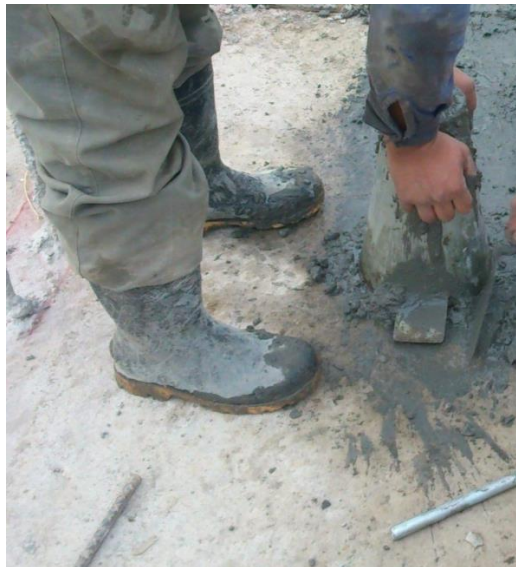
Figura 58. Limpieza del concreto alrededor de la base del cono
