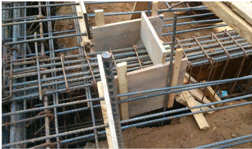
Figura 31. Formaleta de viga y losa de cimentación
