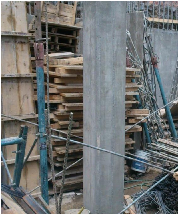
Figura 47. Columna desencofrada
