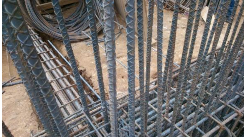
Figura 33. Refuerzo localizado en cabezal para pantalla
