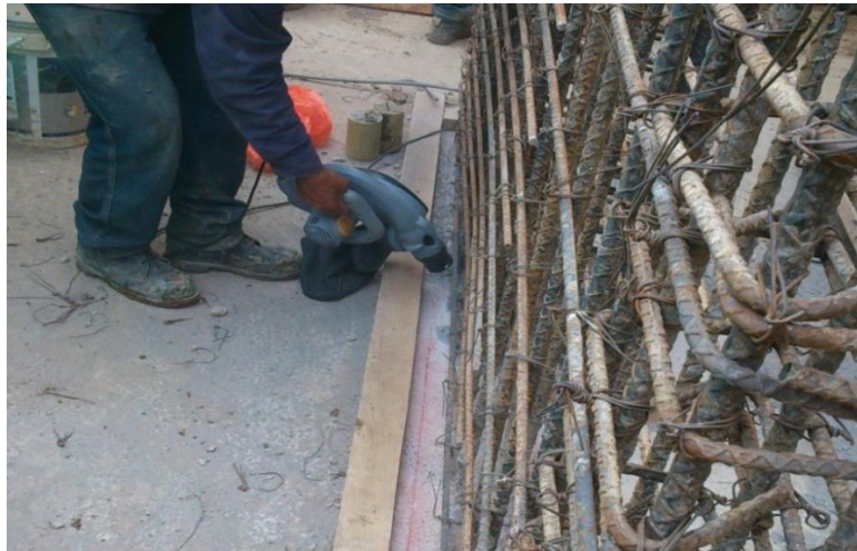
Figura 36. Limpieza de base de pantalla empleando una sopladora
