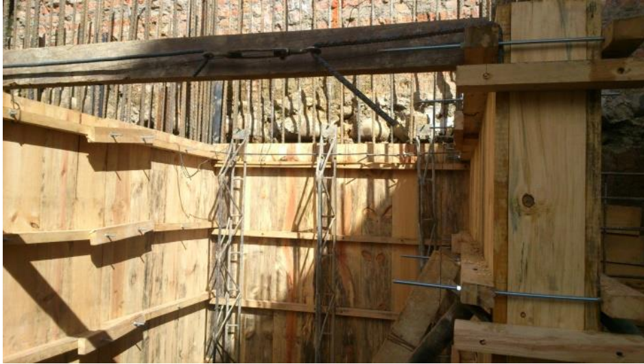
Figura 55. Tablones de formaleta de pantallas
