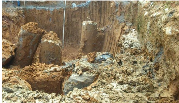
Figura 21. Excavación zona de semisótano
