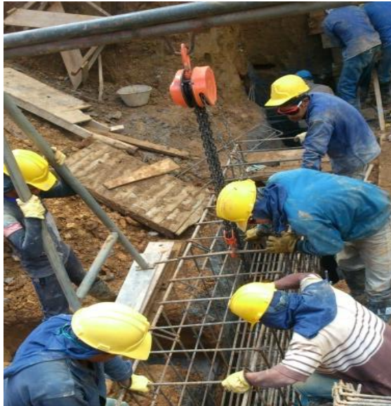
Figura 26. Armado del refuerzo de un cabezal y colocación
