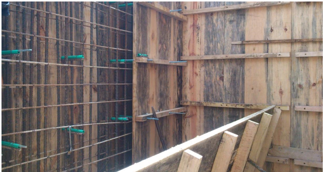
Figura 39. Encofrado de pantalla
