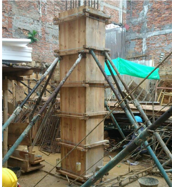
Figura 45. Encofrado de columna
