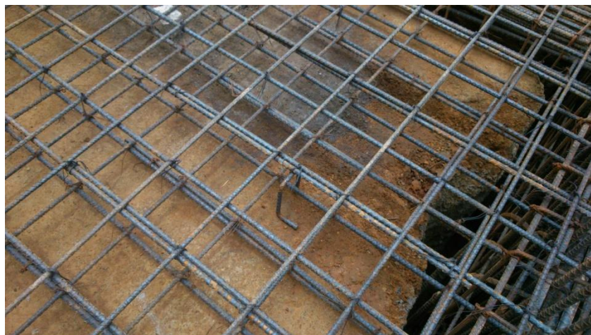
Figura 30. Refuerzo de la losa de cimentación
