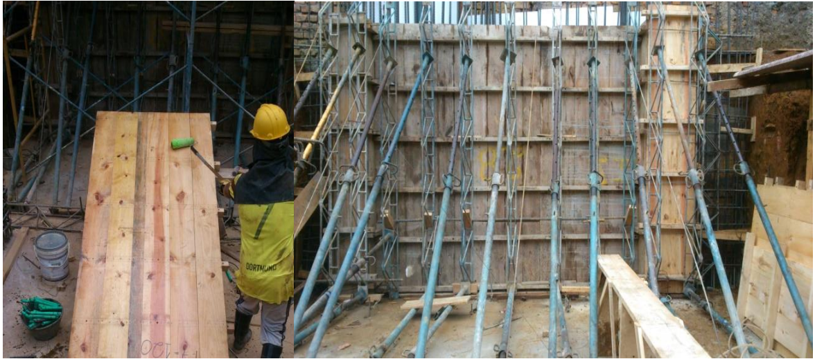
Figura 37. Aplicación de separol a los tableros y encofrado de pantalla
