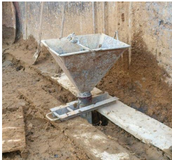
Figura 20. Tolva de tubería tremie
