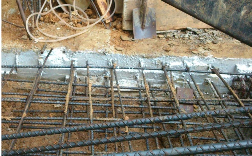
Figura 32. Aplicación de sikadur a concreto endurecido
