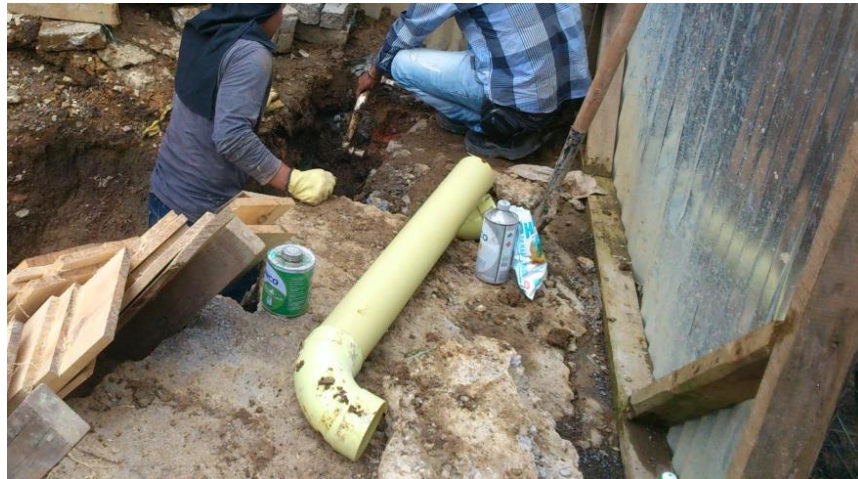
Figura 49. Contratista hidro-sanitario instalando batería sanitaria
