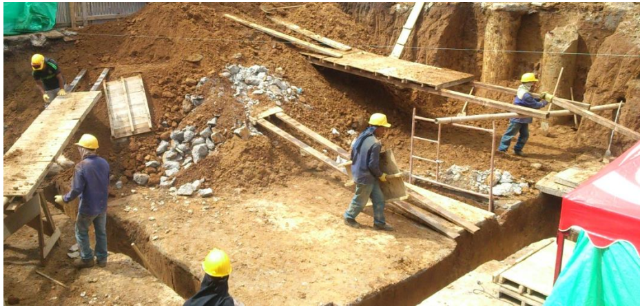
Figura 50. Trabajadores durante la excavación
