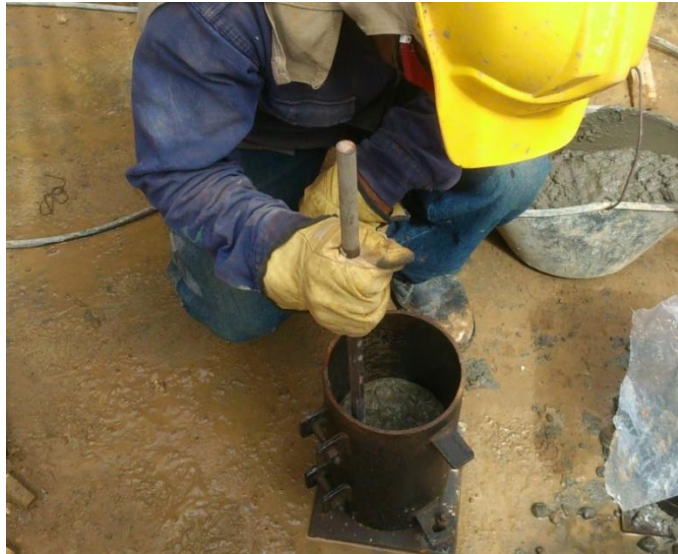
Figura 59. Apisonado del concreto
