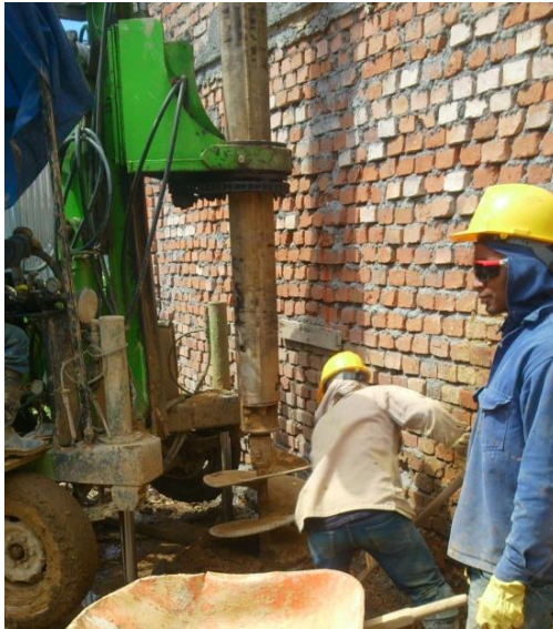
Figura 18. Perforación con máquina piloteadora
