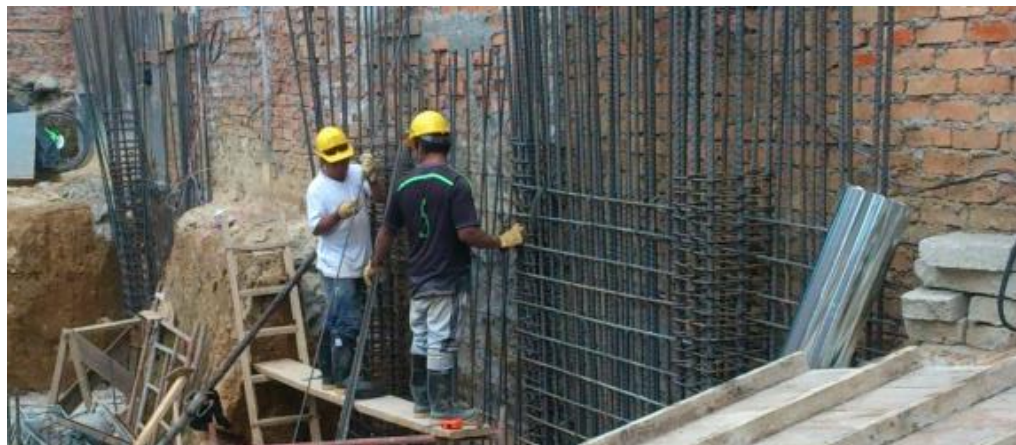
Figura 34. Armadura de pantallas y muros
