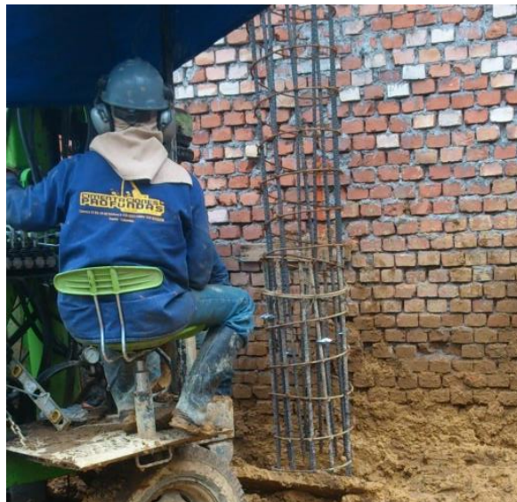
Figura 19. Introducción de armadura de acero
