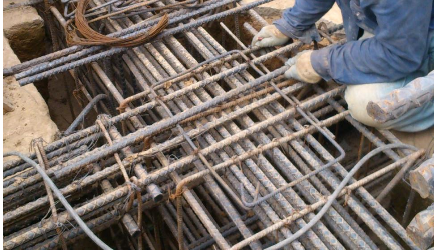
Figura 42. Amarre de estribo guía para armar el refuerzo una columna
