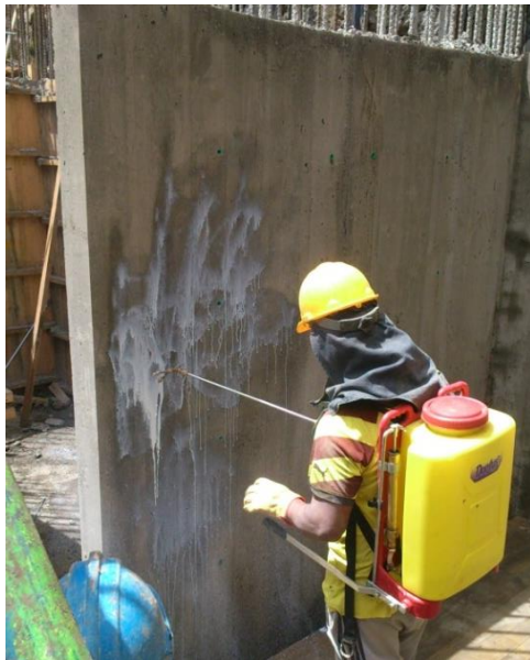
Figura 41. Aplicación de antisol blanco para curado
