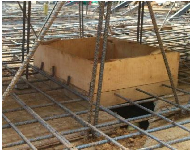
Figura 29. Encofrado para cámara de inspección
