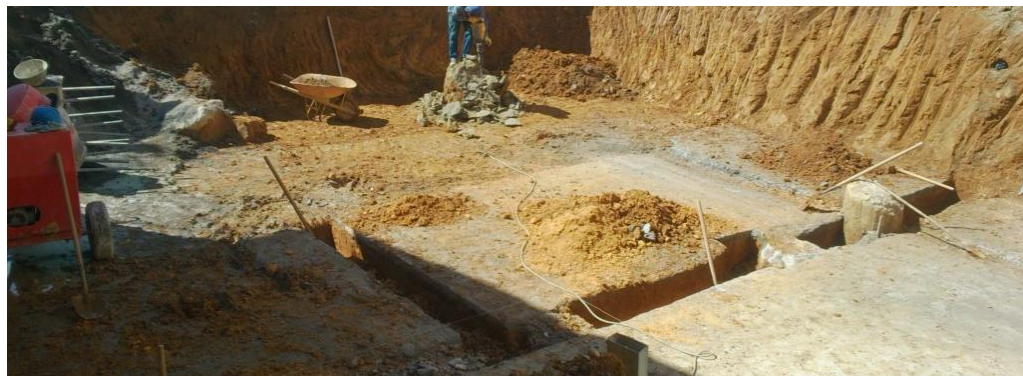
Figura 25. Excavación de zanjas para elementos de cimentación
