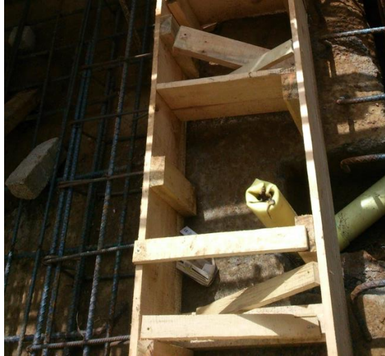
Figura 51. Canaleta de agua pluvial de rampa de sótano
