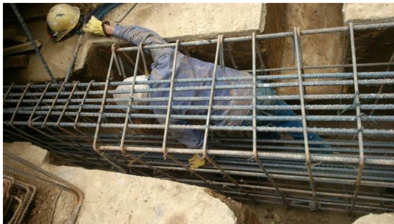
Figura 27. Armado del refuerzo de viga de cimentación que pasa dentro de un cabezal
