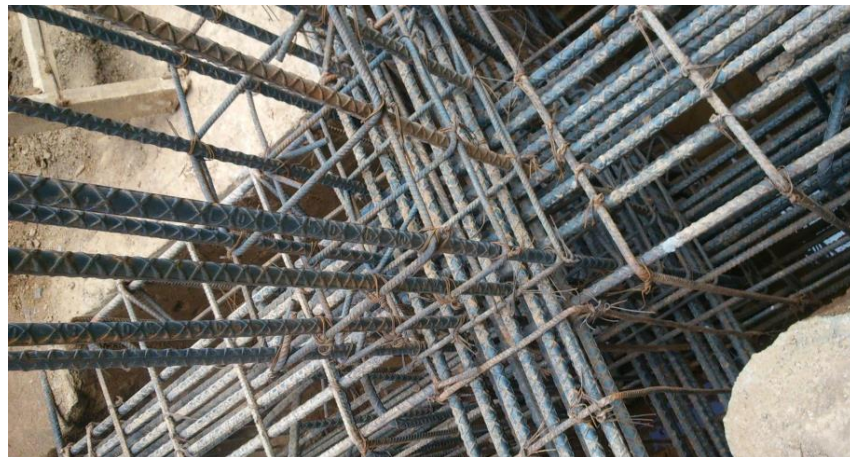
Figura 43. Refuerzo de columna dentro de cabezal
