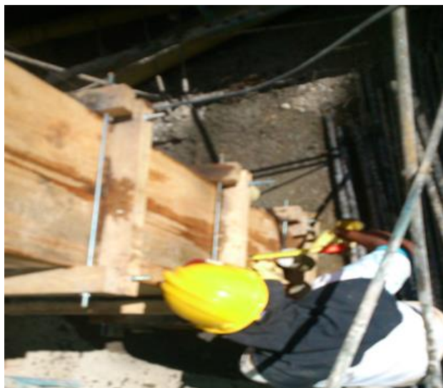
Figura 46. Verificación de plomo de columna fundida
