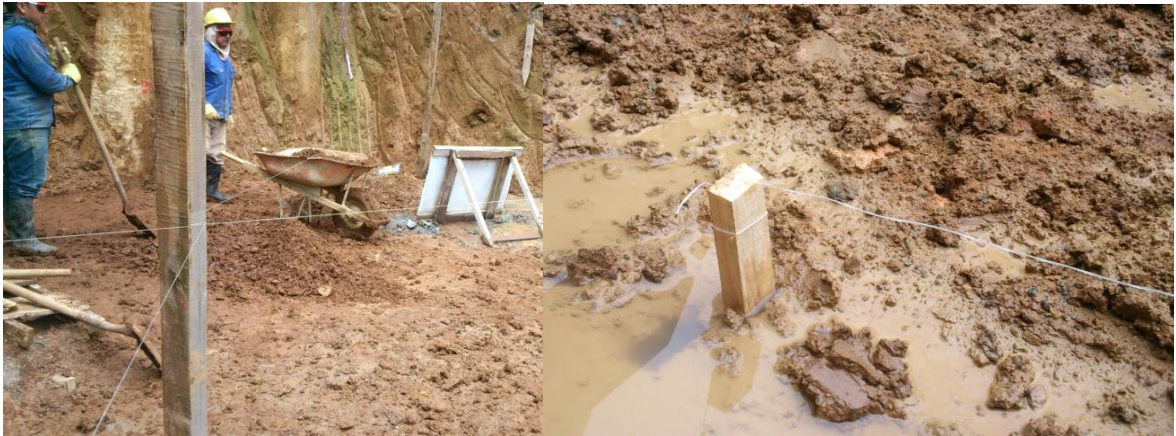
Figura 23. Nivelación para solado de limpieza
