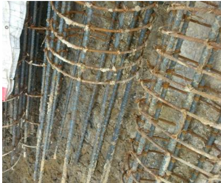
Figura 17. Armaduras de pilotes
