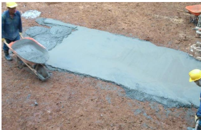
Figura 24. Solado de limpieza de la losa de cimentación
