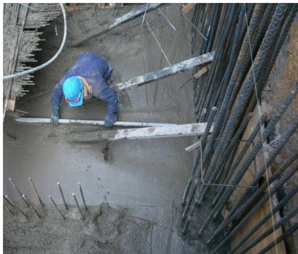
Figura 28. Fundición de elementos de la cimentación
