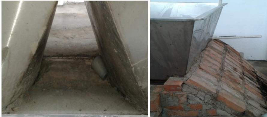
Figura 5. Áreas de difícil acceso para limpieza y desinfección
