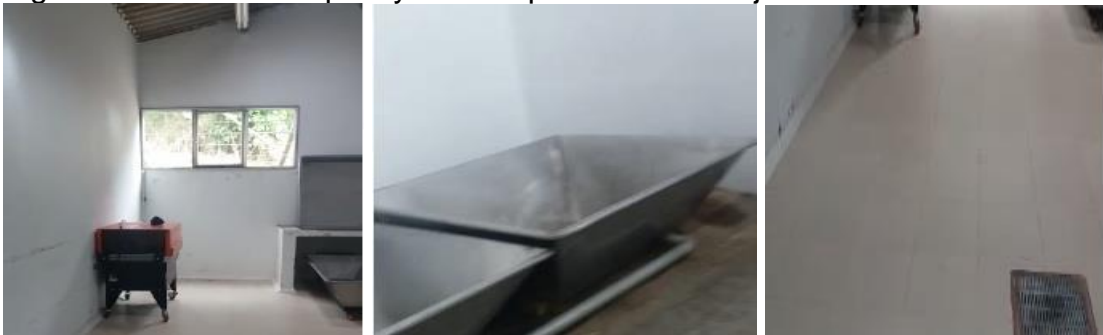
Figura 17. Paredes limpias y sifones provistos con rejilla.
