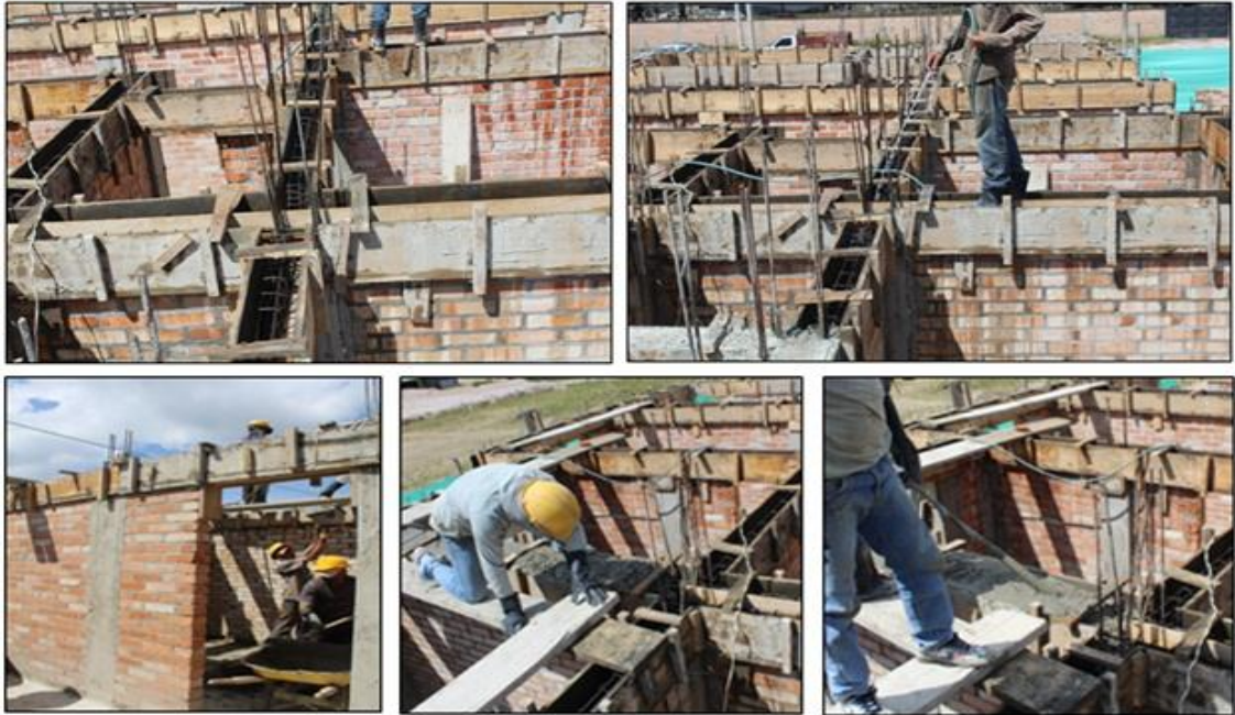
Ilustración 6.26 Vaciado y vibrado viga de amarre
