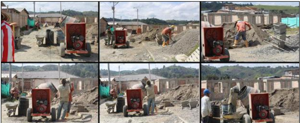
Ilustración 6.13 Proceso de Amasado de concreto
