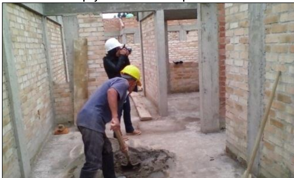
Ilustración 6.29 Apoyo en la revisión de proceso de construcción
