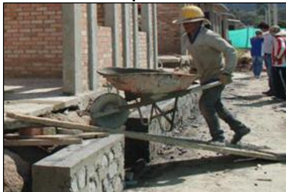
Ilustración 6.14 Transporte de mezcla concreto
