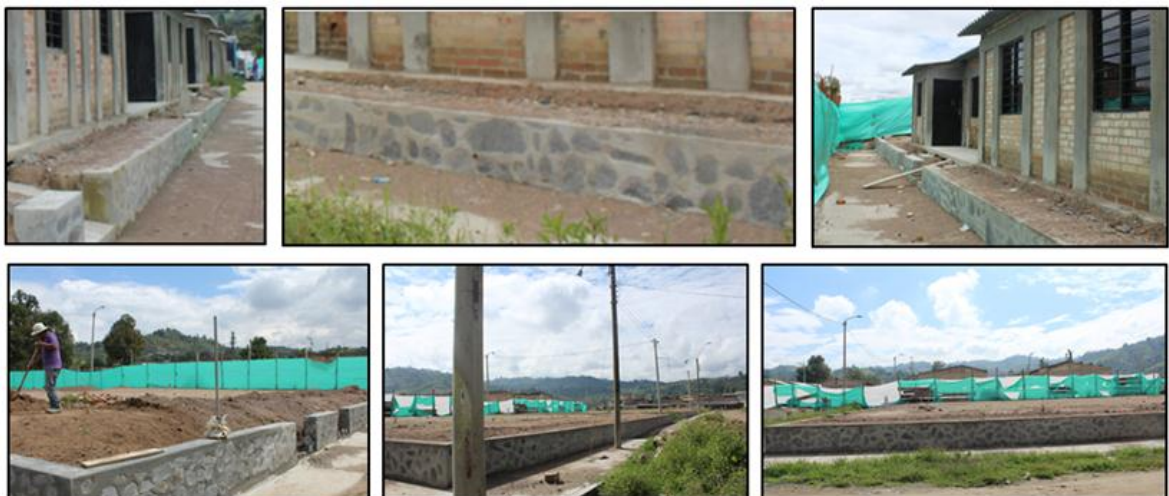
Ilustración 6.47 Nivelación del terreno del muro de contención
