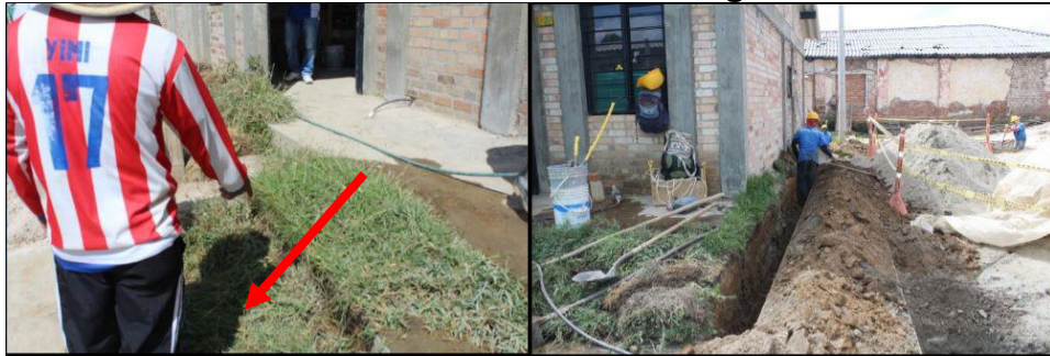
Ilustración 6.48 Instalación de la red de gas domiciliario.
