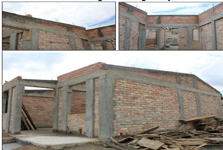
Ilustración 6.34 Viga cinta fraguada y curada
