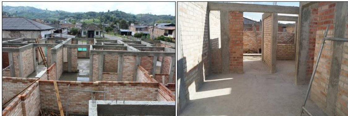
Ilustración 6.28 Muros, vigas y columnas terminados en la obra
