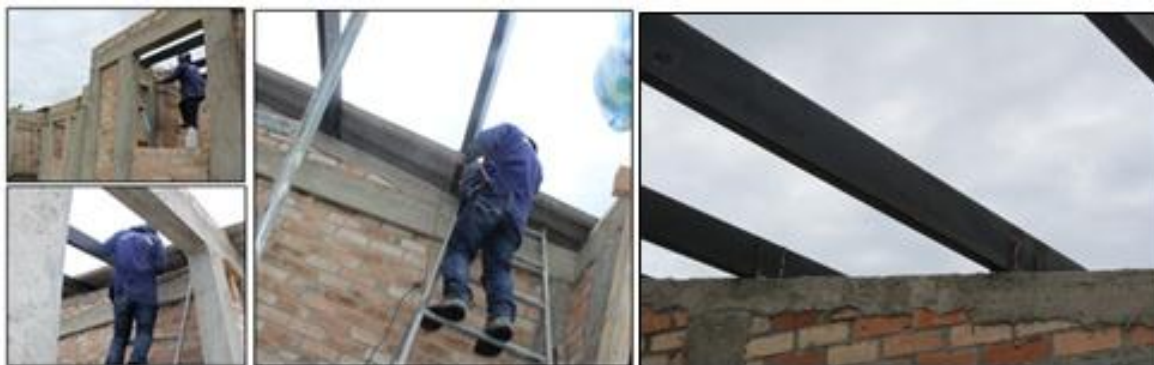
Ilustración 6.35 Soldadura de perlines
