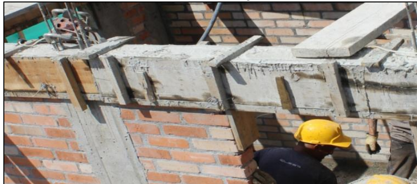
Ilustración 6.27 Detalle cara superior de la formaleta
