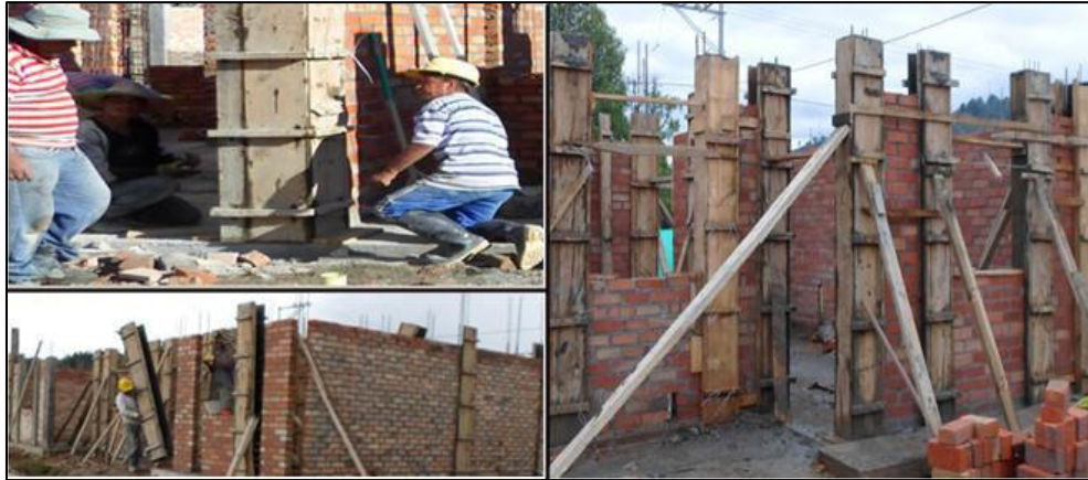
Ilustración 6.21 Armada y vaciada de columnas de concreto reforzado
