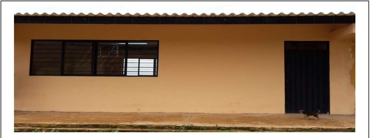
Fotografía 1. Vista frontal, aula entregada vereda Ortega Llanos
