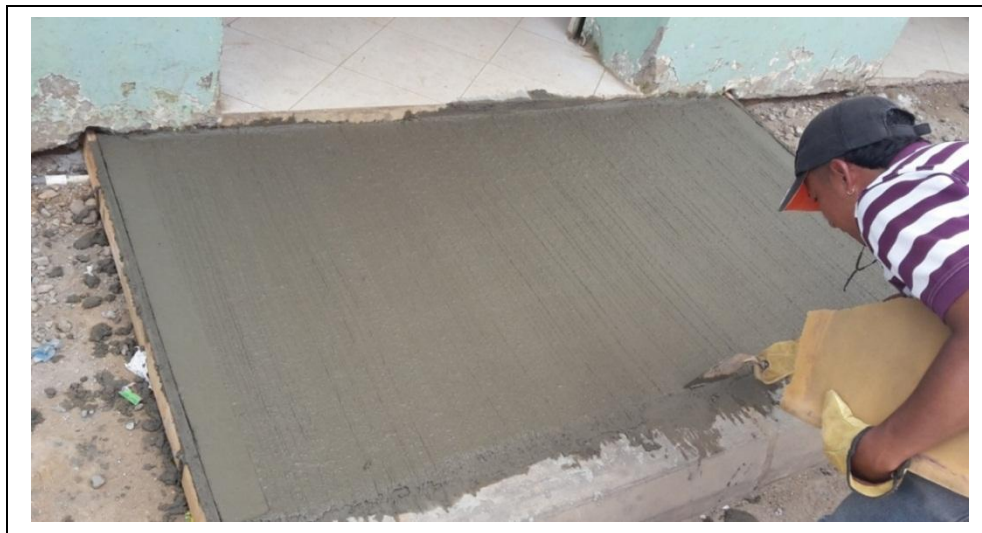
Fotografía 54. Acabado y retoques a la superficie del andén
