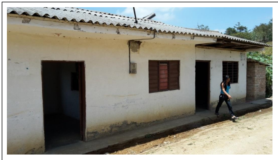
Fotografía 32. Vista general de salón comunal vereda Santa Bárbara
