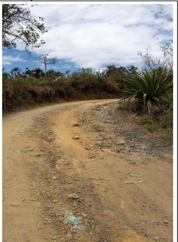
Fotografía 22. Parte alta de la loma, zona plana del tramo, V/Pomorroso
