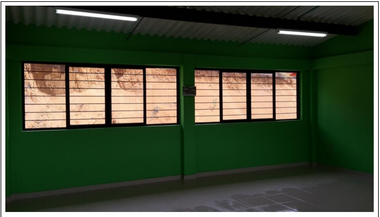
Fotografía 11. Ventanas traseras y elementos estructurales
