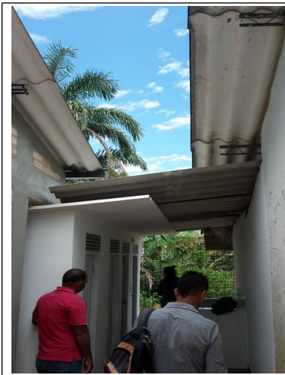
Fotografía 12. Baños comunes y lavamanos
