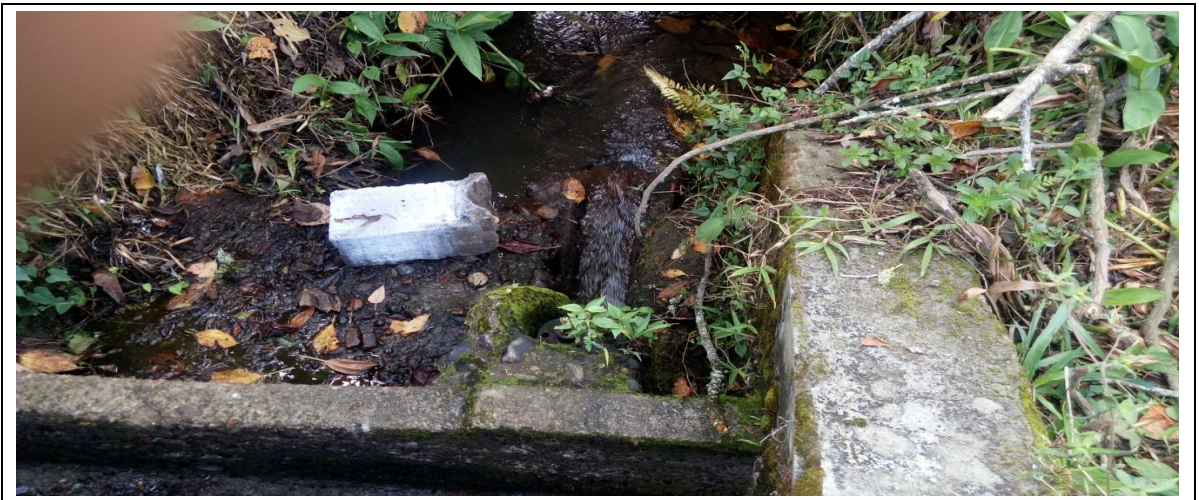
Fotografía 14. Quebrada con caudal insuficiente para abastecimiento
