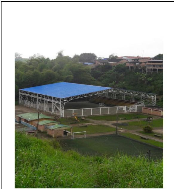
Fotografía 44. Vista general CIC terminado
