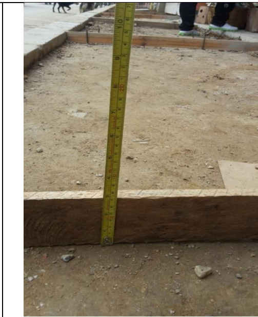
Fotografía 50. Medición de altura de juntas
