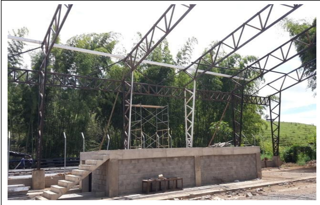
Fotografía 40. Vista general de cerchas para la cubierta del polideportivo
