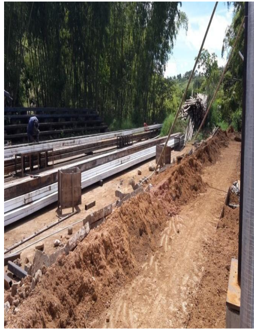
Fotografía 43. Adecuación de área para disposición de cerramiento en malla
