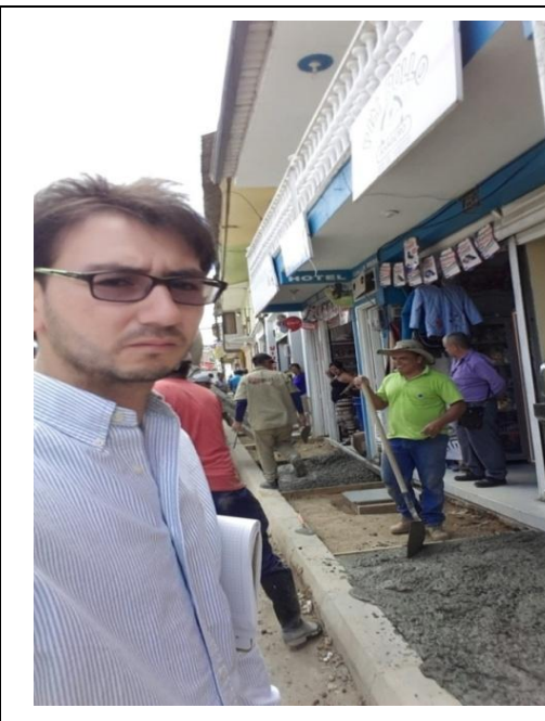
Fotografía 52. Supervisión fundición de andenes
