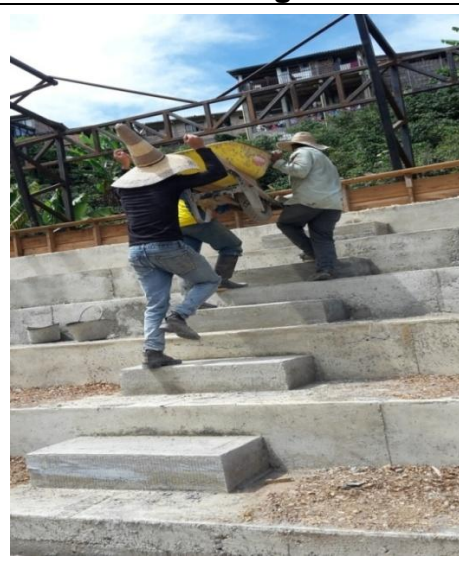
Fotografía 39. Proceso de fundición de gradería
