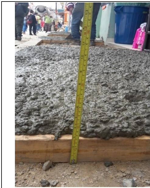
Fotografía 49. Chequeo capa de concreto
