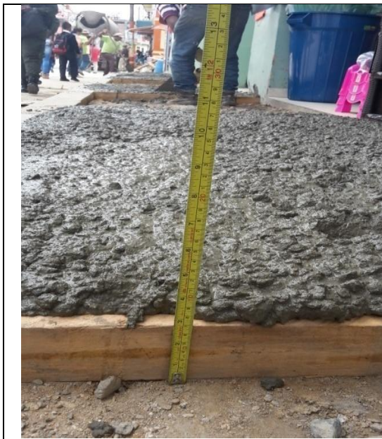
Fotografía 47. Verificación de espesor de la capa de concreto
