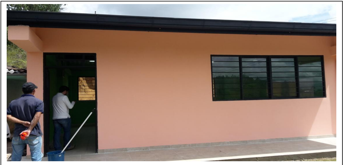
Fotografía 6. Vista Principal Aula Escolar Vereda Cascajal
