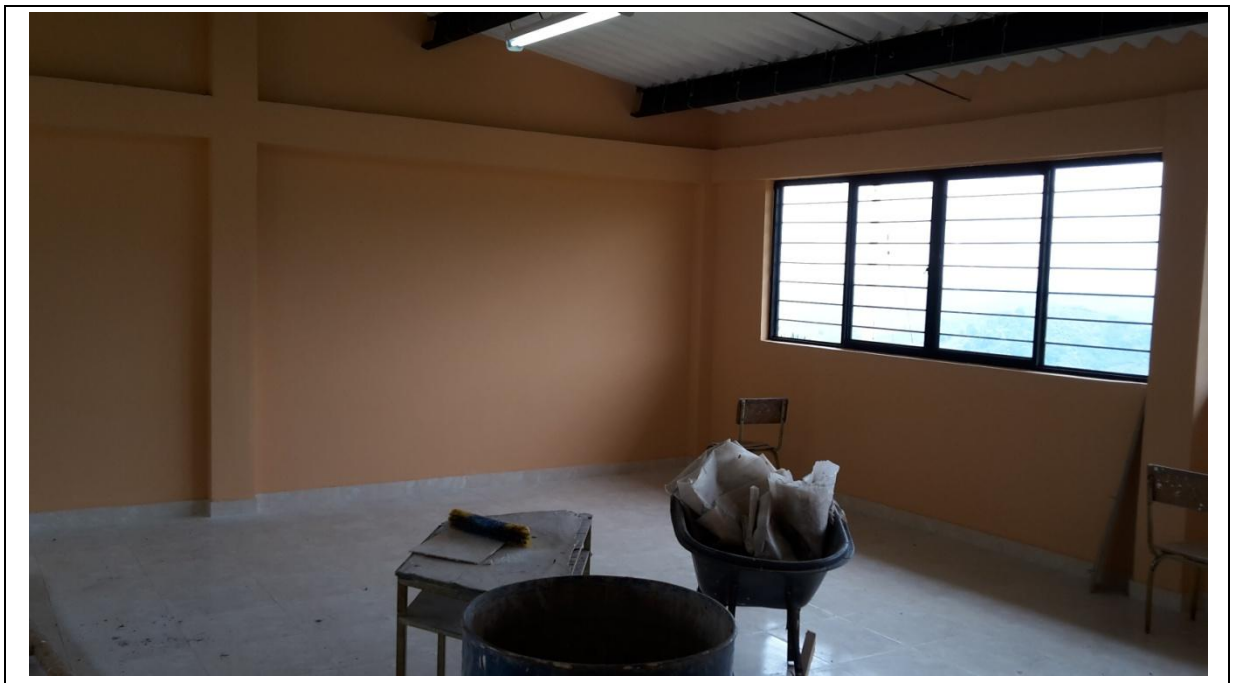
Fotografía 5. Ventanal trasero y observación de elementos estructurales
