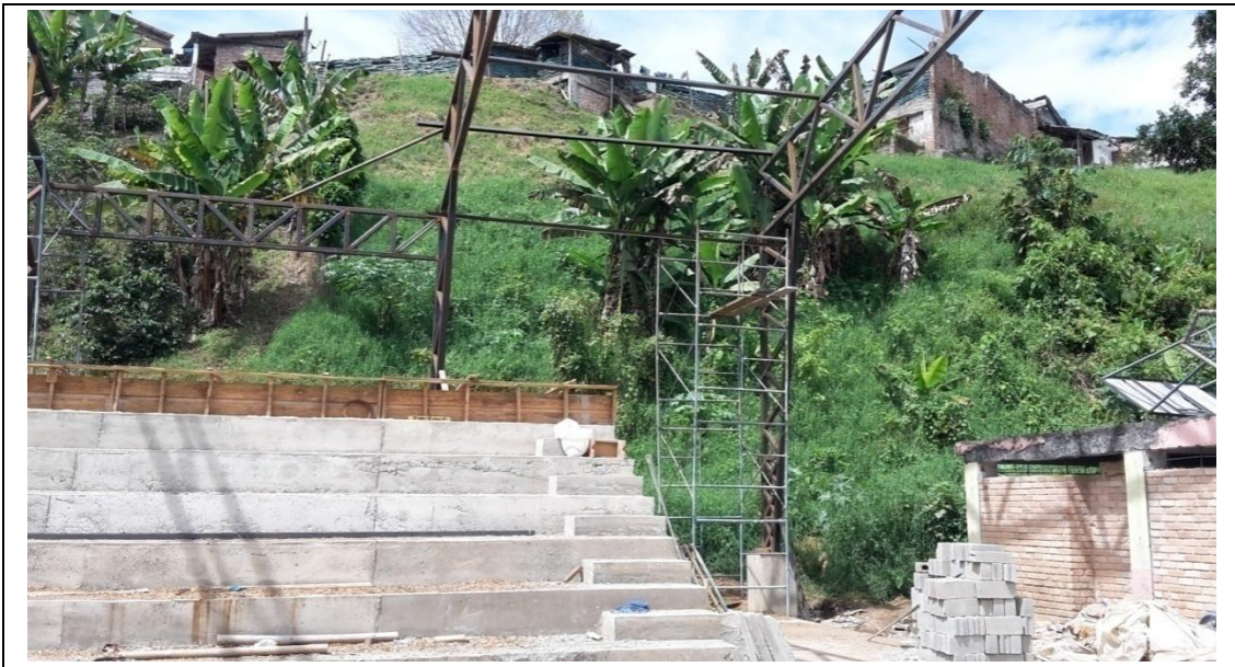
Fotografía 41. Formaleta para fundición de último nivel de la gradería
