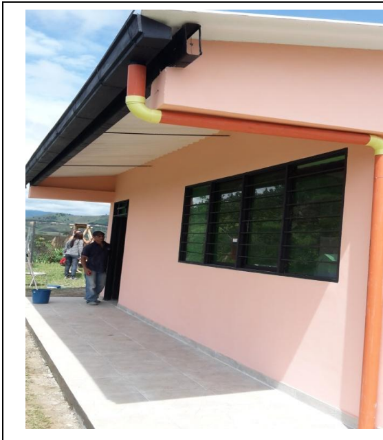
Fotografía 7. Canal colector de aguas lluvias y bajante
