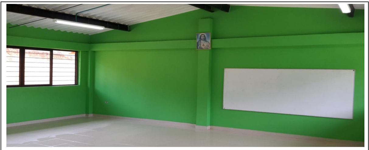
Fotografía 9. Vista General Interna, Acabados Aula Escolar Cascajal
