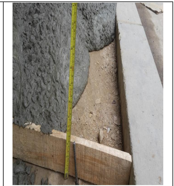
Fotografía 48. Chequeo de espesor capa de concreto
