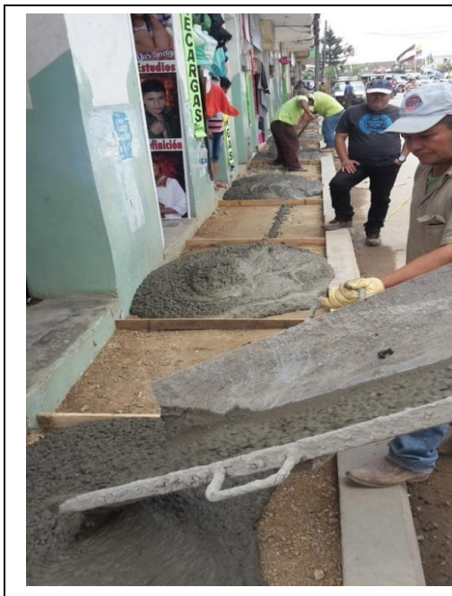
Fotografía 51. Fundición intercalada de lotes de andén
