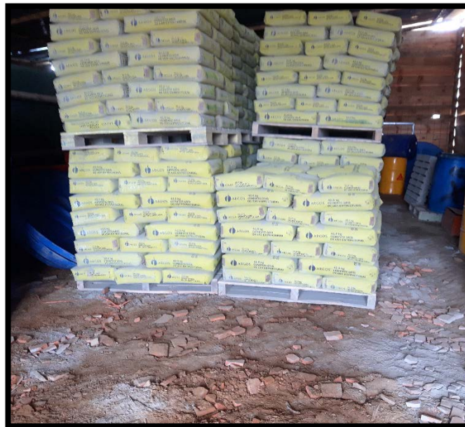
Ilustración 10. Almacenamiento del cemento
