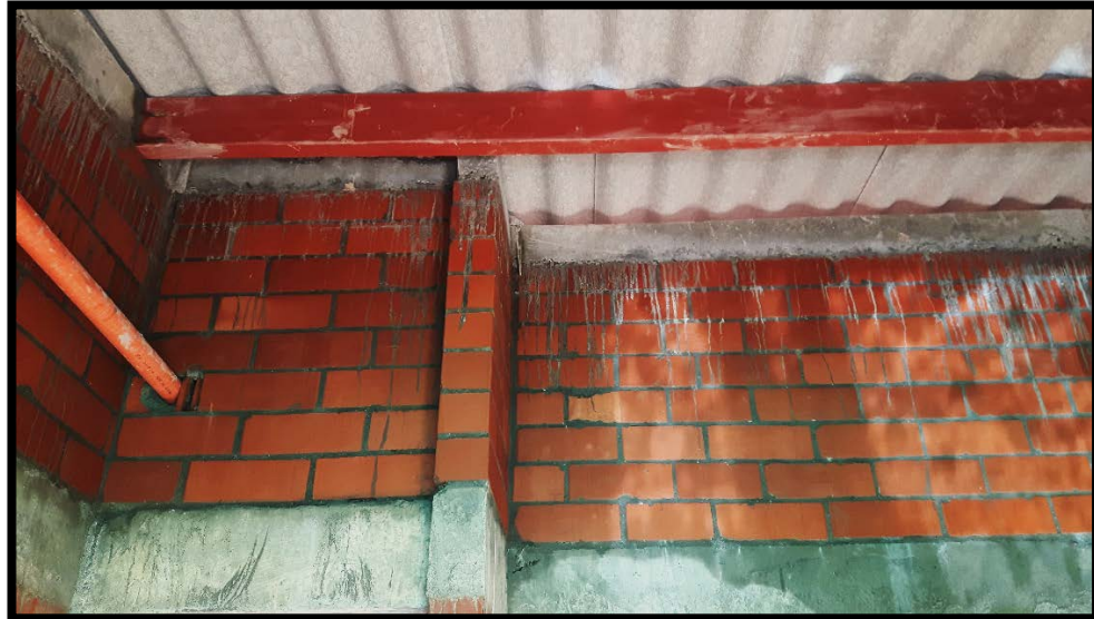
Ilustración 46. Tejado y perfil metálico de soporte
