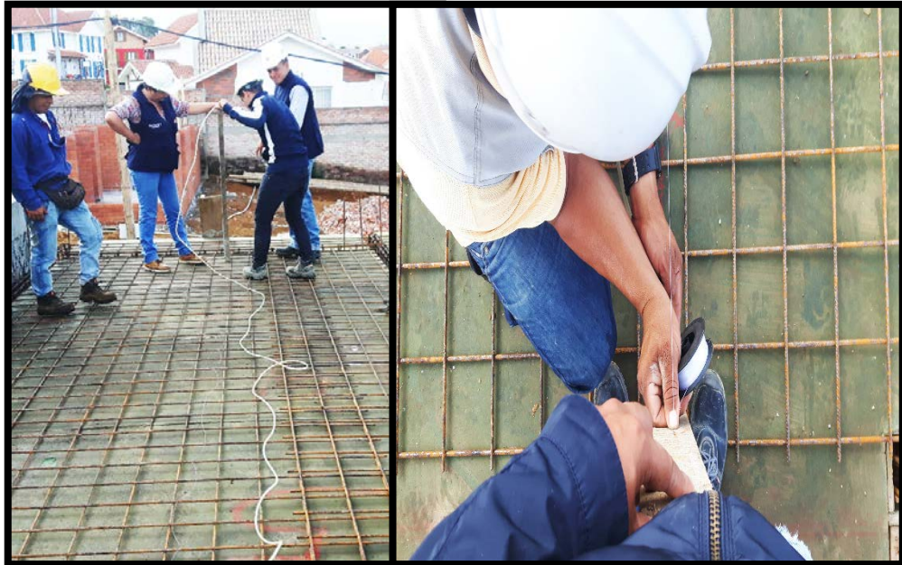
Ilustración 34. Chequeo inicial de nivel formaleta losa entrepiso
