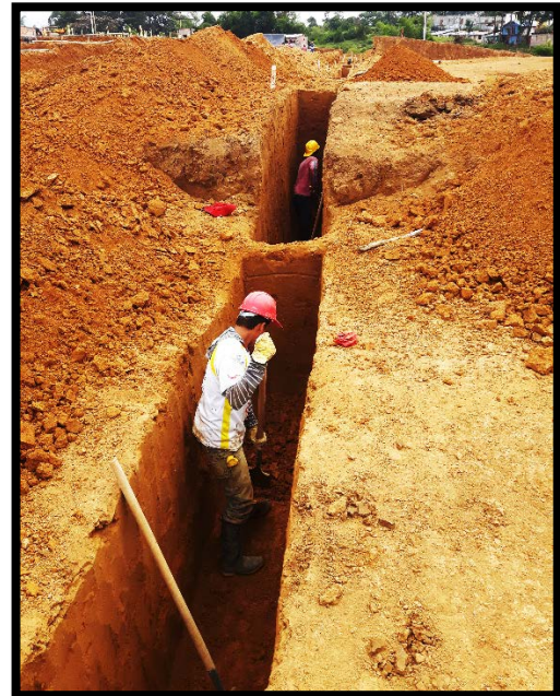
Ilustración 9. Excavación para tubería sanitaria
