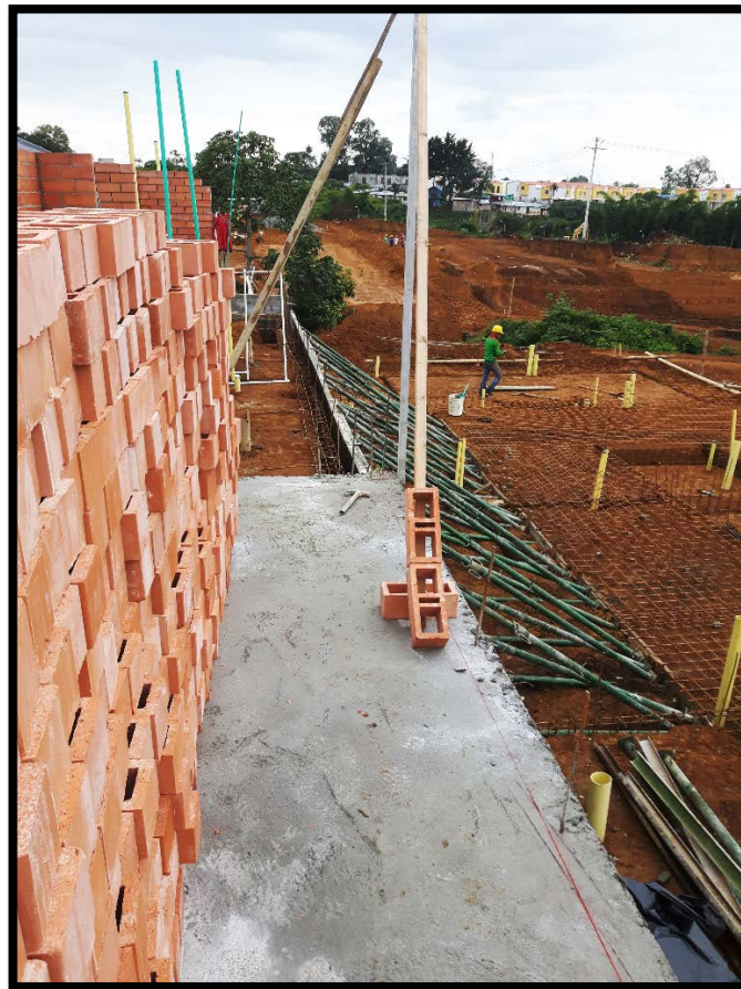
Ilustración 26. Mampostería por instalar
