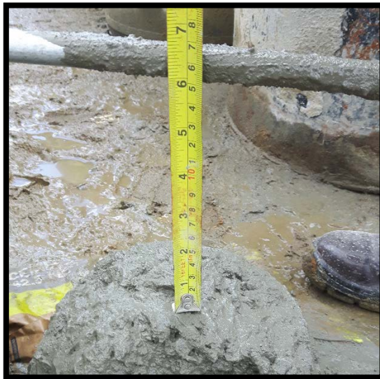
Ilustración 14. Asentamiento 6" losa entrepiso
