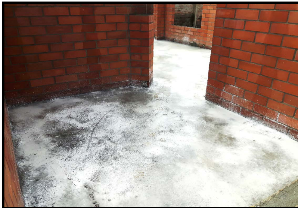
Ilustración 22. Tratamiento en cal
