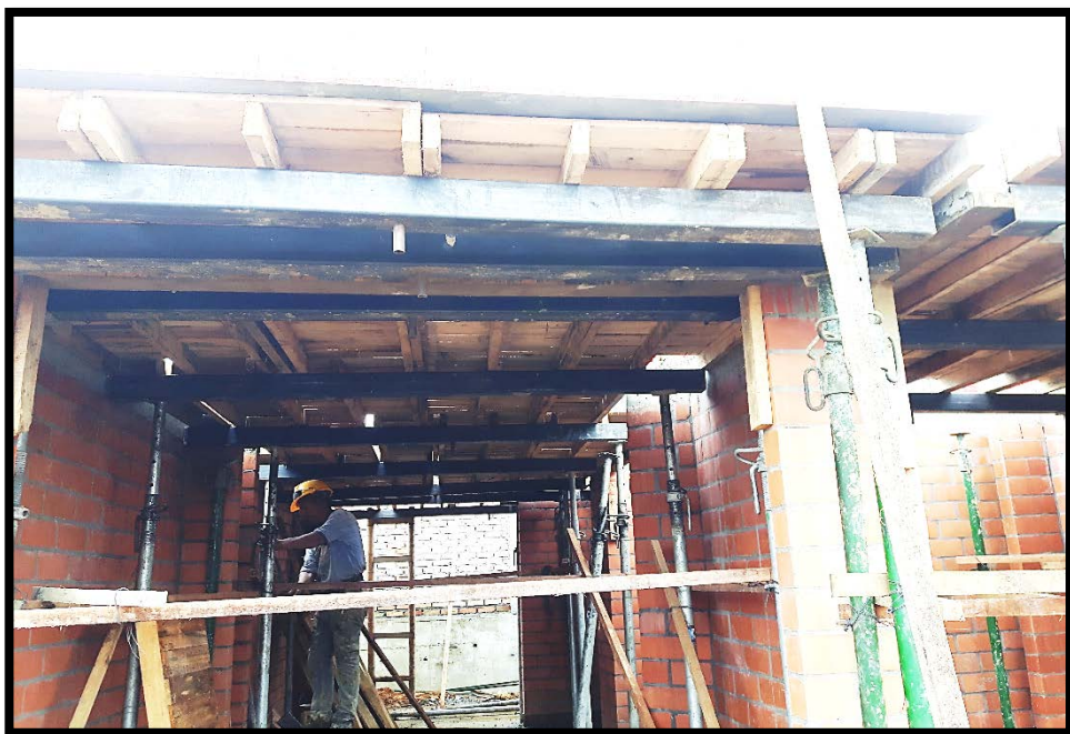
Ilustración 33. Chequeo de ubicación de acero de dovelas 3/8"
