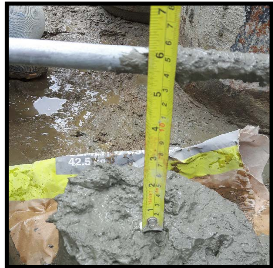
Ilustración 15. Asentamiento 5.5" losa entrepiso
