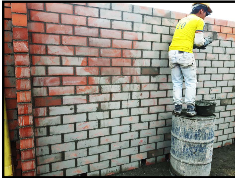
Ilustración 27. Rebite de muros
