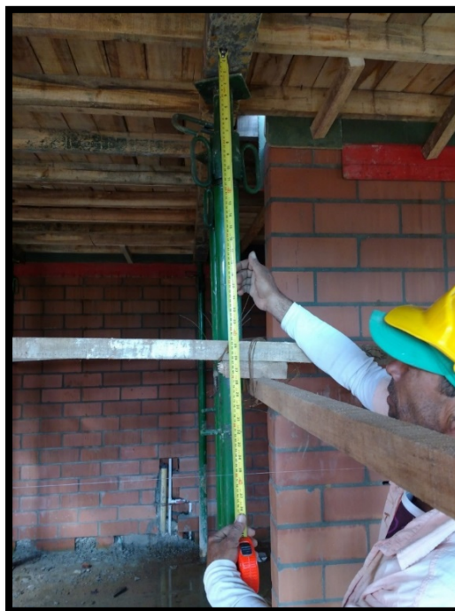
Ilustración 35. Nivelación de formaleta losa entrepiso
