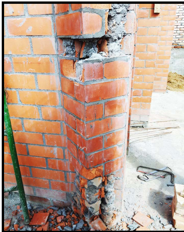
Ilustración 30. Punta de diamante en demolición
