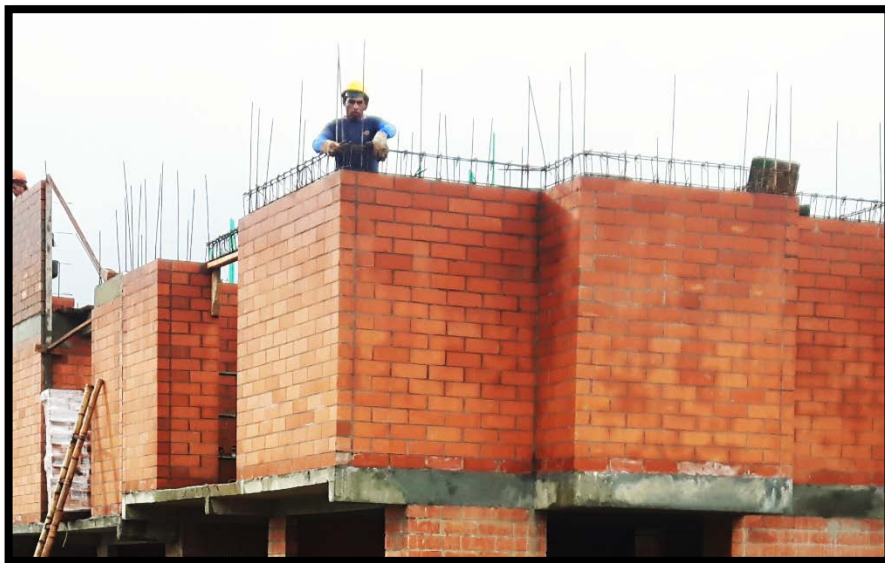
Ilustración 40. Instalación viga de amarre V1
