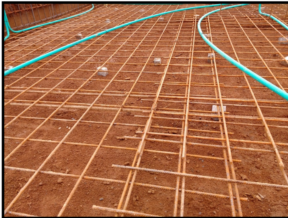
Ilustración 32. Reubicación aceros de refuerzo losa de cimentación
