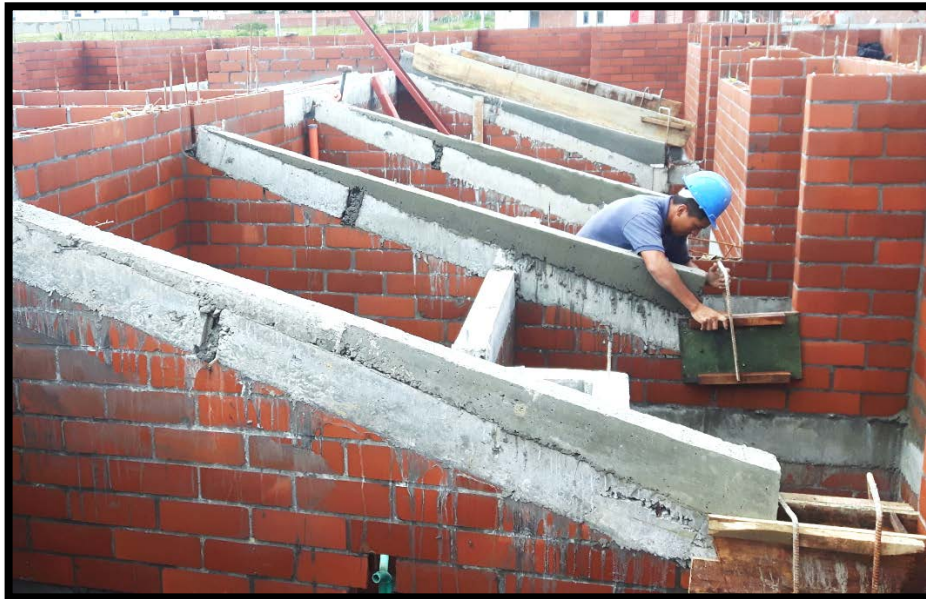
Ilustración 45. Corrección de pendiente vigas cinta
