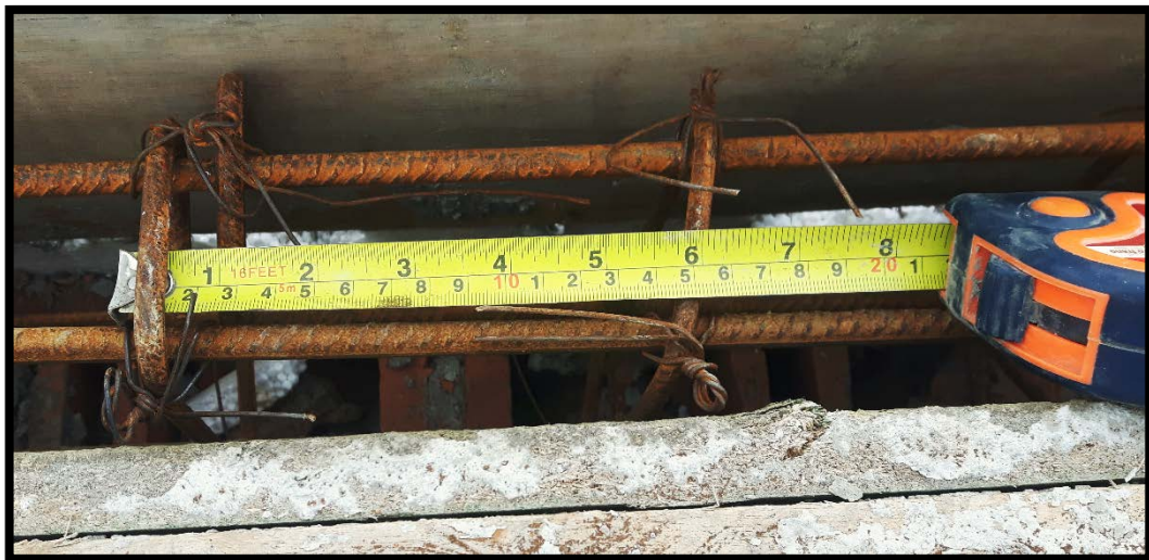
Ilustración 41. Chequeo de separación estribos viga de amarre
