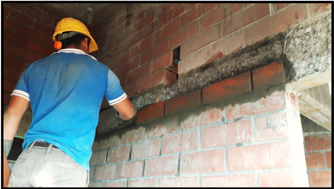
Ilustración 44. Uso de ladrillo para detalle arquitectónico en el retroceso
