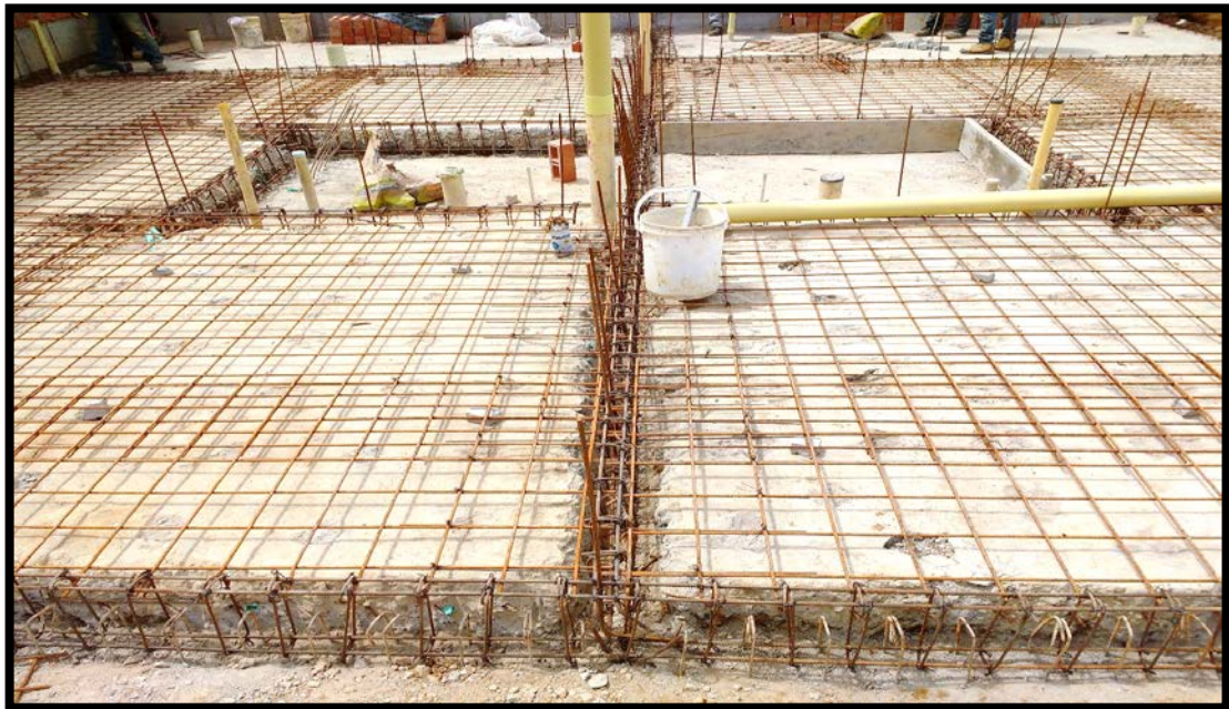
Ilustración 24. Nuevo armado de acero losa de cimentación casas 13A y 14A
