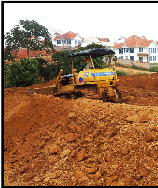
Ilustración 8. Movimiento de tierras
