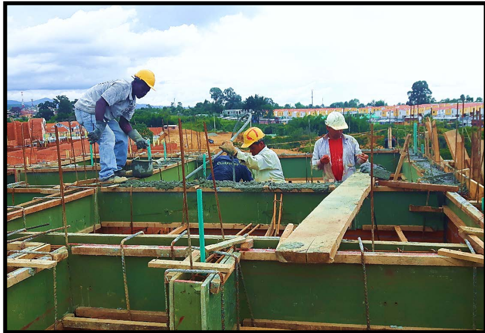
Ilustración 42. Fundición vigas de amarre
