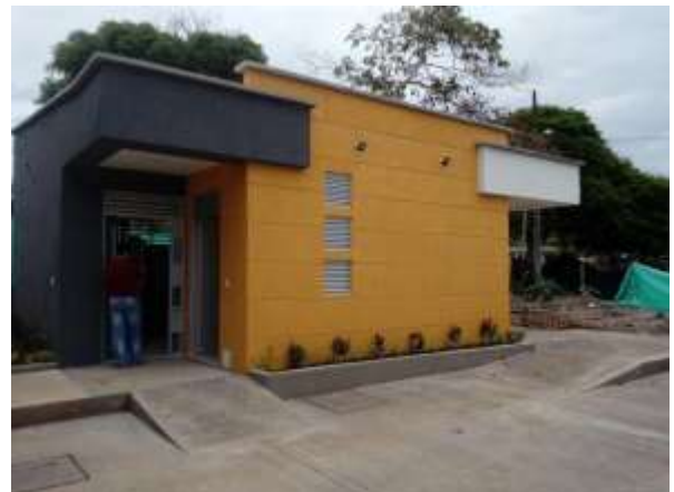
Figura 20: Zona de sanitarios
