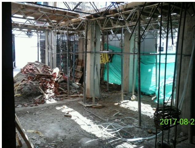
FIGURA 63. SISTEMA DE CERCHAS Y PUNTALES METALICOS.
