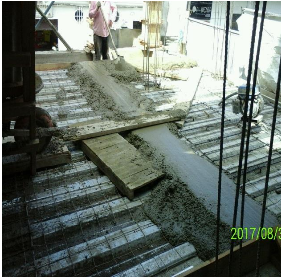
FIGURAS 72 Y 73. FUNDICION DE LOSA ALIGERADA EN METALDECK.
