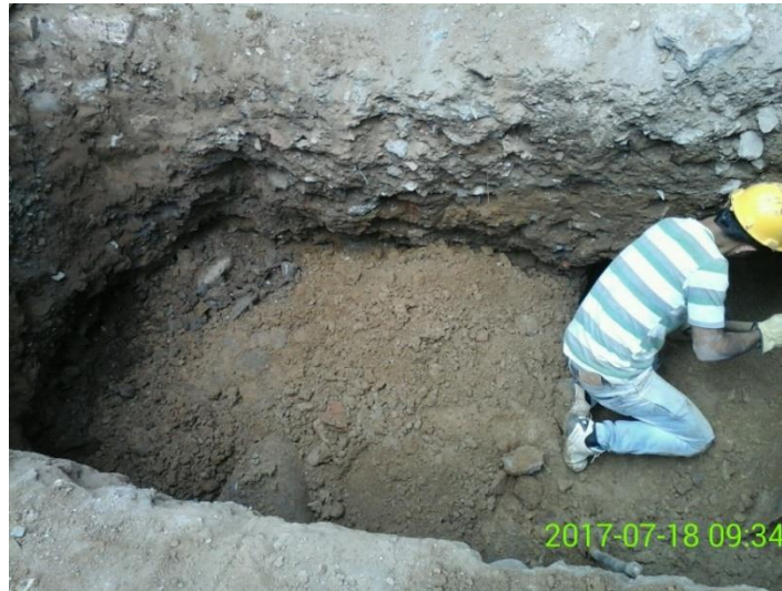
FIGURA 23. EXCAVACIONES PARA FUNDICION DE ZAPATA Z-17.
