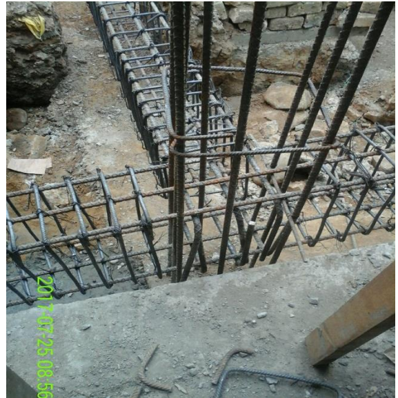
FIGURAS 39 Y 40. ARMADO DE ACEROS PARA VIGAS DE CIMENTACION.
