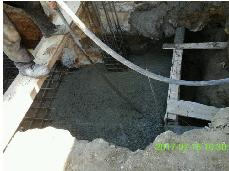
FIGURA 32. VIBRADO DEL CONCRETO EN LA FUNDICION.
