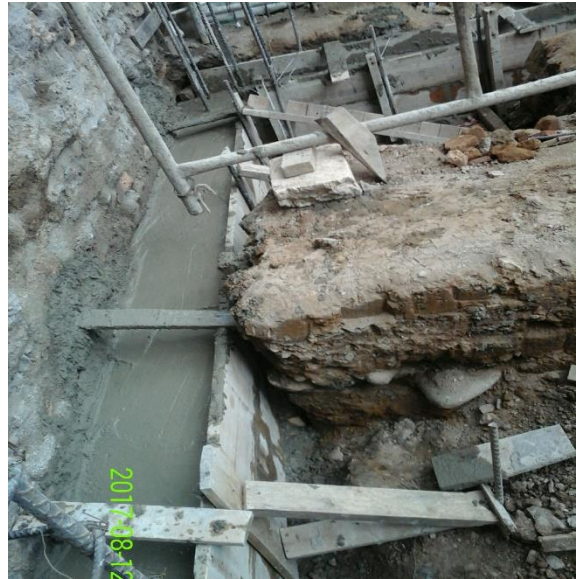
FIGURAS 41 Y 42. FUNDICION DE VIGAS DE CIMENTACION.
