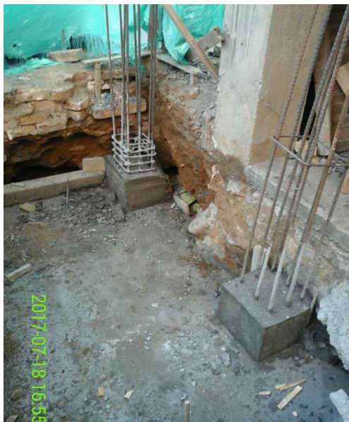
FIGURA 38. PEDESTALES PARA AMARRE DE VIGAS DE CIMENTACION.
