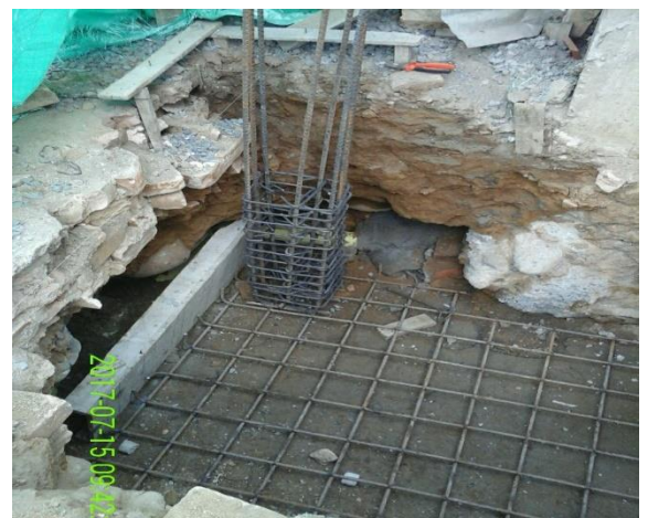
FIGURAS 28 Y 29. COLOCACION DE MALLA DE REFUERZO Y DE CASTILLO DE COLUMNA C3.
