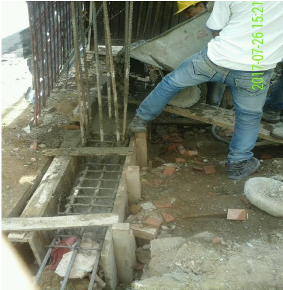
FIGURAS 41 Y 42. FUNDICION DE VIGAS DE CIMENTACION.
