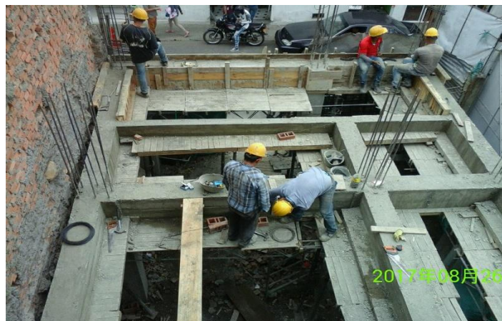
FIGURA 64. FUNDICION DE VIGA DE ENTREPISO VE3 EN EL EJE 3 EN EL NIVEL 2.
