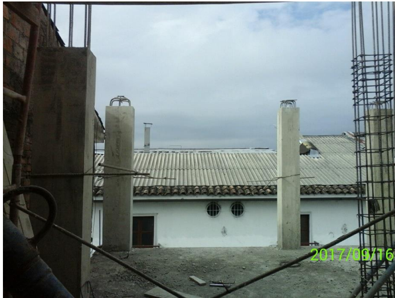
FIGURA 83. COLUMNAS C2 Y C5 EN EL NIVEL 3 DEL BLOQUE 2.
