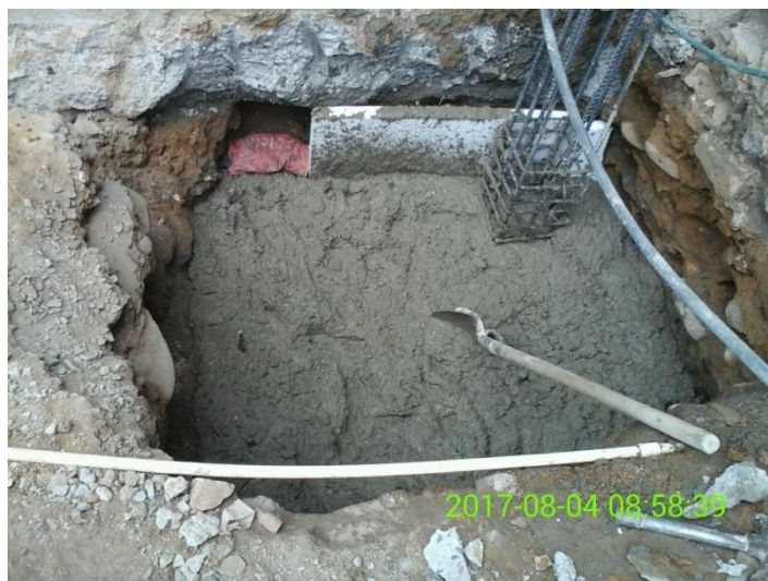
FIGURA 33. JUNTA DE DILATACION CON LAMINA DE ICOPOR.
