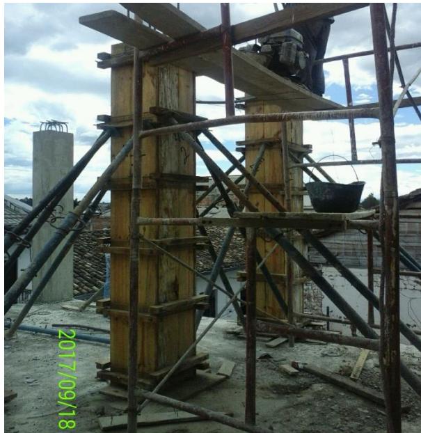
FIGURA 82. VACIADO DE CONCRETO PARA FUNDICION DE COLUMNAS C3 EN EL NIVEL 3 DEL BLOQUE 2.
