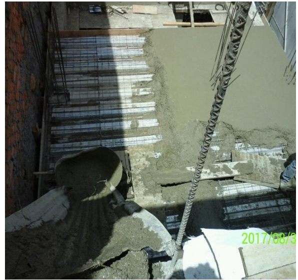
FIGURAS 72 Y 73. FUNDICION DE LOSA ALIGERADA EN METALDECK.
