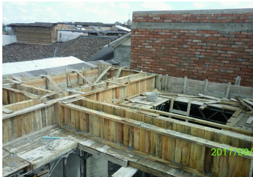
FIGURA 94. FUNDICION DE VIGAS DE AMARRE VA1 NIVEL DE CUBIERTA BLOQUE 2.
