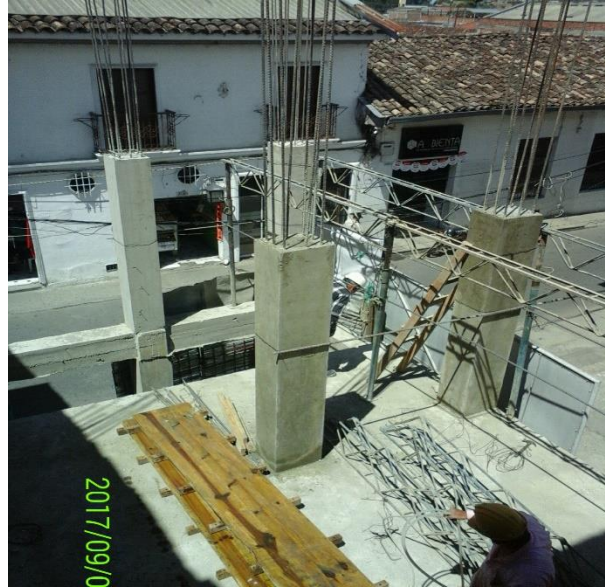
FIGURA 81. COLUMNAS C3 Y C2 EN EL NIVEL 2 DEL BLOQUE 2.
