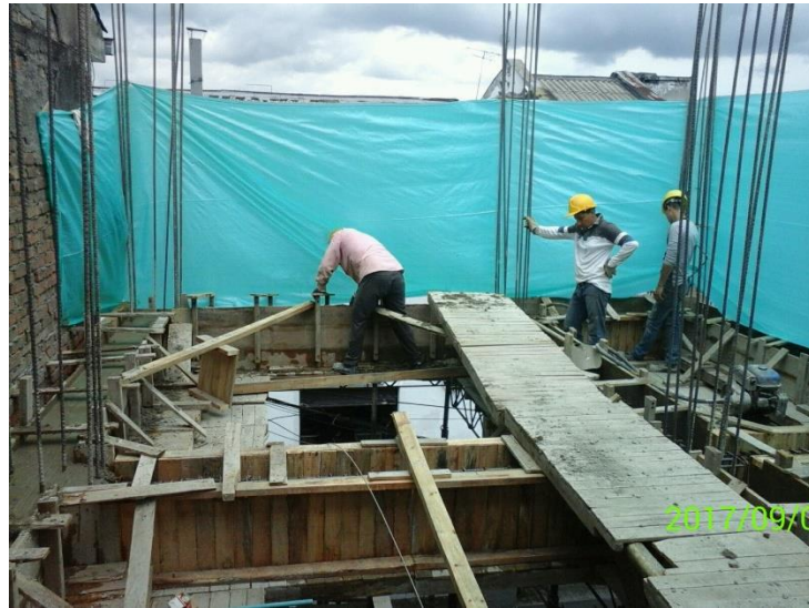
FIGURA 87. FUNDICION VIGAS DE ENTREPISO NIVEL 3 DEL BLOQUE 2.
