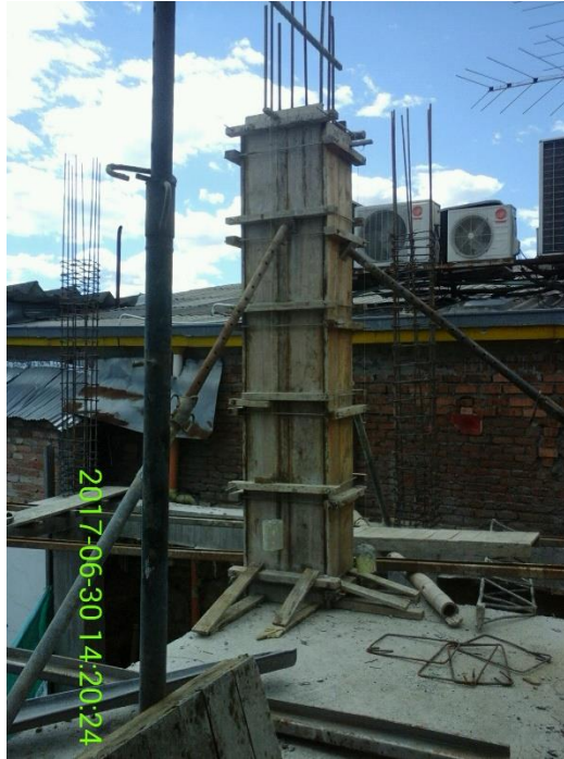
FIGURA 84. ENCOFRADO DE COLUMNA C1 EN EL NIVEL 3 DEL BLOQUE 1.
