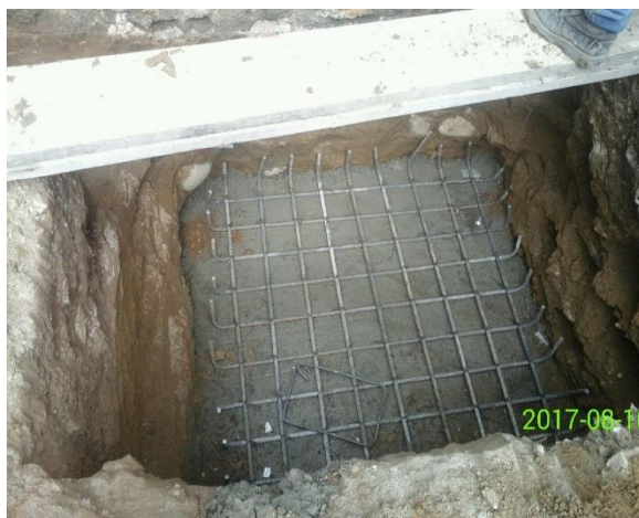
FIGURAS 28 Y 29. COLOCACION DE MALLA DE REFUERZO Y DE CASTILLO DE COLUMNA C3.
