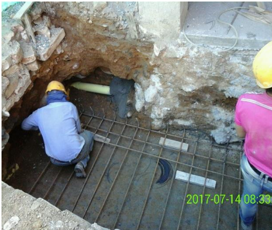
FIGURAS 25 Y 26. AMARRE DE VARILLAS PARA LA PARRILLA DE REFUERZO.
