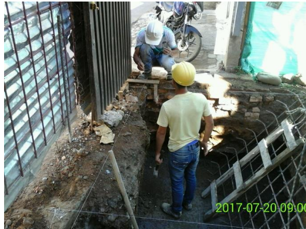
FIGURA 27. LOCALIZACION Y REPLANTEO PARA ZAPATA Z-17 EN EL EJE 1 ENTRE EJES B-CC.
