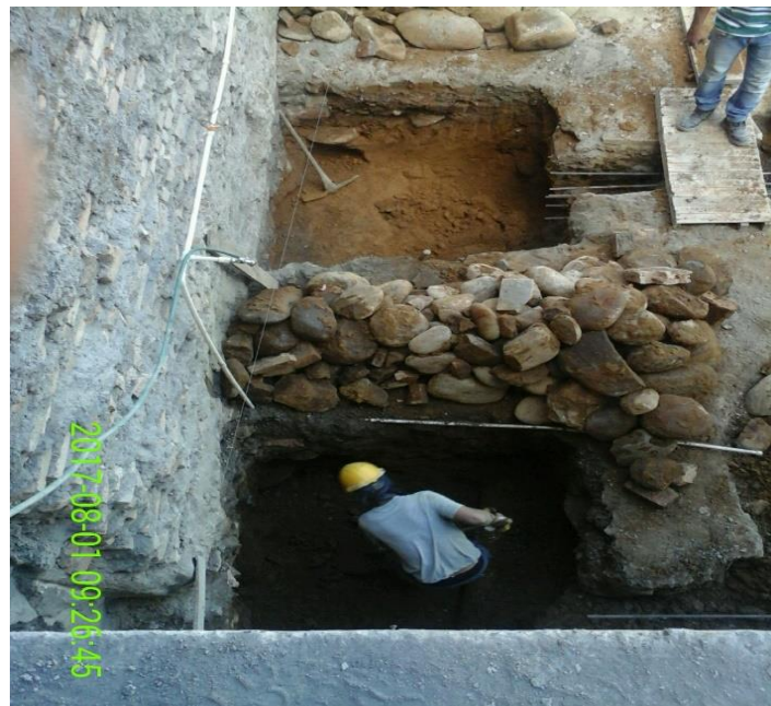
FIGURA 24. EXCAVACIONES PARA FUNDICION DE ZAPATAS Z-7 Y Z-9.
