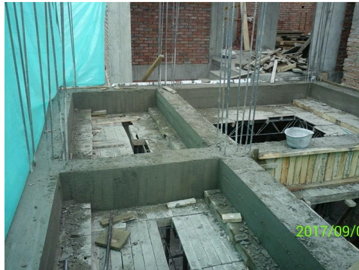
FIGURA 88. DESENCOFRADO VIGAS DE ENTREPISO NIVEL 3 DEL BLOQUE 2.
