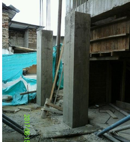
FIGURA 52. DESENCOFRADO DE COLUMNA C3.
