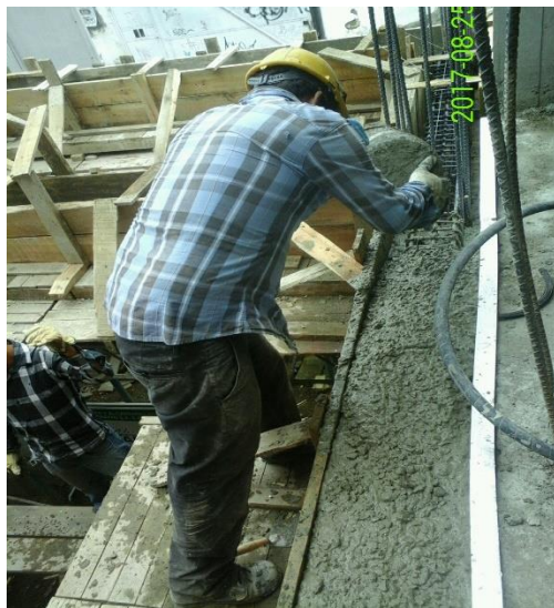
FIGURA 64. FUNDICION DE VIGA DE ENTREPISO VE3 EN EL EJE 3 EN EL NIVEL 2.
