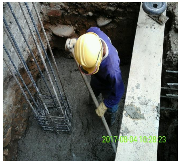
FIGURAS 30 Y 31. VACIADO DE CONCRETO PARA FUNDICION DE ZAPATAS.
