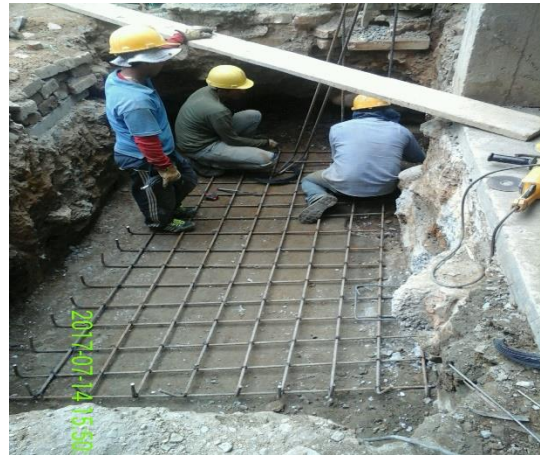
FIGURAS 25 Y 26. AMARRE DE VARILLAS PARA LA PARRILLA DE REFUERZO.
