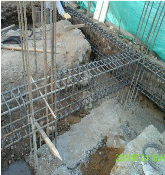
FIGURAS 39 Y 40. ARMADO DE ACEROS PARA VIGAS DE CIMENTACION.
