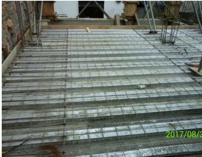
FIGURA 71. INSTALACION DE MALLA ELECTROSOLDADA EN LA LOSA METALDECK.
