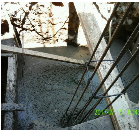
FIGURAS 30 Y 31. VACIADO DE CONCRETO PARA FUNDICION DE ZAPATAS.
