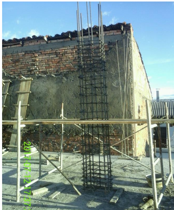
FIGURA 85. ARMADO DE ACEROS PARA COLUMNA C5 EN EL NIVEL 3 DEL BLOQUE 1.
