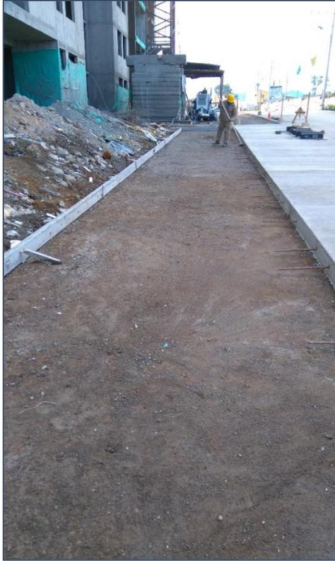
Figura N° 44 Limpieza del área a fundir. Fuente propia
