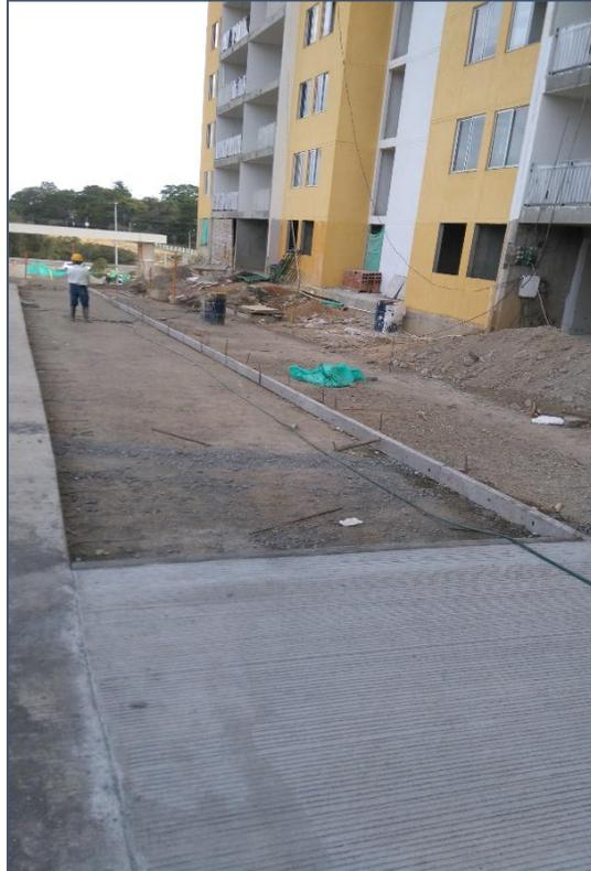
Figura N° 43 Colocación de formaleta. Fuente propia
