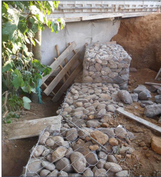
Figura N° 38 Grada entre gaviones de 30 cm. Fuente propia
