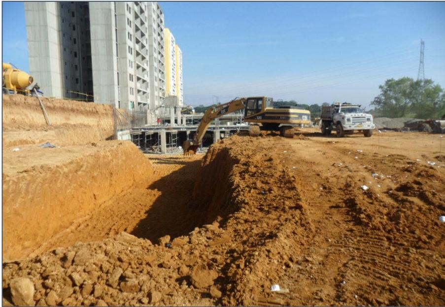
Figura N° 22 Excavación de suelo para box coulvert. Fuente propia
