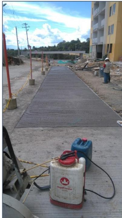
Figura N° 50 Curado del concreto. Fuente propia
