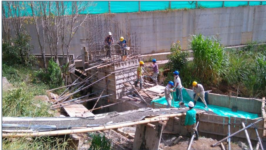
Figura N° 19 Fundición de cámara de inspección. Fuente propia
