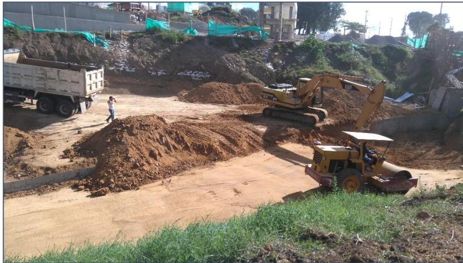
**Figura N° 30 Compactación con equipo mecánico rodillo liso. Fuente propia**
