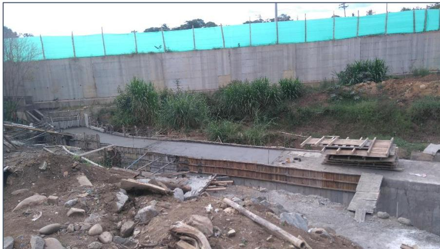
Figura Nº 9 Losa superior terminada. Fuente propia
