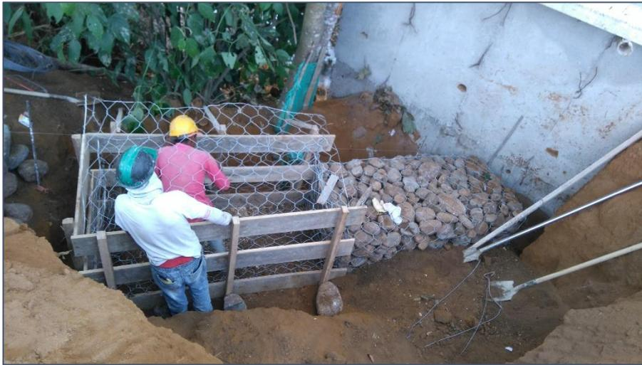
Figura N° 37 Colocación de gaviones. Fuente propia
