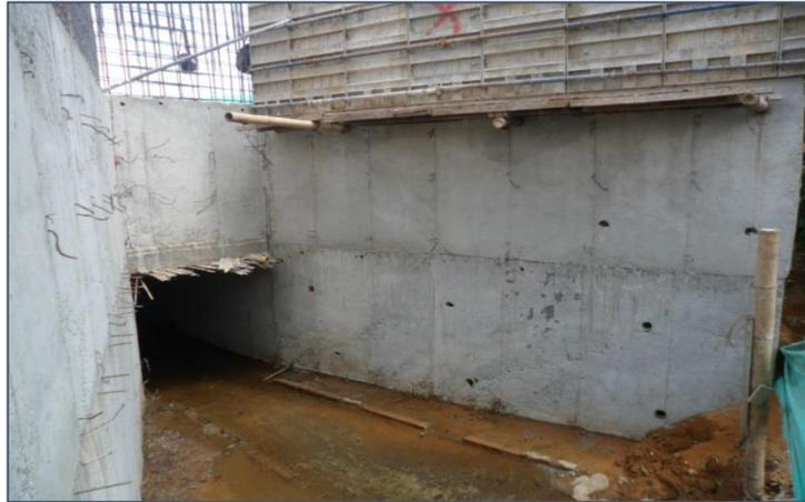
Figura N° 17 Aletas laterales y muro frontal. Fuente propia
