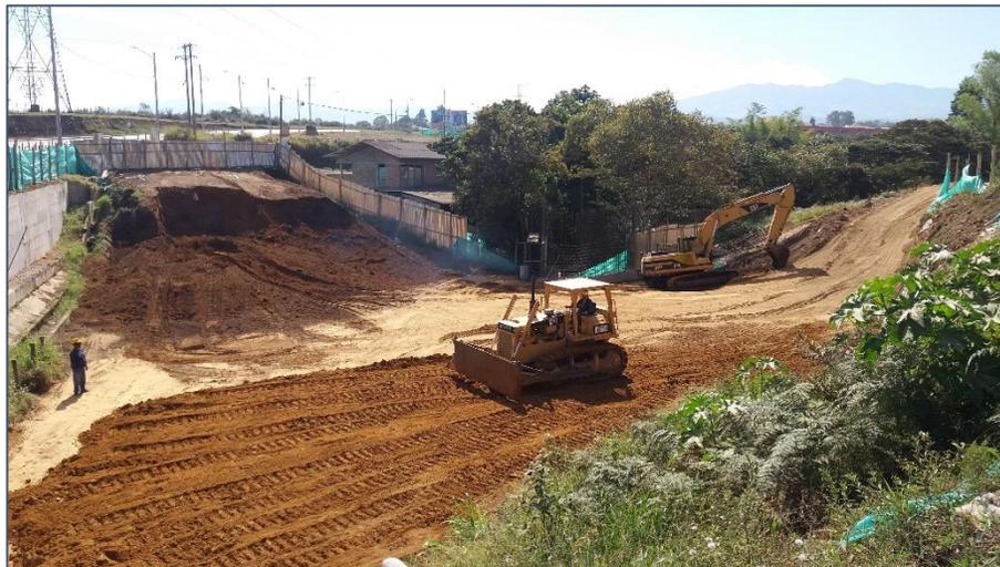
**Figura N° 31 extendido del suelo con equipo mecánico bulldozer. Fuente propia**
