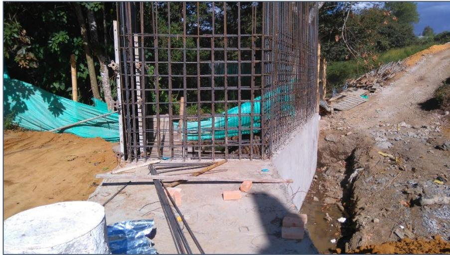
Figura Nº 16 Refuerzo de muro frontal. Fuente propia
