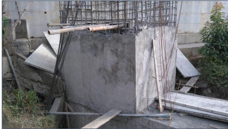
Figura N° 20 Primer tramo de cámara de inspección. Fuente propia
