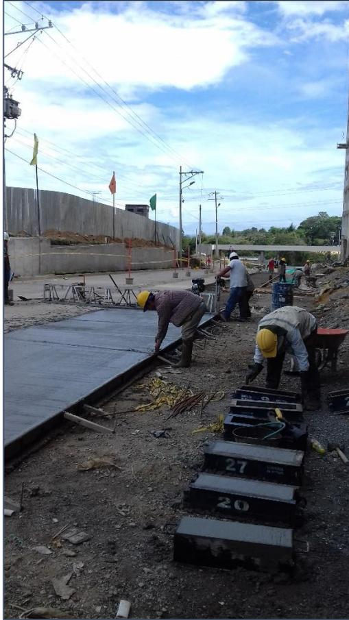
Figura N° 45 Vigas ensayo a flexión. Fuente propia
