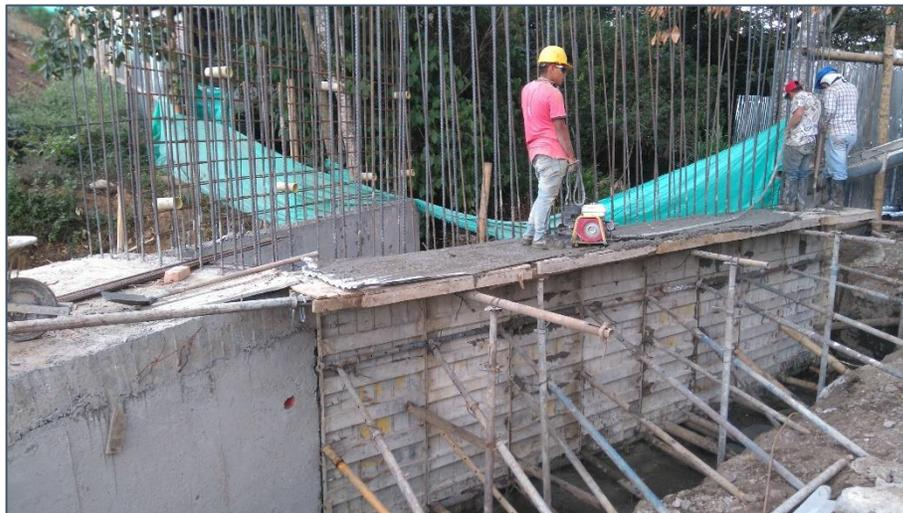
Figura N° 13 Fundición muro lateral. Fuente propia
