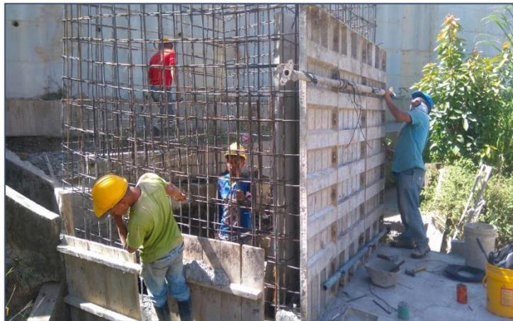
Figura N° 18 Encofrado y refuerzo cámara de inspección. Fuente propia
