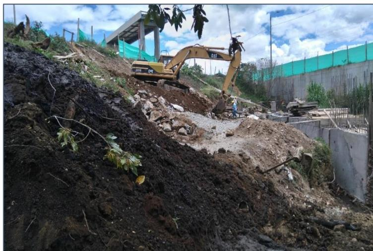
Figura N° 24 Descapote para relleno sobre box coulvert. Fuente propia
