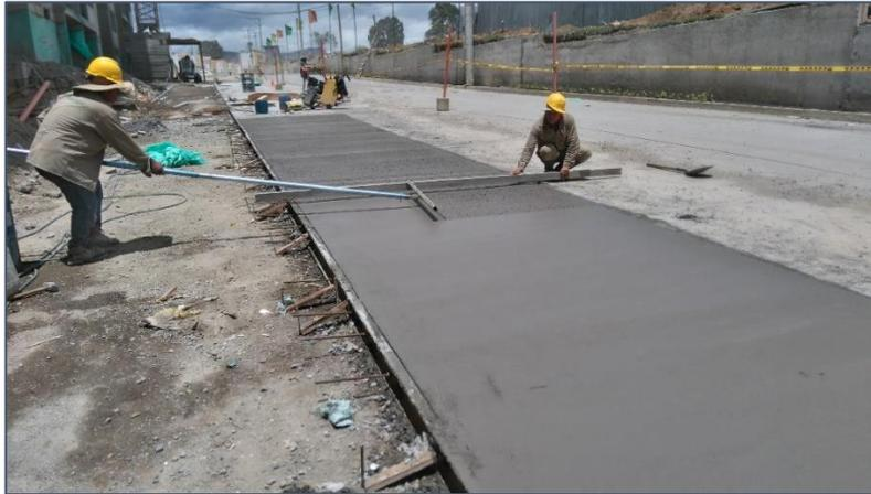
Figura N° 49 Texturizado del concreto. Fuente propia
