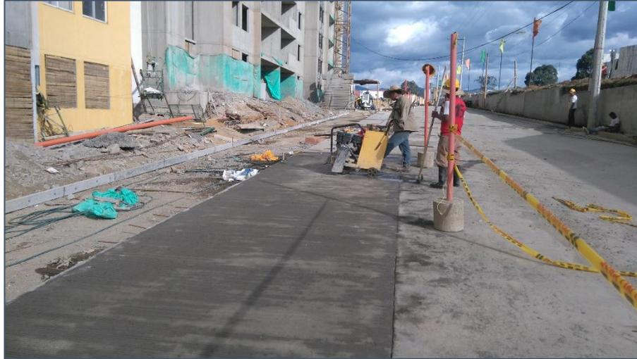
Figura N° 51 Corte de juntas. Fuente propia
