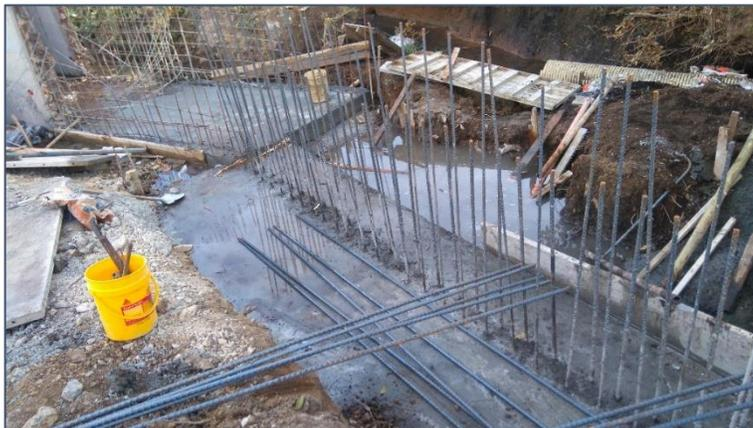
Figura N° 12 Zapata de muro de contención. Fuente propia
