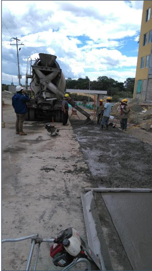
Figura N° 47 Vibrado del concreto. Fuente propia
