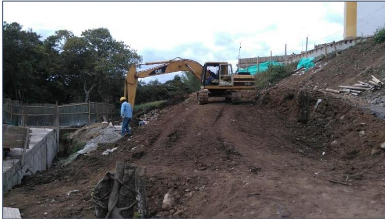
Figura N° 25 Vía de acceso para el ingreso de maquinaria. Fuente propia
