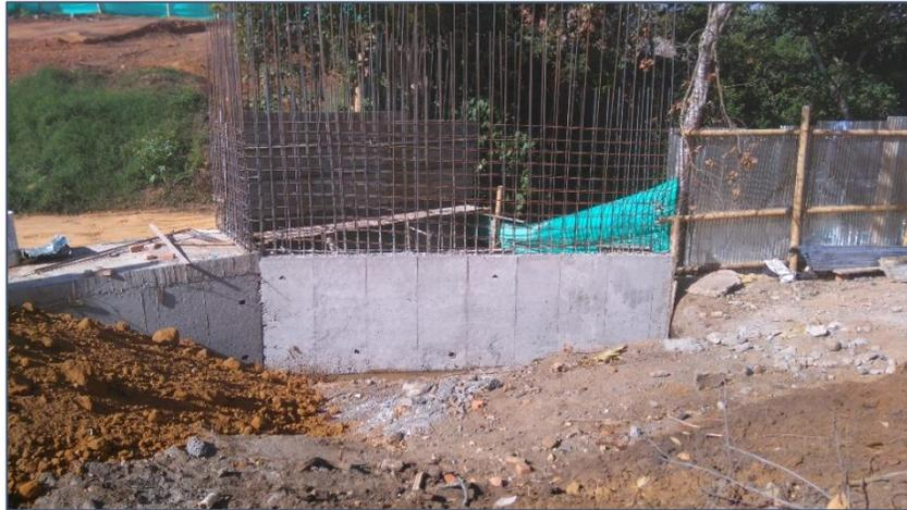
Figura N° 14 Primer tramo de muro de contención. Fuente propia
