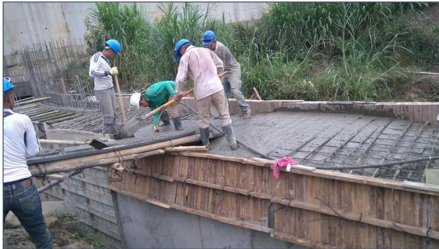
Figura Nº 8 Colocación de concreto. Fuente propia
