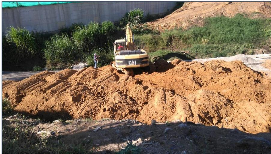
Figura N° 29 Retiro de material orgánico, colocación y extendido de suelo sobre box culvert Fuente propia
