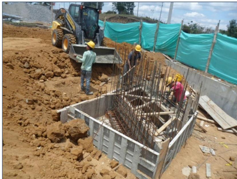
Figura N° 21 Reducción de sección en cámara de inspección. Fuente propia
