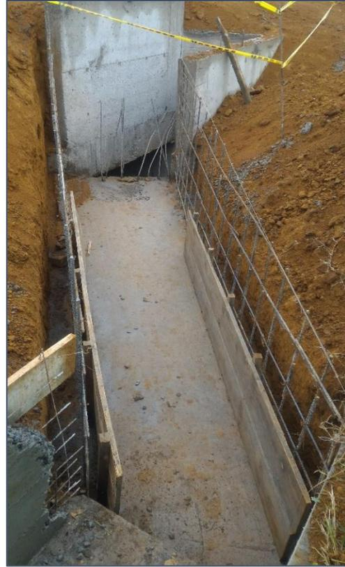
Figura N° 42 Disipador de energía. Fuente propia
