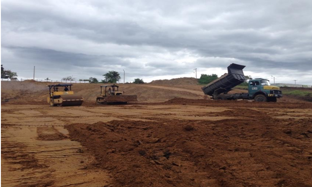
Figura 21. Adecuación zona de relleno materia de corte. Fuente: Elaboración propia.
