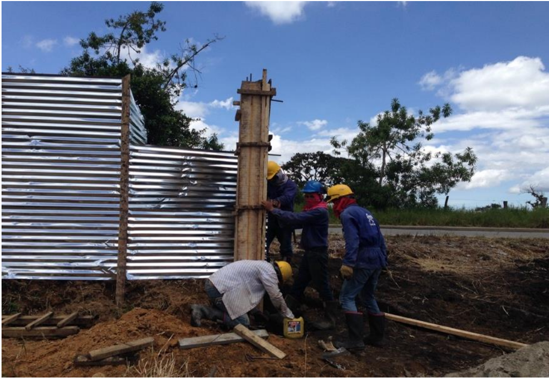
Figura 11. Ejecución y desarrollo del cerramiento. Fuente: Elaboración propia.
