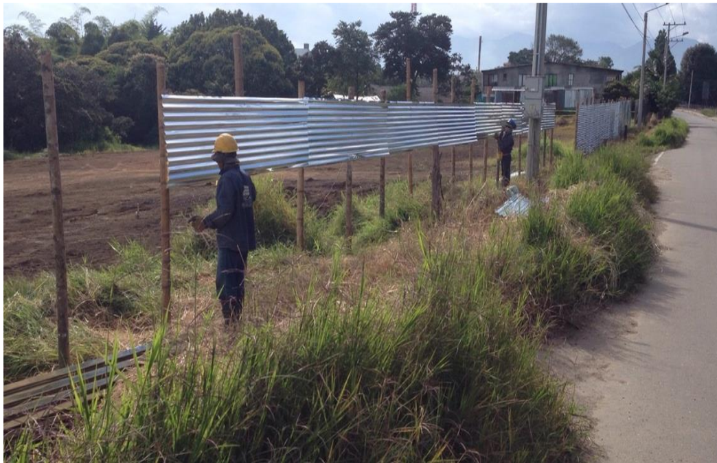
Figura 10. Construcción cerramiento temporal del proyecto. Fuente: Elaboración propia.
