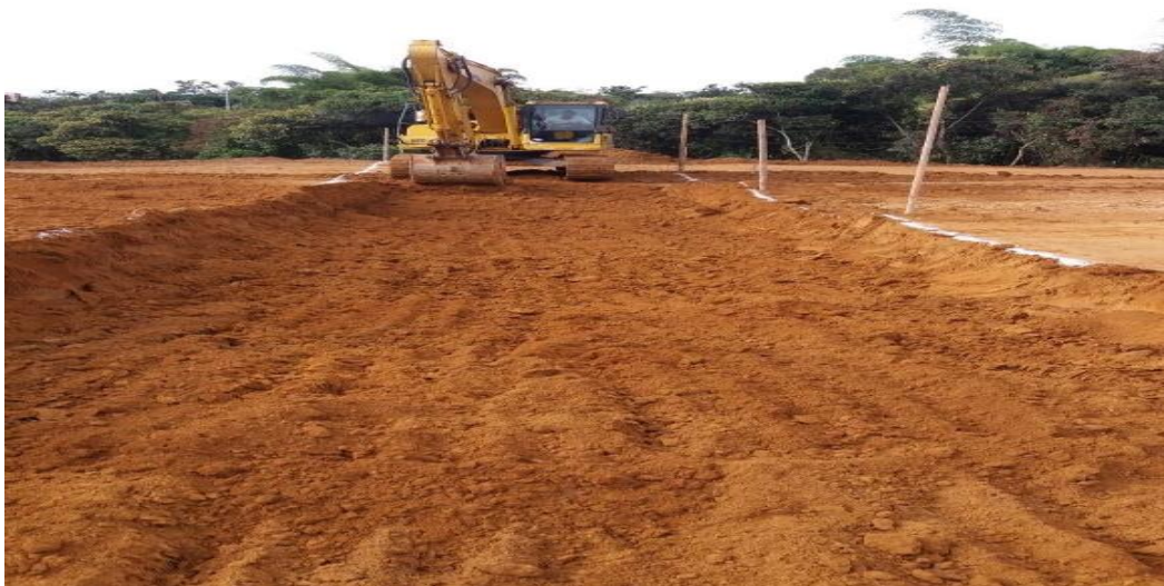
Figura 37. Excavación cajones para vía. Fuente: Elaboración propia.
