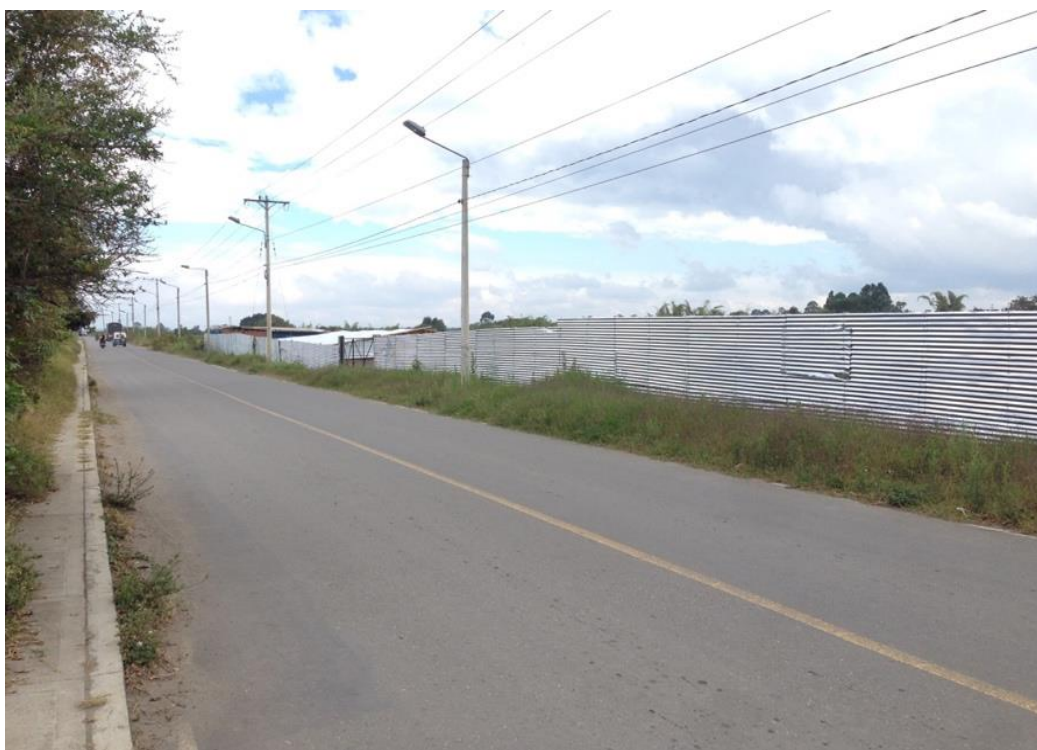
Figura 14. Cerramiento temporal del proyecto. Fuente: Elaboración propia.
