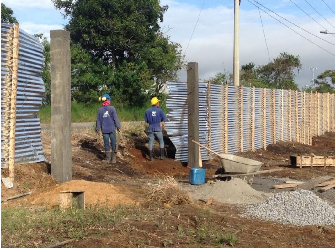
Figura 12. Ejecución y desarrollo del cerramiento. Fuente: Elaboración propia.
