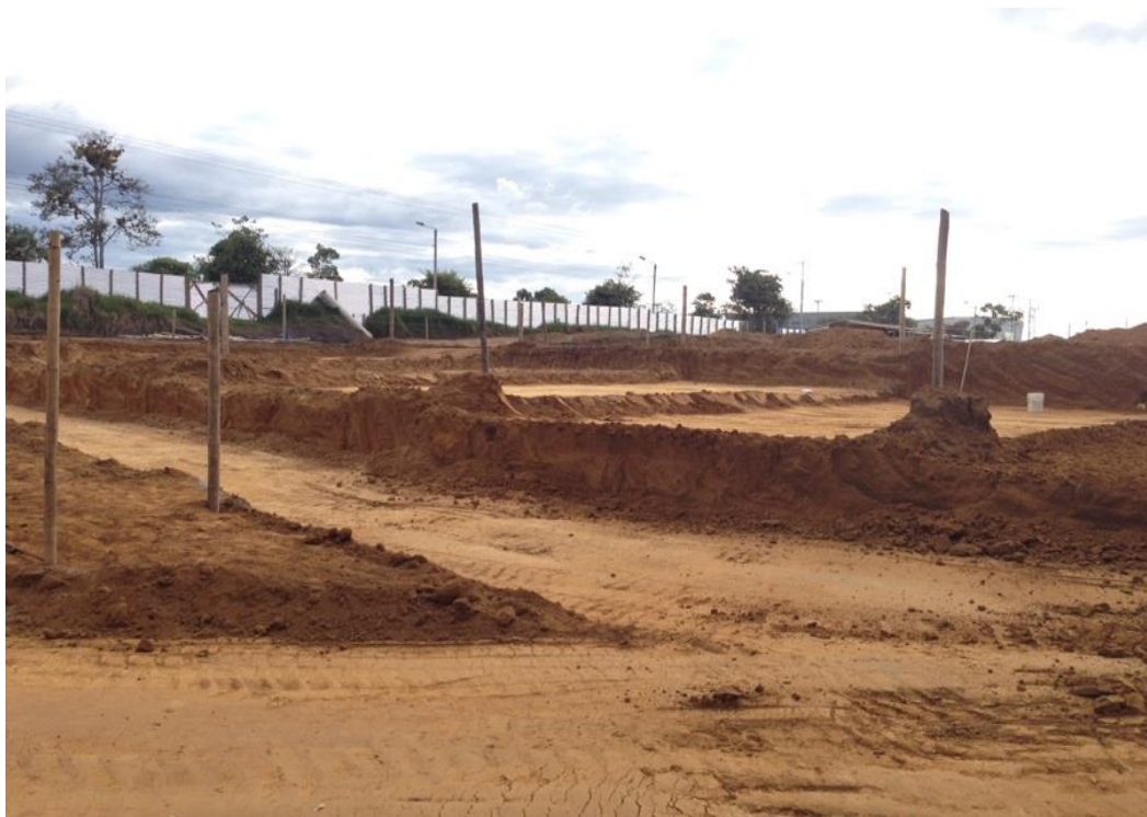
Figura 35. Terrazas casas y excavación cajón de vía. Fuente: Elaboración propia.
