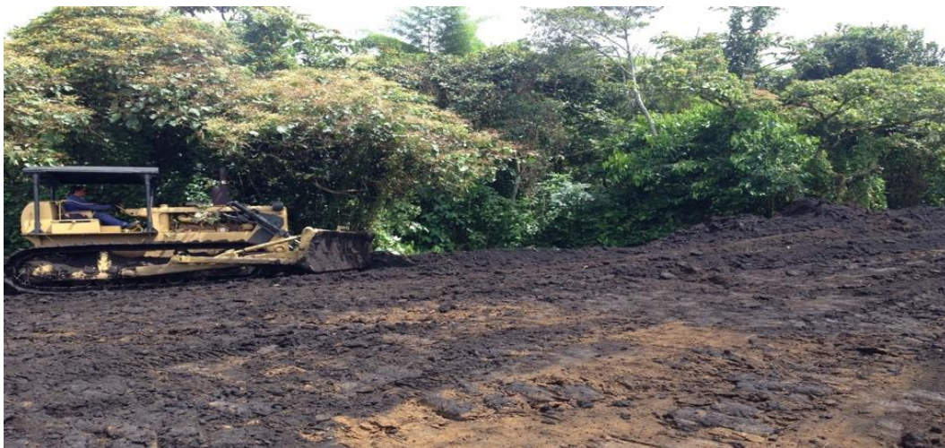
Figura 6. Remoción de capa orgánica para construcción campamento. Fuente: Elaboración propia.
