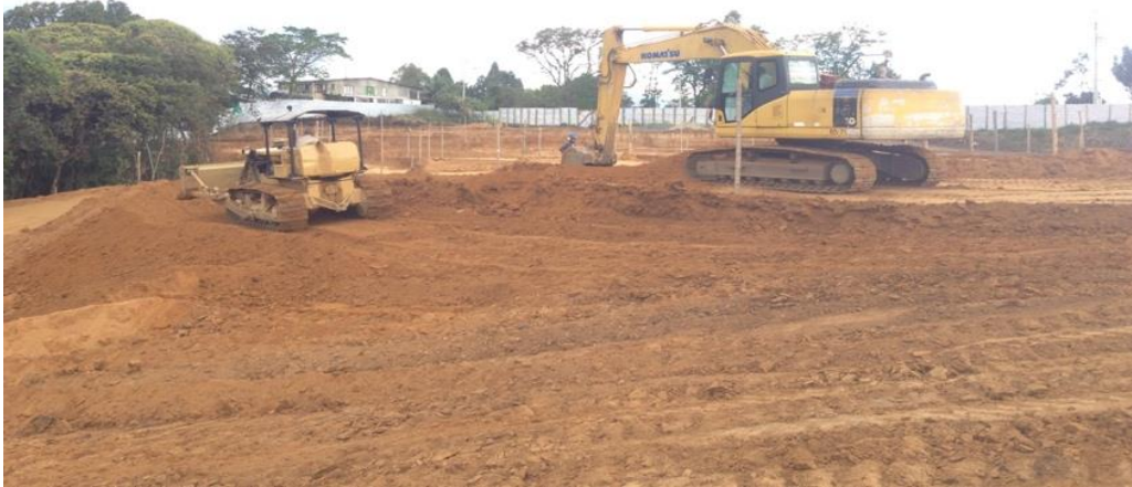
Figura 32. Corte terrazas individuales casas. Fuente: Elaboración propia.
