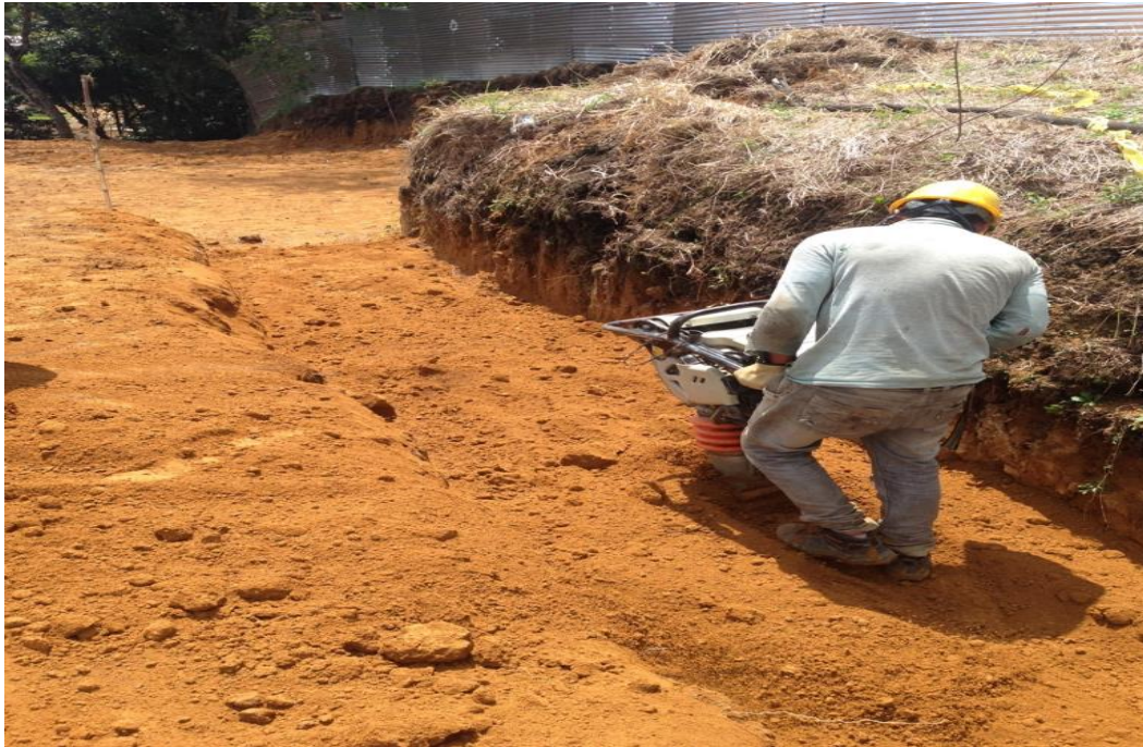
Figura 30. Compactación con saltarin del material de trabajo. Fuente: Elaboración propia.
