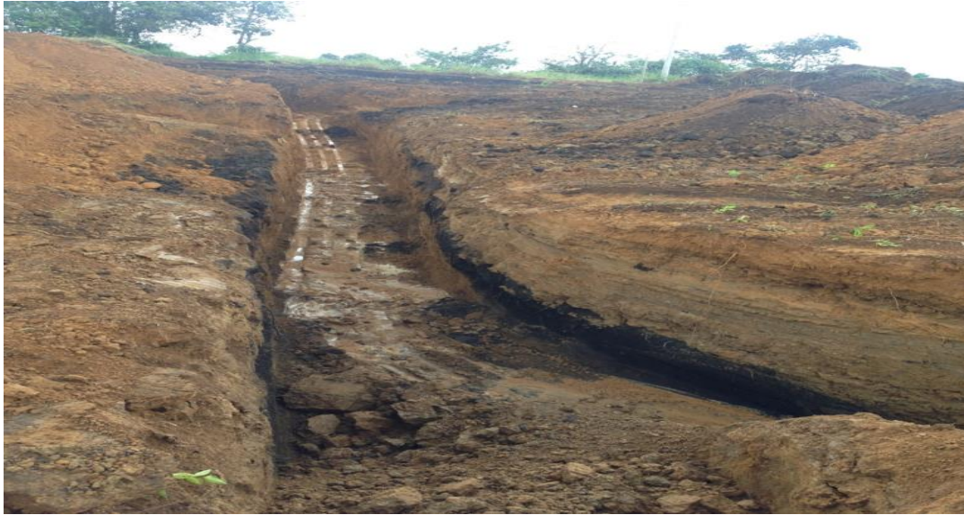
Figura 19. Zona antigua de botadero material de corte. Fuente: Elaboración propia.
