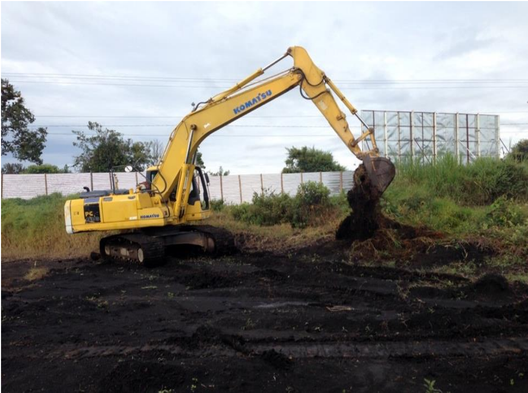
Figura 7. Remoción de material orgánico. Fuente: Elaboración propia.
