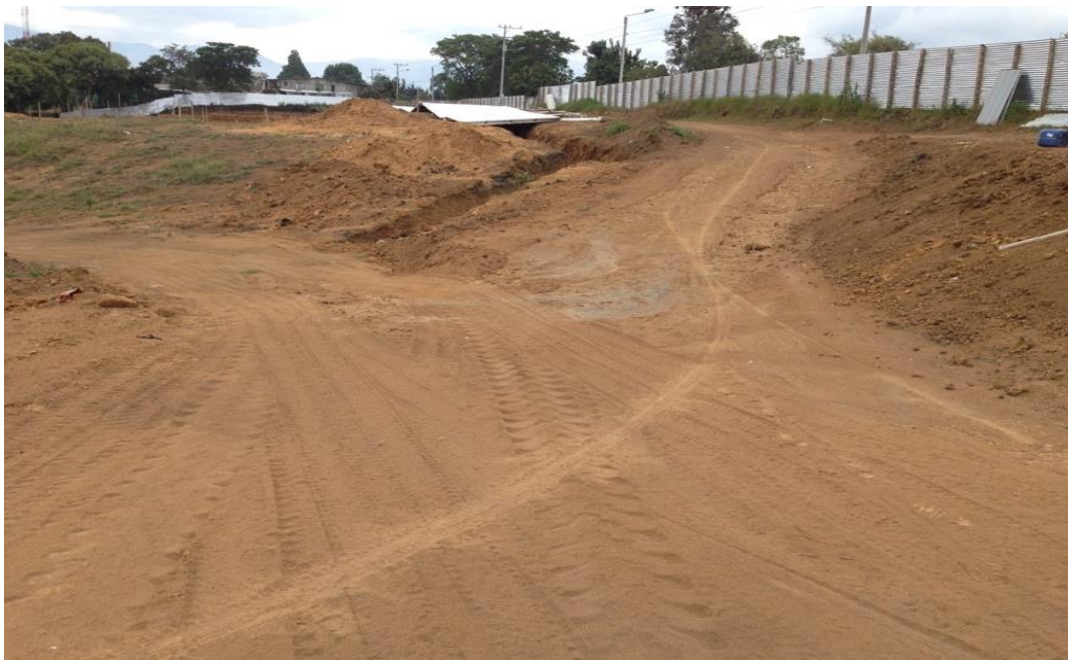
Figura 23. Vía temporal. Fuente: Elaboración propia.
