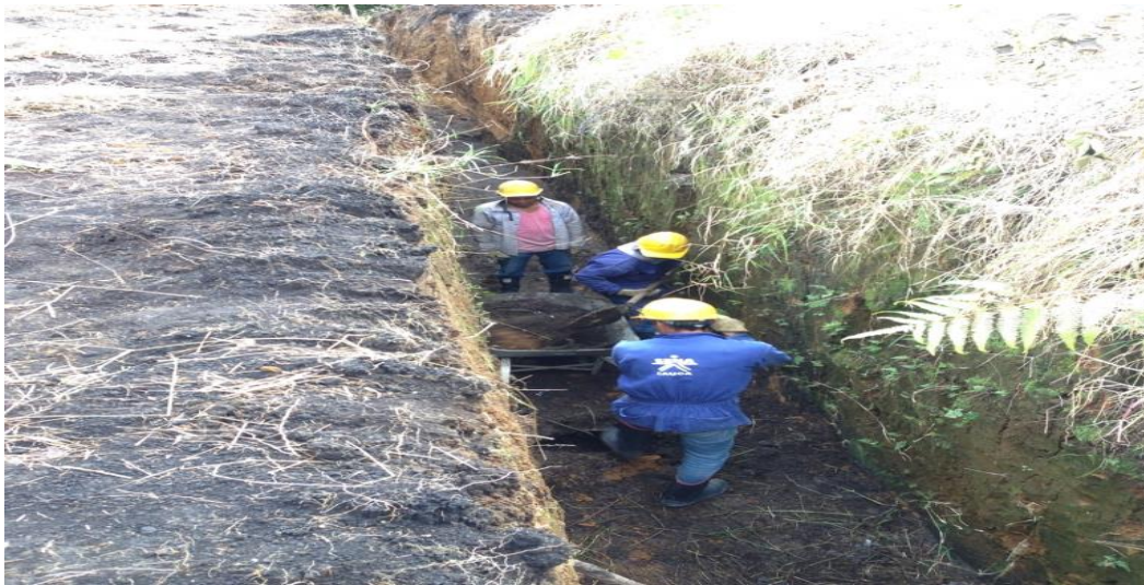
Figura 29. Limpieza zanja de material organico. Fuente: Elaboración propia.
