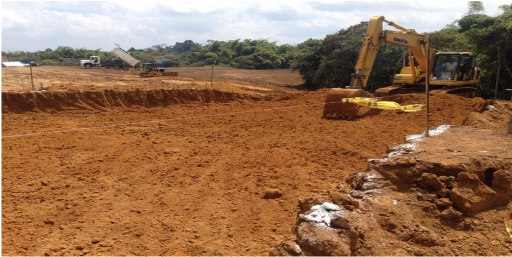
Figura 36. Excavación cajones para vía. Fuente: Elaboración propia.
