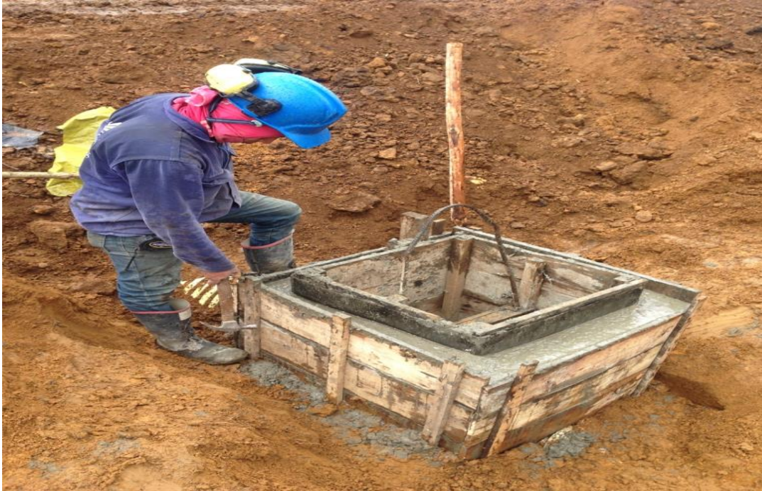
Figura 24. Construcción caja de inspección. Fuente: Elaboración propia.
