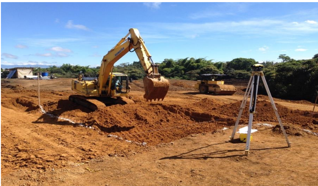
Figura 31. Verificación de cotas con nivel de precisión. Fuente: Elaboración propia.
