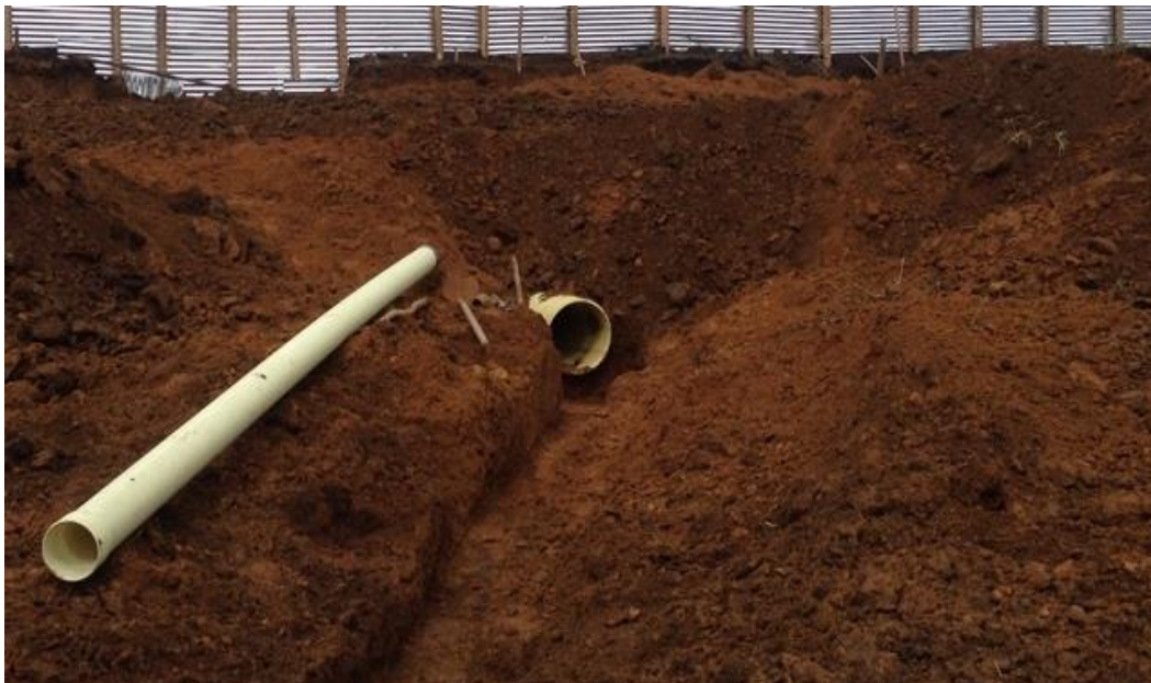
Figura 25. Colocación tubería 10". Fuente: Elaboración propia.
