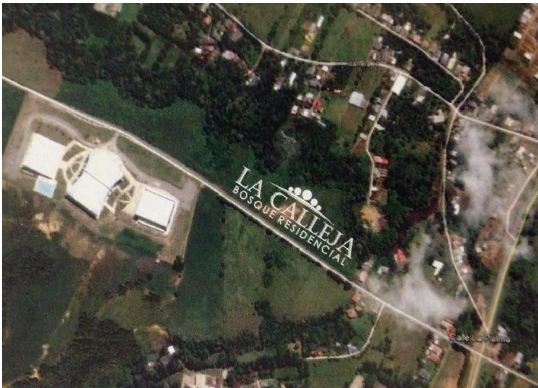
Figura 2. Localización del proyecto. Fuente: Procal Constructores.
