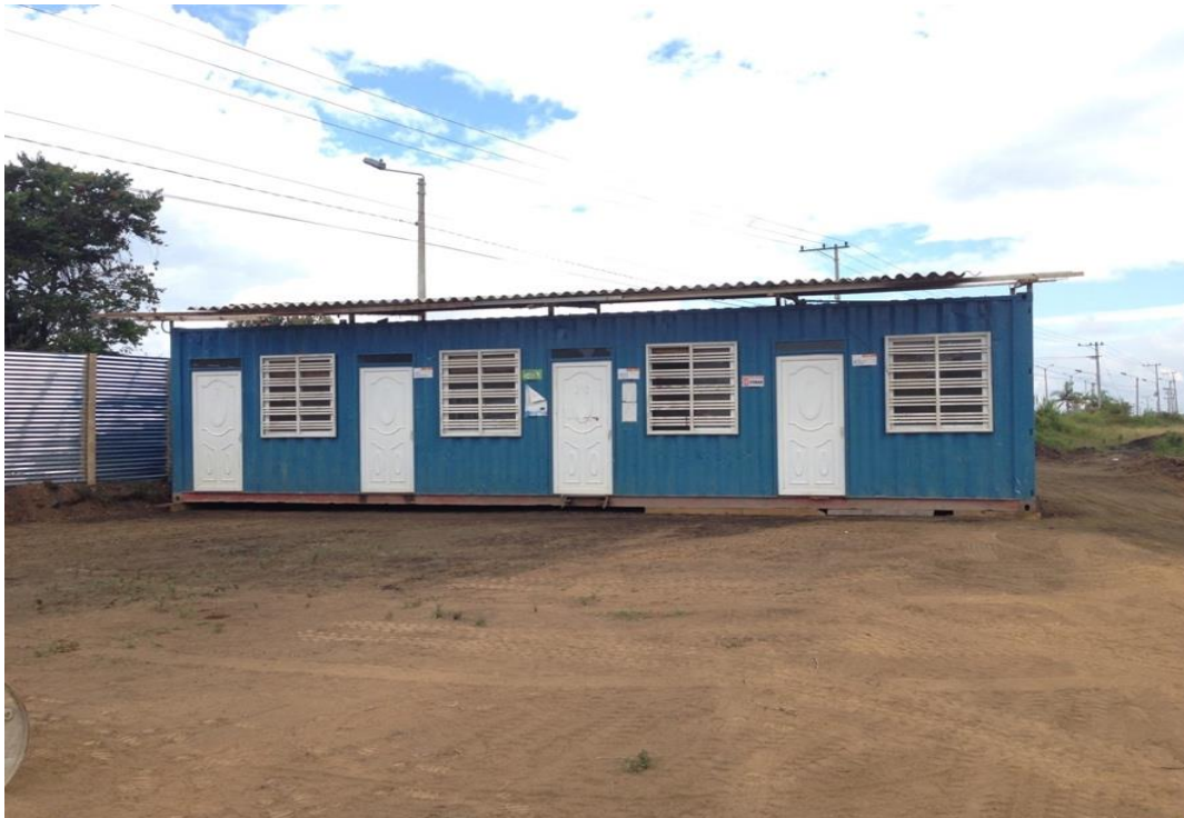
Figura 15. Oficinas de la obra. Fuente: Elaboración propia.
