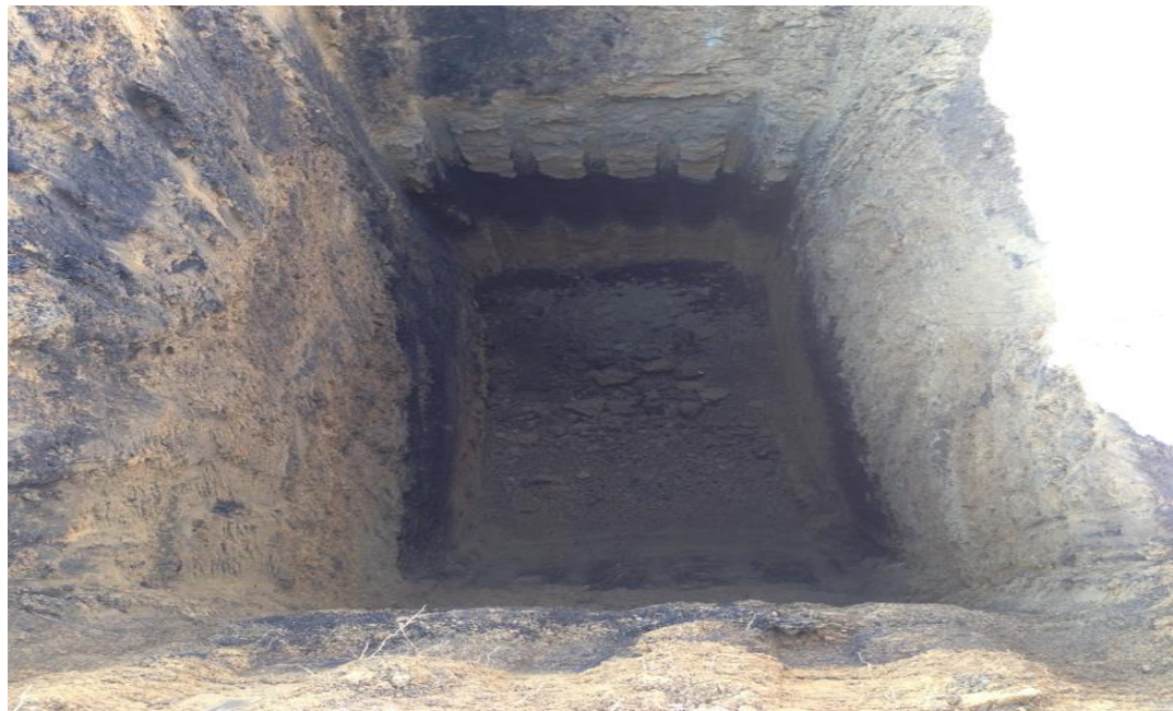
Figura 20. Apique para conocer estratos de suelos inferiores. Fuente: Elaboración propia.
