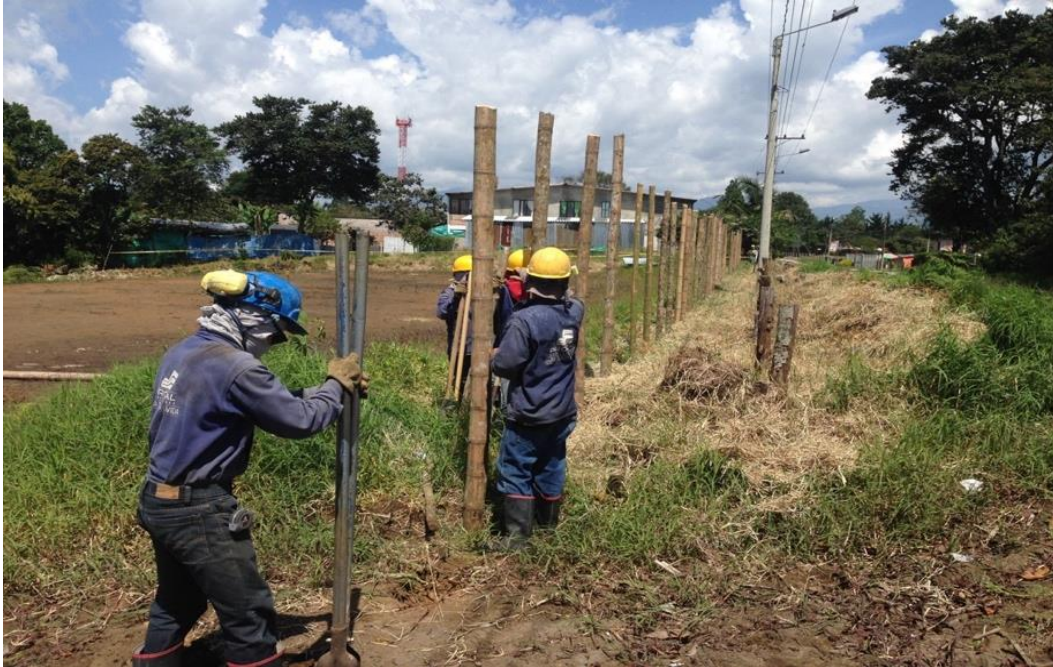
Figura 9. Ejecución y desarrollo del cerramiento. Fuente: Elaboración propia.
