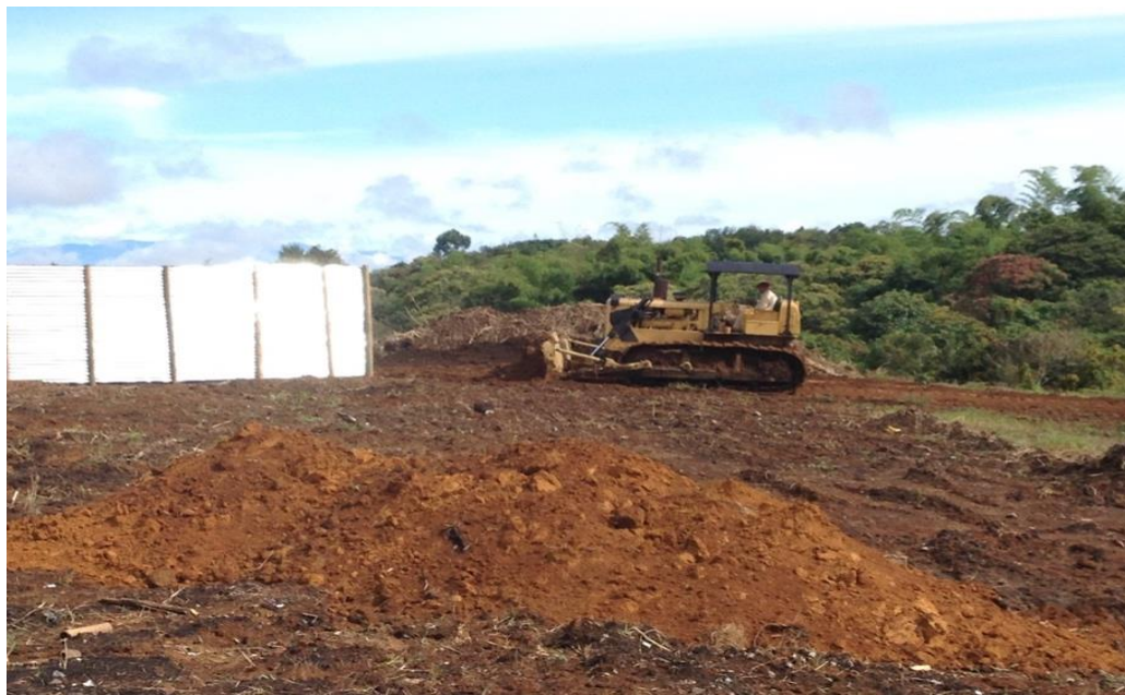
Figura 18. Remoción de material contaminado con bulldozer. Fuente: Elaboración propia.
