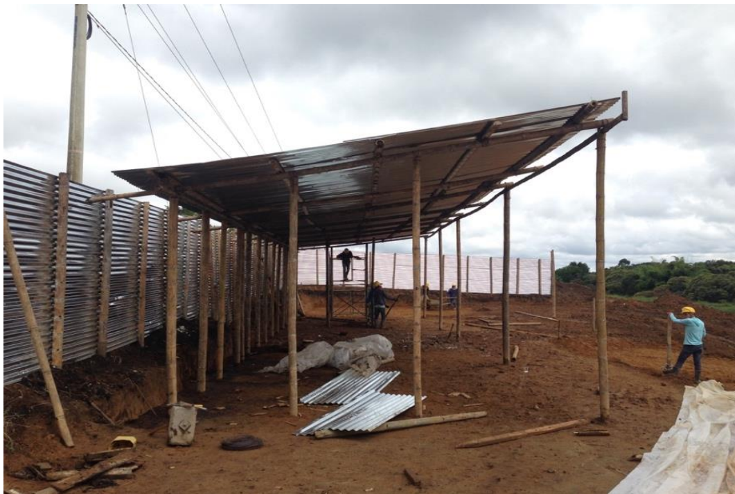
Figura 13. Ejecución y desarrollo del campamento. Fuente: Elaboración propia.
