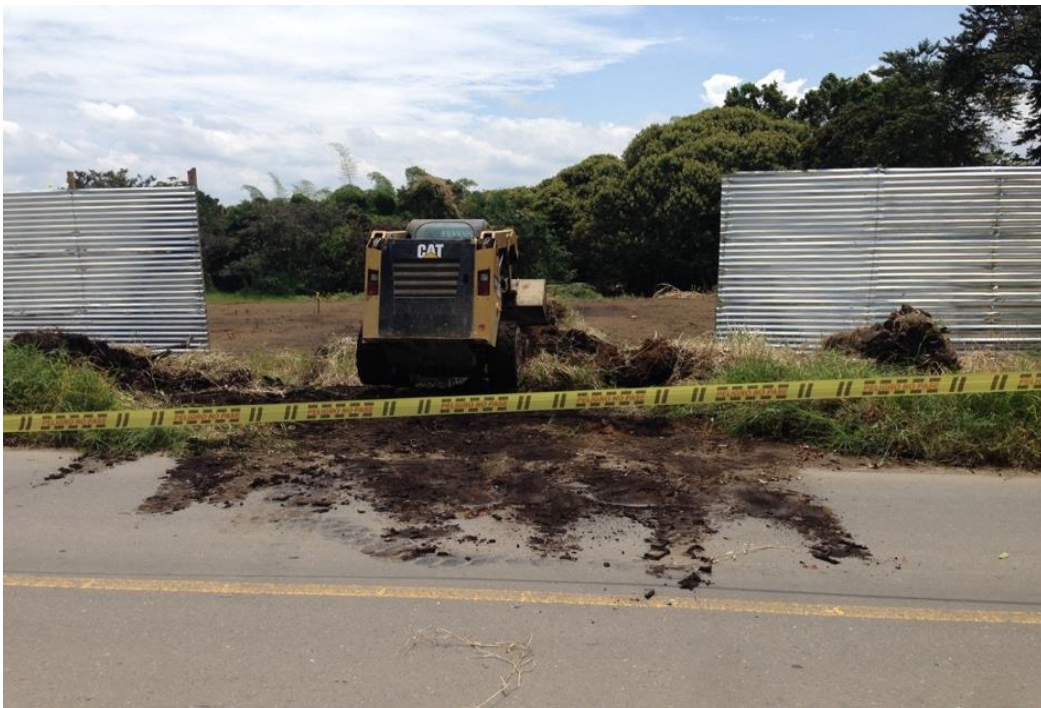
Figura 8. Limpieza de material orgánico con bobcat. Fuente: Elaboración propia.
