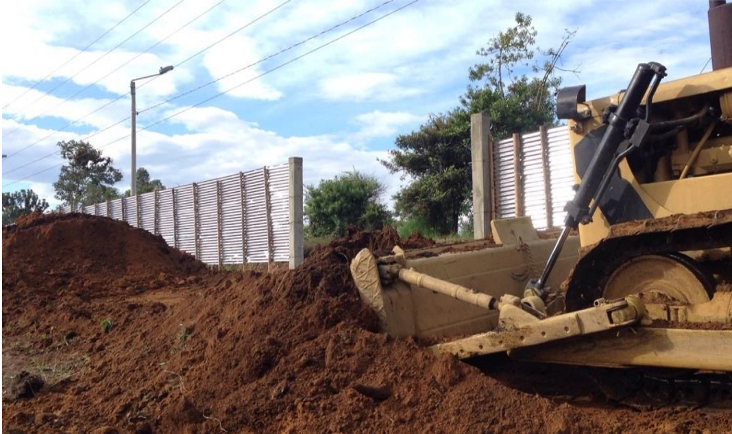
Figura 22. Bulldozer Cat D6 realizando corte para futura via temporal. Fuente: Elaboración propia.
