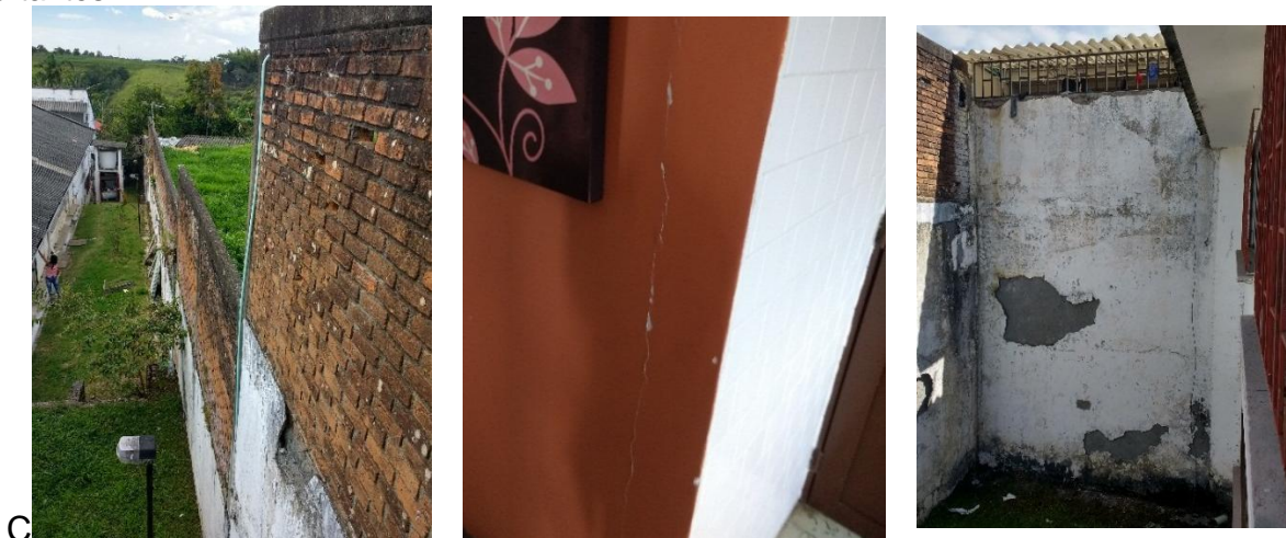
Figura 31. Fotografías detalle de la estructura existente.
