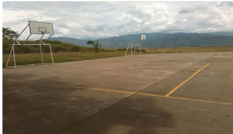
Figura 16. Cancha multiple, Institucion Educativa Bachillerato Patia Fuente: Estudio de suelos.
