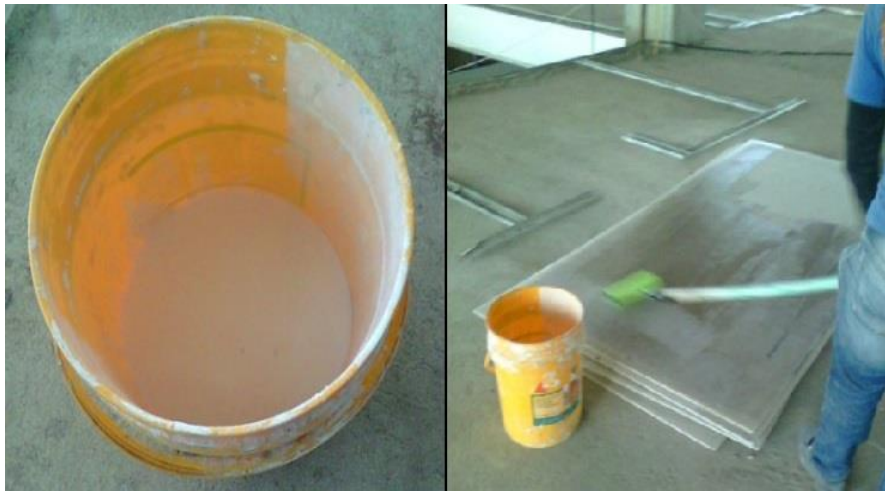
Figura 33. Impermeabilización con Acronal 1 A
