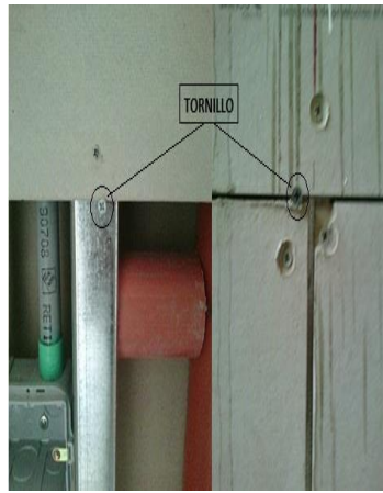
Figura 22. Tornillo para dilatación entre placas
