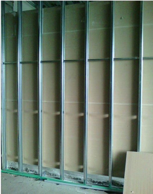
Figura 54. Muro panel yeso 2 caras a 1 placa
