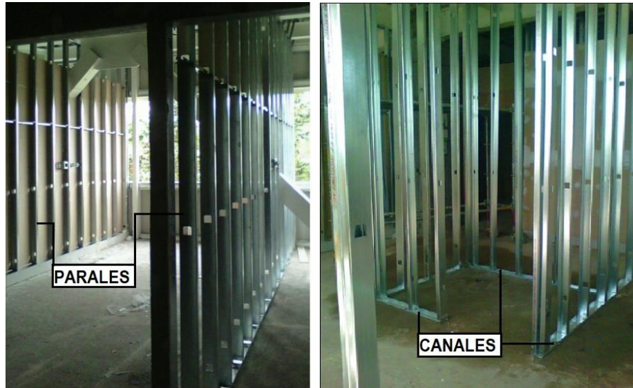
Figura 5. Estructura interna de un muro
