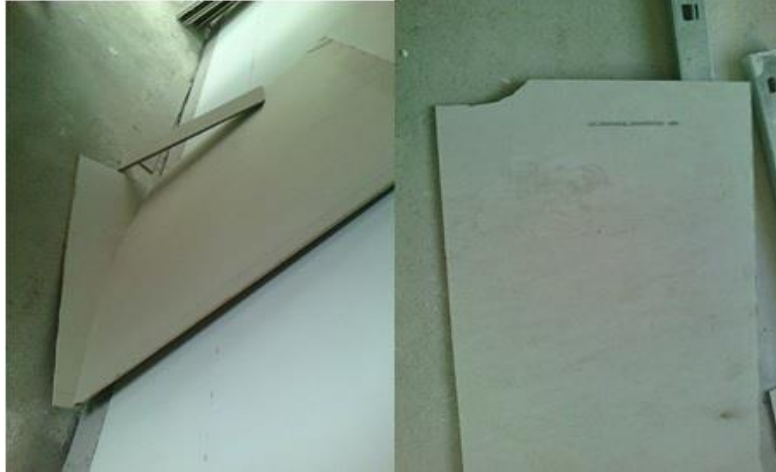
Figura 49. Placas deterioradas
