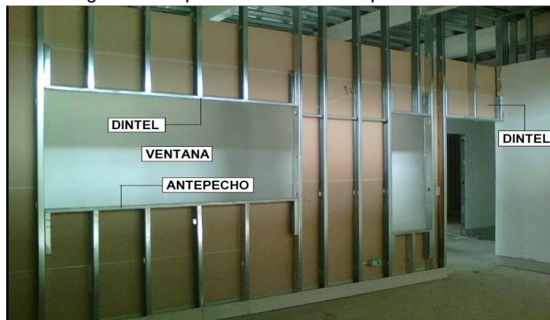
Figura 19. Disposición de estructura para aberturas
