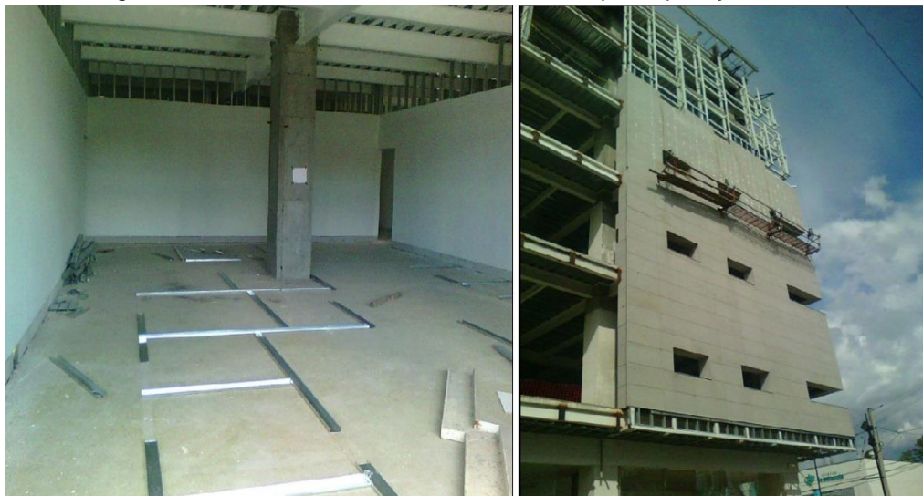
Figura 42. Sin actividad en construcciones de quinto piso y fachadas
