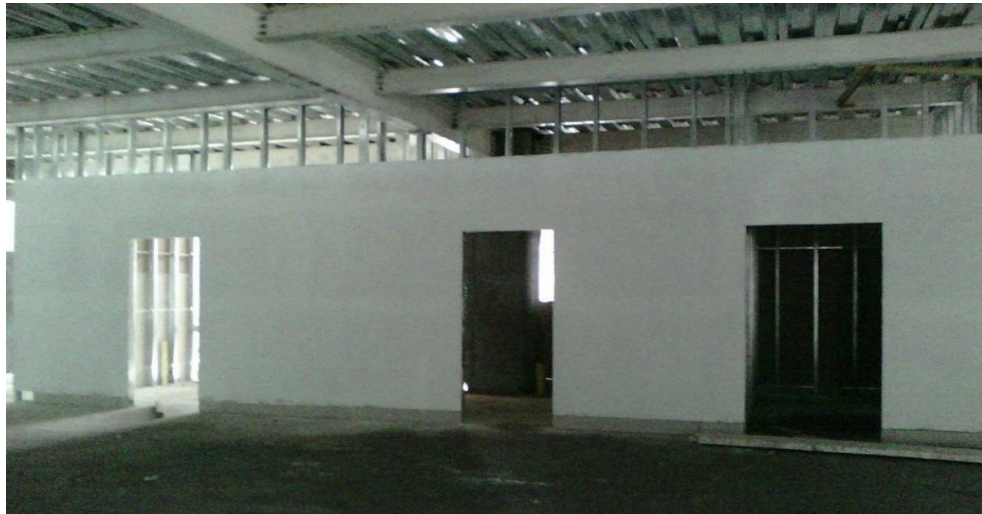
Figura 27. Acabados. Aplicación de 3 manos de pintura sobre muro
