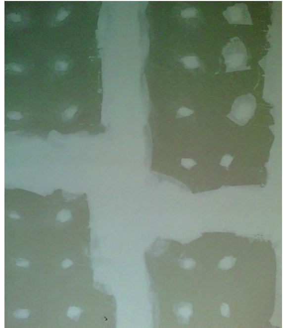
Figura 55. Muro en etapa de masillado
