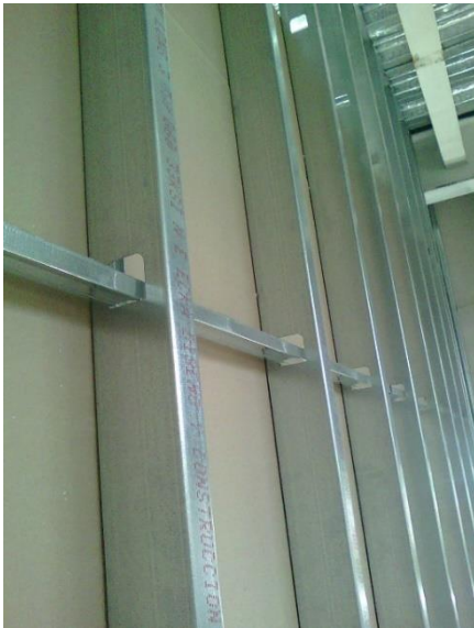
Figura 17. Instalación de riostra
