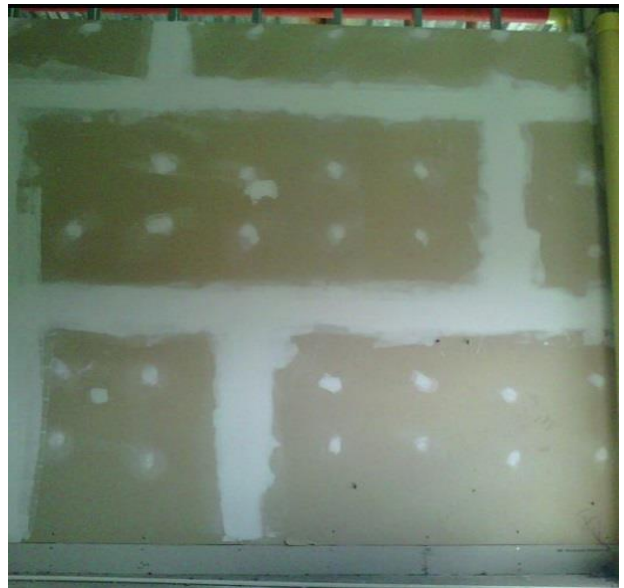
Figura 26. Masillado en un muro panel yeso 2 caras
