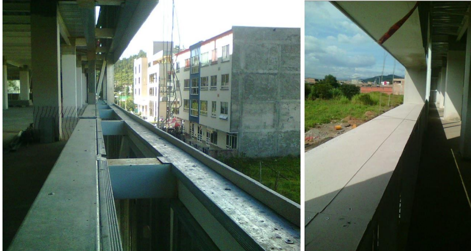
Figura 31. Estructura y emplacado de carteras dobles en marcos de ventanas
