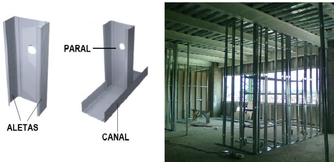
Figura 16. Instalación de parales sobre canales
