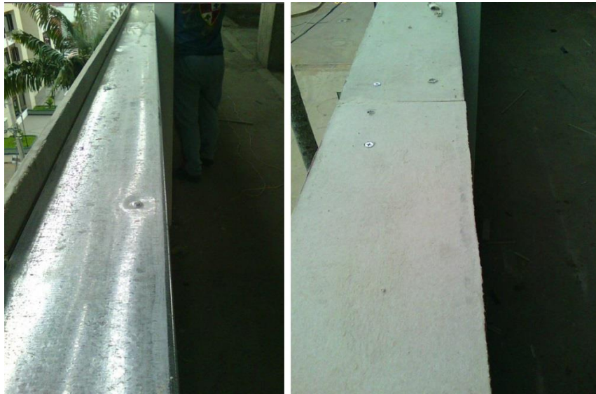
Figura 30. Estructura y emplacado de carteras sencillas en marcos de ventanas
