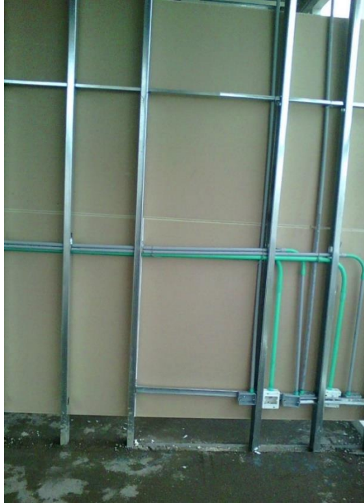
Figura 47. Estructura a corregir, para la más de 40.6 cm
