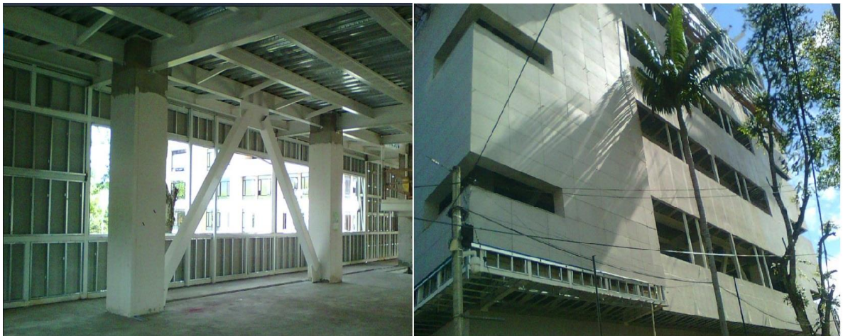
Figura 51. Estructurado y emplacado de la fachada sur
