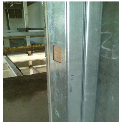
Figura 18. Estructura en esquina y marcos de puertas de muros
