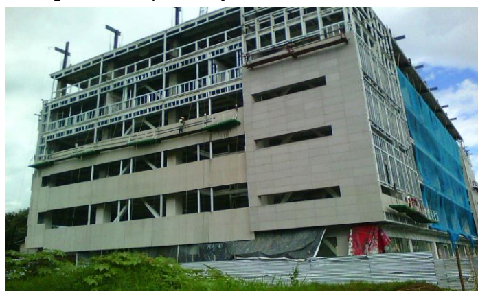
Figura 38. Emplacado y estructurado fachada norte
