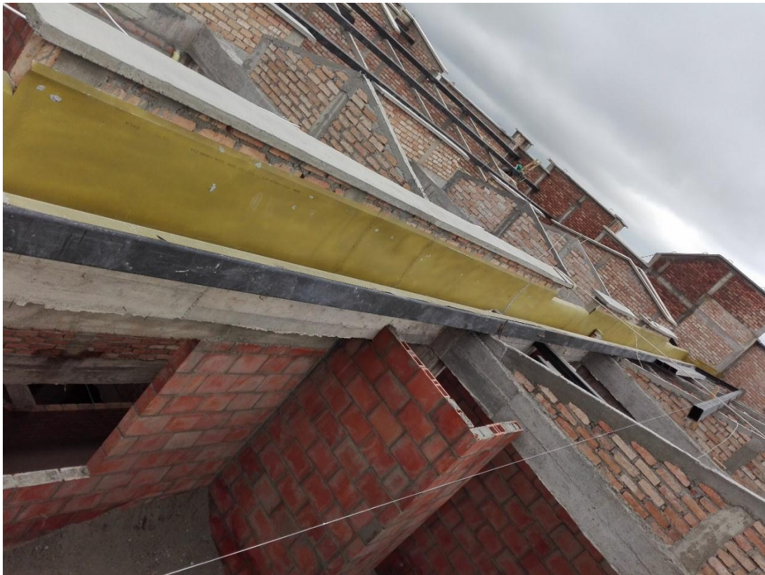
Figura 22. Canales de recolección de aguas lluvias y nivelado de correas.
