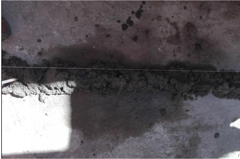
Figura 10. Colocación hilos y mezcla de pega. FUENTE. Propia.
