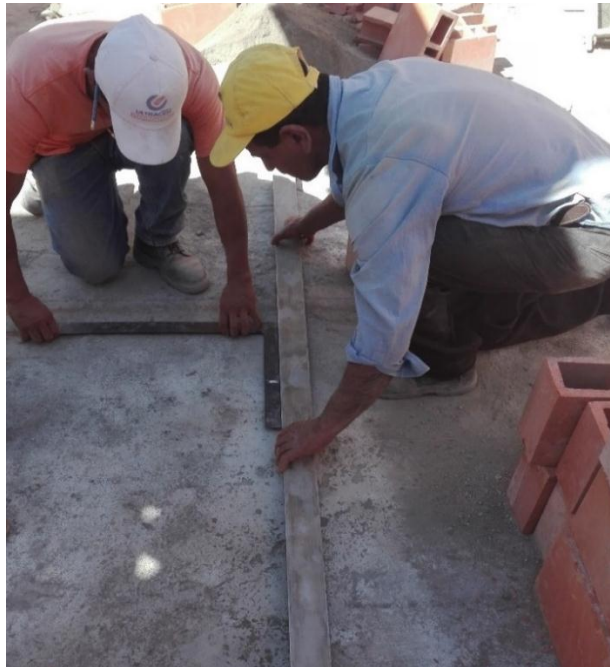
Figura 6. Proceso de marcación.
