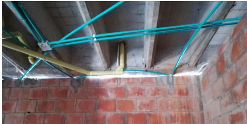
Figura 32. Caja para luminaria. FUENTE. Propia.
