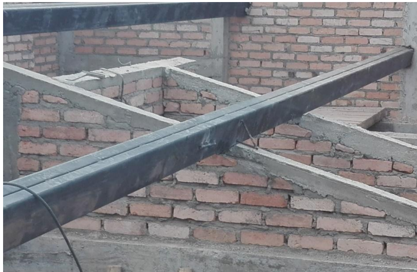
Figura 19. Instalación de correas.
