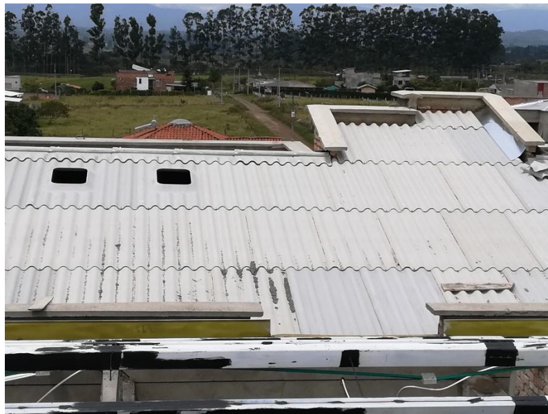
Figura 29. Instalación de flanches. FUENTE. Propia.
