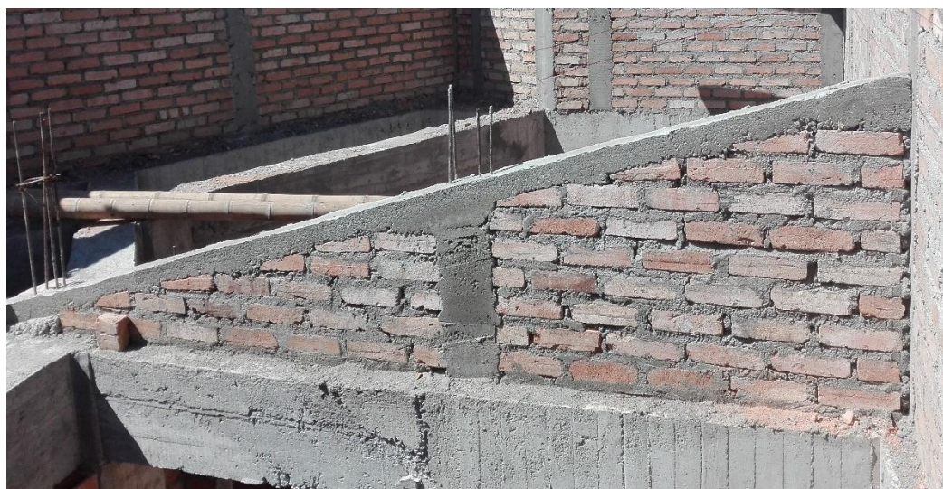
Figura 14. Mampostería de culatas, columnetas y cintas de amarre. FUENTE. Propia.
