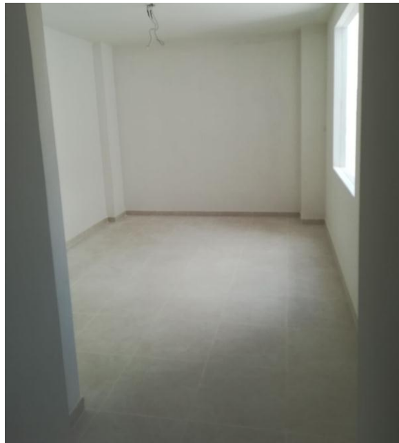
Figura 45. Piso terminado en aparta estudios. FUENTE. Propia.
