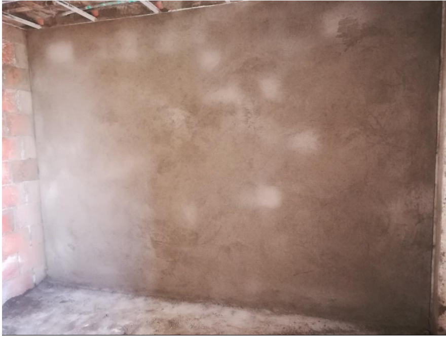
Figura 28. Pañete de muro con repello con mortero. FUENTE. Propia.
