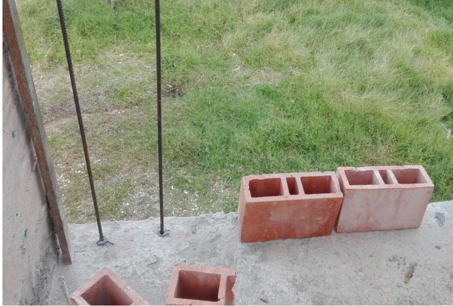
Figura 9. Anclaje de acero vertical a estructura. FUENTE. Propia.
