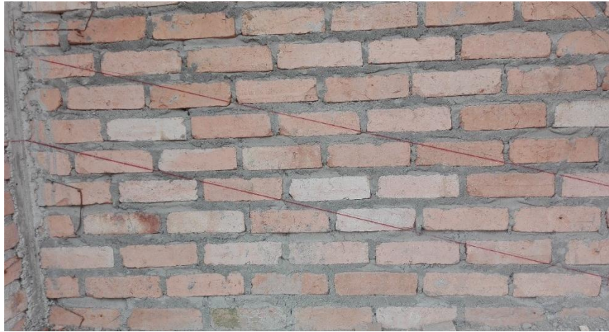
Figura 18. Cimbrado para colocación de correas.
