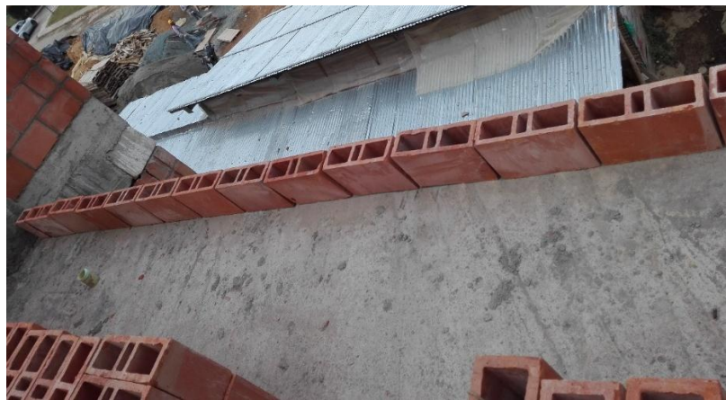
Figura 8. Colocación para acomodo de ladrillo.
