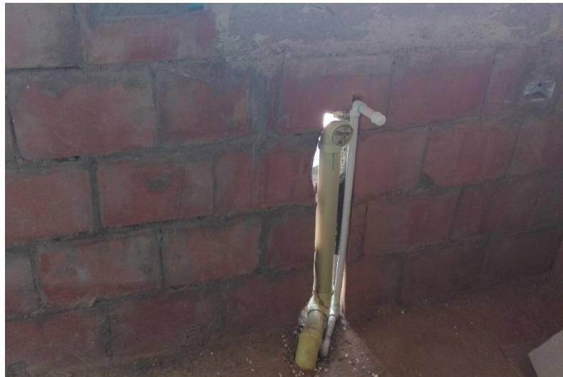
Figura 25. Instalación de puntos sanitario e hidráulico del lavaplatos. FUENTE. Propia.
