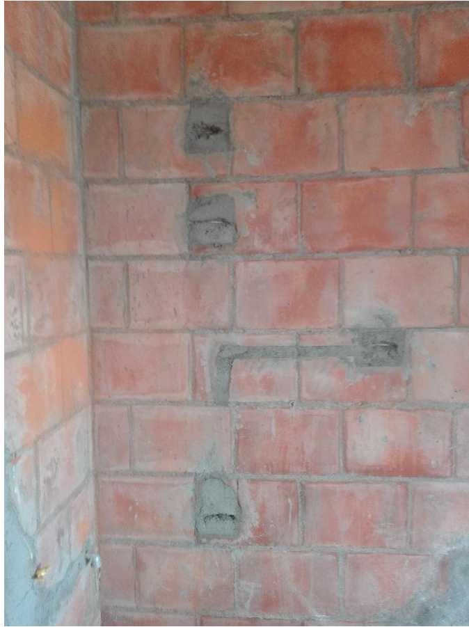
Figura 33. Toma corrientes de chispero, campana, microondas, licuadora. FUENTE. Propia.
