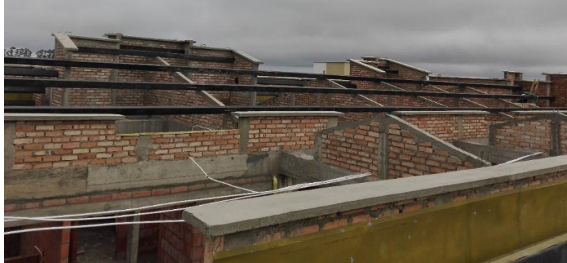
Figura 20. Correas instaladas.
