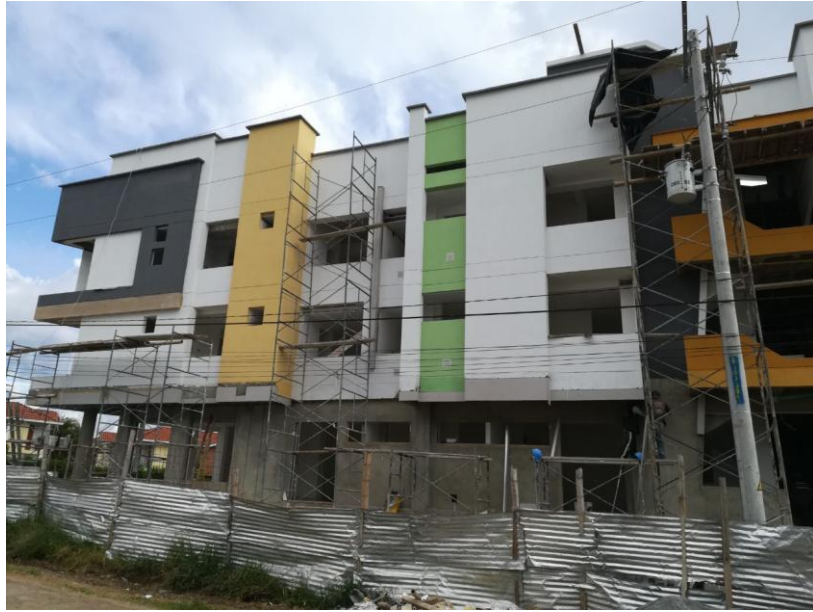
Figura 5. Granotex fachada calle 52 norte. FUENTE. Propia.
