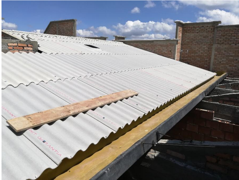
Figura 30. Cubierta con tejas de fibrocemento y canal de recolección de aguas lluvias. FUENTE. Propia.
