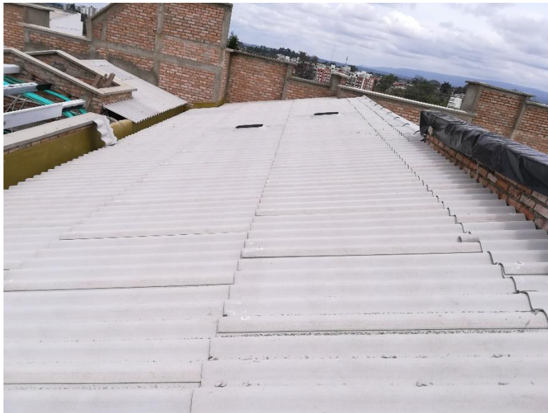
Figura 31. Cubierta con tejas de fibrocemento. FUENTE. Propia.
