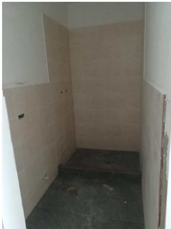
Figura 32. Enchape de baño. FUENTE. Propia.
