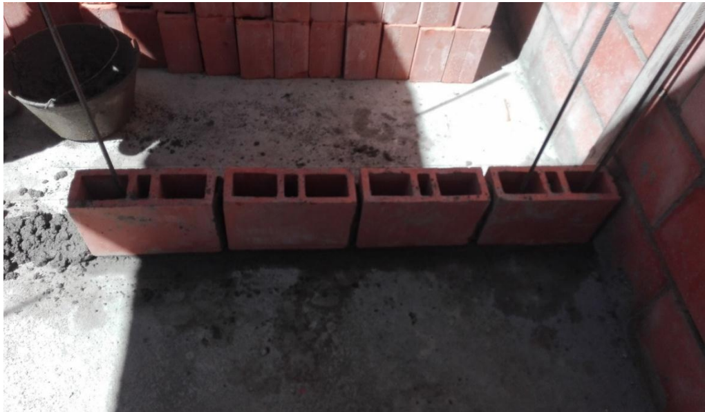
Figura 11. Colocación primer hilada de ladrillo. FUENTE. Propia.
