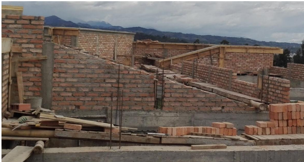
Figura 14. Mampostería de culatas y colocación de refuerzos. FUENTE. Propia.
