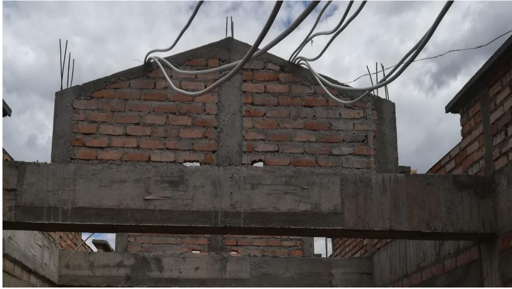
Figura 15. Mampostería de culatas, columnetas y cintas de amarre. FUENTE. Propia.
