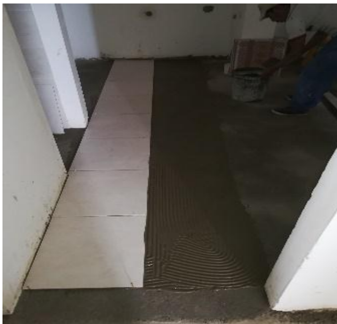
Figura 31. Proceso pega de piso. FUENTE. Propia.
