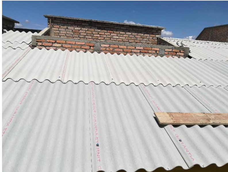
Figura 27. Cubierta con Tejas de fibrocemento. FUENTE. Propia.
