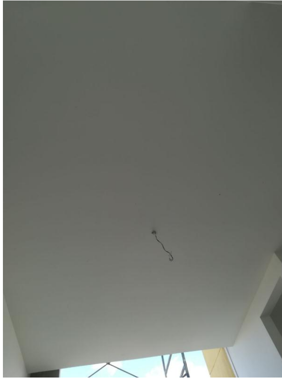
Figura 34. Cielo raso con tratamiento hasta segunda mano.
