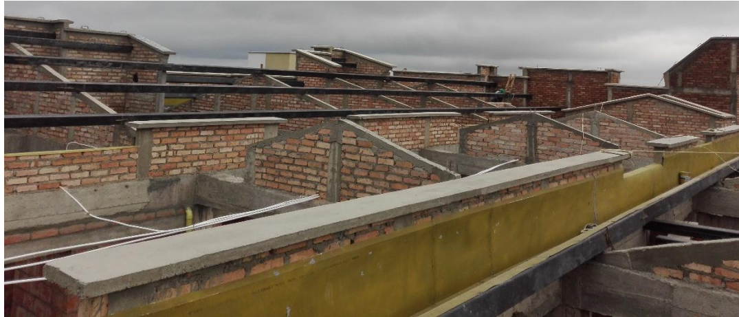
Figura 23. Canales de recolección de aguas lluvias.
