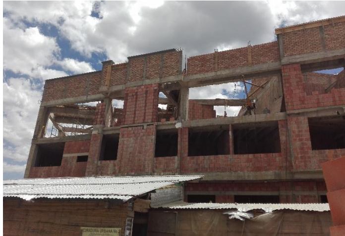
Figura 49. Fachada carrera 15 N días después del ingreso a la obra.
