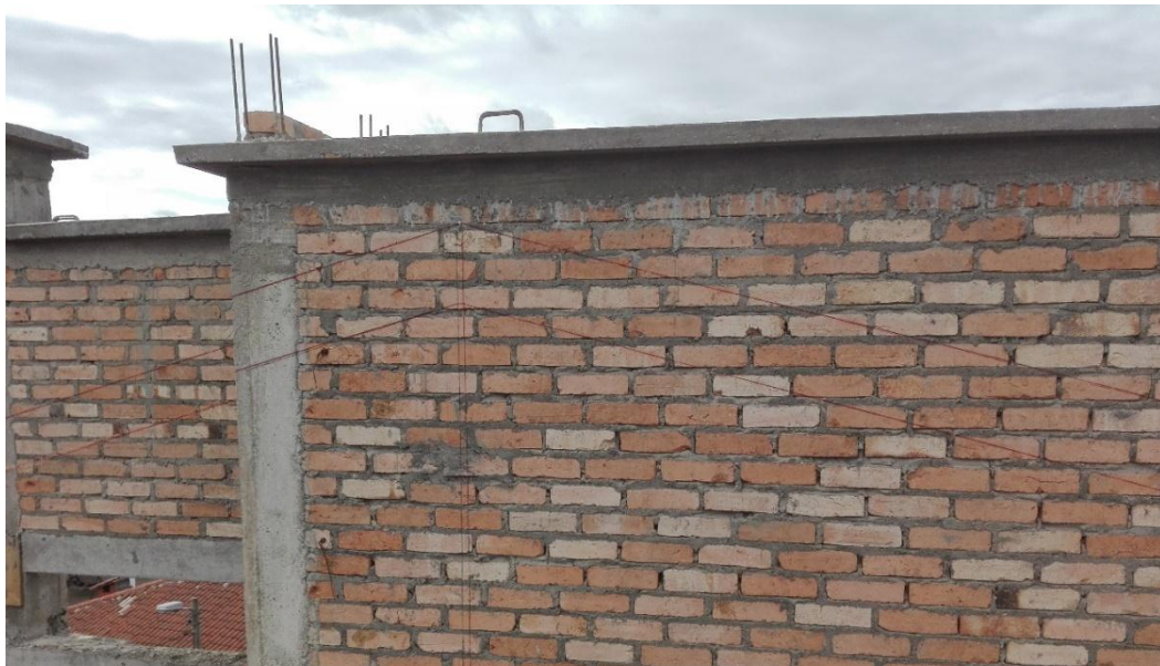
Figura 17. Cimbrado para colocación de correas. FUENTE. Propia.
