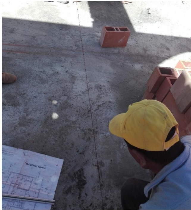
Figura 7. Proceso de cimbrado.
