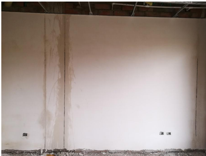
Figura 30. Terminado de muro en estuco. FUENTE. Propia.
