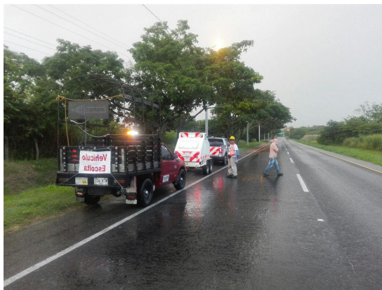
Fotografía 4 CONCESIÓN VARIANTE CHICORAL – IBAGUE – CAJAMARCA -Referencia de CYH INGENIERIA Y CONSTRUCCIÓN S.A.S
