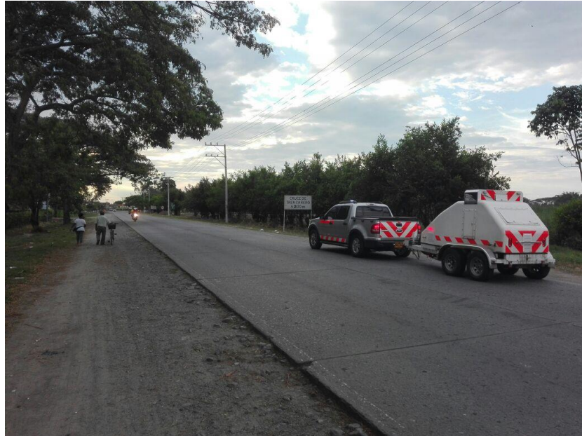
Fotografía 11 VIAS DE LA GOBERNACIÓN DEL VALLE -Referencia de CYH INGENIERIA Y CONSTRUCCIÓN S.A.S
