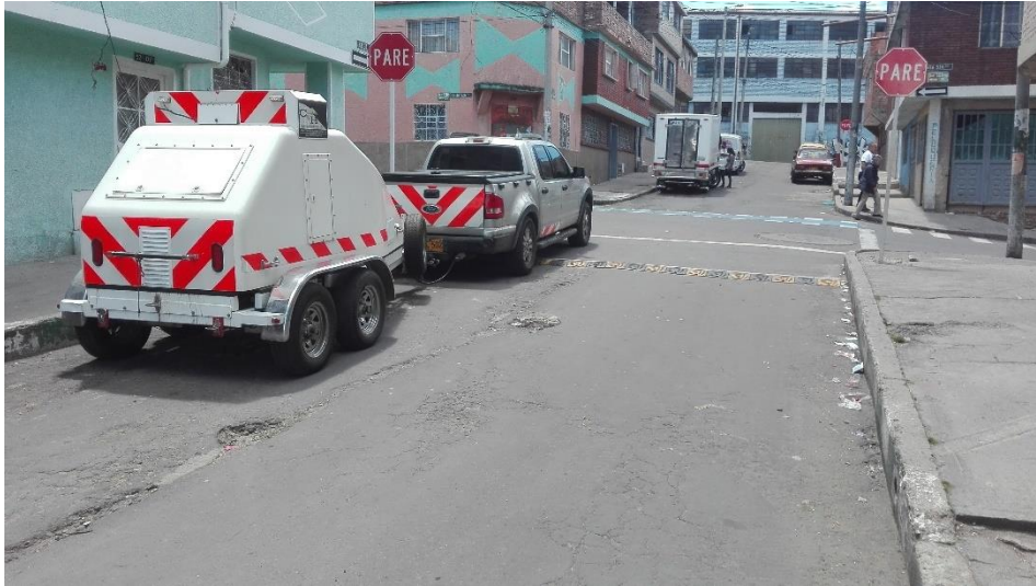
Fotografía 5 VÍAS DE TUNJUELITO -Referencia de CYH INGENIERIA Y CONSTRUCCIÓN S.A.S
