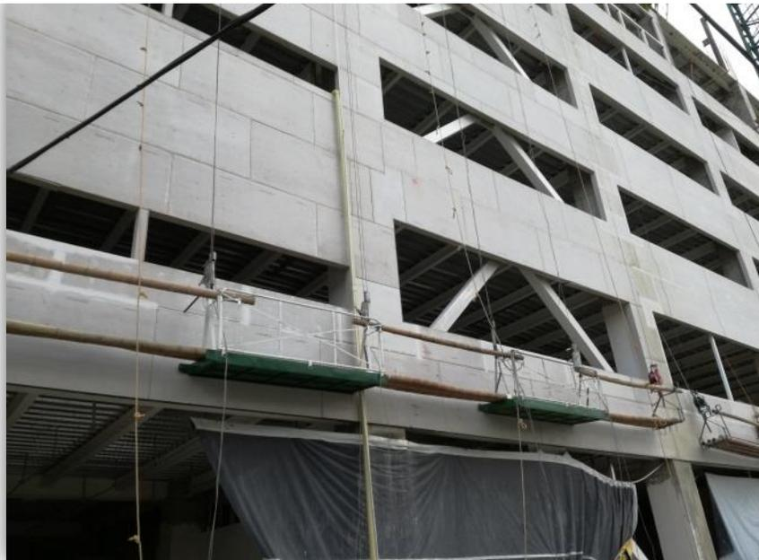
**Figura 12.** Estructura metálica con placas de Superboard Estándar (sistema confinado), Jul/07/2017.
