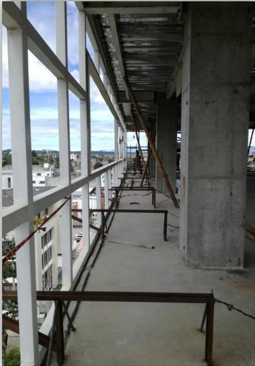
**Figura 6.** Estructura metálica con perfiles tubulares, Jul/03/2017.
