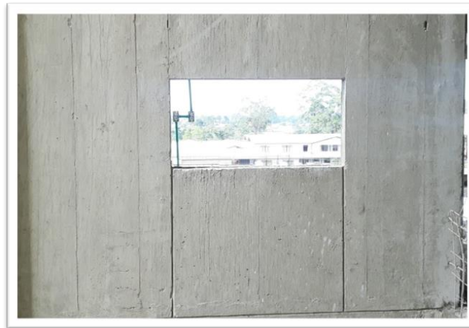
Figura 16. Inspección Visual Torre C- corrección de flejes con poco recubrimiento. Fuente: Propia (2017).
