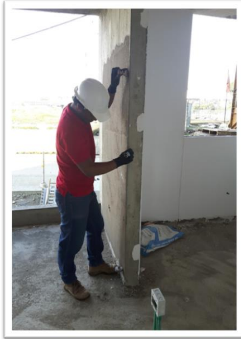
Figura 17. Revisión Técnica (codal) post-Fundición. Fuente: Propia (2017)
