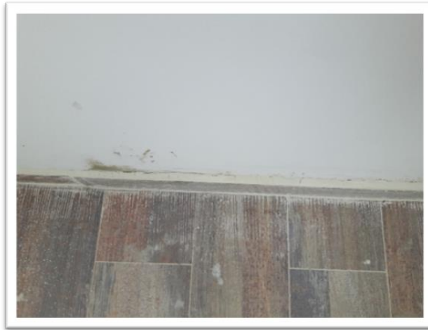
Figura 27. Fragua sin uniformidad y fisuras. Fuente: Propia (2017).
