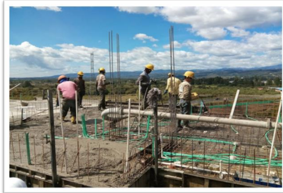
Figura 13. Fundición de Apartamento. Fuente: Propia (2017).
