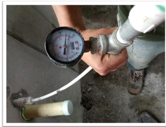
Figura 19. Prueba hidrostática. Fuente: Propia (2017)
