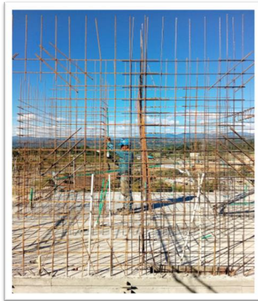
Figura 11. Revisión de Pre-fundición Torre C. Fuente: Propia (2017).
