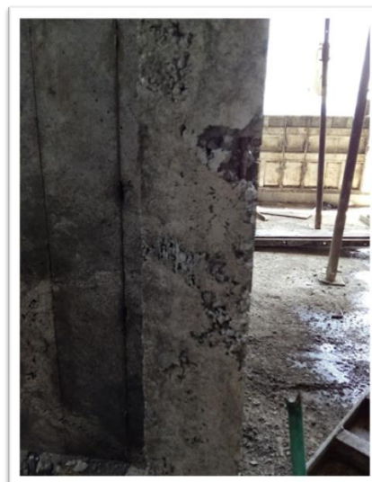
Figura 14. Inspección Visual Torre C- Hormigueros. Fuente: Propia (2017).
