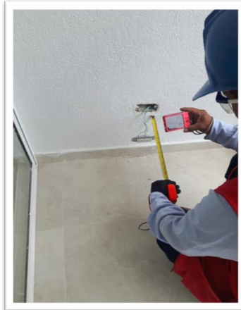
Figura 28. Medición de las acometidas Eléctricas (Longitud mínima). Fuente: Propia (2017).
