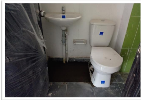
Figura 24. Enchape pisos (Corrección), Sanitario y lavamanos. Fuente: Propia (2017).
