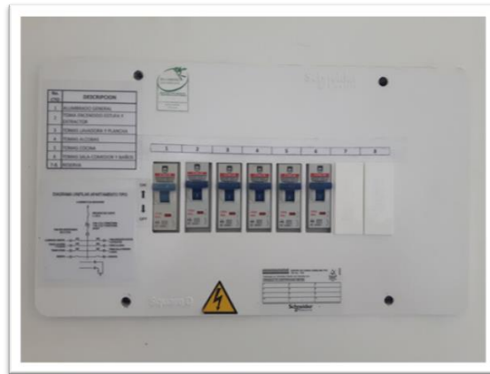
Figura 32. Cajas Eléctricas con Diagrama unifilar y Descripción de Breques. Fuente: Propia (2017).
