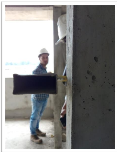
Figura 18. Revisión Técnica (Plomada) post-fundición. Fuente: Propia (2017).
