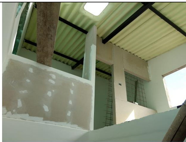
Imagen 68. Adición de un nuevo piso de 31.5 m 2 , fuente propia.
