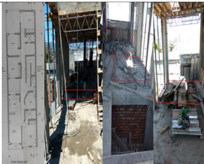
Imagen 40. Modificación de los vacíos en la losa del tercer piso, fuente propia.
