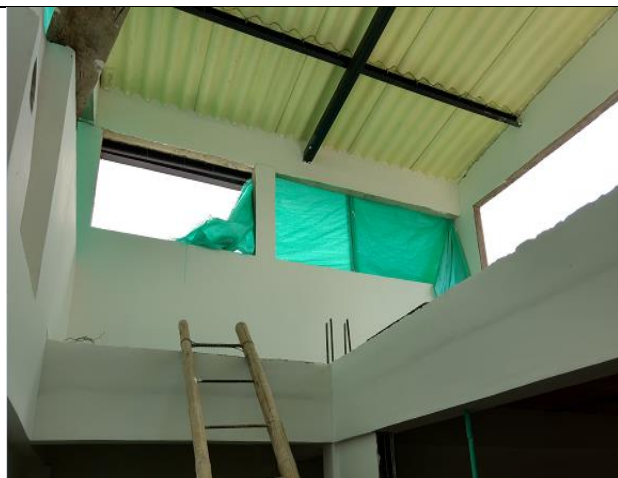
Imagen 67. Adición de un nuevo piso de 31.5 m 2 , fuente propia.
