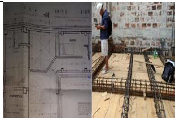
Imagen 30. Vacío no construido en obra, fuente propia.
