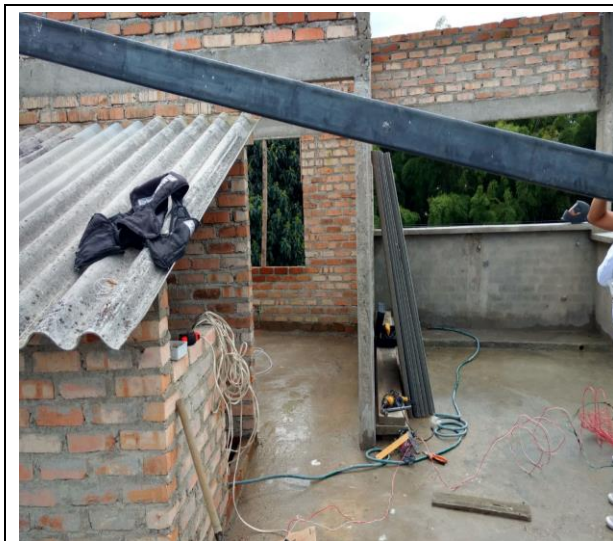
Imagen 57. Losa de entrepiso adicional, fuente propia.
