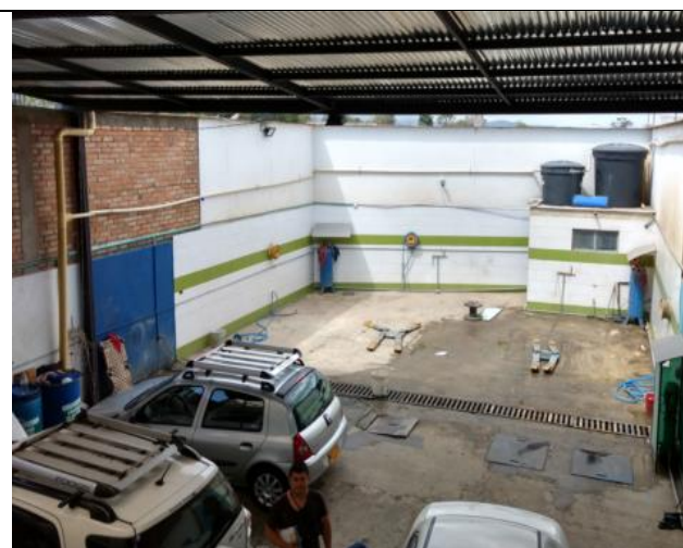
Imagen 23. Área de lavadero de carros, fuente propia.
