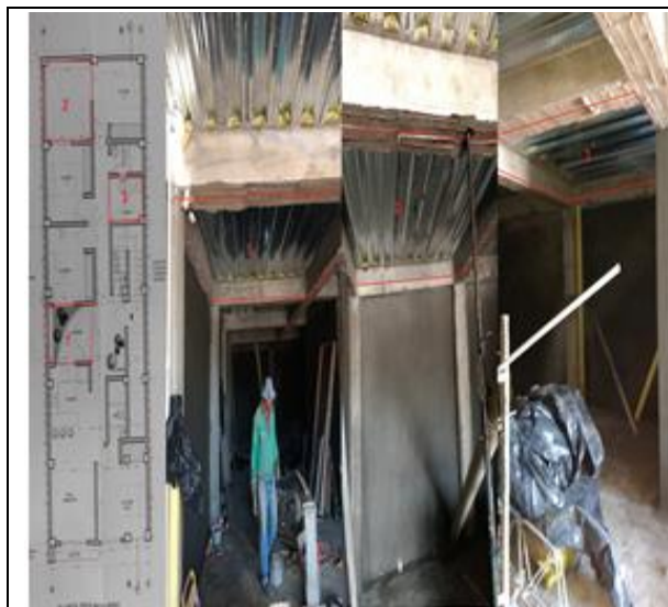
Imagen 39. Modificación de los vacíos en la losa del segundo piso, fuente propia.
