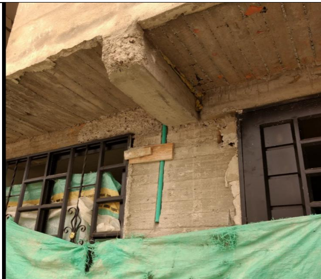
Imagen 58. Muro estructural en primer piso únicamente, fuente propia.
