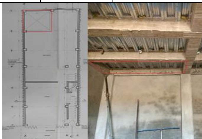
Imagen 38. Faltante del vacío de ventilación, fuente propia.
