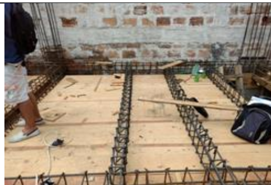
Imagen 32. Área del vacío modificado en obra, fuente propia.
