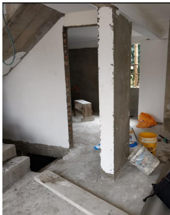
Imagen 56. Muro estructural presente en primer y segundo piso, en lugar de columnas, fuente propia.
