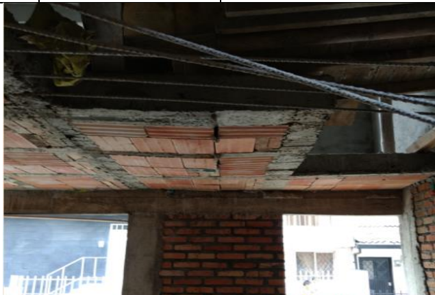
Imagen 34. Losa de entepiso con problemas de flexión, fuente propia.
