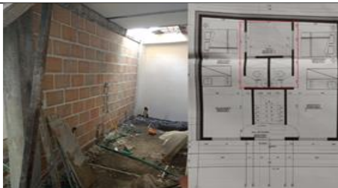
Imagen 46. Modificación en la vacío de ventilación, fuente propia.
