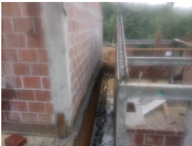
Fig 22: Avance en muro de contención en concreto ciclópeo
