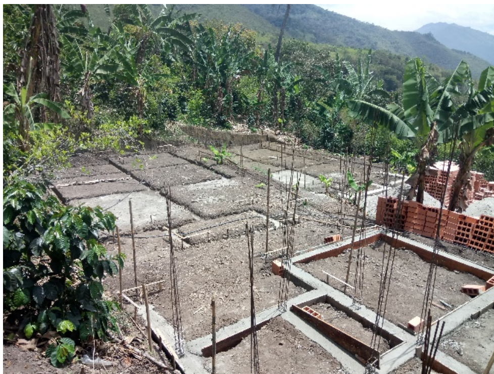
Fig 14: Armado y colocación de castillos de acero (columnas)
