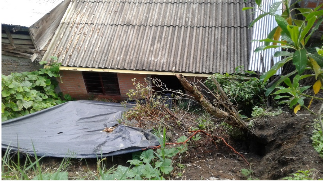
Fig 31: Movimiento de tierra a causa de ola invernal
