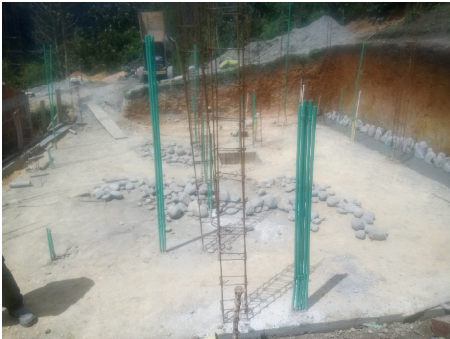
Fig 25: Instalación de redes
