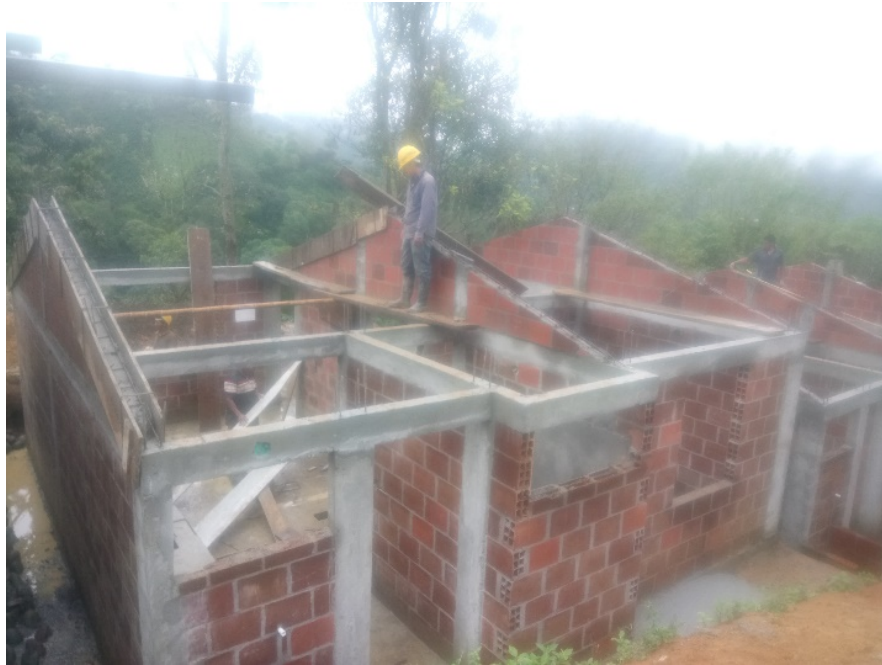
Fig 26: Construcción de culatas
