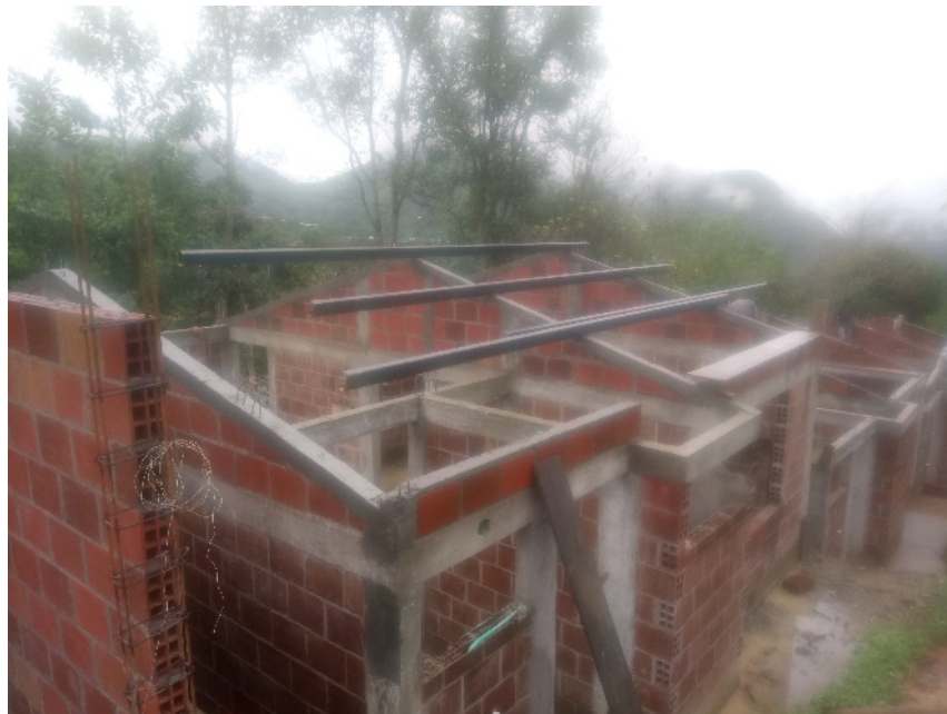
Fig 27: Instalación de correas metálicas
