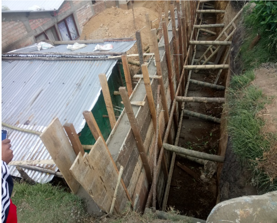
Fig 4: Construcción obras de mitigación
