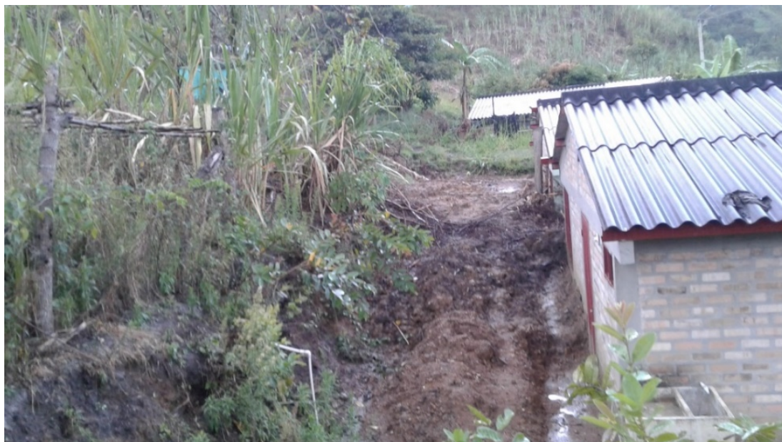
Fig 30: movimiento de tierra a causa de ola invernal
