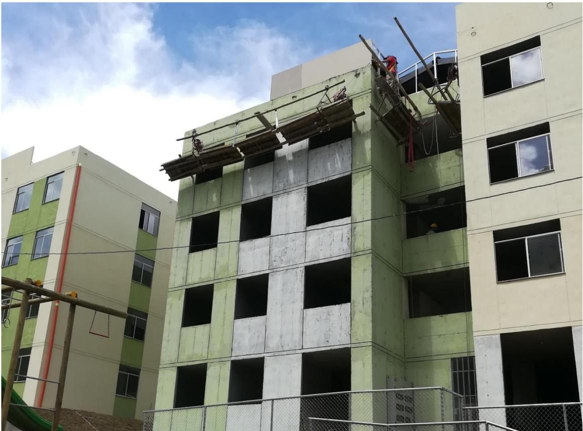
Figura No.26 Aplicación de base para graniplast (Fuente: Propia)
