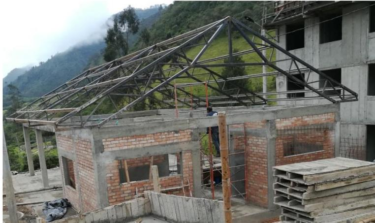
Figura No.35 Estructura de Cubierta de Salón Comunal (Fuente: Propia)
