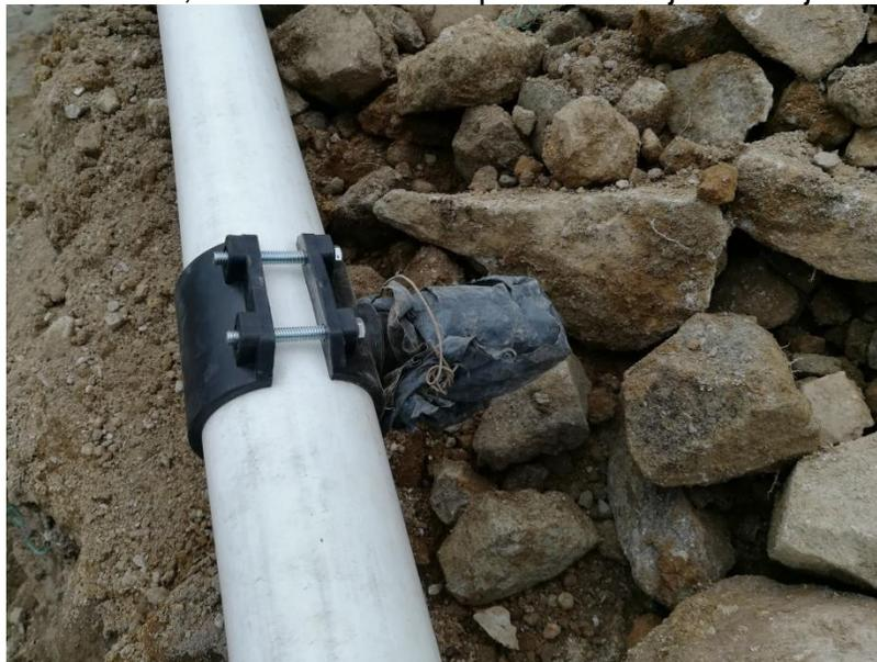
Figura No.19 Instalación de Collarín de 3"x1" (Fuente: Propia)
