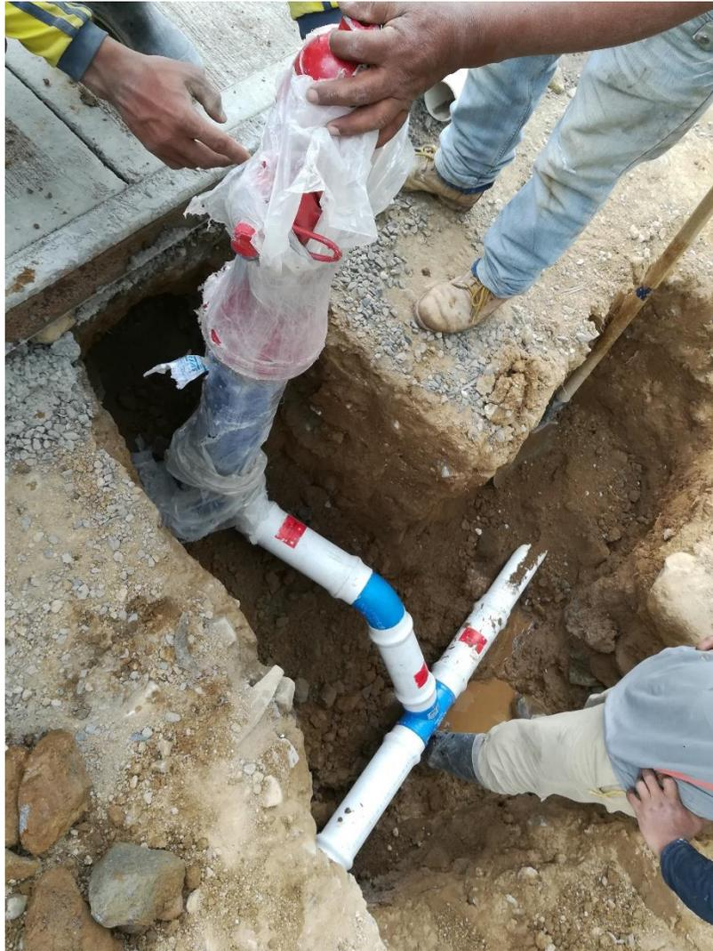
Figura No.31 Instalación tubería e Hidrante (Fuente: Propia)
