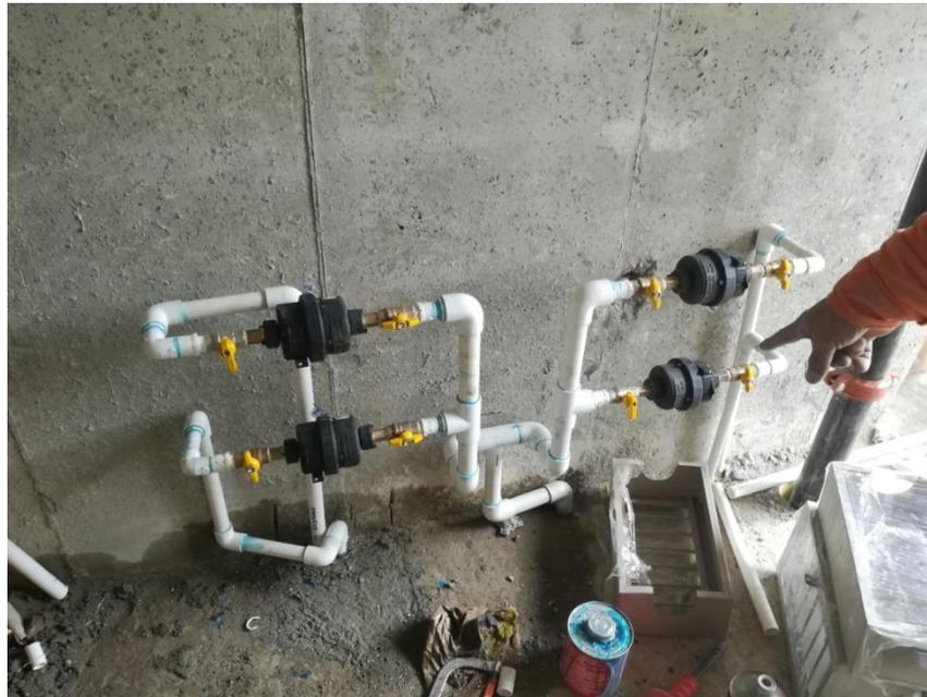
Figura No.20 Instalación de Medidores de Agua (Fuente: Propia)
