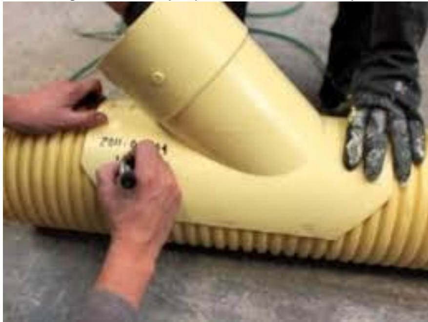
Figura No. 17. Ejemplo instalación de silla yee.
