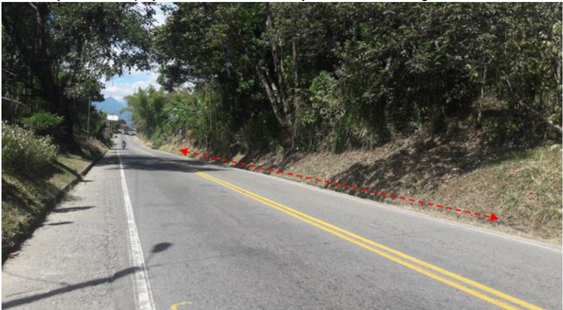
Fotografía No.10. Instalación de tubería sanitaria PVC de 8" paralela a la vía Mojarras – Popayán entre PR73+350 y PR73+650 margen derecha
