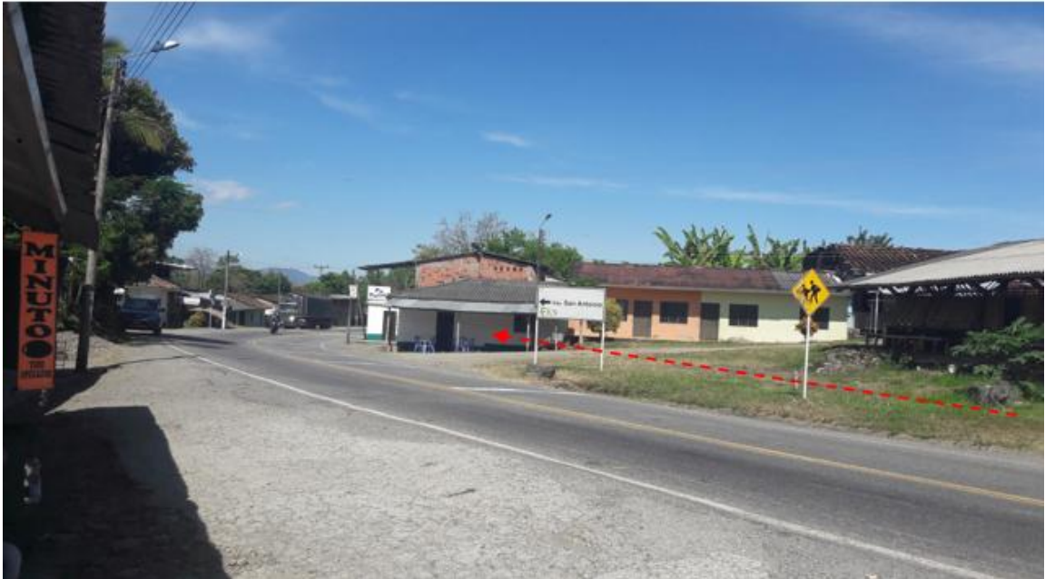
Fotografía No.8. Instalación de tubería sanitaria PVC de 8" paralela a la vía Mojarras – Popayán entre PR73+200 y PR73+250
