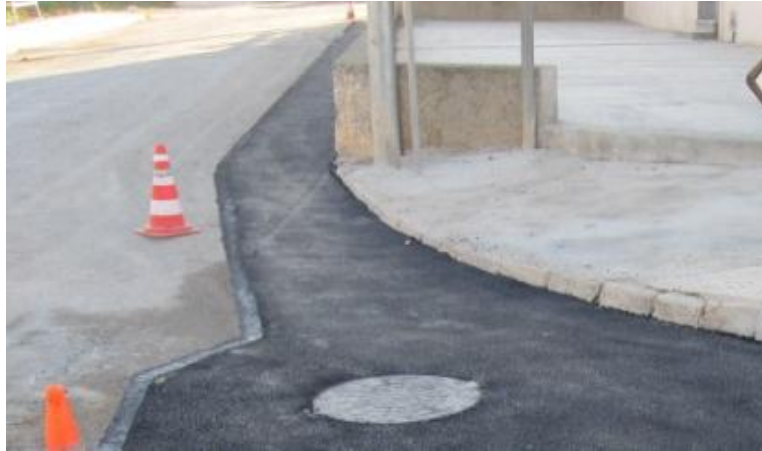
Figura No. 16. Ejemplo reposición de pavimento flexible.
