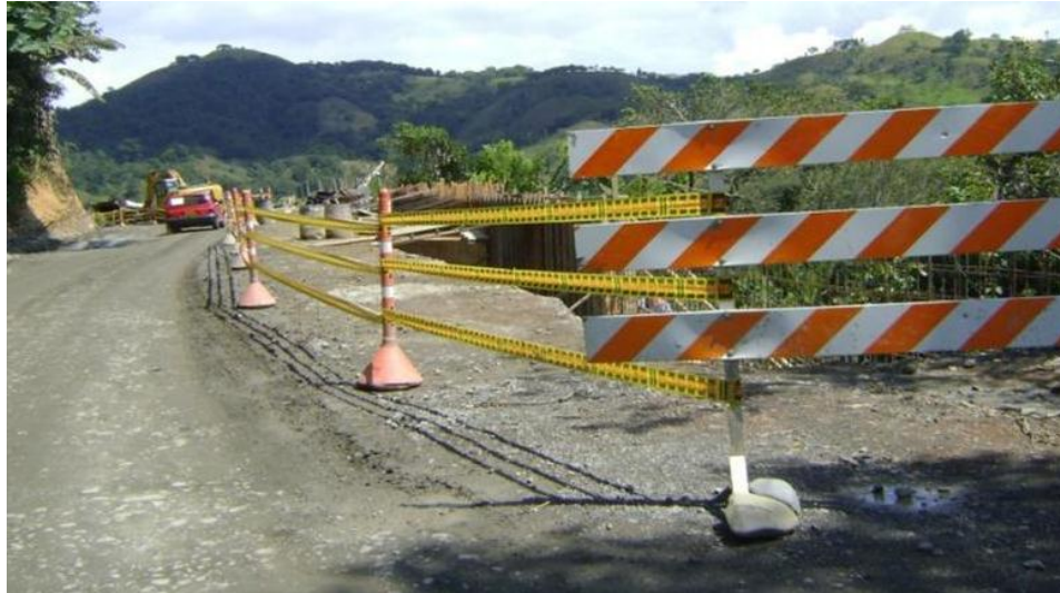
Figura No.7. Ejemplo de señalización en la vía para excavación de zanjas
