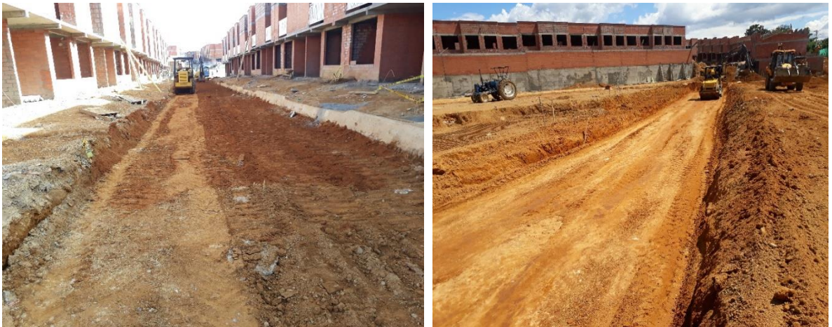
Figura 31. Compactación de la subrasante.
