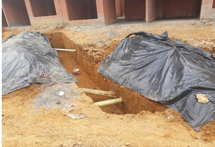
Figura 57. Material de relleno cubierto con plástico.
