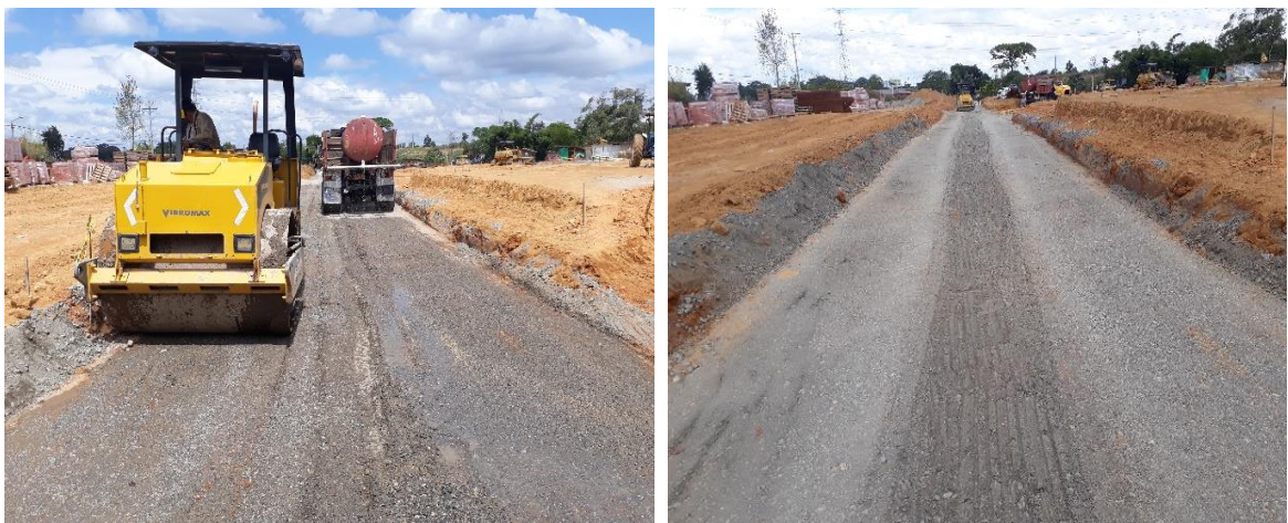
Figura 33. Compactación de la sub-base.
