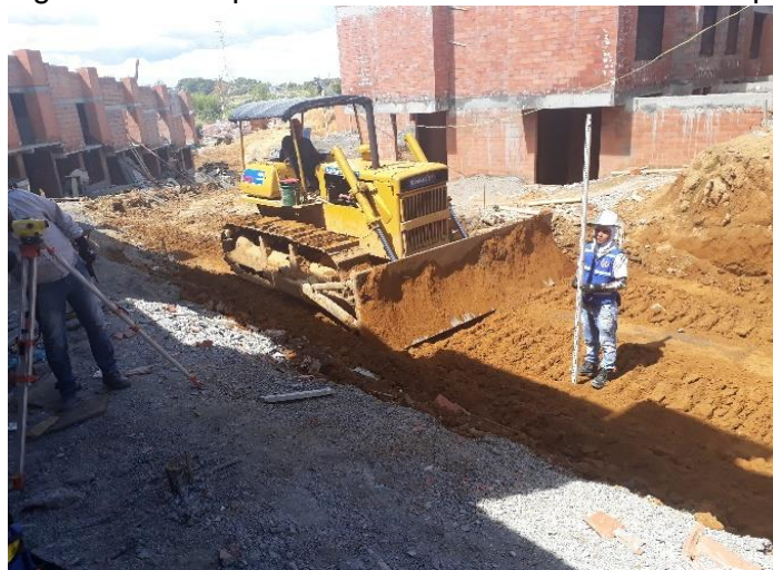
Figura 29. Chequeo del corte de la vía con nivel de precisión.
