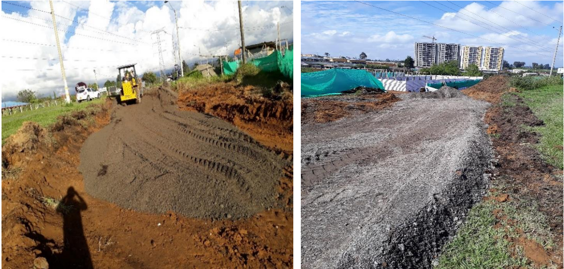
Figura 18. Extendido y compactado de sub-base.
