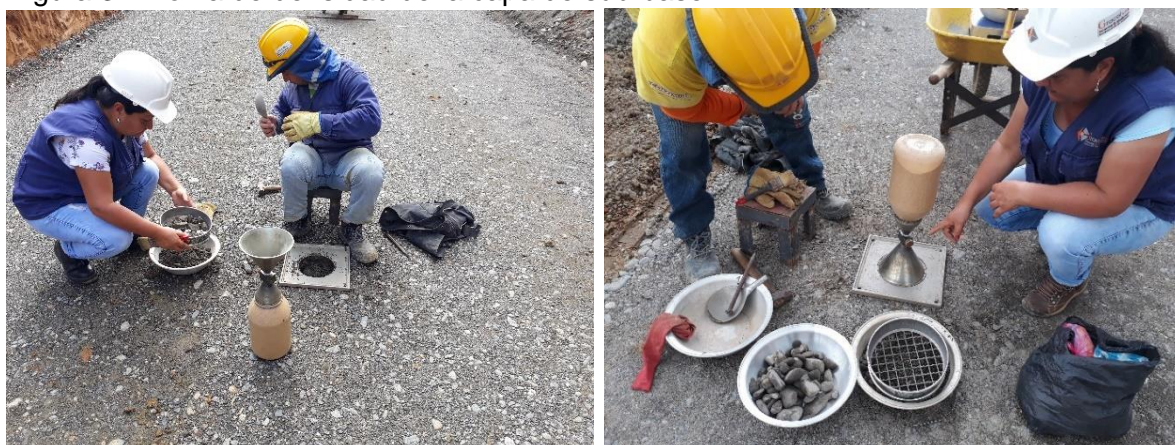
Figura 34. Toma de densidad de la capa de sub-base.
