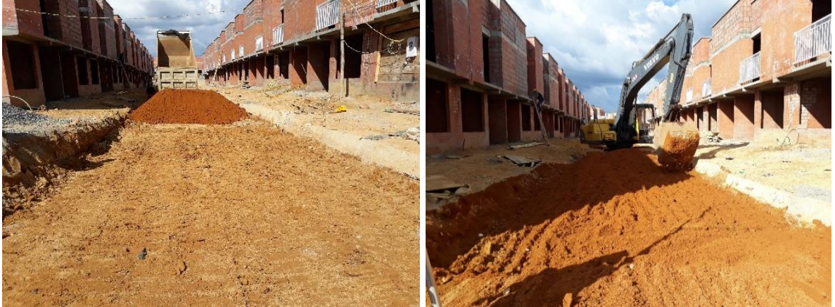
Figura 30. Extendido de material de relleno.
