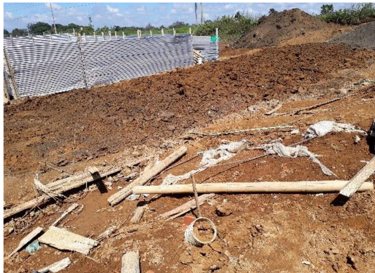
Figura 17. Escarificado de la subrasante.
