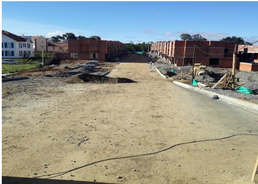
Figura 4. Estado de vía manzana F.
