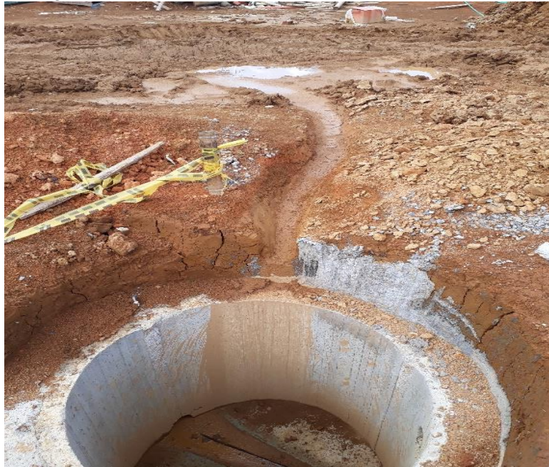
Figura 13. Canales manuales.
