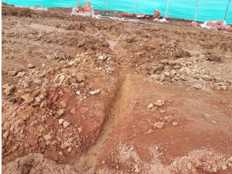
Figura 12. Canales manuales.
