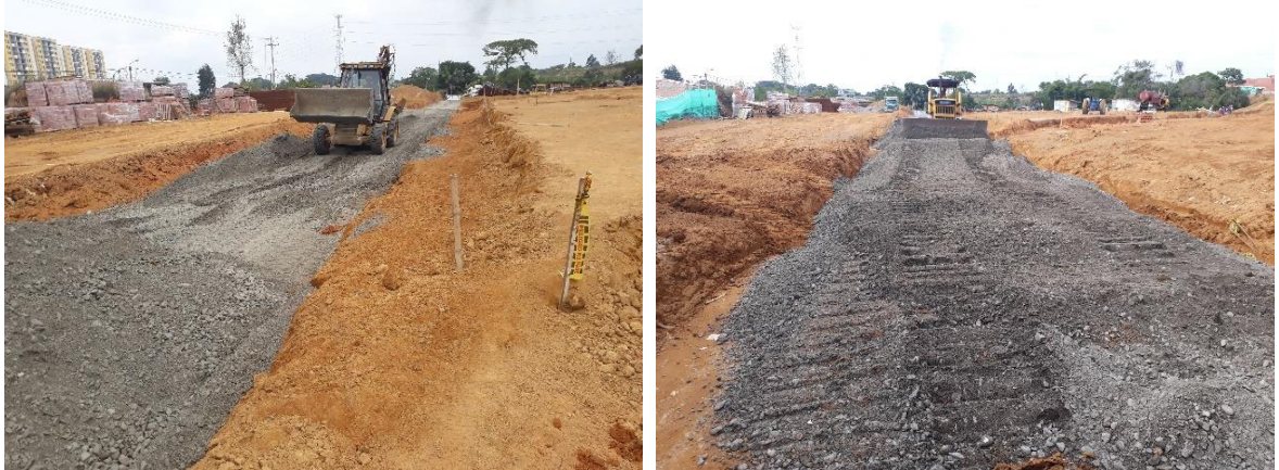
Figura 32. Extendido de sub-base
