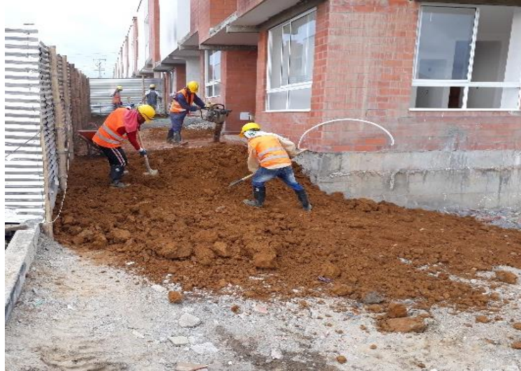
Figura 44. Conformación y compactación del terreno.
