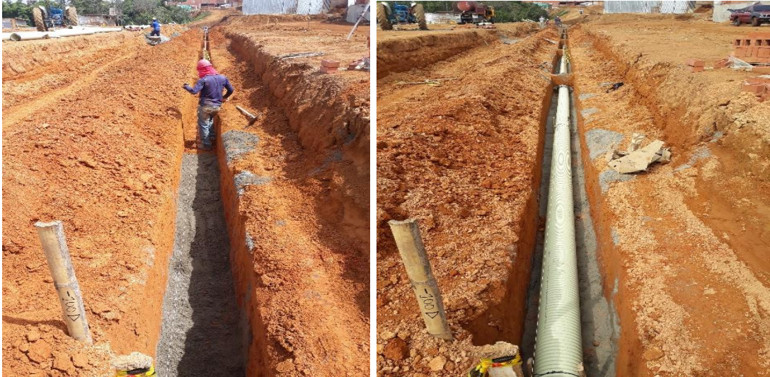
Figura 55. Encamado de tubería.
