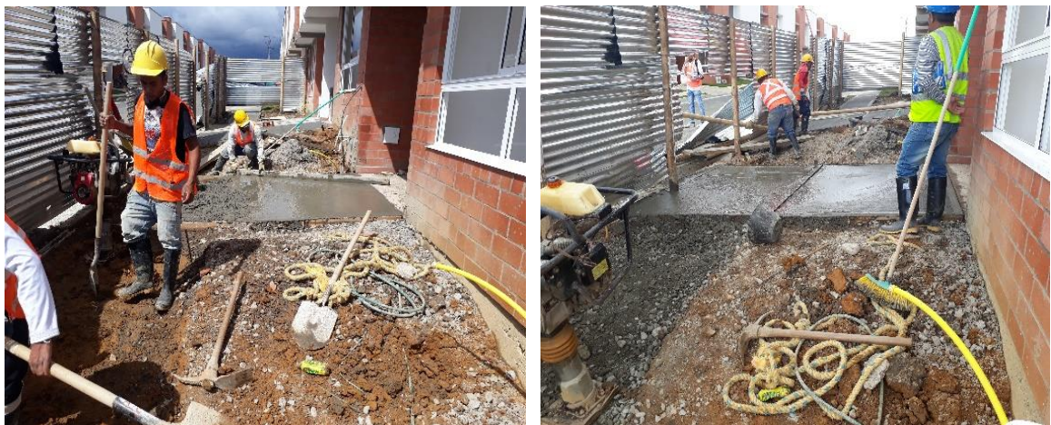
Figura 47. Colocación del concreto.
