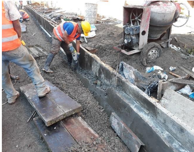
Figura 51. Fundición incompleta.
