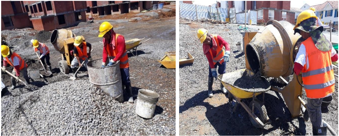
Figura 46. Preparación del concreto.
