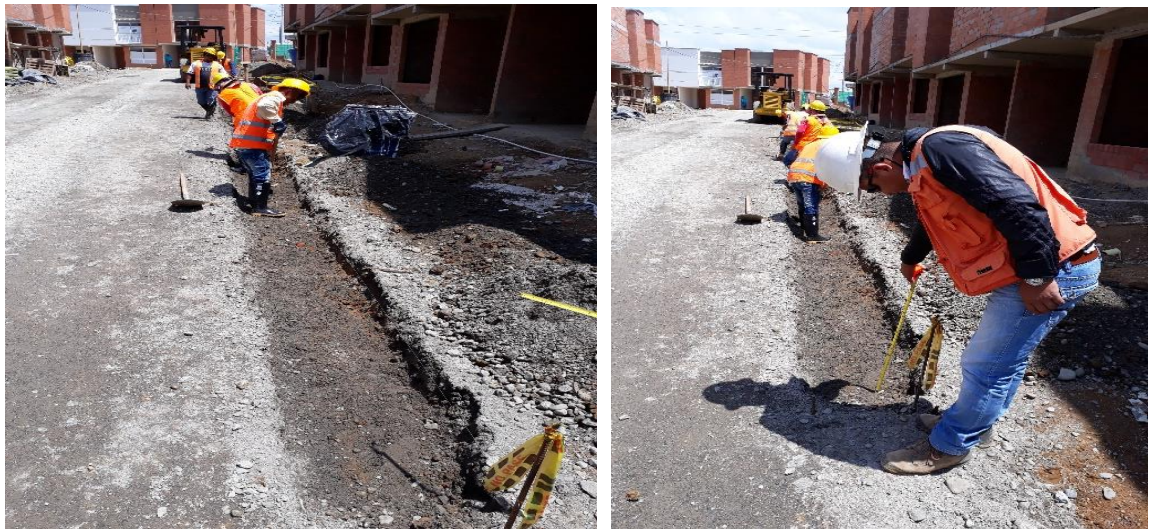
Figura 48. Excavación para construcción de sardineles.
