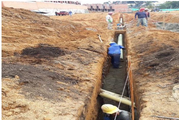
Figura 56. Extendido de tubería.
