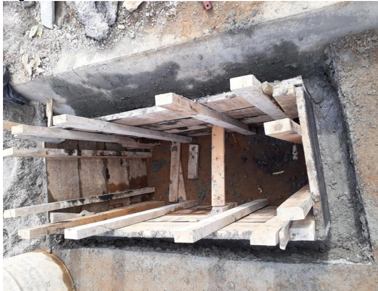
Figura 11. Construcción de sumideros
