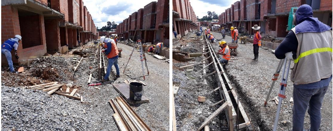
Figura 49. Instalación y chequeo de formaleta.
