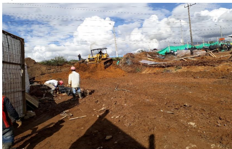
Figura 15. Corte de subrasante.
