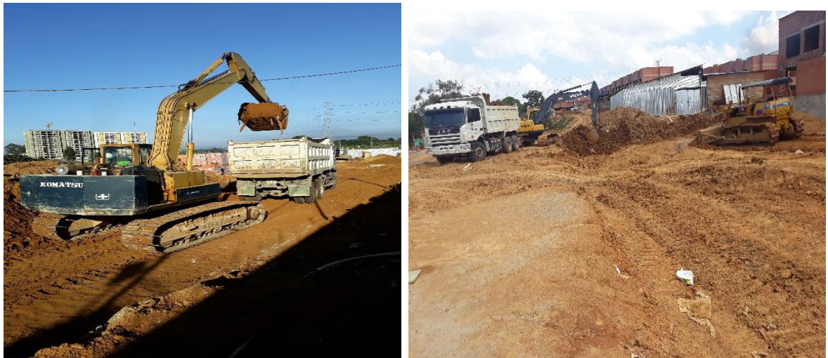
Figura 26. Cargue de material
