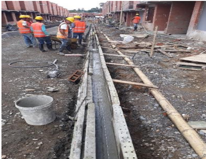
Figura 5024. Fundición del sardinel.
