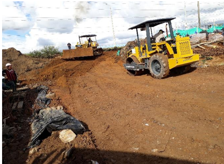
Figura 16. Compactación de la subrasante.
