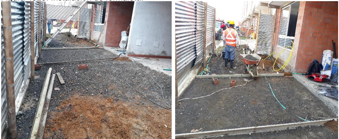
Figura 45. Instalación de formaleta.
