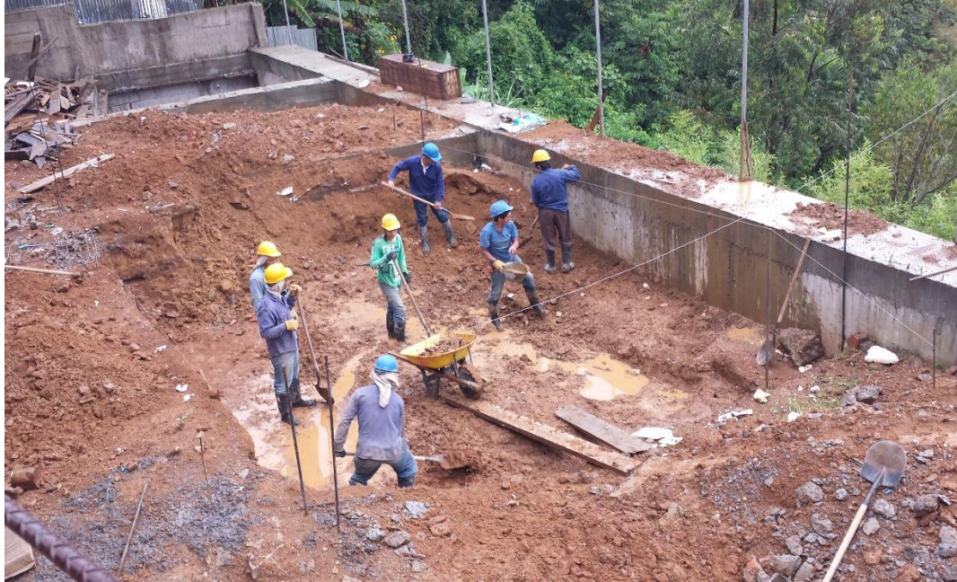
Fotografía 78. Excavación de la piscina. Fuente: Tomada por el pasante
