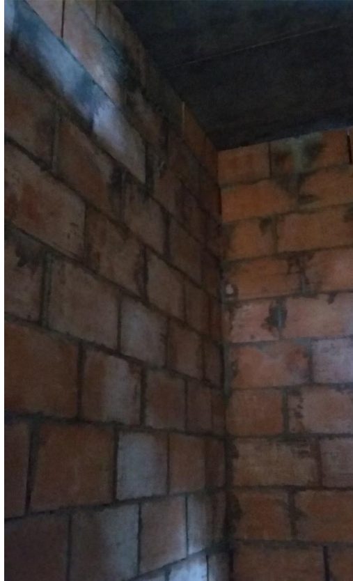
Fotografía 38. Construcción de muros en 5to piso. Fuente: Tomada por el pasante
