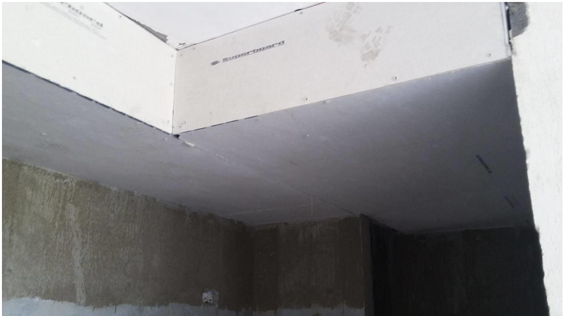
Fotografía 72. Superboard instalado sobre la cocina. Fuente: Tomada por el pasante
