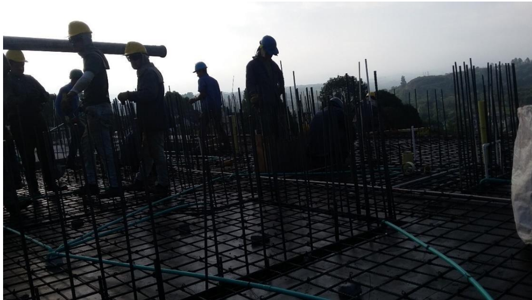
Fotografía 29. Instalación de la tubería para el vaciado del concreto. Fuente: Tomada por el pasante
