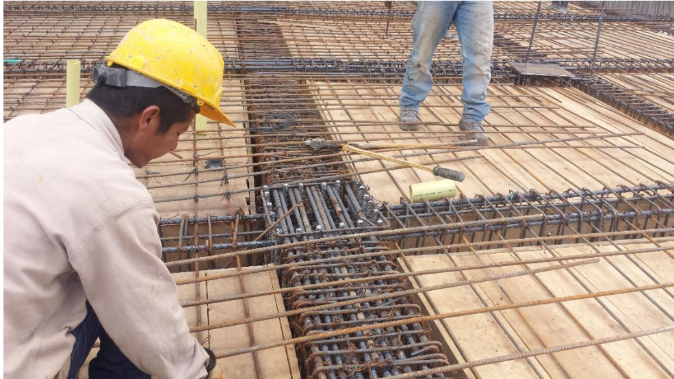
Fotografía 59. Armado refuerzo de la losa maciza. Fuente: Tomada por el pasante
