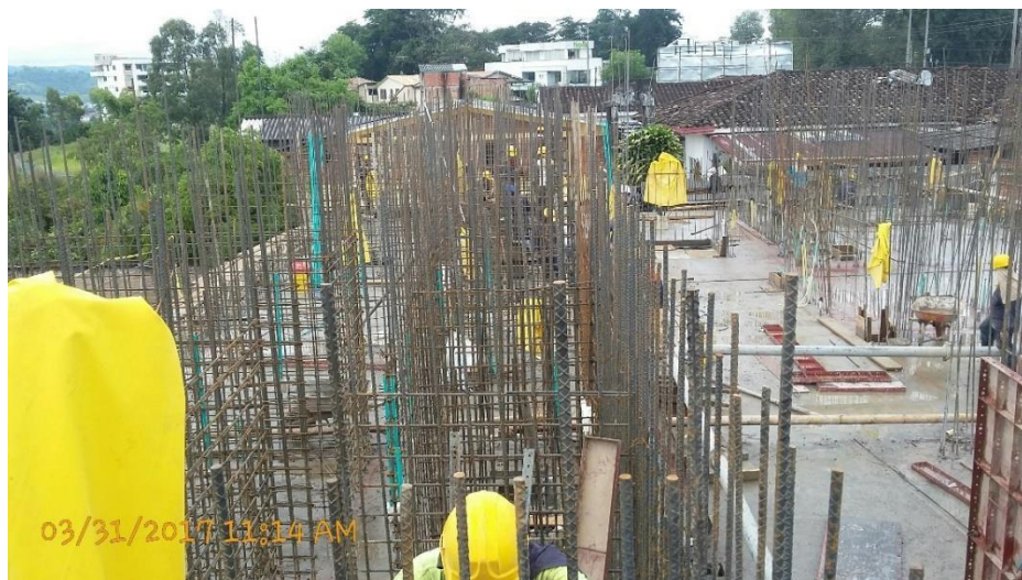
Fotografía 9. Armado del acero del octavo piso. Fuente: Tomada por el pasante
