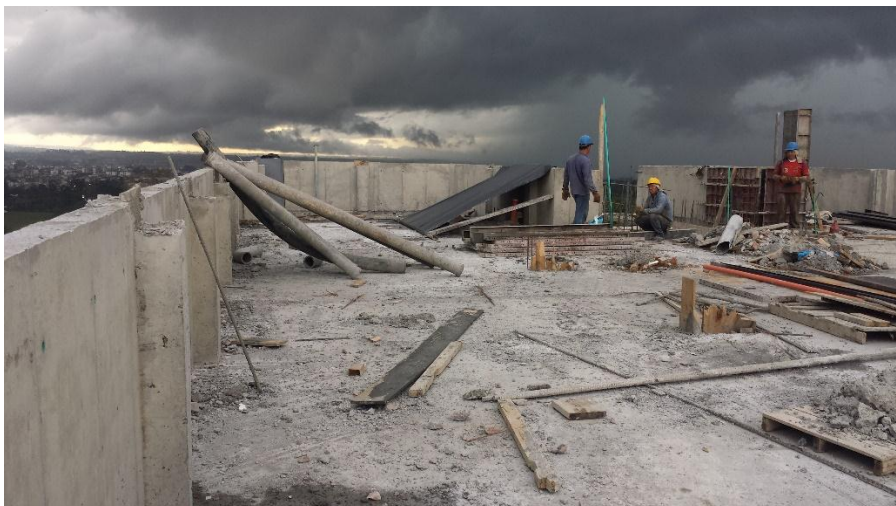
Fotografía 37. Fundición del antepecho de la terraza. Fuente: Tomada por el pasante
