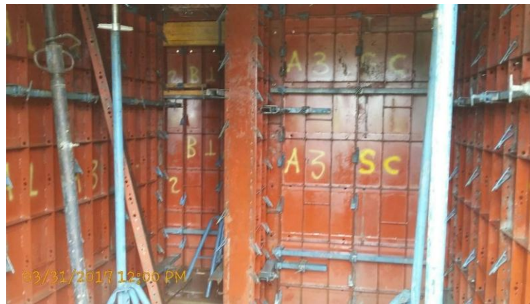
Fotografía 13. Armado completo de alcoba del apartamento. Fuente: Tomada por el pasante
