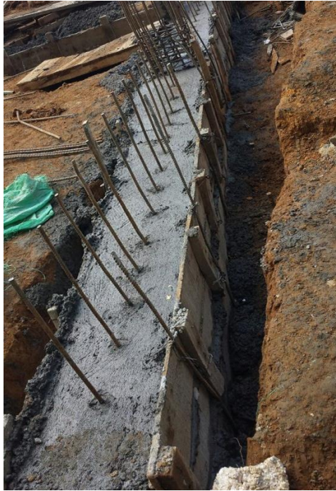
Fotografía 50. Fundición viga de amarre. Fuente: Tomada por el pasante
