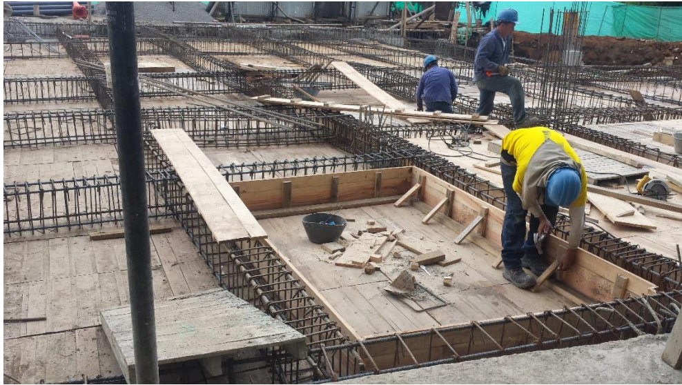
Fotografía 57. Obrero formaleteando vigas. Fuente: Tomada por el pasante
