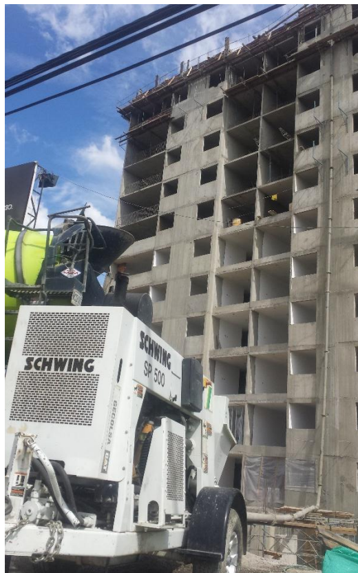
Fotografía 35. Máquina bombeando concreto al piso 11. Fuente: Tomada por el pasante
