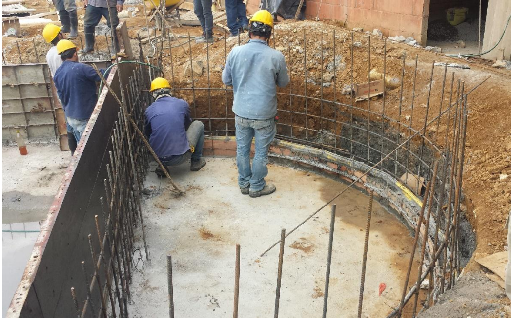
Fotografía 79. Armado de acero de la piscina. Fuente: Tomada por el pasante
