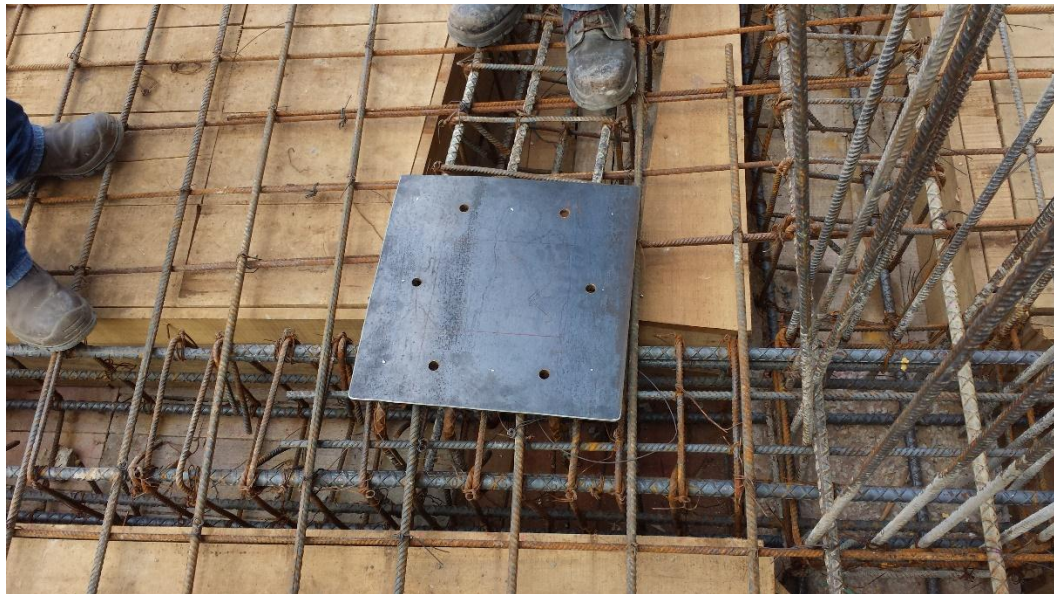
Fotografía 60. Platina de acero para apoyo de columna metálica. Fuente: Tomada por el pasante
