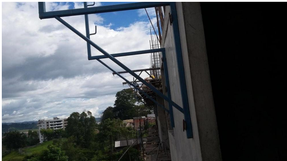
Fotografía 23. Vista de palomeras amarradas al apto del piso inferior. Fuente: Tomada por el pasante
