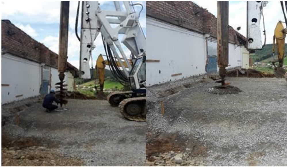
Fotografía 2. Máquina piloteadora empieza a perforar. Fuente: Tomada por el ingeniero residente
