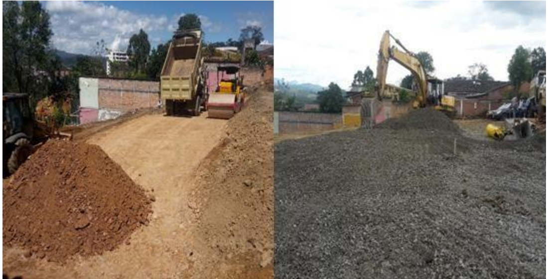
Fotografía 4. Se procede a la compactación de material. Fuente: Tomada por el ingeniero residente
