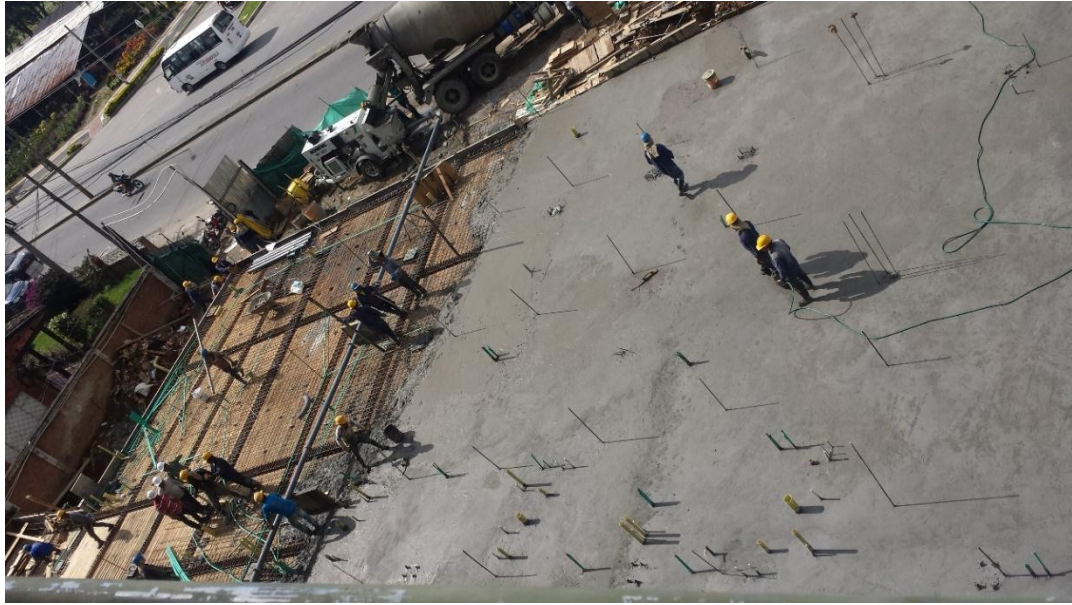
Fotografía 64. Fundición de la losa maciza en un 60% completado. Fuente: Tomada por el pasante
