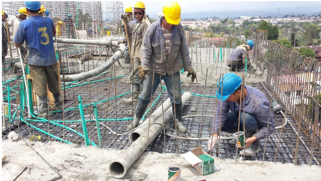
Fotografía 19. Aplicación de Sikadur-32 Primer y vaciado del concreto de la losa. Fuente: Tomada por el pasante
