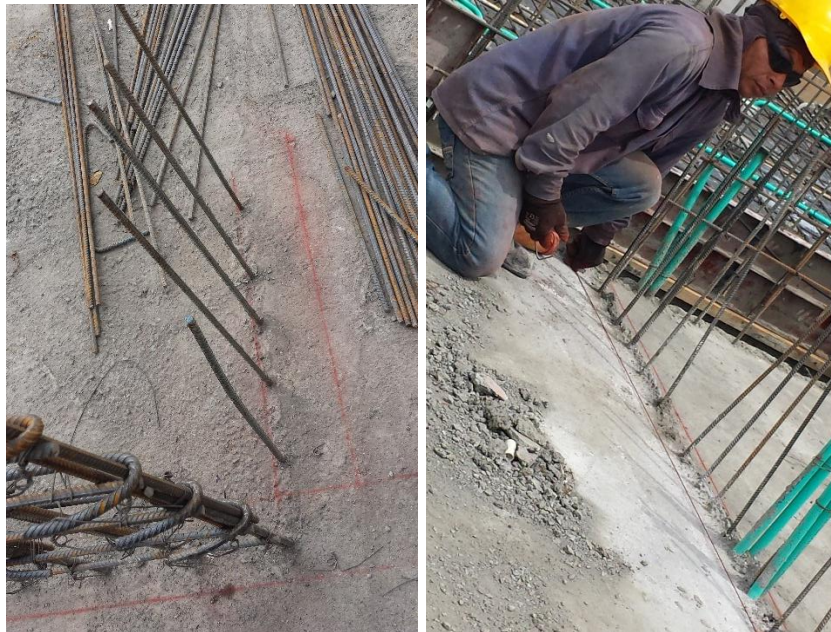
Fotografía 8. Demarcación de muros sobre la losa. Fuente: Tomada por el pasante
