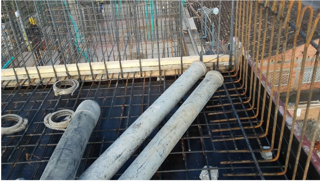
Fotografía 28. Tubería para el vaciado del concreto. Fuente: Tomada por el pasante
