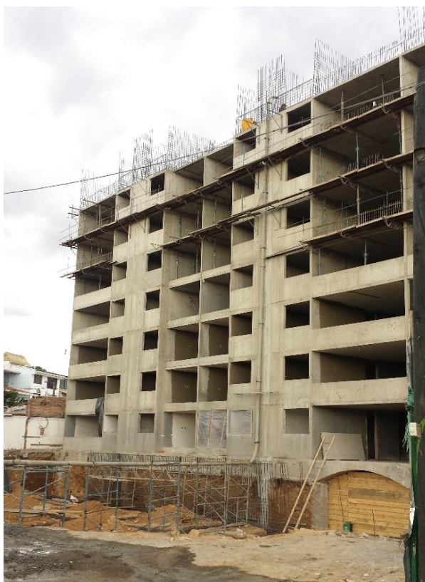
Fotografía 7. Vista frontal hasta el 7mo piso fundido. Fuente: Tomada por el pasante
