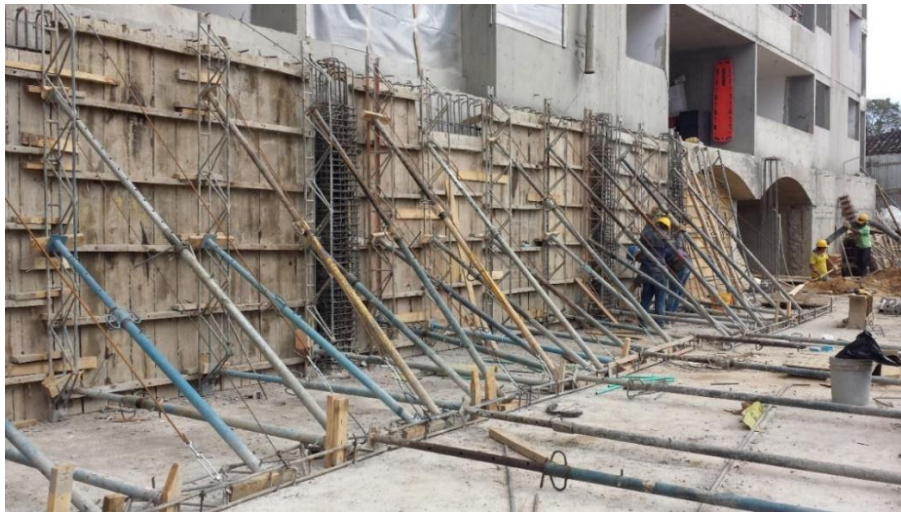
Fotografía 53. Formaleteado de muro de contención, locales comerciales. Fuente: Tomada por el pasante
