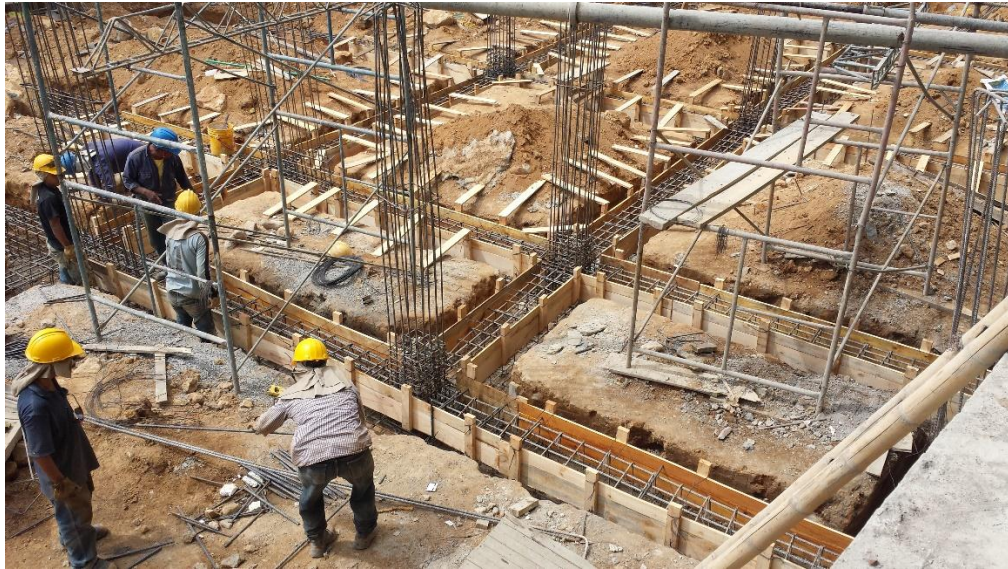
Fotografía 44. Formaleteado de vigas T de amarre. Fuente: Tomada por el pasante
