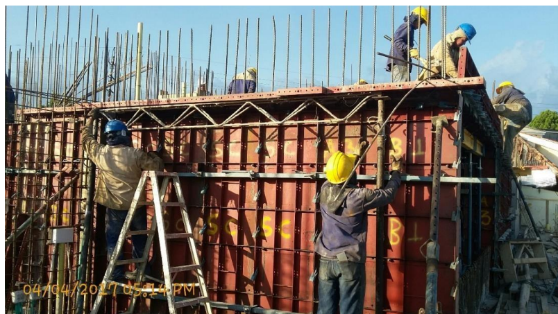
Fotografía 14. Vista posterior del Armado de la formaleta. Fuente: Tomada por el pasante
