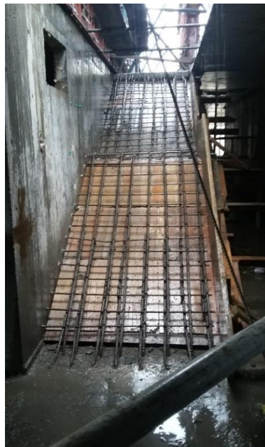
Fotografía 25. Refuerzo de las escaleras. Fuente: Tomada por el pasante
