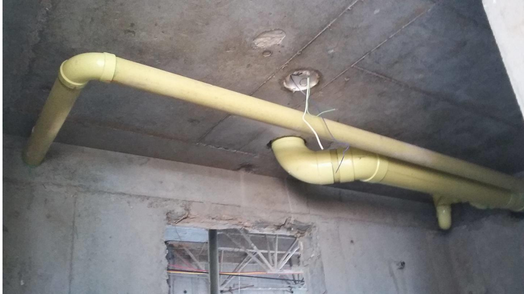
Fotografía 70, Instalaciones hidráulicas en los baños del apto. Fuente: Tomada por el pasante
