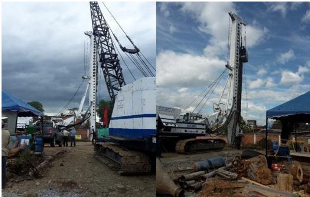
Fotografía 1. Máquina piloteadora en obra. Fuente: Tomada por el ingeniero residente
