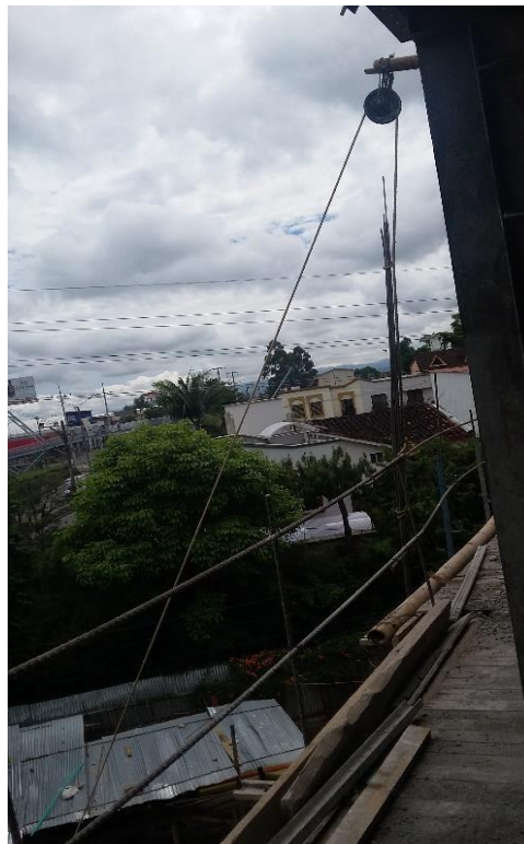
Fotografía 33. Polea utilizada para subir el refuerzo hasta la losa de 9no piso. Fuente: Tomada por el pasante
