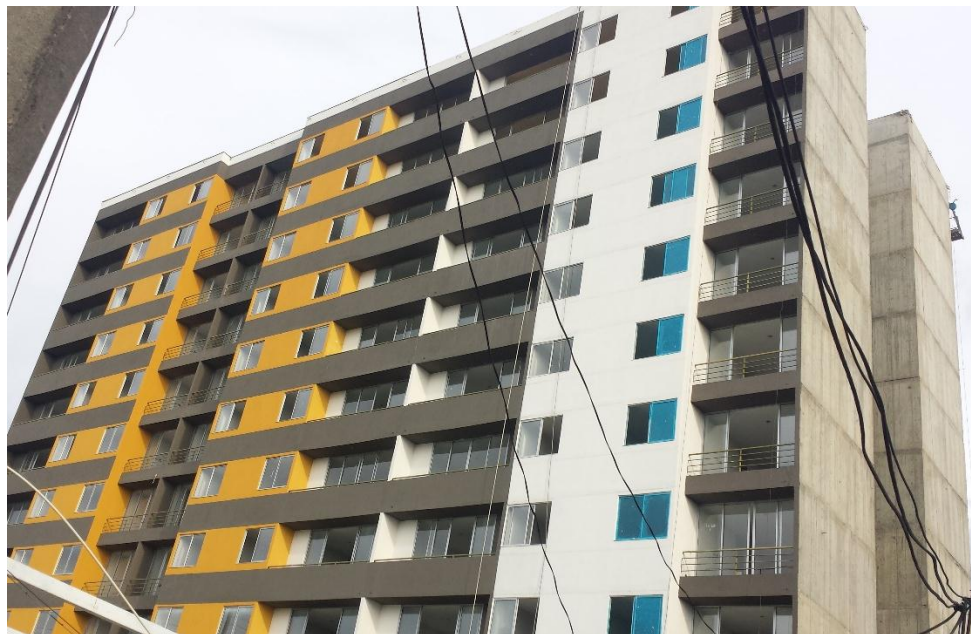
Fotografía 75. Aplicación de graniplast sobre fachada principal. Fuente: Tomada por el pasante
