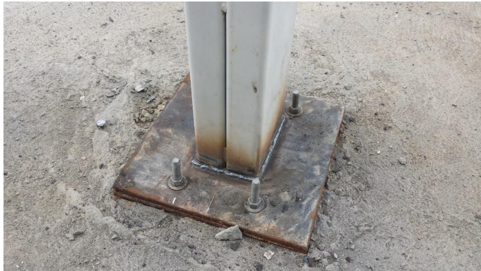
Fotografía 67. Columna metálica anclada a la losa. Fuente: Tomada por el pasante
