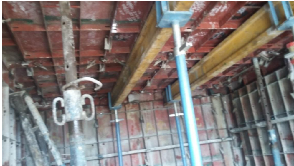
Fotografía 32. Vista inferior de formaleta de losa. Fuente: Tomada por el pasante
