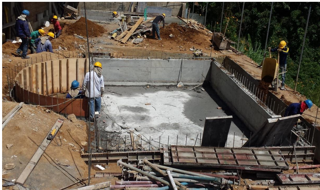
Fotografía 82. Piscina fundida. Fuente: Tomada por el pasante
