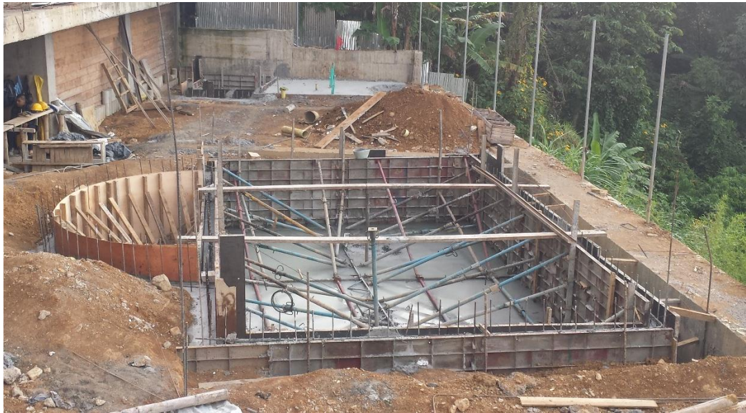
Fotografía 81. Soporte de la formaleta de la piscina. Fuente: Tomada por el pasante
