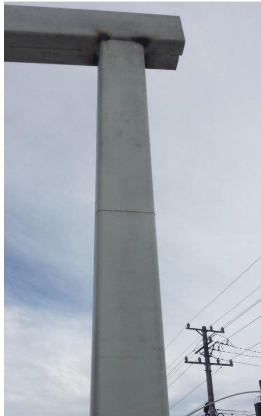
Fotografía 69. Unión con soldadura entre columna y viga metálica. Fuente: Tomada por el pasante
