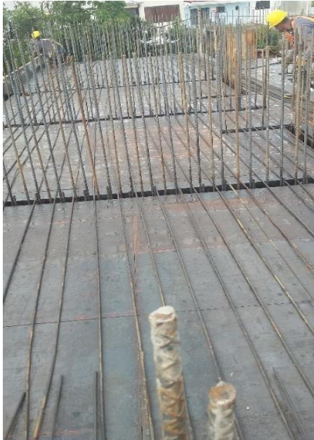
Fotografía 20. Formaleta lista para extender el refuerzo del apto 2. Fuente: Tomada por el pasante
