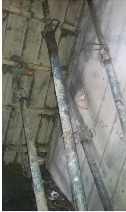
Fotografía 26. Vista inferior de la formaleta de escaleras. Fuente: Tomada por el pasante
