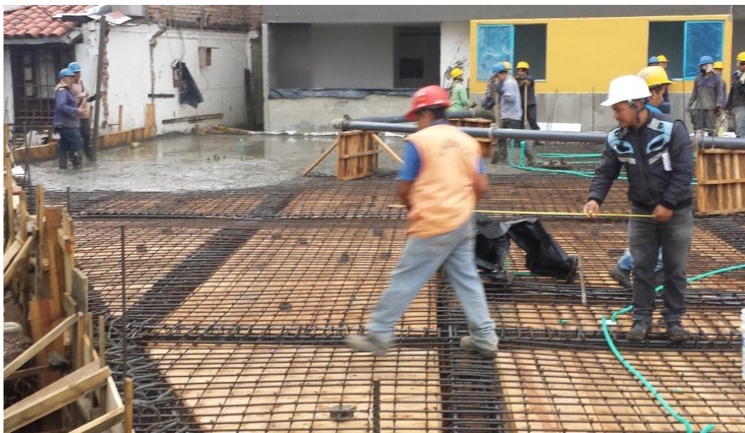
Fotografía 63. Inicio de fundición de la losa maciza con concreto bombeado. Fuente: Tomada por el pasante
