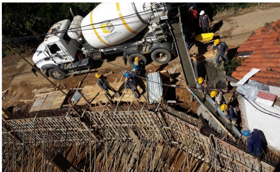
Fotografía 54. Vaciado del concreto en muro de contención lateral. Fuente: Tomada por el pasante
