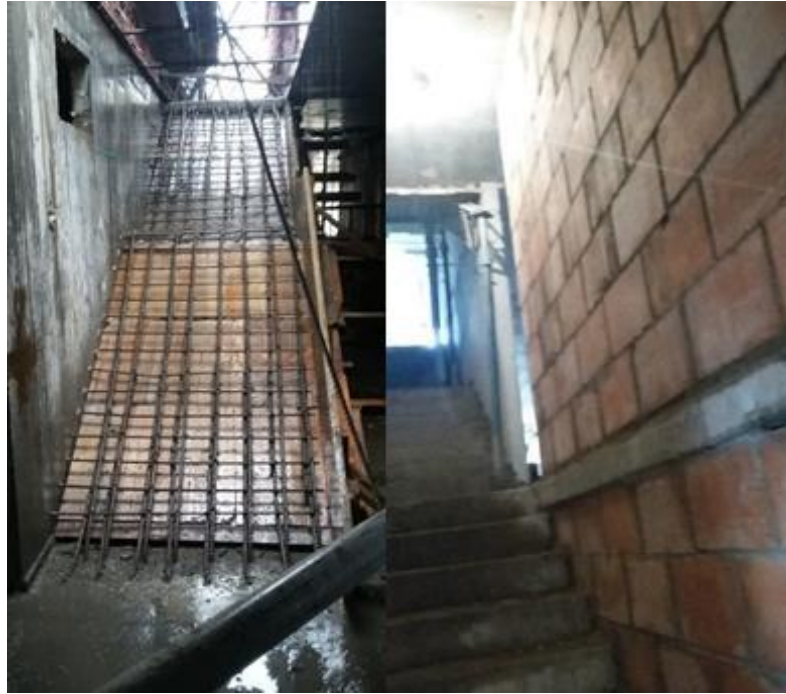
Fotografía 39. Escaleras fundidas y muros en mampostería. Fuente: Tomada por el pasante
