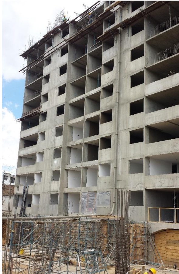
Fotografía 30. Vista frontal de ocho pisos fundidos en su totalidad. Fuente: Tomada por el pasante
