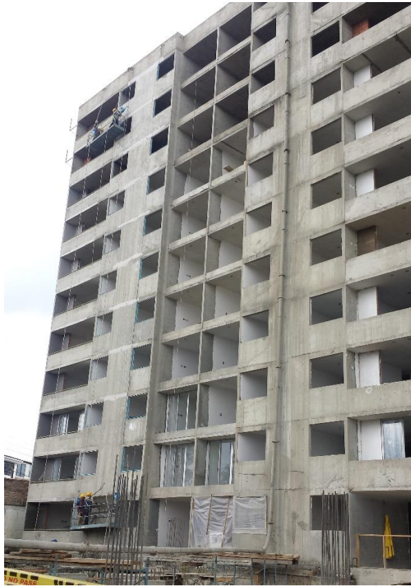
Fotografía 36. Vista frontal piso 11 fundido en su totalidad. Fuente: Tomada por el pasante
