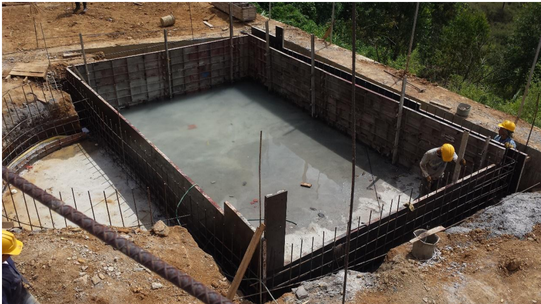
Fotografía 80. Formateado de la piscina. Fuente: Tomada por el pasante
