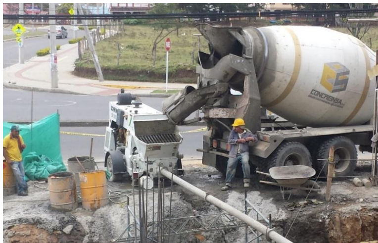
Fotografía 18. Llegada del concreto a obra y vaciada a la bomba. Fuente: Tomada por el pasante
