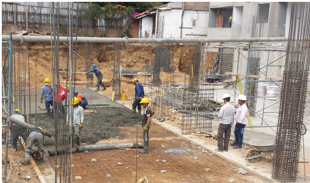
Fotografía 51. Fundición de losa sótano locales comerciales. Fuente: Tomada por el pasante
