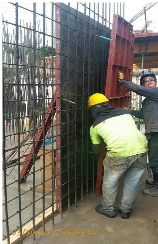
Fotografía 11. Ubicación de formaleta del apto 801. Fuente: Tomada por el pasante
