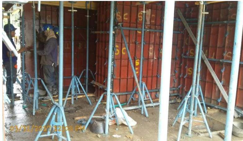
Fotografía 12. Armado completo de comedor del apartamento. Fuente: Tomada por el pasante
