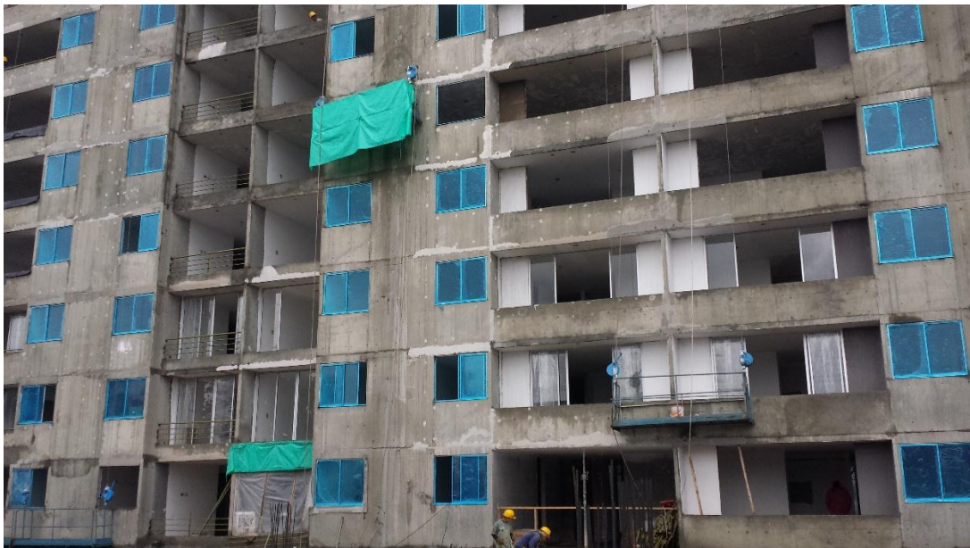
Fotografía 73. Ventanería cubierta con plástico para protección de acabados y obreros colgados en andamios arreglando imperfectos.
