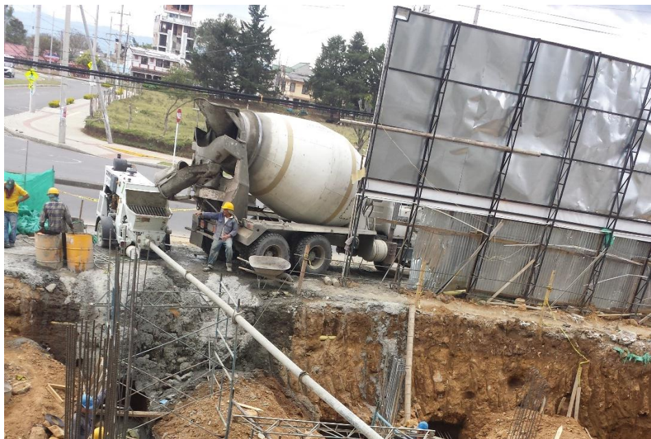
Fotografía 27. Llegada del concreto a la obra. Fuente: Tomada por el pasante
