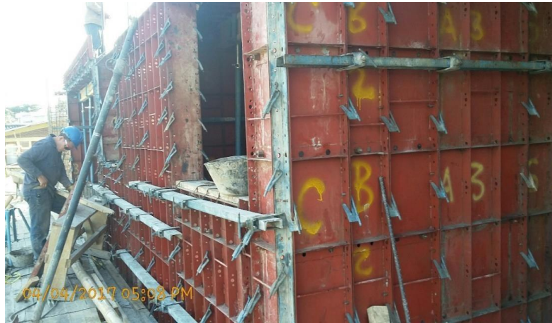
Fotografía 15. Vista frontal de la formaleta armada totalmente Fuente: Tomada por el pasante
