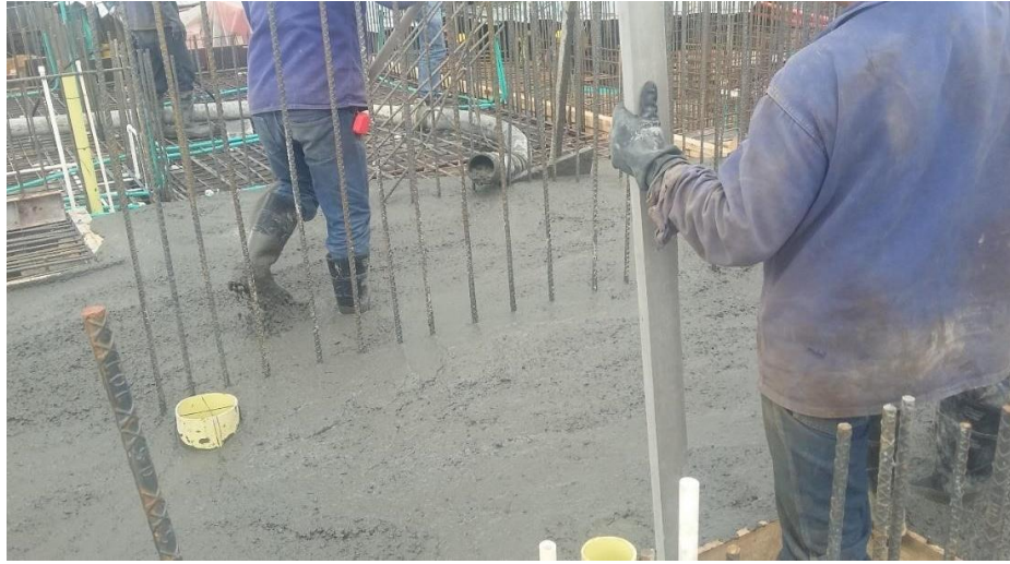
Fotografía 22. Fundición del apto 2. Fuente: Tomada por el pasante
