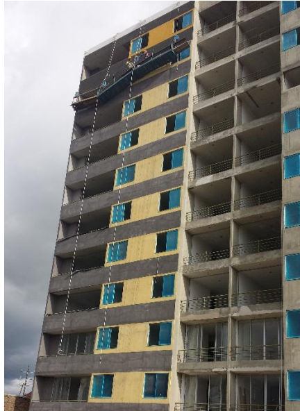
Fotografía 74. Aplicación de capa base sobre fachada principal. Fuente: Tomada por el pasante
