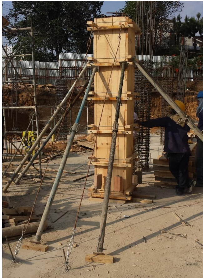
Fotografía 52. Columna formaleteada lista para fundir. Fuente: Tomada por el pasante
