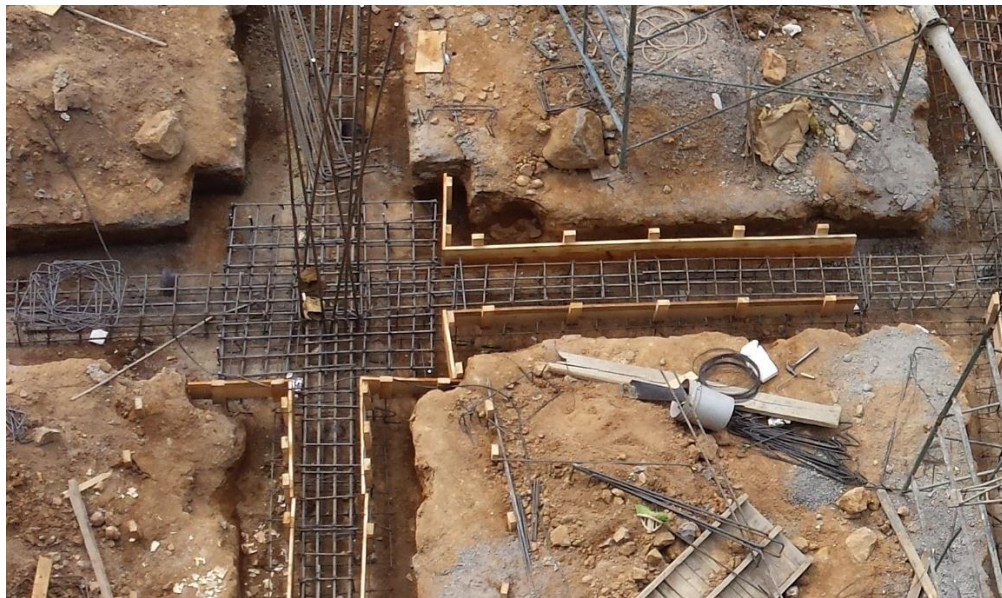
Fotografía 45. Formaleteado de una zapata. Fuente: Tomada por el pasante
