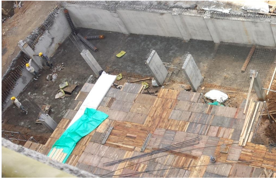
Fotografía 55. Entarimado de tableros sobre gatos y cerchas. Fuente: Tomada por el pasante
