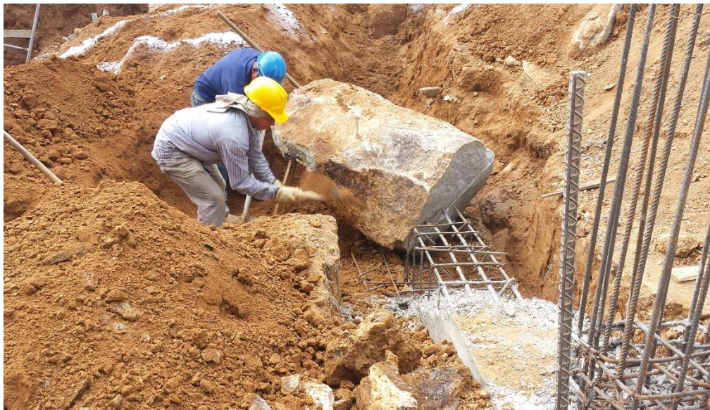
Fotografía 48. Obreros enterrando la roca fracturada. Fuente: Tomada por el pasante
