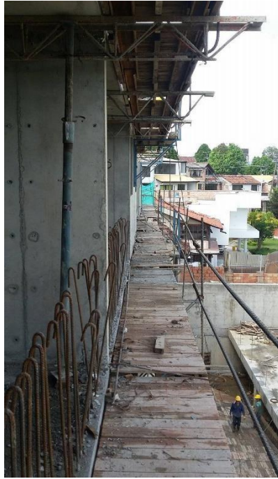
Fotografía 24. Tableros usados sobre las palomeras. Fuente: Tomada por el pasante
