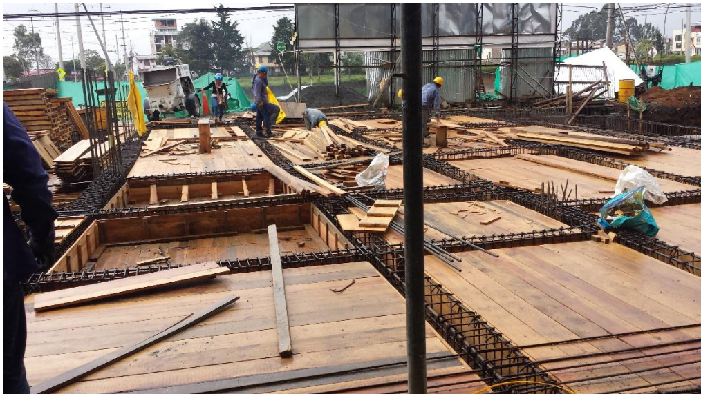
Fotografía 58. Formaleteado de losa y vigas. Fuente: Tomada por el pasante
