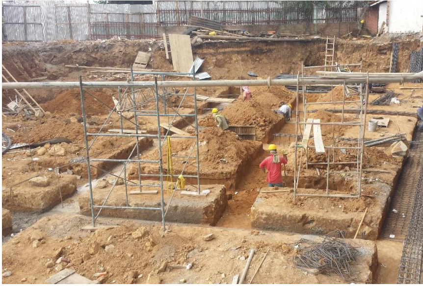
Fotografía 42. Excavación de cimentación locales comerciales. Fuente: Tomada por el pasante
