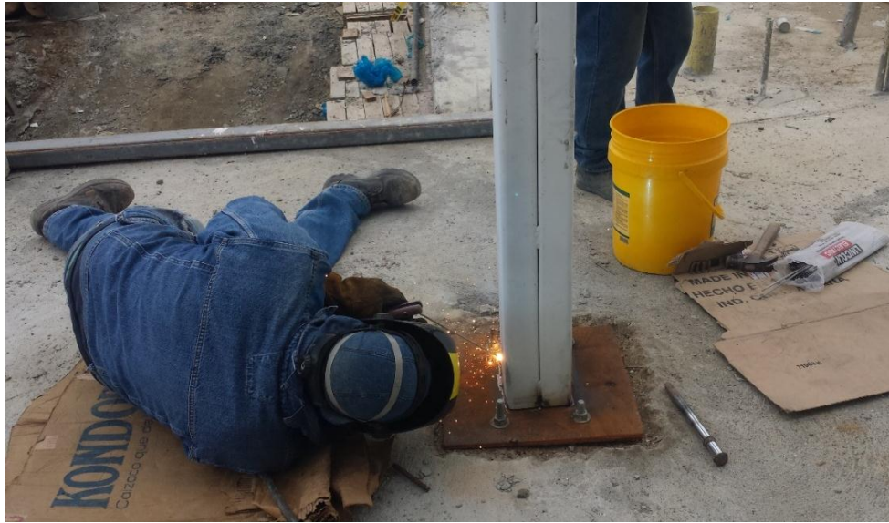
Fotografía 66. Operario soldando columna metálica sobre platina. Fuente: Tomada por el pasante
