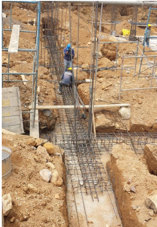
Fotografía 43. Armado de refuerzo de cimentación. Fuente: Tomada por el pasante
