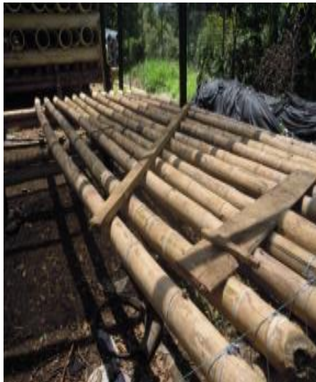
FIGURA 18. Instalación de la estructura en guadua.
