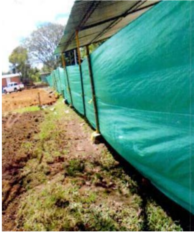
FIGURA 33. Cerramiento Perimetral en lona verde.
