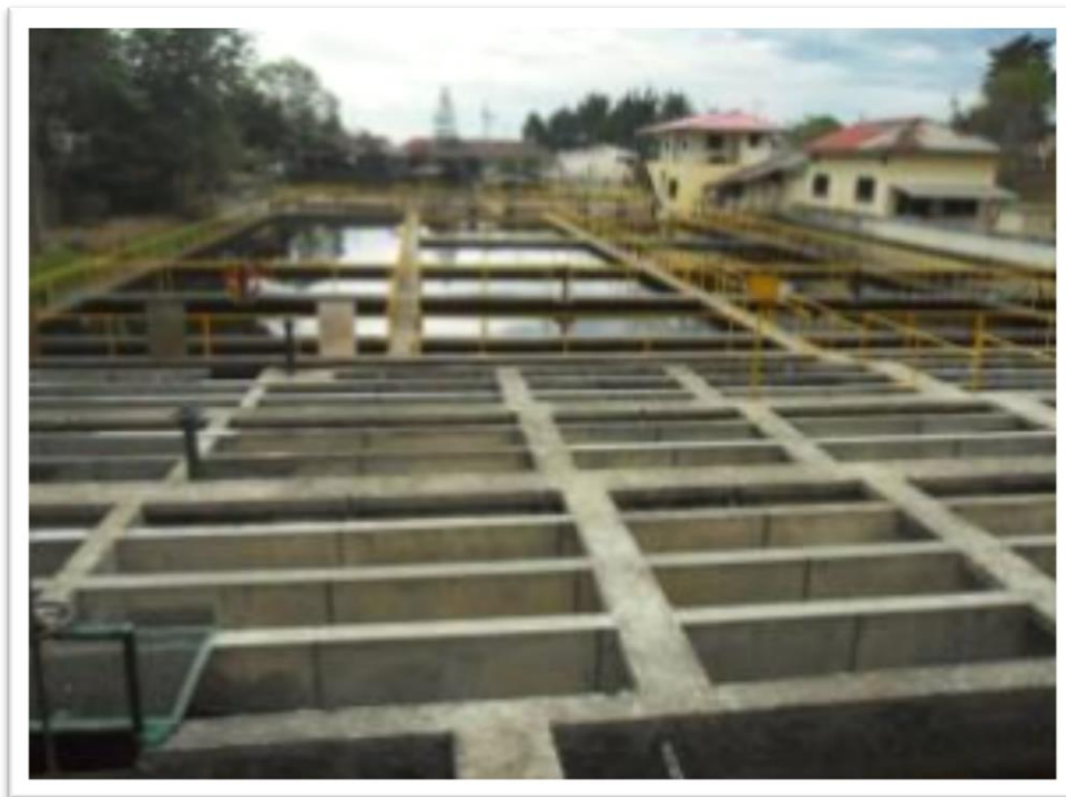
FIGURA 2. Foto Planta de Tratamiento del Tablazo.
