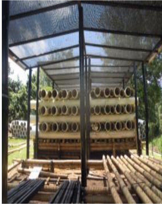
FIGURA 17. Clasificación y colocación de la tubería.
