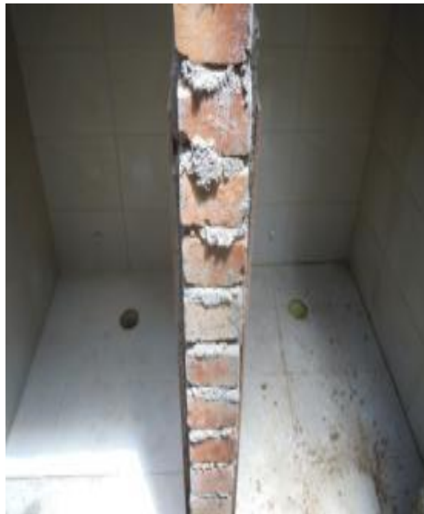
FIGURA 28. Tabique división baños y punto sanitario PVC 4" (Ítems 3.4 y 4,4).
