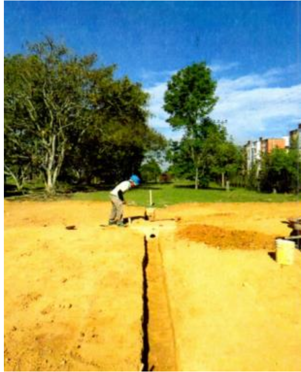
FIGURA 51. Excavación a mano para Tuberías de drenaje (3/3).
