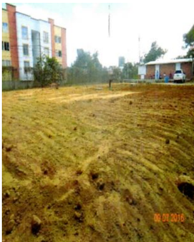
FIGURA 44. Nivelación de la Subrasante (1/2). (Ítem 1,4).
