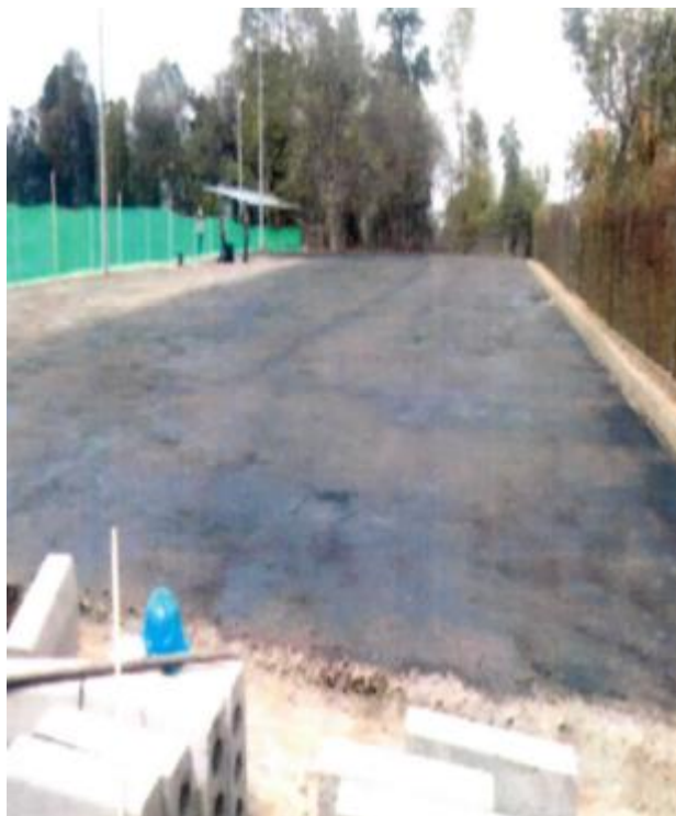
FIGURA 59. Suministro y Riego de Emulsión asfáltica. (Ítem 1.7)
