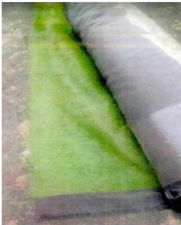
FIGURA 70. Suministro e instalación de césped sintético. (Ítem 2,1).
