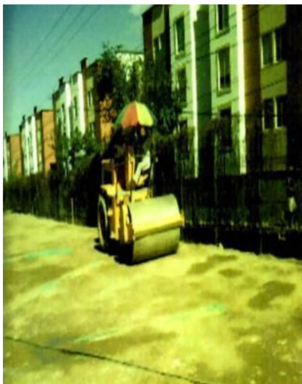
FIGURA 58. Suministro, Riego y Compactación de Sub Base Granular (4/4). (Ítem 1.6)
