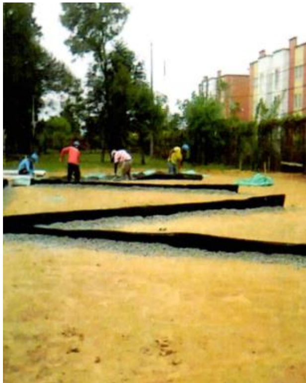
FIGURA 53. Suministro e instalación de Geodren con Tubería perforada de 6". (2/3).
