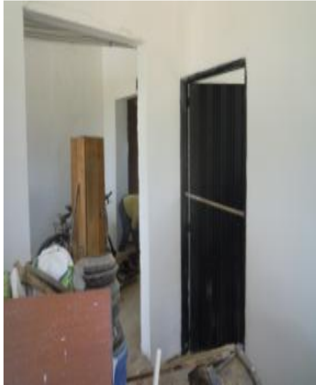
FIGURA 21. Apertura de vano para acceso.
