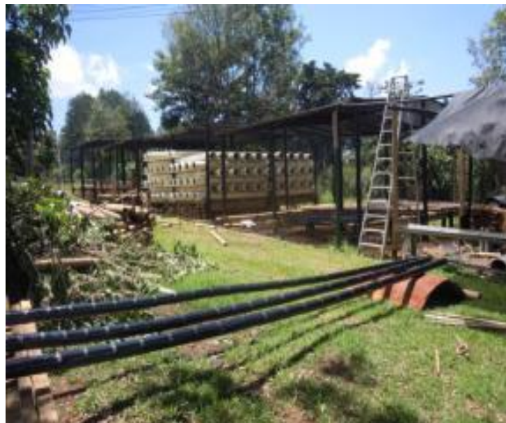
FIGURA 16. Inmunización e impermeabilización de guaduas.
