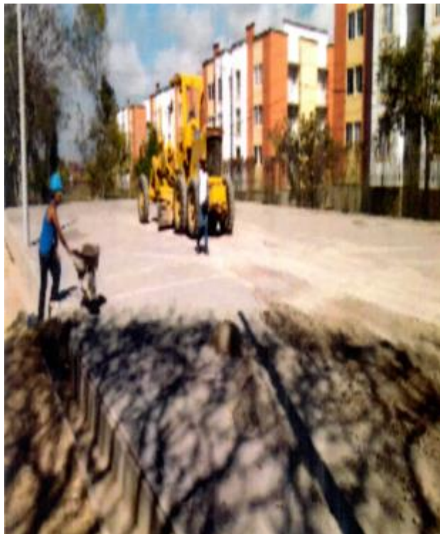
FIGURA 57. Suministro, Riego y Compactación de Sub Base Granular (3/4). (Ítem 1.6)
