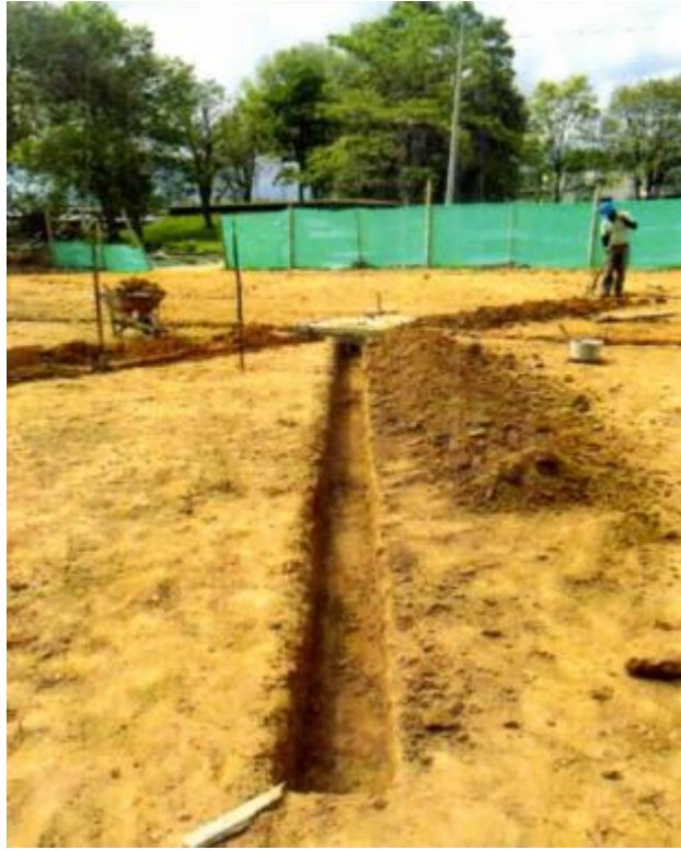
FIGURA 49. Excavación a mano para Tuberías de drenaje (1/3).
