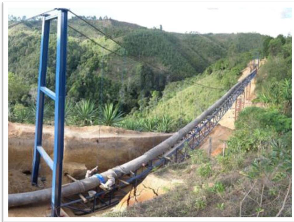
FIGURA 3. Foto Planta de tratamiento de Palacé.
