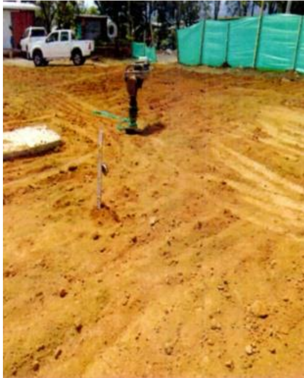
FIGURA 45. Nivelación de la Subrasante (2/2). (Ítem 1,4).
