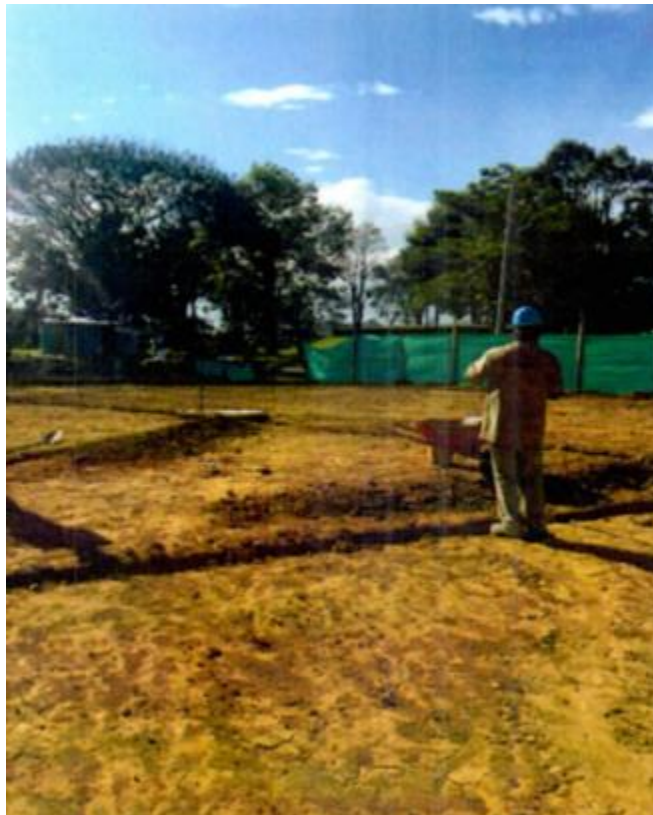
FIGURA 32. Localización y Replanteo. (Ítem 1.1).
