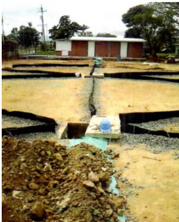
FIGURA 54. Suministro e instalación de Geodren con Tubería perforada de 6". (3/3).
