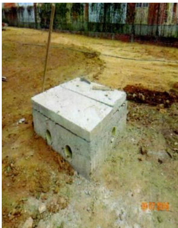
FIGURA 40. Construcción cajas de inspección en concreto (4/4).
