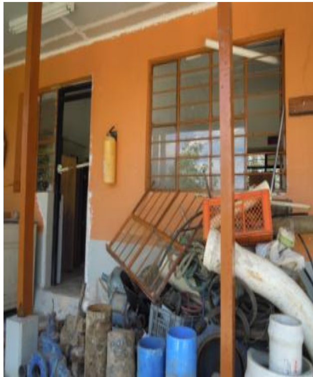
FIGURA 24. Limpieza general de la obra.
