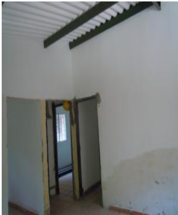
FIGURA 30. Suministro e Instalación de Teja de Fibrocemento. (Ítem 9,2).
