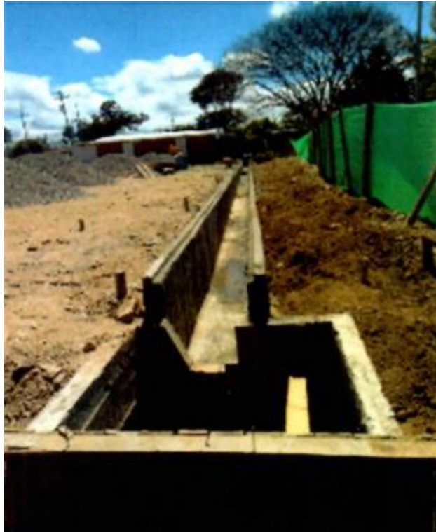
FIGURA 61. Canaleta lateral en concreto reforzado para recolección de aguas lluvias. (2/3).
