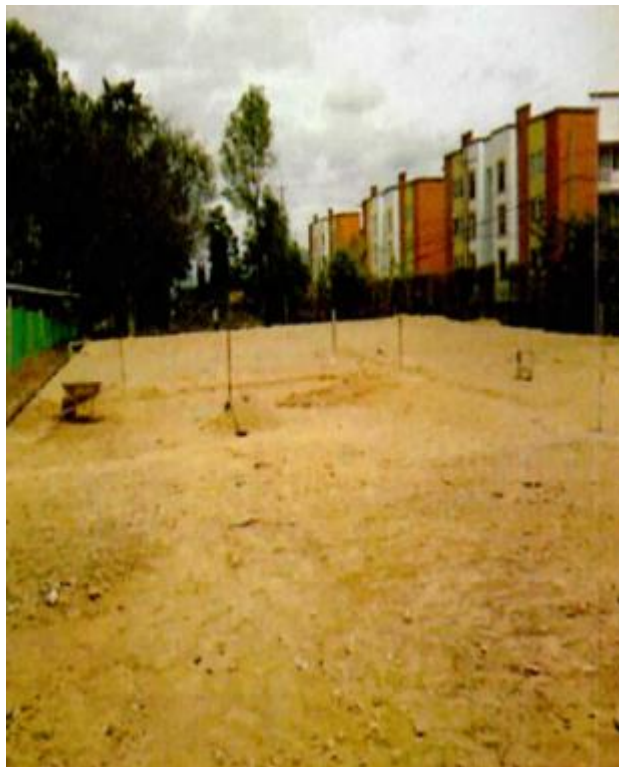
FIGURA 47. Suministro, Riego y Compactación de Roca Muerta (2/3). (Ítem 1,5).
