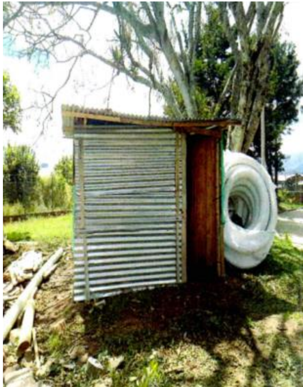
FIGURA 34. Construcción de almacén para insumos.
