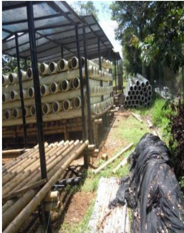
FIGURA 19. Estructura en guadua terminada.
