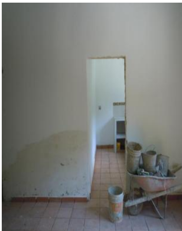
FIGURA 31. Repello y Revitado de muros con mortero 1:3. (Ítem 3,1 y 3,2).
