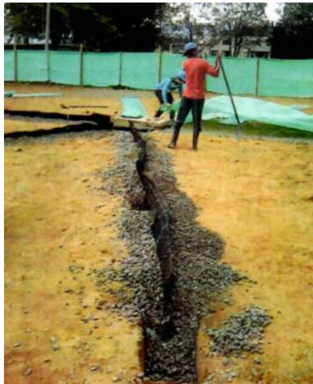
FIGURA 52. Suministro e instalación de Geodren con tubería perforada de 6". (1/3).
