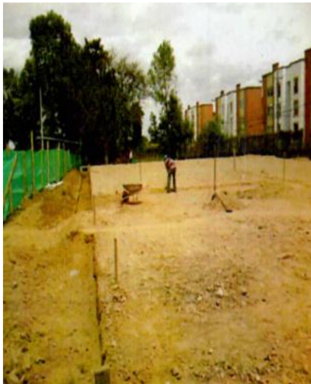
FIGURA 46. Suministro, Riego y Compactación de Roca Muerta (1/3). (Ítem 1,5).
