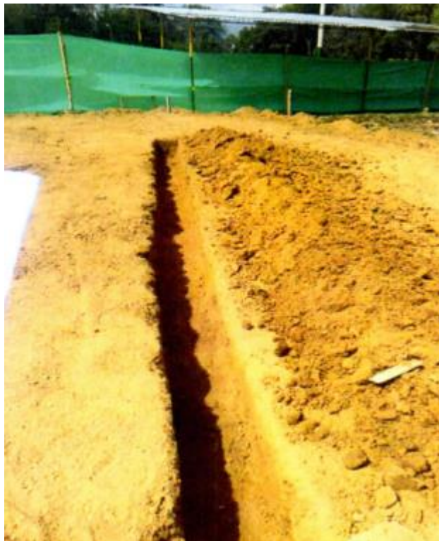
FIGURA 50. Excavación a mano para Tuberías de drenaje (2/3).
