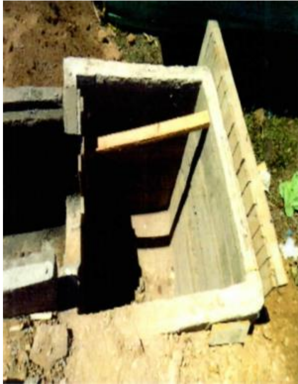
FIGURA 37. Construcción cajas de inspección en concreto (1/4).
