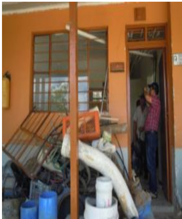
FIGURA 20. Zona frontal de la obra en ejecución.
