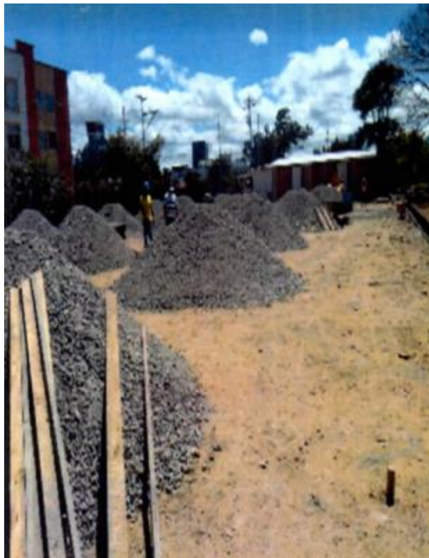
FIGURA 55. Suministro, Riego y Compactación de Sub Base Granular (1/4). (Ítem 1.6)
