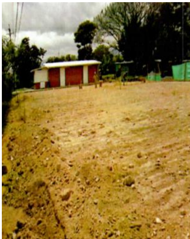
FIGURA 48. Suministro, Riego y Compactación de Roca Muerta (3/3). (Ítem 1,5).
