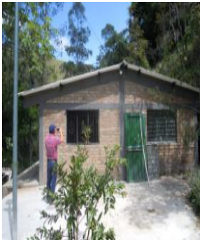
FIGURA 25. Muro en soga en ladrillo común limpio (Ítem 3,5).
