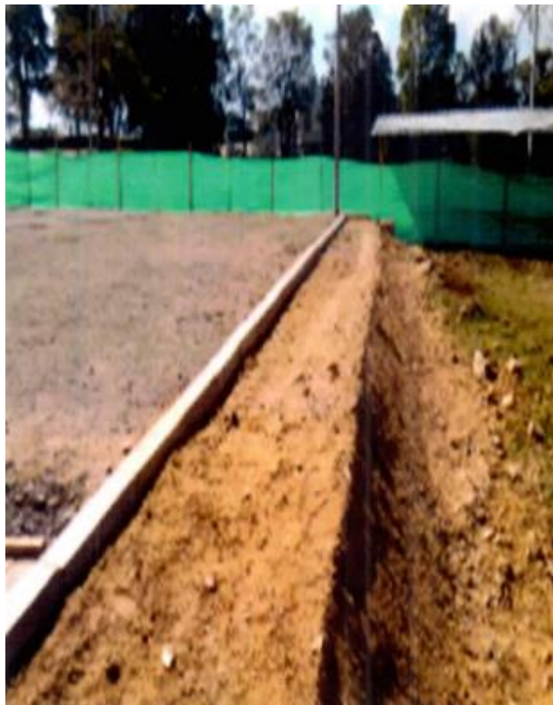
FIGURA 63. Bordillo en concreto para confinamiento. (50x80x20cm).
