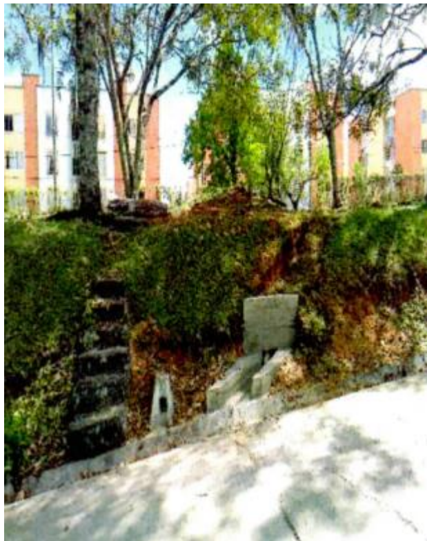
FIGURA 67. Descole de aguas lluvias de la cancha hacia cuneta de la vía.
