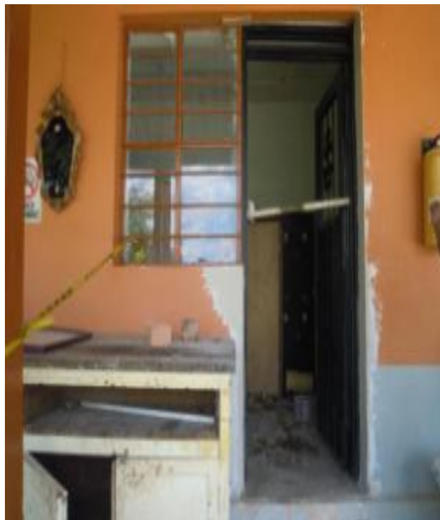
FIGURA 22. Suministro e instalación de marcos y puertas.
