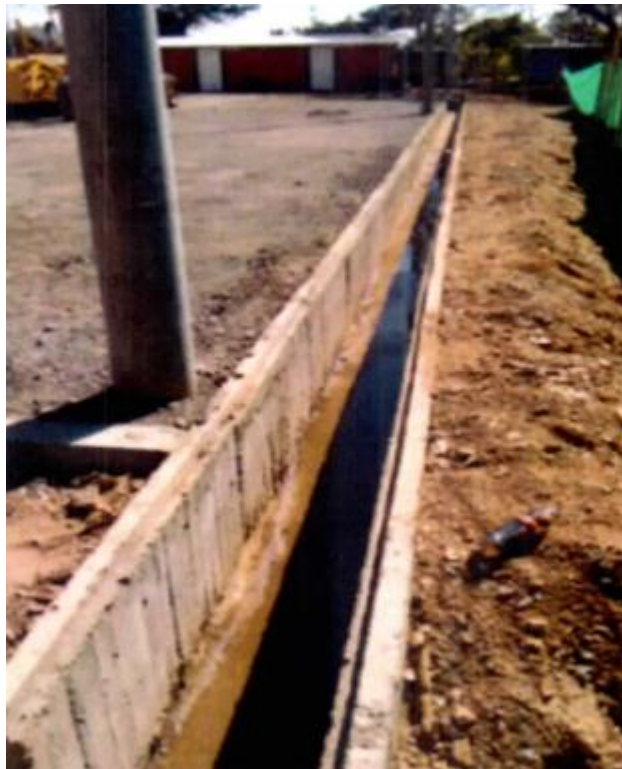
FIGURA 62. Canaleta lateral en concreto reforzado para recolección de aguas lluvias. (3/3).
