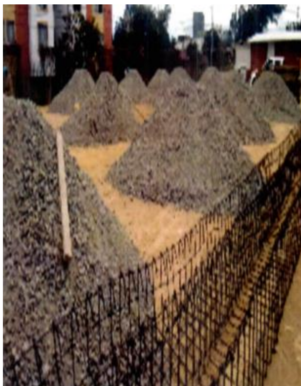
FIGURA 60. Canaleta lateral en concreto reforzado para recolección de aguas lluvias. (1/3).
