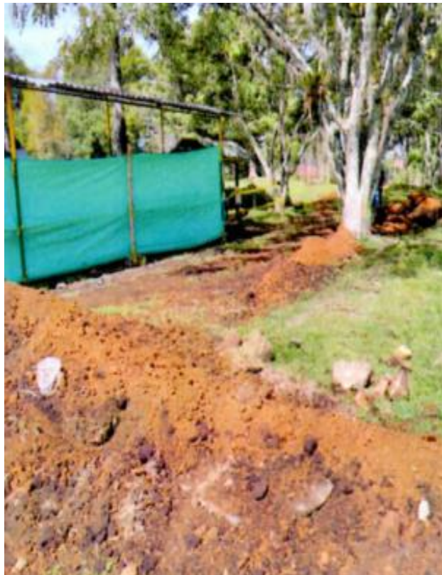
FIGURA 36. Excavaciones a máquina (Ítem 1,2).
