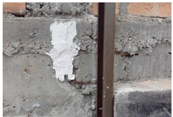
Imagen 35. Acero de refuerzo sin el recubrimiento adecuado, fuente propia
