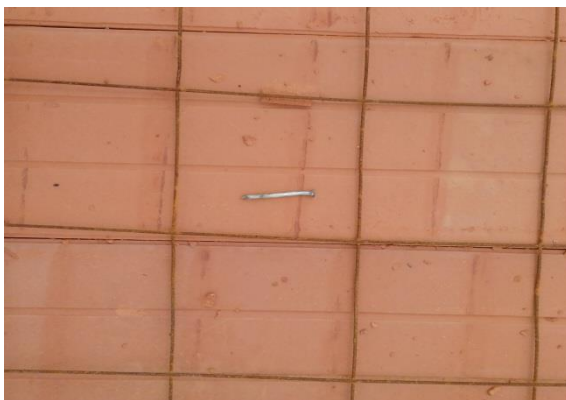
Imagen 76. Conectores utilizados para el anclaje de los perfiles, fuente propia
