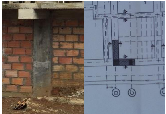
Imagen 9. Modificación en la pantalla ubicada en los ejes 2D-C', fuente propia
