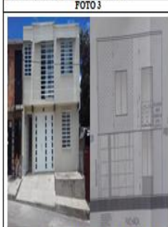
Descripción: Modificaciones realizadas en la fachada de la edificación, fuente propia.
