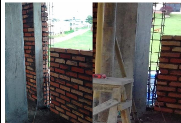
Imagen 34. Irregularidades en el dentado de columnetas, fuente propia
