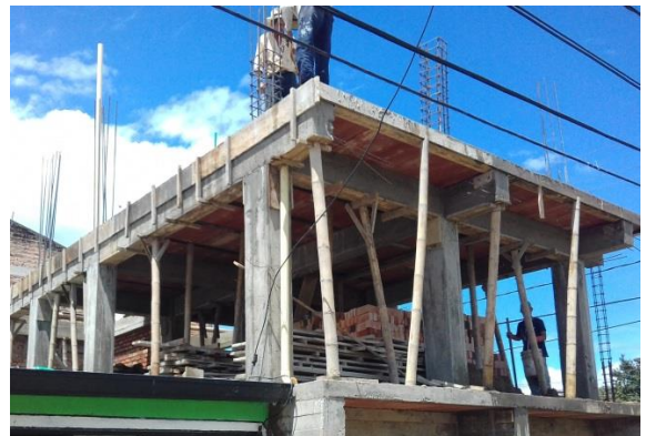
Imagen 33. Falta de columnetas de confinamiento, fuente propia
