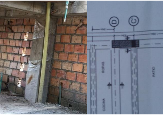
Imagen 10. Modificación en la pantalla ubicada en los ejes 3D-C', fuente propia
