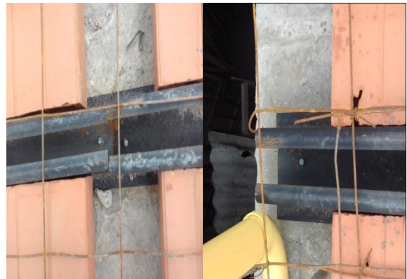
Imagen 75. Anclaje del perfil a la viga de entrecimiento, fuente propia
