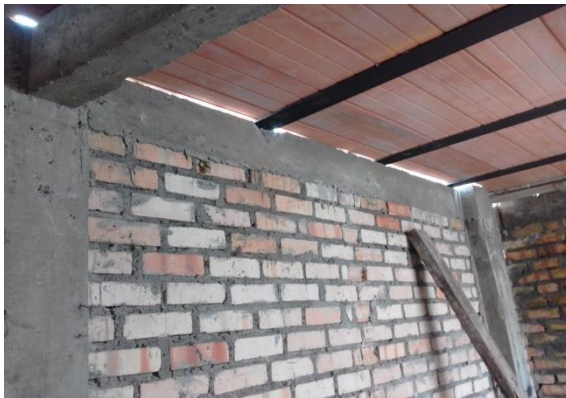
Imagen 74. Colocación de perfiles y bloques, fuente propia
