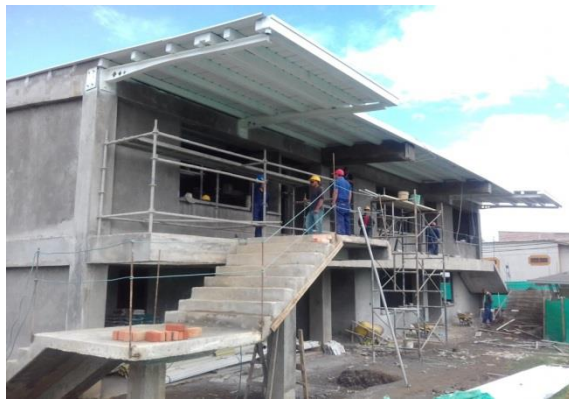
Imagen 20. Cambio de vigas de concreto por perfiles metálicos, fuente propia
