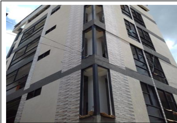
Imagen 14. Modificación en la fachada de la edificación, fuente propia
