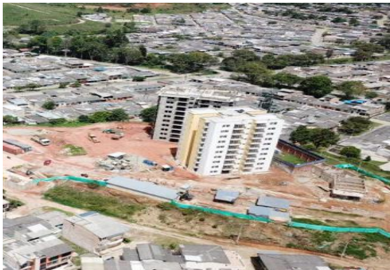
Imagen 40. Vista general del proyecto, fuente página Constructora Trametal
