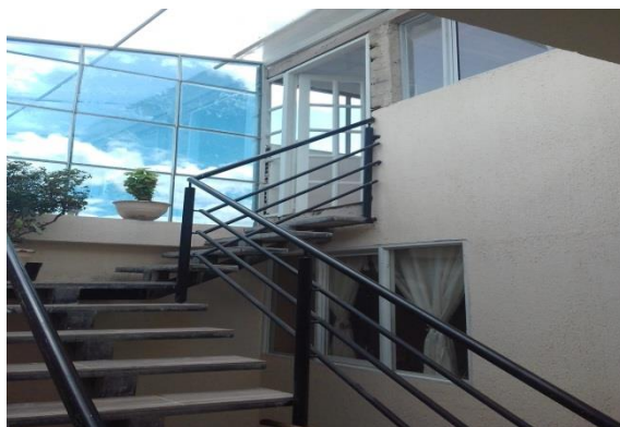
Imagen 98. Construcción de piso adicional, fuente propia
