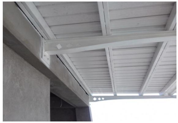
Imagen 21. Adición de perfil metálico entre el eje D-E, fuente propia
