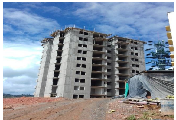
Imagen 39. Construcción de la torre B del proyecto, fuente propia
