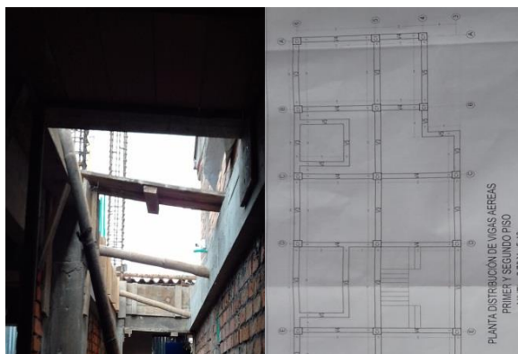
Imagen 53. Prolongación de la viga V3 y V4, fuente propia
