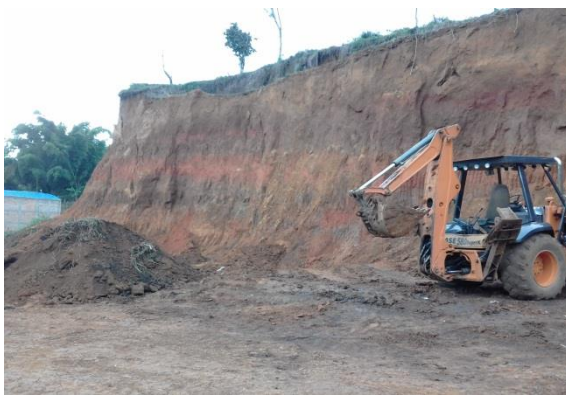
Imagen 88. Modificación en la pendiente del talud de corte, fuente propia
