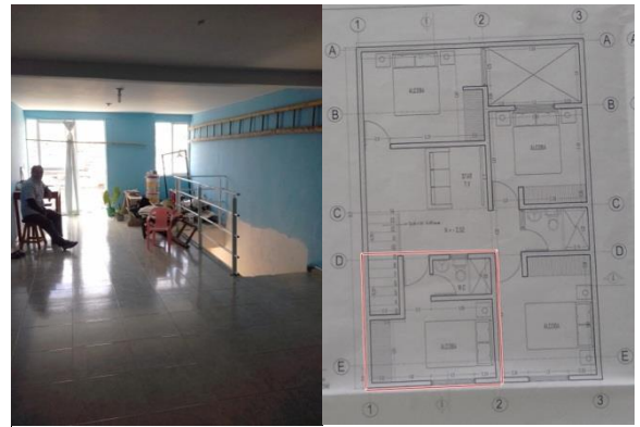
Imagen 69. Faltante de alcoba ubicada entre los ejes 1-2 y D-E, fuente propia
