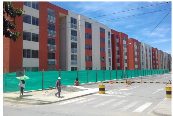
Imagen 79. Construcción de cuatro (4) torres de apartamentos, fuente propia
