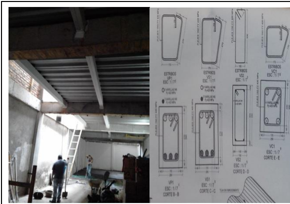
Imagen 64. Cambio de vigas de concreto por perfiles metálicos, fuente propia
