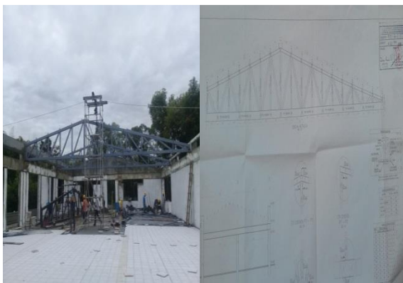
Imagen 28. Modificación en el diseño de las cerchas de cubierta, fuente propia
