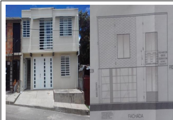
Imagen 68. Modificaciones en la fachada de la edificación, fuente propia
