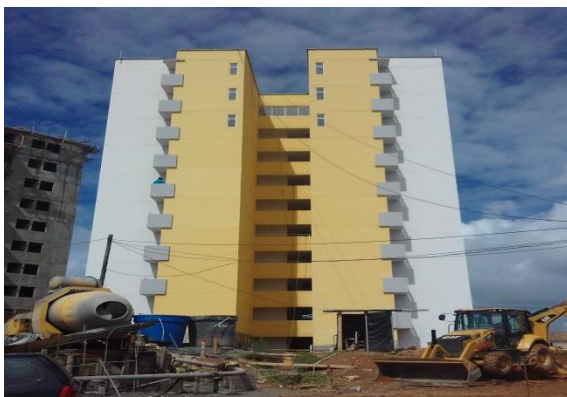
Imagen 38. Construcción de la torre A del proyecto, fuente propia
