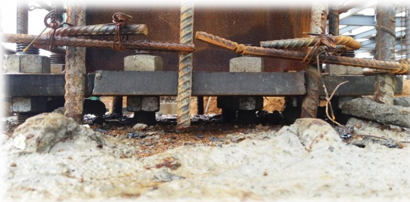
Fotografía 8: Base de columna con sus respectivas tuercas de nivelación y ajuste
