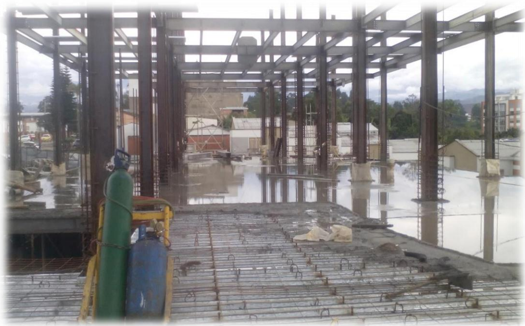
Fotografía 20: Curado de primer tramo, losa piso 1.
