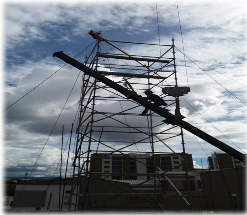
Fotografía 6: montaje de columna con andamio y diferencial.
