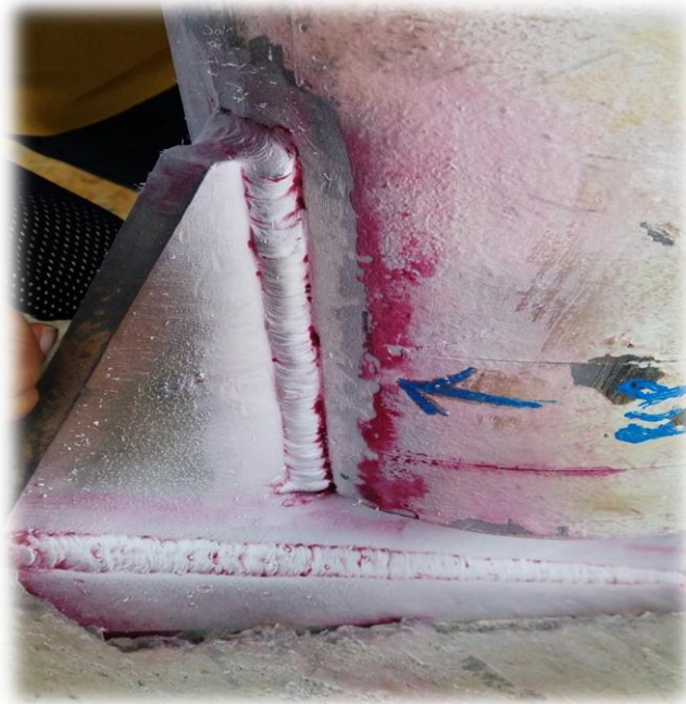
Fotografía 36: Soldadura para reparar
