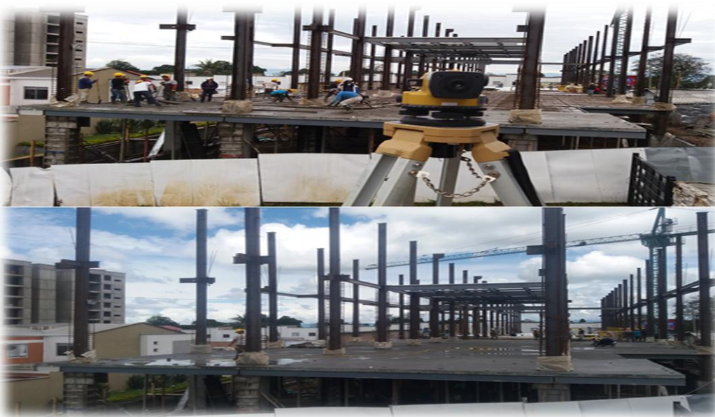
Fotografía 19: Nivelación y acabado de primer tramo, losa 1.
