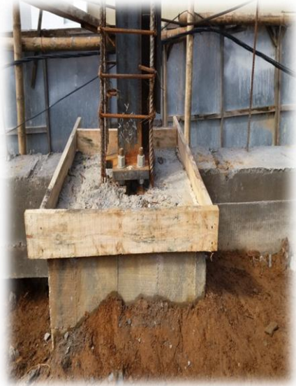
Fotografía 24: Superficie lista para aplicar grout.
