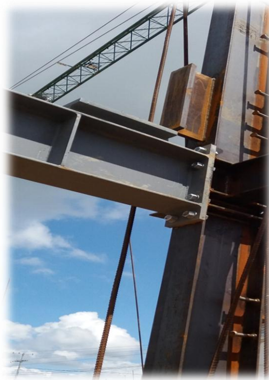
Fotografía 41: Conexión viga-columna a momento con chapa frontal a tope en obra.
