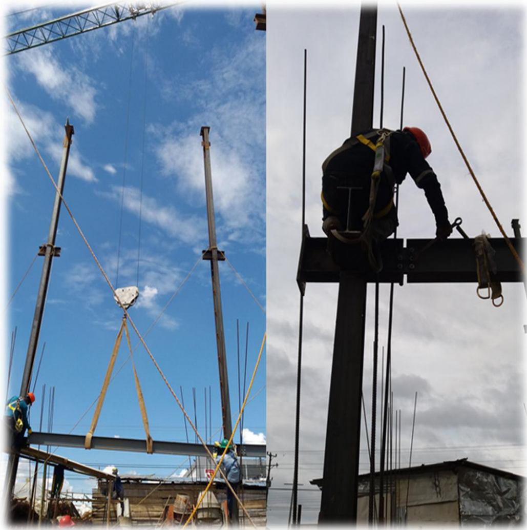
Fotografía 9: Montaje de viga con ayuda de la torre grúa
