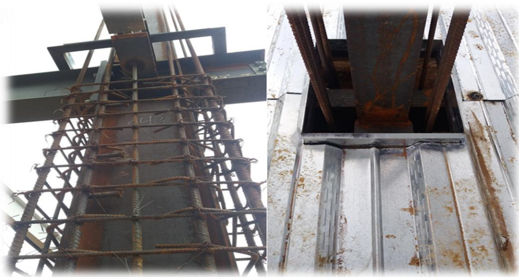
Fotografía 12: Collarín en columna, antes y después de instalar lámina.
