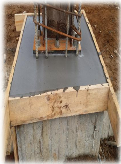
Fotografía 25: Superficie nivelada con el grout.
