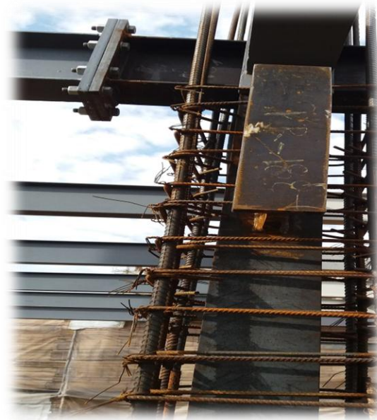
Fotografía 42: Conexión viga-columna a momento con chapa en alero en obra.
