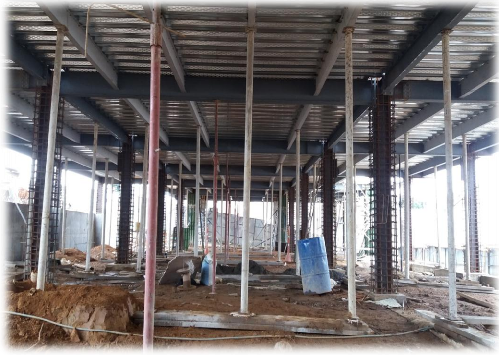
Fotografía 17: Puntales en cada centro de luz de las vigas y viguetas.
