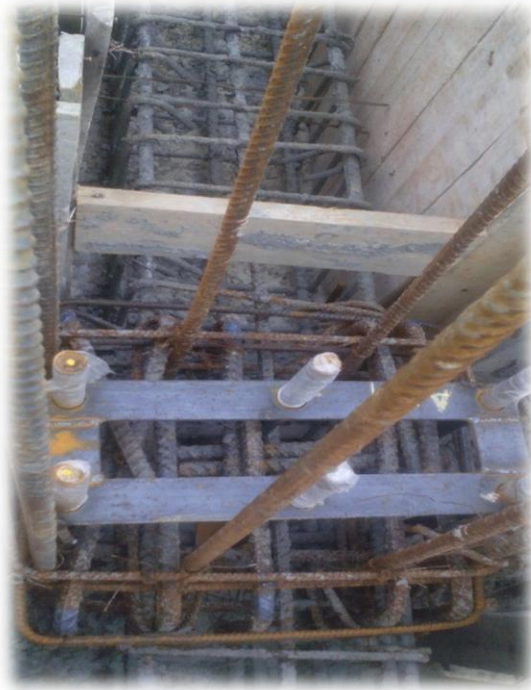
Fotografía 4: Viga y pedestal antes de fundición.
