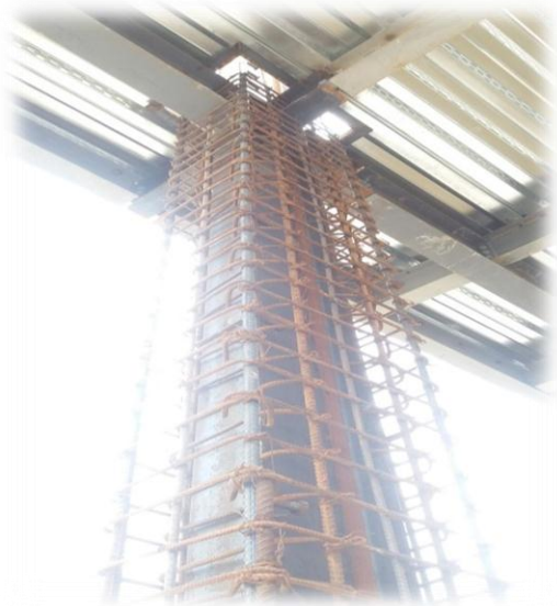
Fotografía 23: Nudo con los estribos soldados,
