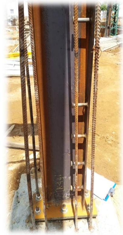
Fotografía 21: Conectores en columna real.
