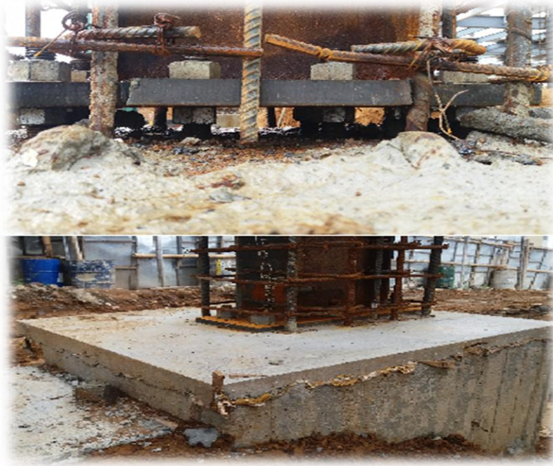
Fotografía 40: Unión pedestal-columna hecha en obra.
