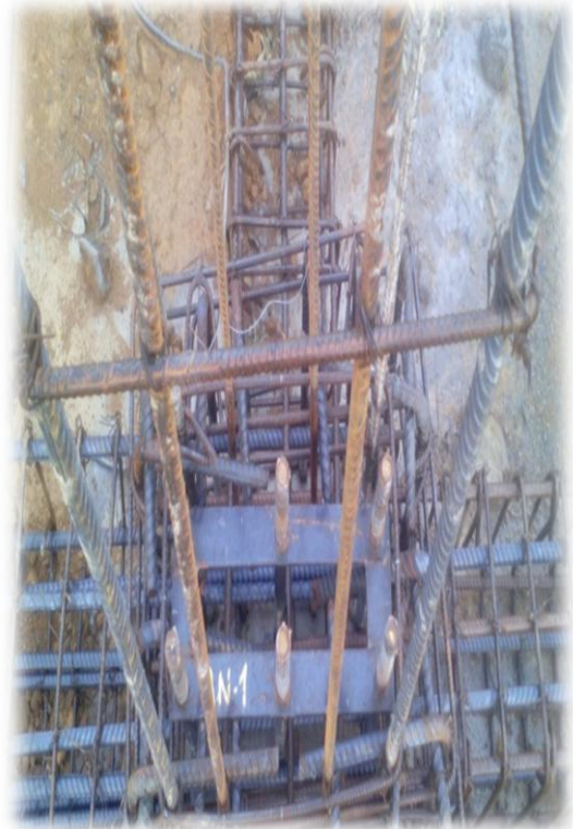
Fotografía 3: Colocación de acero de vigas y pedestal y posicionamiento de anclaje.
