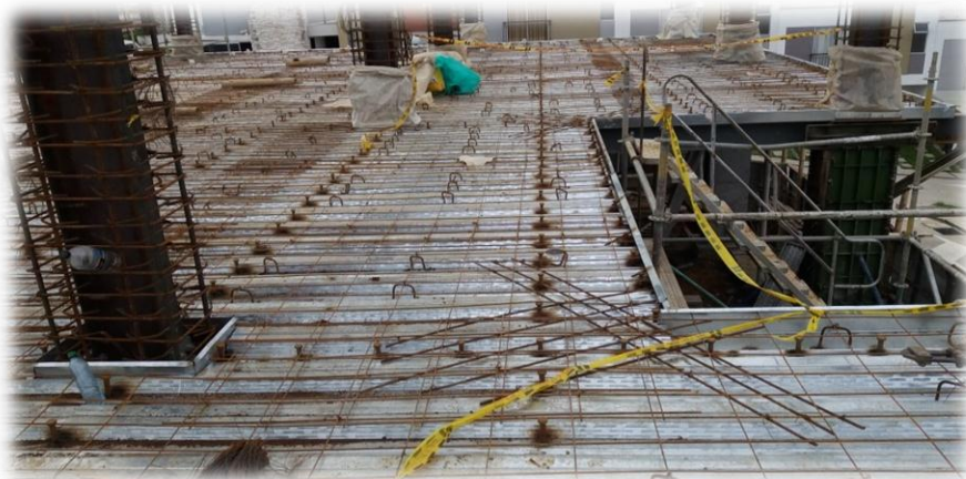
Fotografía 16: Acero adicional en las esquinas del área de escaleras.
