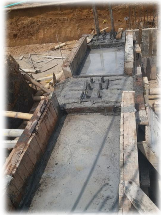
Fotografía 5: Viga y pedestales después de fundición.
