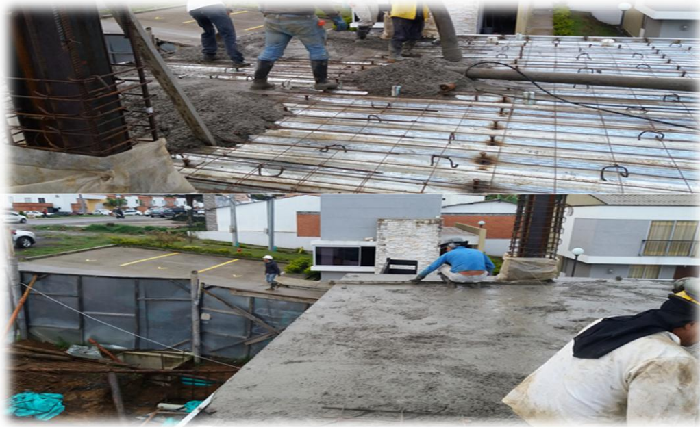
Fotografía 18: Fundición de losa, piso 1.
