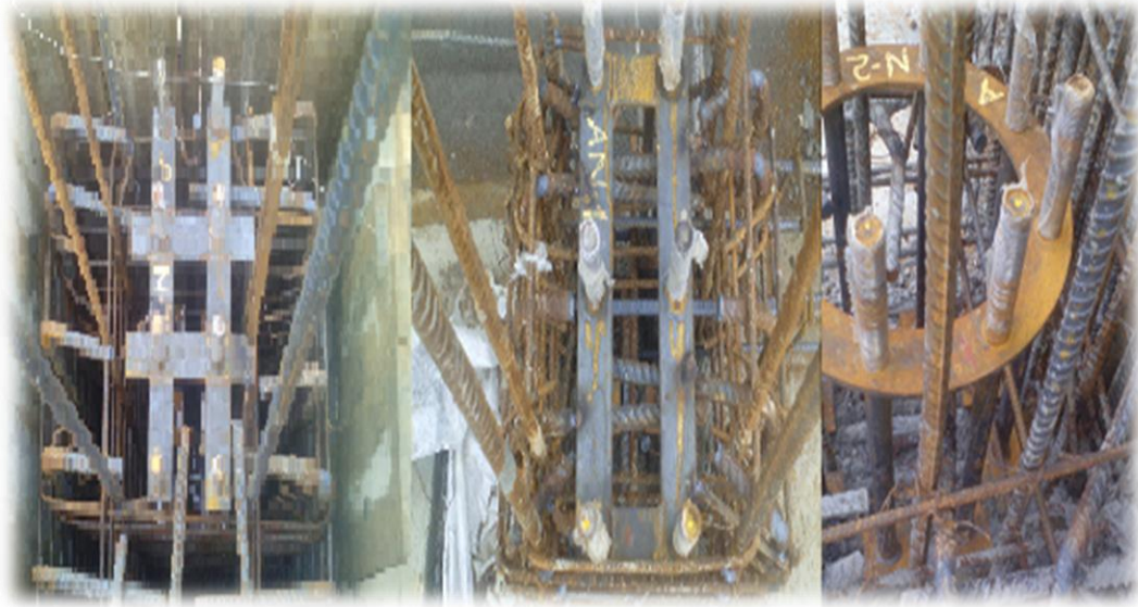
Fotografía 39: Anclajes ya instalados en obra.
