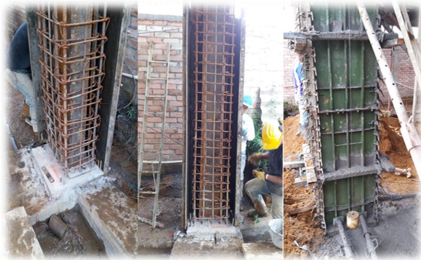
Fotografía 28: Proceso de encofrado de columnas.
