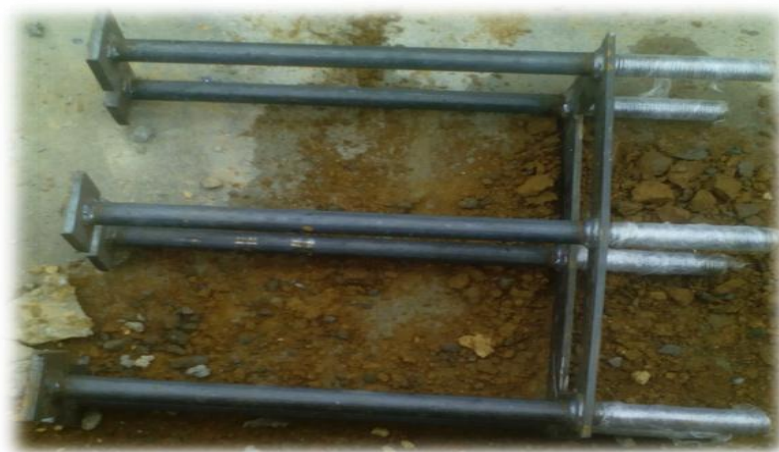
Fotografía 38: Anclaje real en obra.
