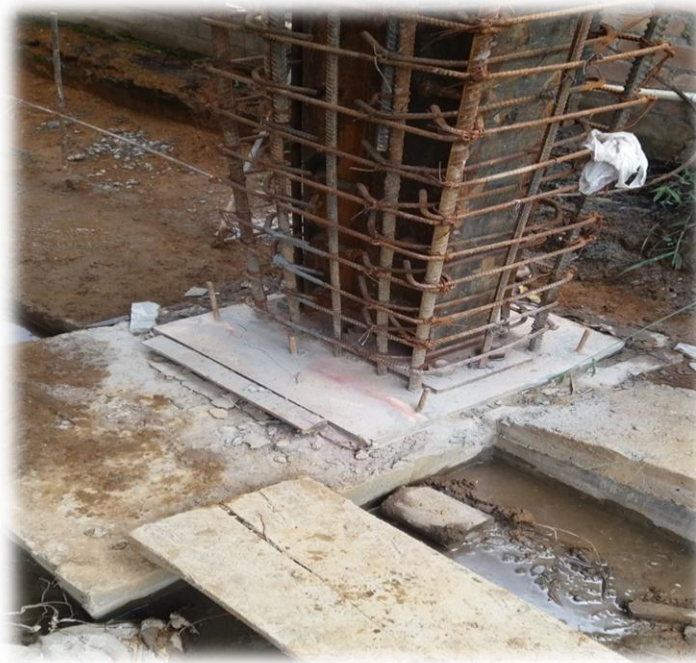
Fotografía 27: Pines para localización de formaleta para columnas.
