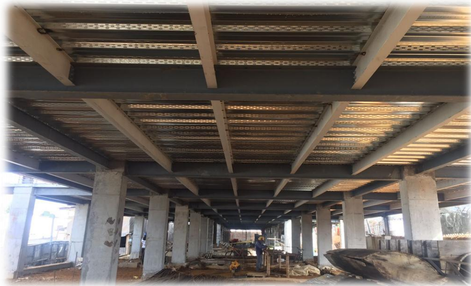
Fotografía 31: Columnas fundidas primer nivel.
