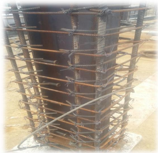
Fotografía 22: Instalación y amarre de estribos y ganchos.
