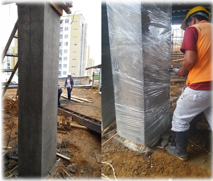
Fotografía 29: Desencofrado y curado de columnas.
