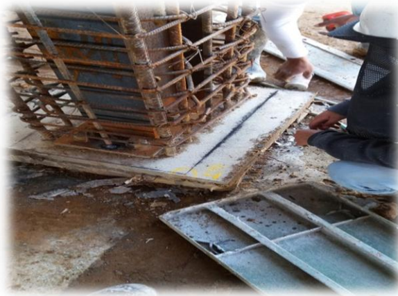
Fotografía 26: Referencia y cimbrado para formaleta de columna.
