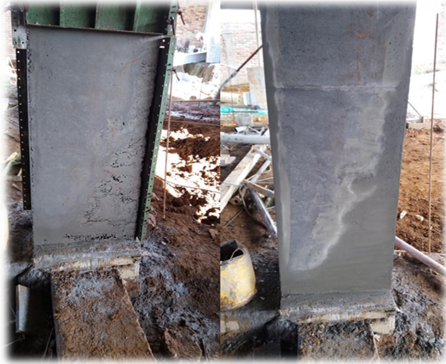
Fotografía 30: reparación de columna hormigueada.
