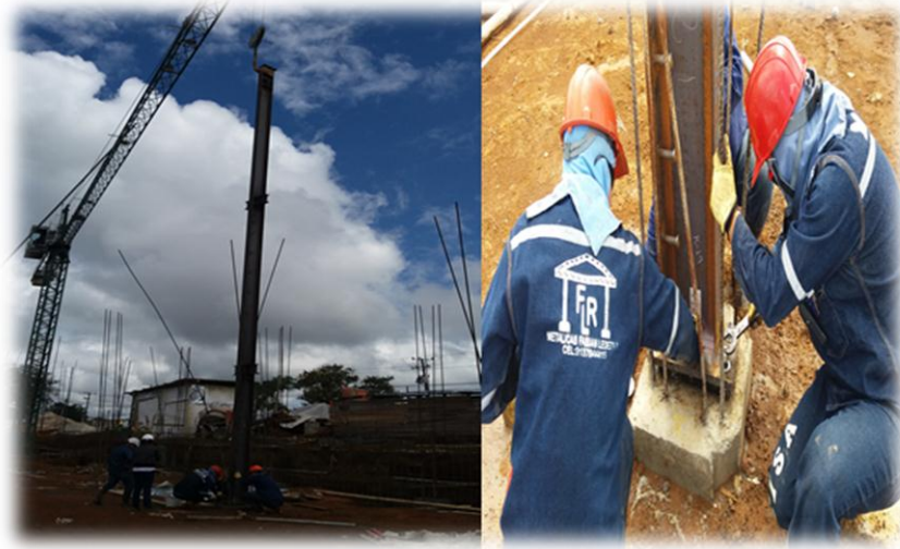
Fotografía 7: Montaje de columna.
