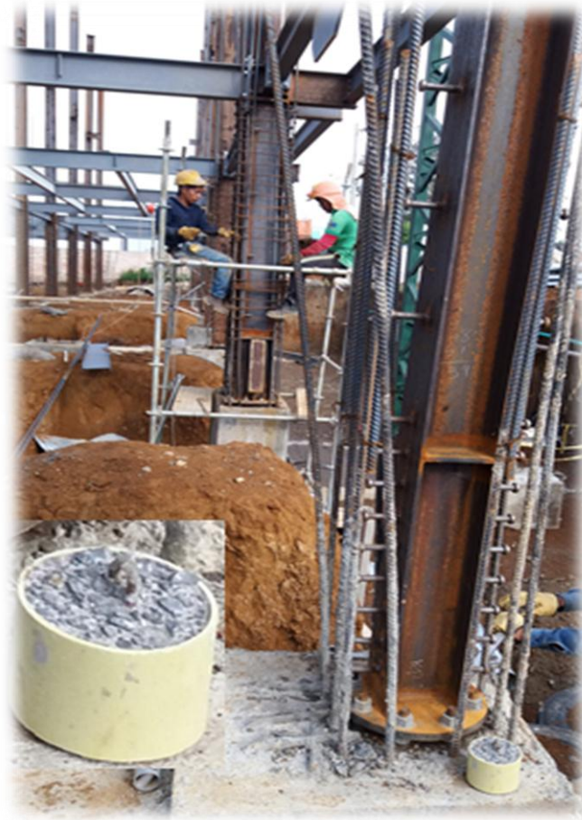
Fotografía 10: Pesas (plomada) usadas para dar plomo vertical a las columnas.
