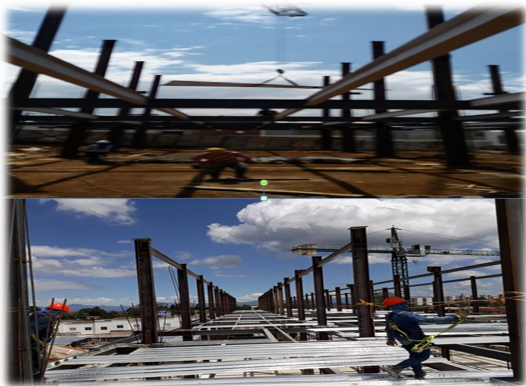
Fotografía 11: Colocación de lámina con ayuda de la torre grúa.
