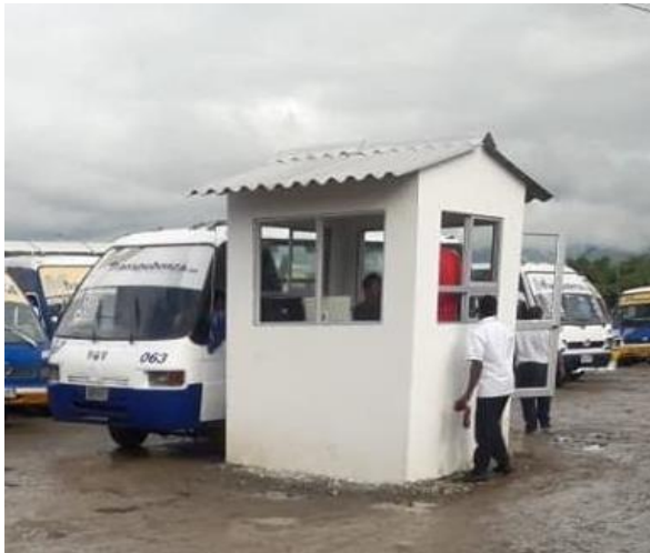
Figura XXII. Caseta de despacho. Fuente. Propia.
