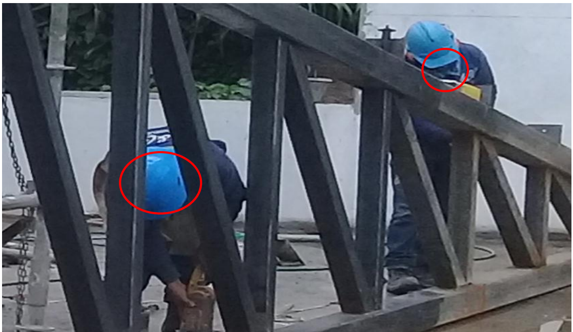
Figura 47. Soldadores usando gafas y protección
