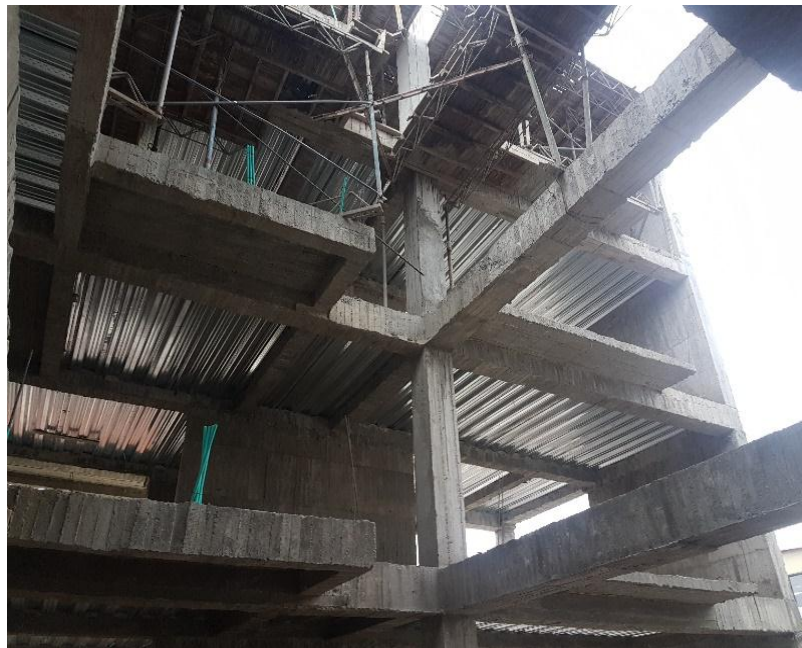
Figura 63. Estructura de vigas, columnas, pantallas y losa
