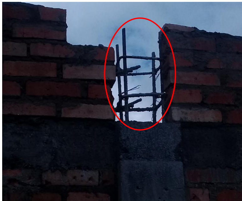
Figura 25. Refuerzo en columnas intermedias
