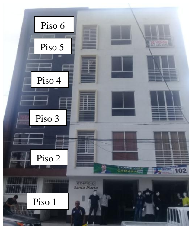
Figura 21. Fachada del edificio construido
