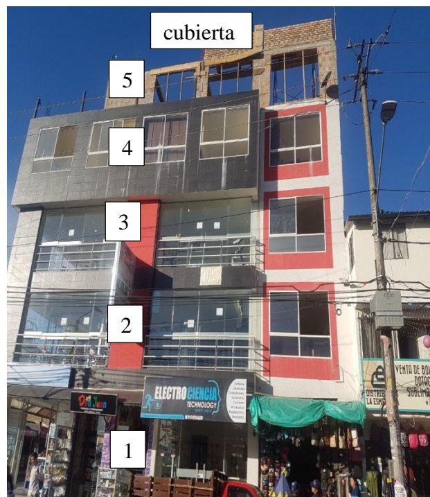
Figura 57. Fachada de la edificación
