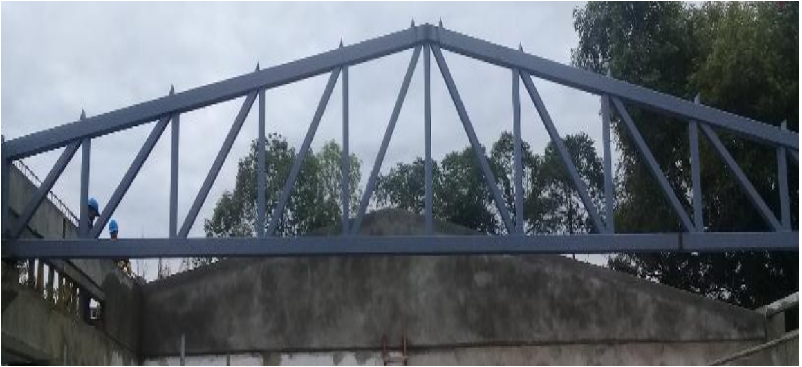
Figura 38. Cercha en obra
