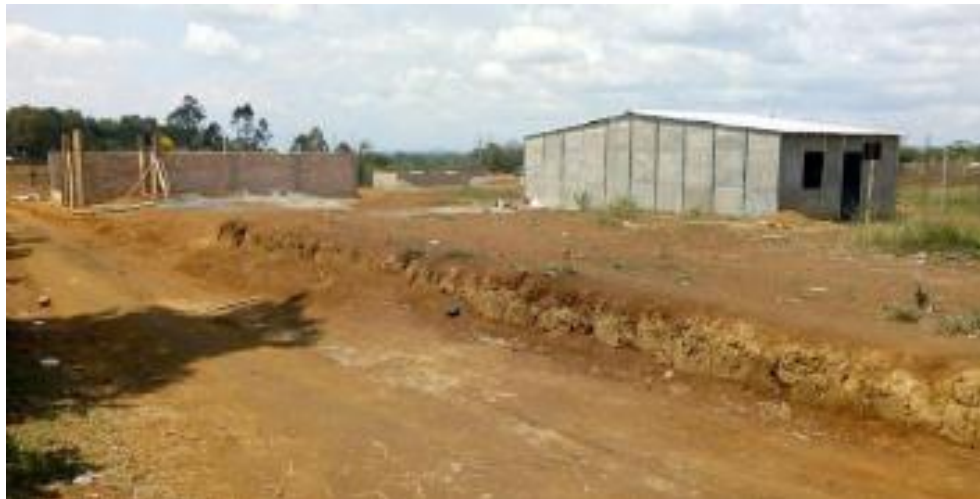
Figura 18. Apertura de vías para urbanismo
