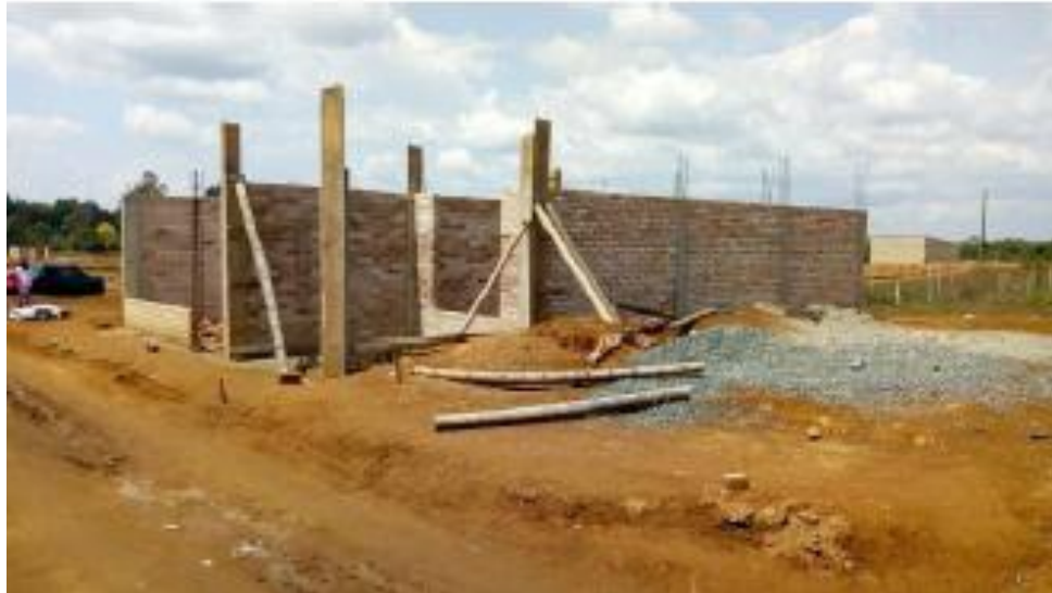
Figura 19. Construcción de viviendas
