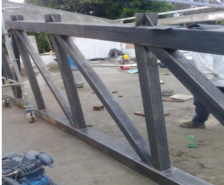
Figura 40. Perfiles en obra
