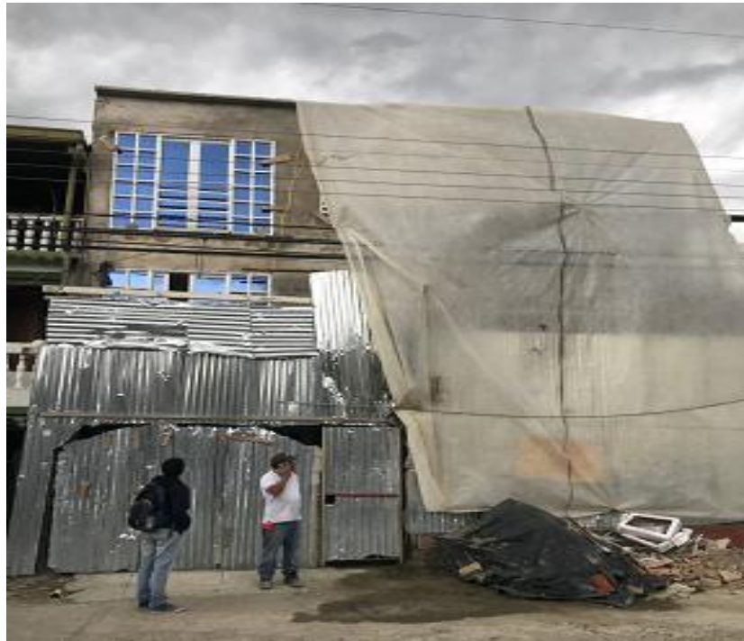
Figura 33. Construcción de vivienda de cuatro pisos
