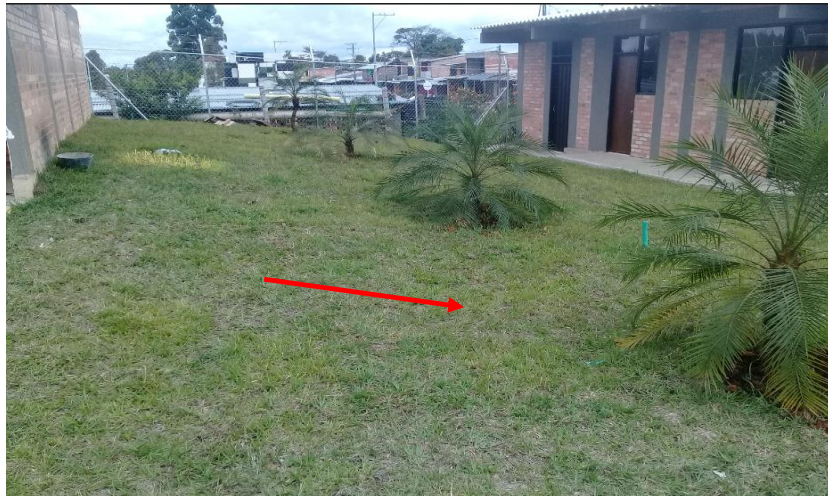
Figura 60. Área de drenaje hacia la vía
