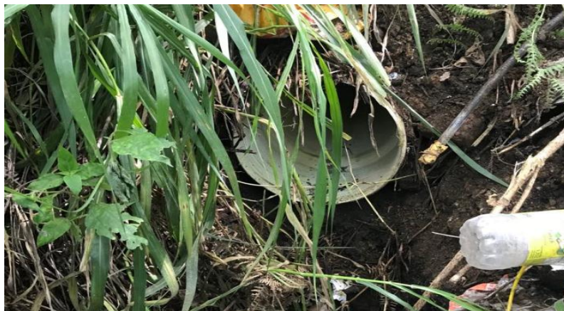
Figura 59. Desembocadura de alcantarillado pluvial
