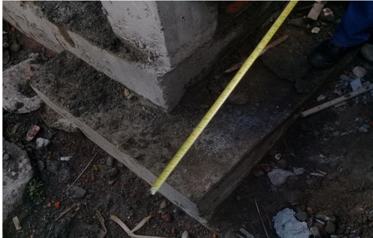
Figura 22. Zapata en obra
