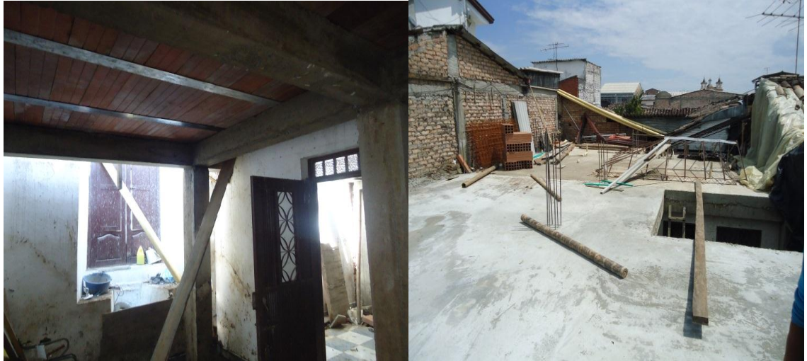
Figura 65. Losa aligerada, vista inferior y superior
