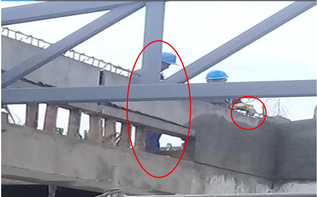
Figura 46. Arnés de seguridad para trabajadores en altura
