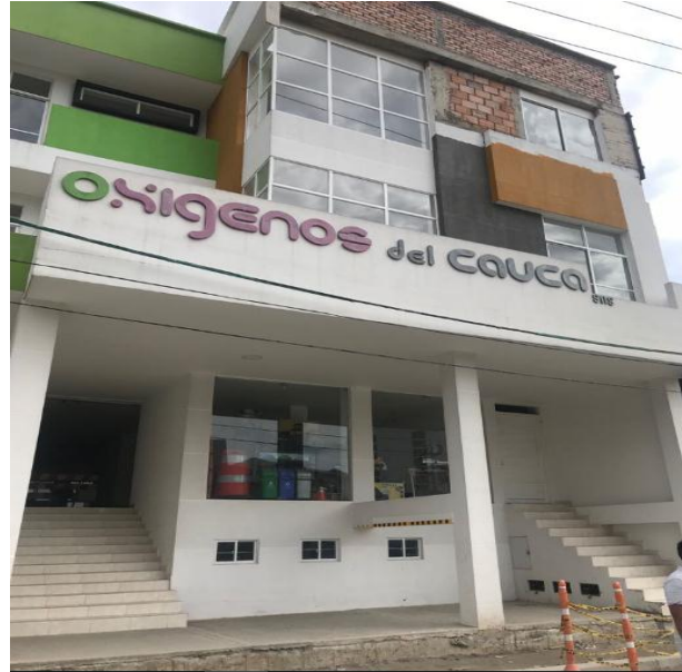
Figura 7. Fachada de la construcción
