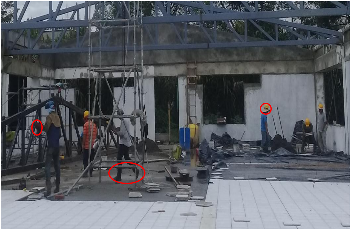
Figura 45. Obreros usando elementos de protección
