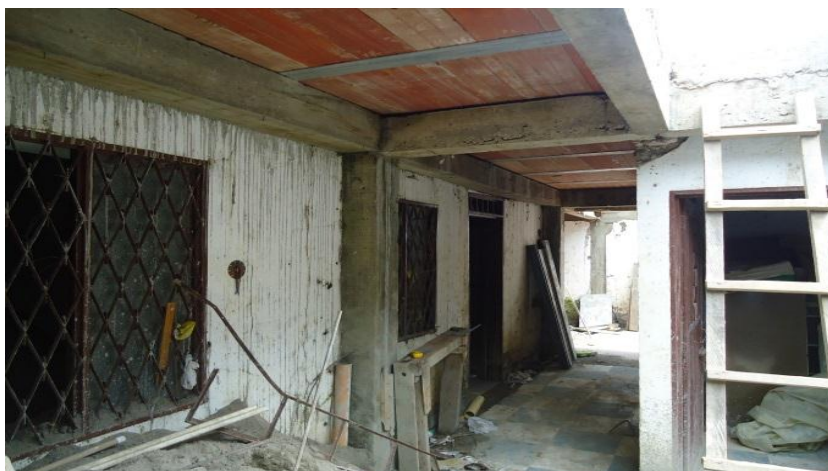
Figura 64. Reforzamiento estructural, se mantienen muros
