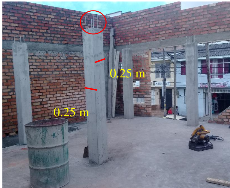
Figura 24. Sección de columnas
