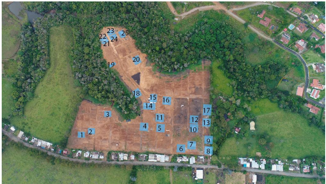
Figura 17. Localización de las viviendas en construcción (Dron oficina de Planeación)
