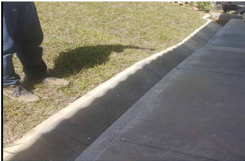
Figura 61. Cunetas de desviación hacia la vía
