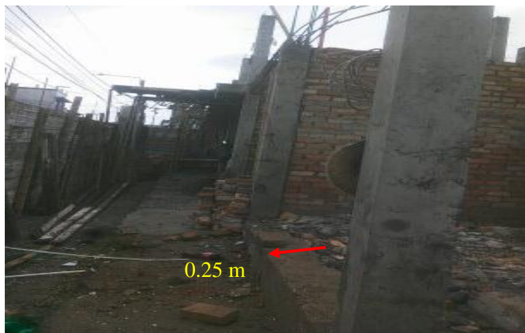
Figura 23. Vigas de sobre cimiento
