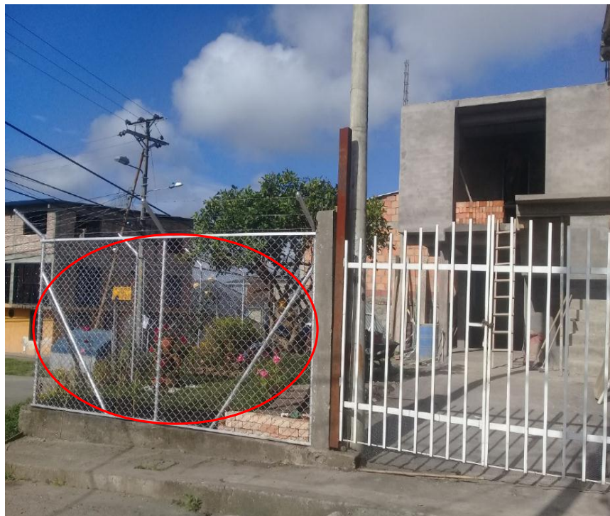
Figura 9. Cerramiento de zona pública
