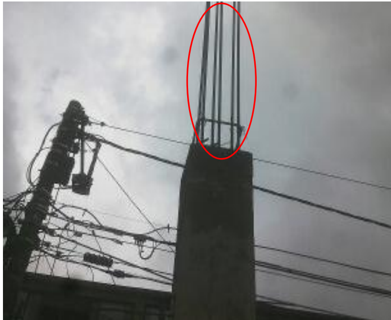
Figura 26. Refuerzo en columnas esquineras
