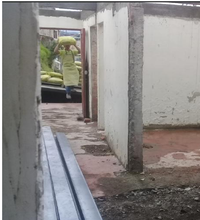
Figura 56. Adecuación para inicio de obra
