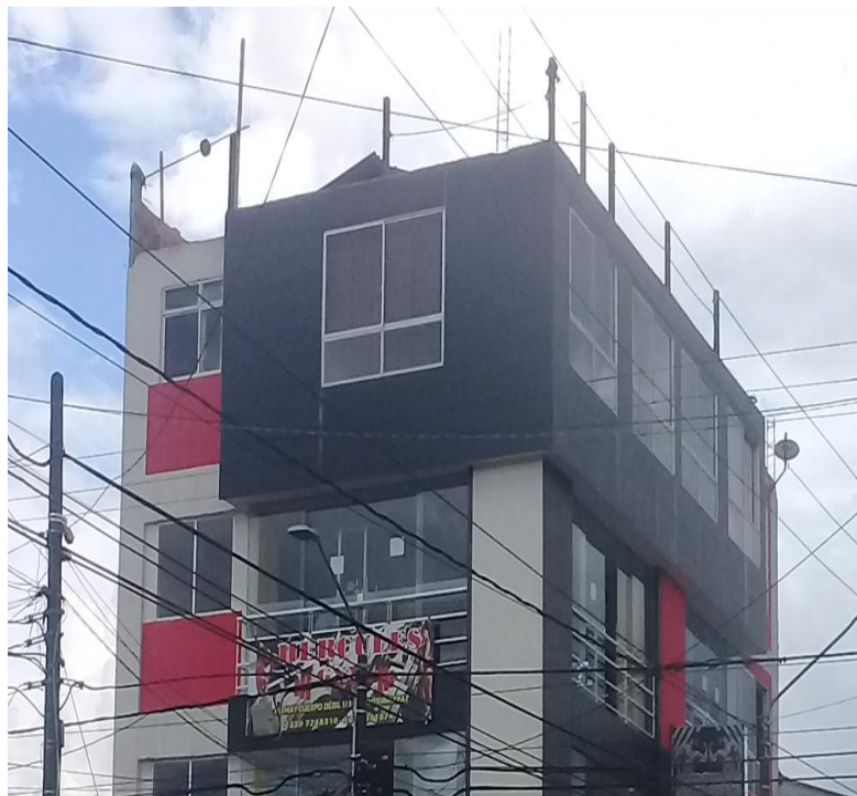
Figura 58. Edificio en proceso de demolición
