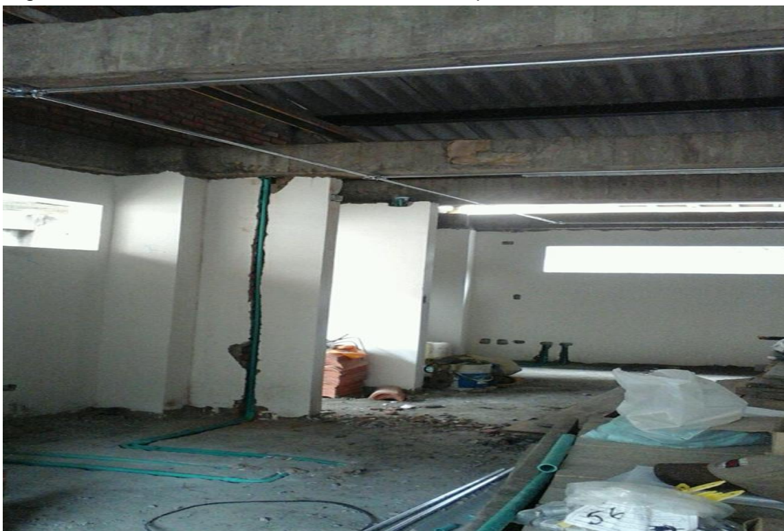
Fuente registro fotografico visitas a la obra
