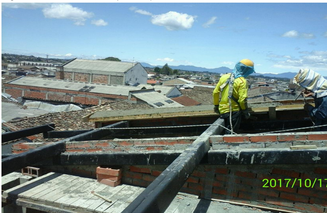
Fuente registro fotografico visitas a la obra
