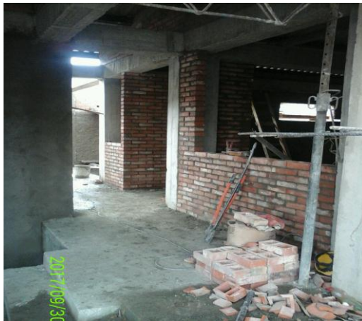
Pega de ladrillo estructural en bloque 1 nivel +6,00
