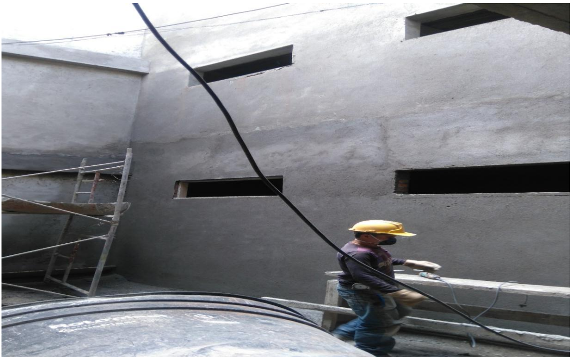
Fuente registro fotografico visitas a la obra
