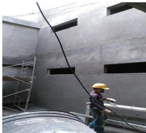
Repello de muros en bloque 1 nivel +0,00
