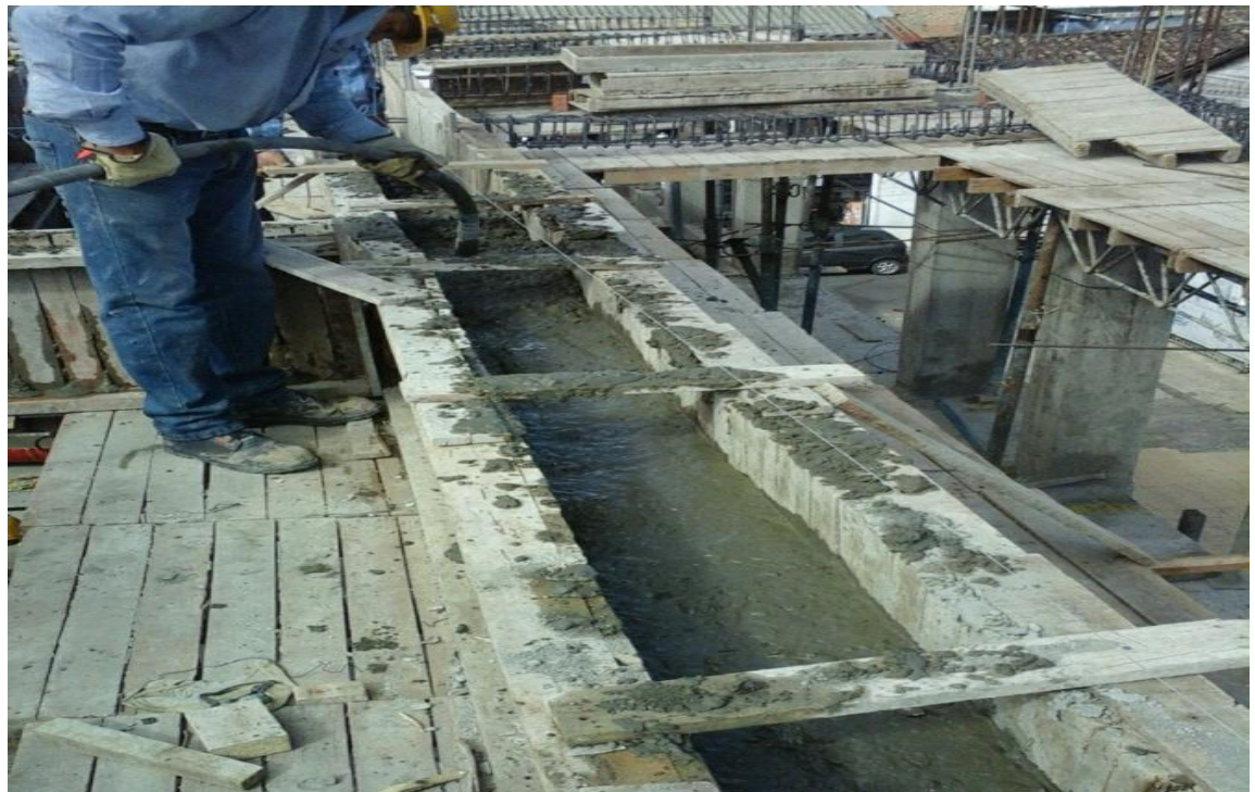
Figura 20: formaleta y vibrado vigas nivel 3
