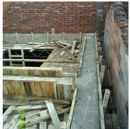
Vigas de amarre bloque 1 nivel +9,13
