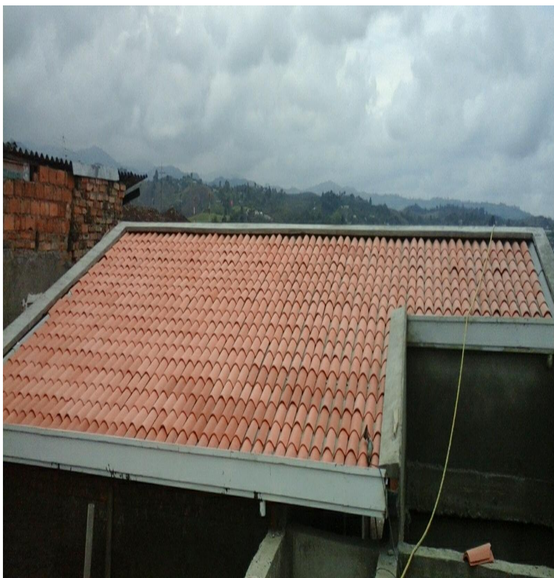
Figura 22: Instalacion de teja tubo bloque 1
