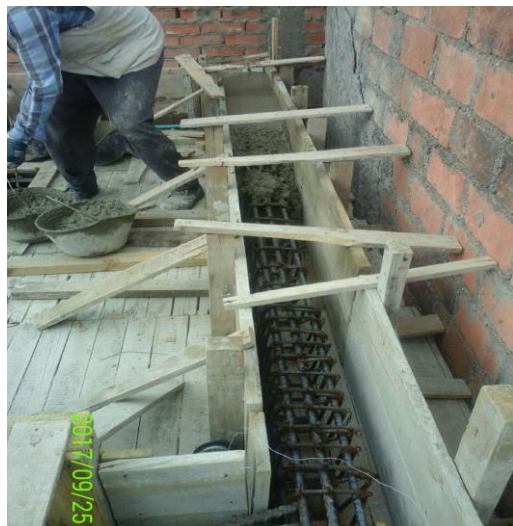
Fundicion de vigas de amarre bloque 2 nivel +9,13
