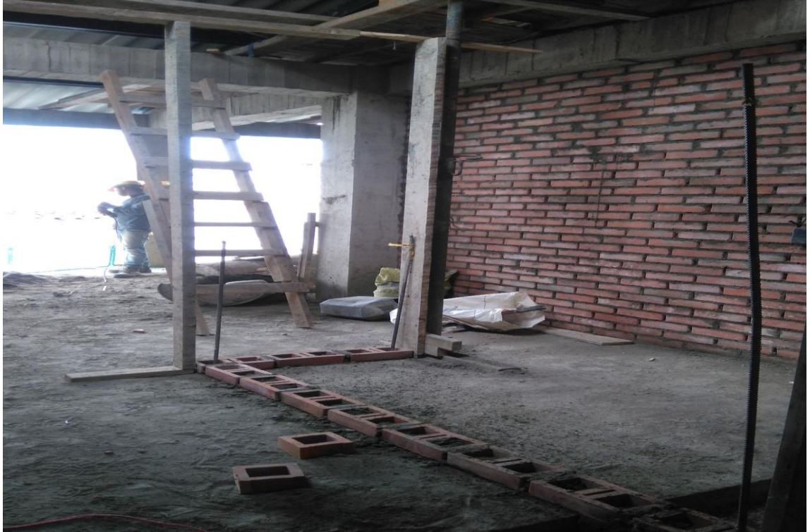
Fuente registro fotografico visitas a la obra
