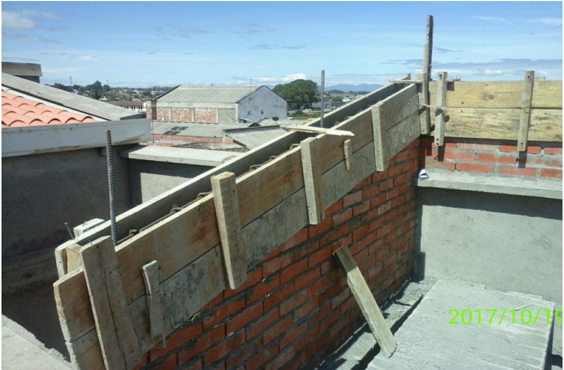
Fuente registro fotografico visitas a la obra
