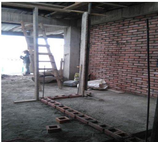
Pega de ladrillo estructural en bloque 2 nivel +6,00
