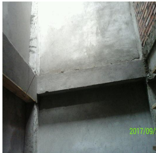
Repello de carteras en el bloque 1
