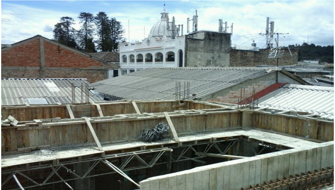
Figura 19: formaleta y vibrado vigas nivel 3
