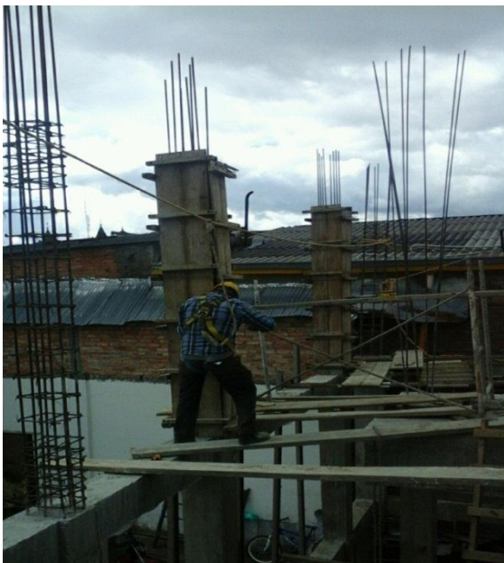
Figura 17: formaleta y fundicion de columnas.
