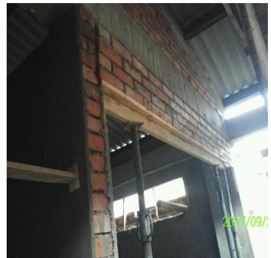
Dinteles en el bloque 1 nivel +6,00
