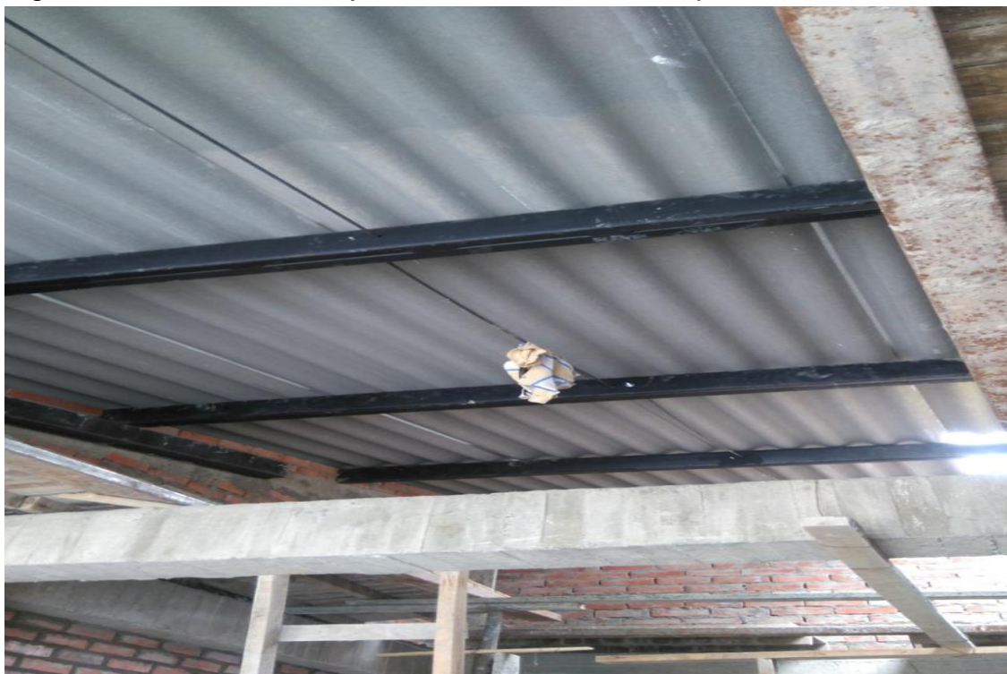
Fuente registro fotografico visitas a la obra
