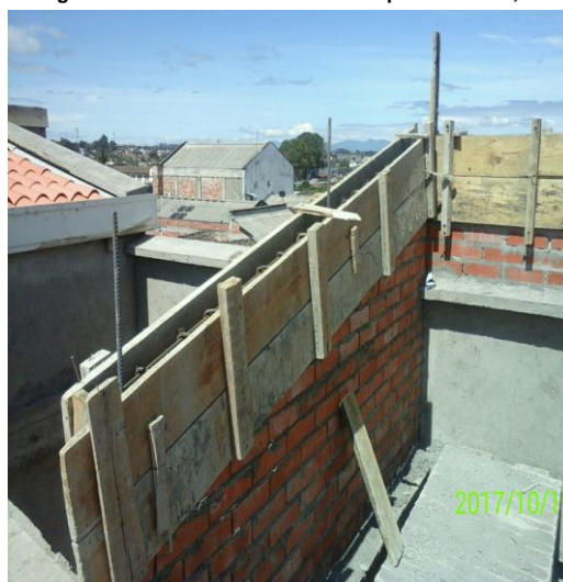
Formateado de vigas de culata bloque 1 nivel +9,13
