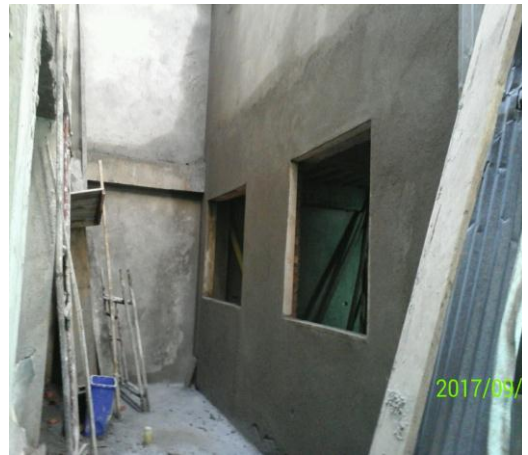
Repello de muros en bloque 1 nivel +0,00
