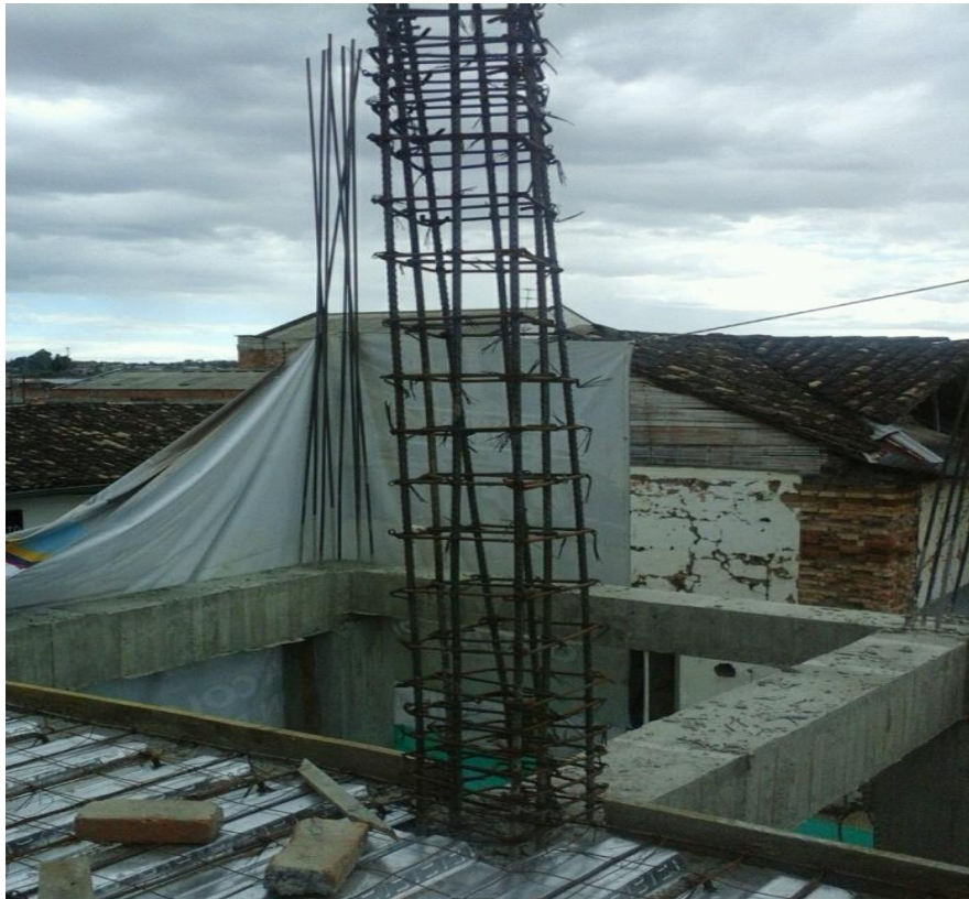
Figura 15: Armado de castillo de acero para columnas nivel 2 y 3.
