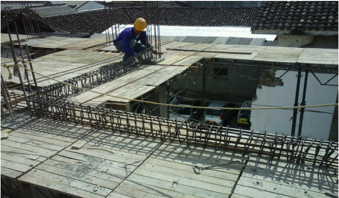
Figura 18: Armado de acero de vigas 2 nivel
