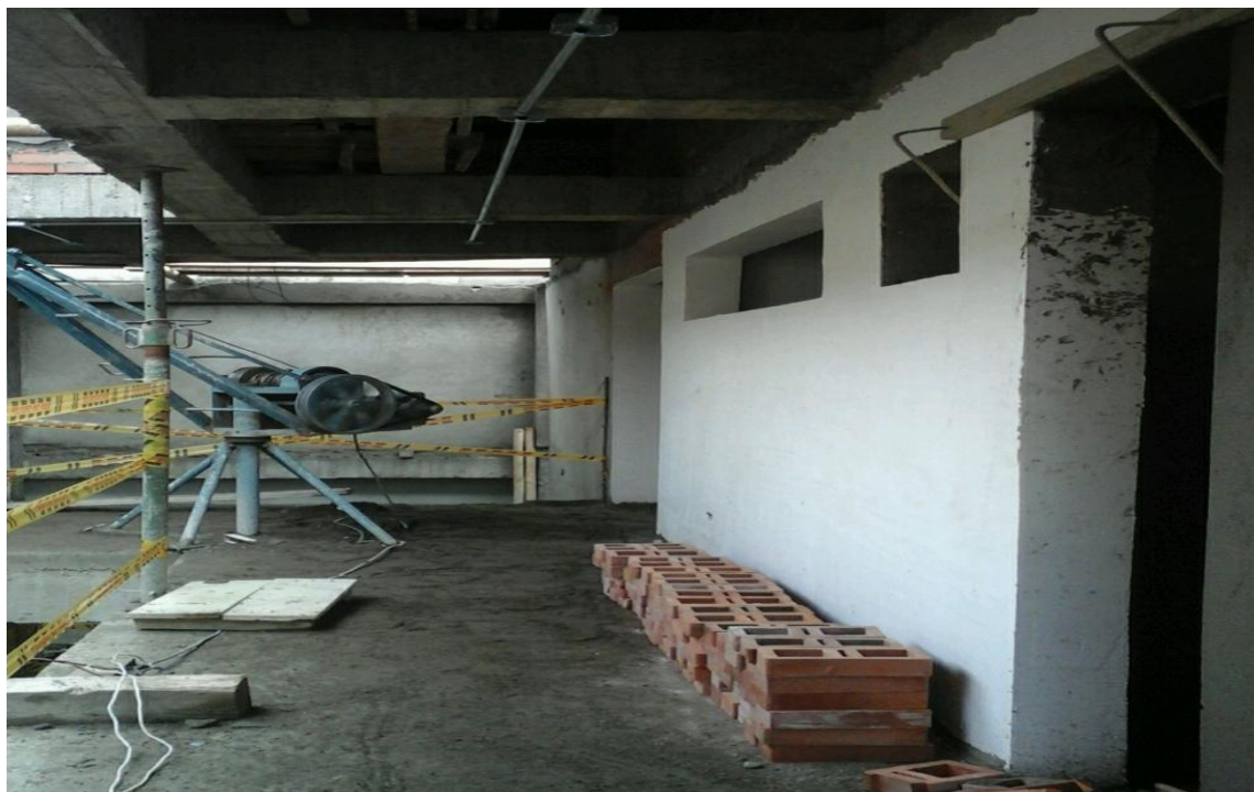
Fuente registro fotografico visitas a la obra
