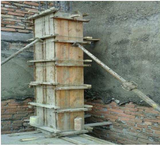
Figura 16: formaleta y fundicion de columnas.
