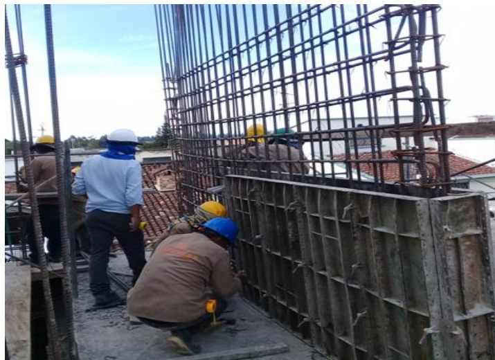
Figura 11: Colocación de formaleta para muro pantalla. (Fuente: Autor).
