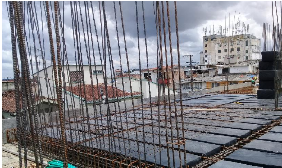
Figura 26: Armado de elementos para losa aligerada. (Fuente: Autor).
