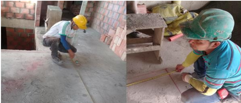
Figura 31: Replanteamiento y cimbrado de muros de mampostería. (Fuente: Autor).
