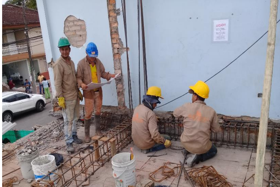
Figura 25: Armado de vigas sobre formaleta para losa de entrepiso. (Fuente: Autor).
