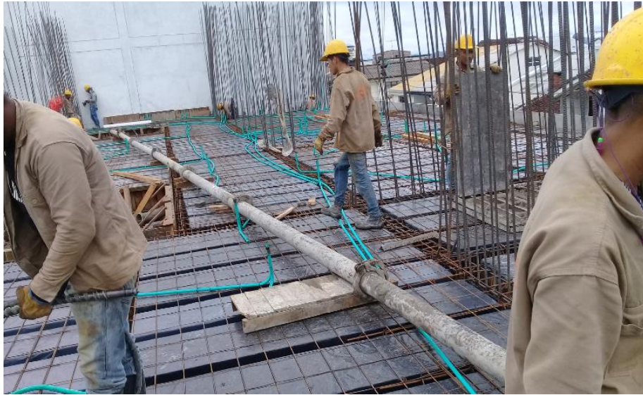
Figura 27: Losa aligerada lista para fundición. (Fuente: Autor).
