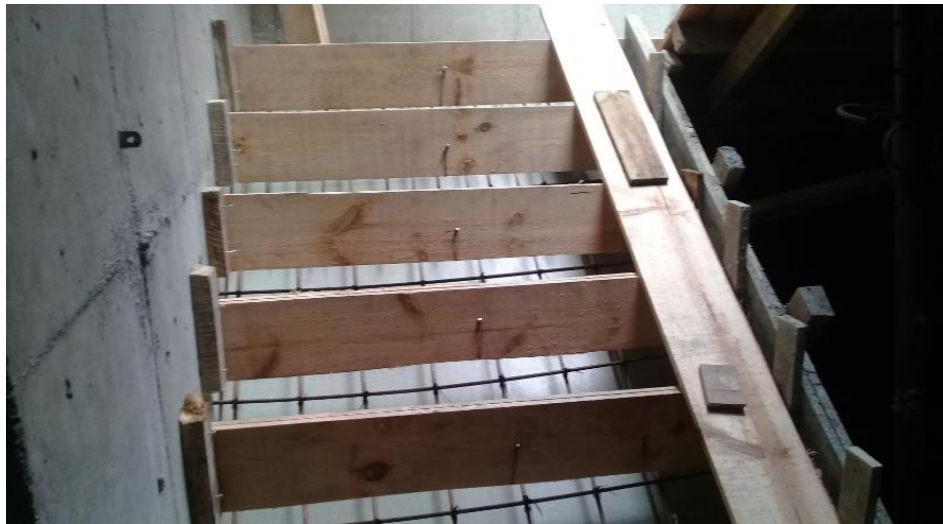
Figura 29: Formaleta para gradas o escaleras. (Fuente: Autor).
