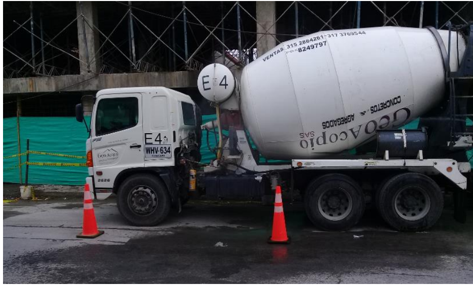
Figura 15: Mixer con concreto premezclado. (Fuente: Autor).
