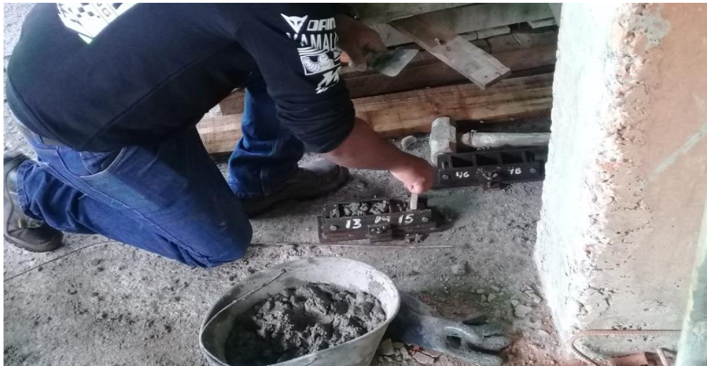
Figura 35: Muestras de mortero de pega para ensayos de resistencia. (Fuente: Autor).
