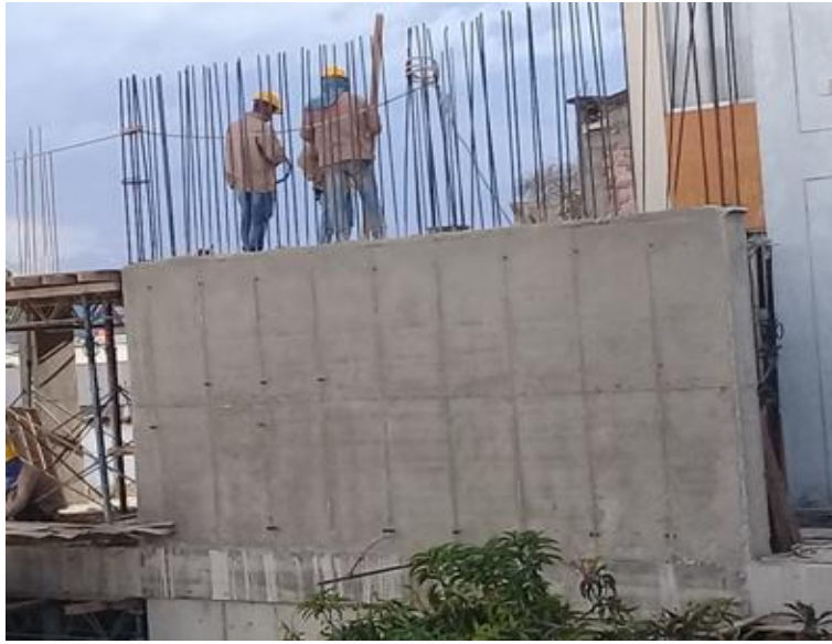
Figura 13: Desencofrado y terminación de muro pantalla. (Fuente: Autor).
