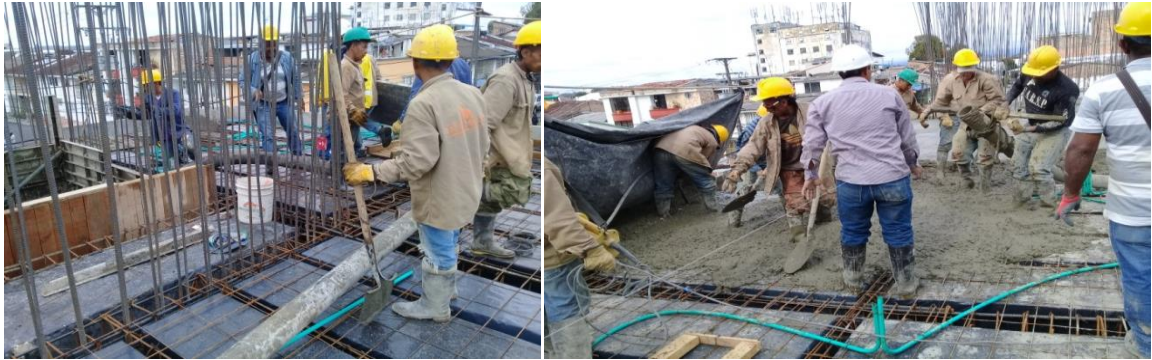
Figura 16: Vaciado y colocación del concreto en obra. (Fuente: Autor).
