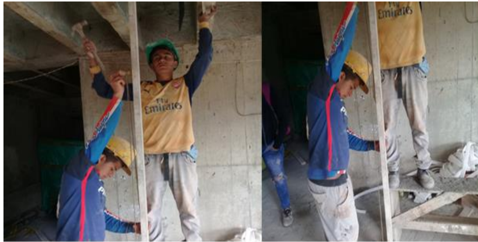
Figura 32: Instalación de codales aplomados para iniciar la pega de ladrillo sobre muros.
