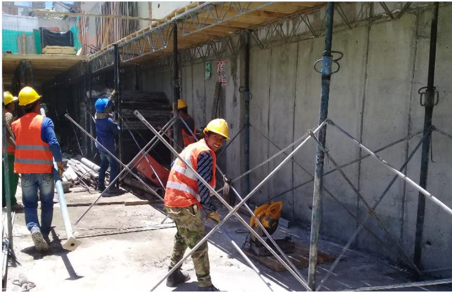
Figura 24: Instalación de formaleta para vigas y losa de entrepiso. (Fuente: GRACOL.SAS).
