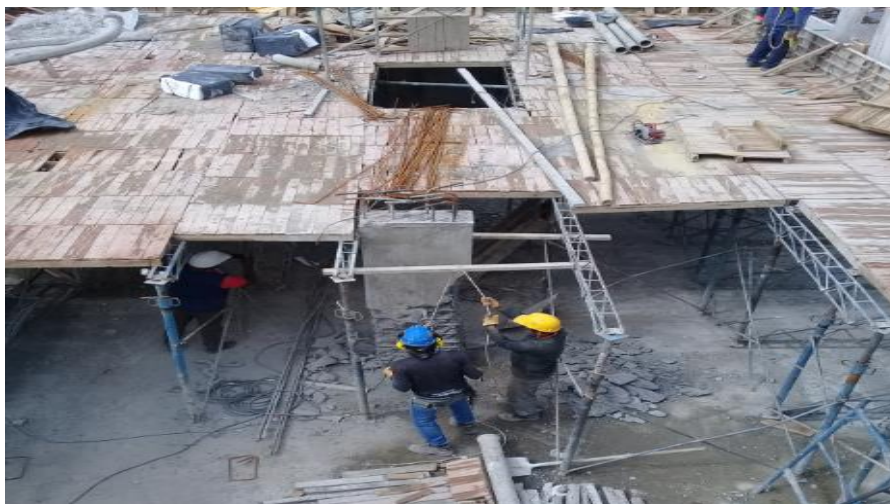
Figura 38: Demolición de columnas. (Fuente: Autor).
