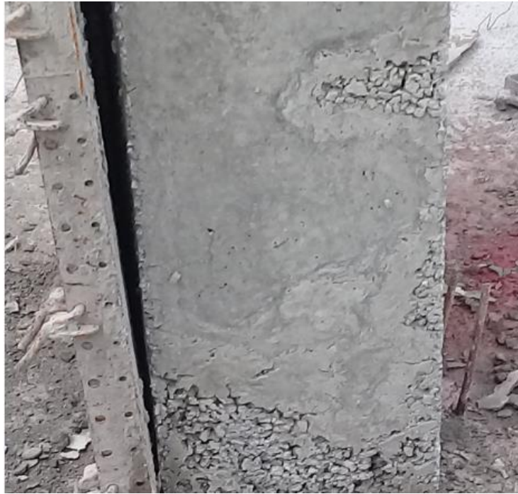
Figura 23: Columna con hormigueros. (Fuente: Autor).
