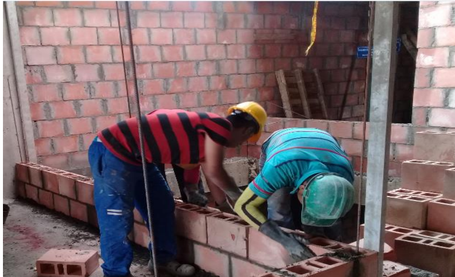
Figura 33: Pegado de ladrillo para muros de mampostería. (Fuente: Autor).
