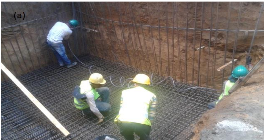
Figura 21: Paso de niveles manualmente (nivel con manguera). (Fuente: GRACOL.SAS).
