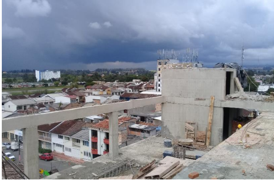
Figura 39: Piso # 6, con columnas demolidas. (Fuente: Autor).
