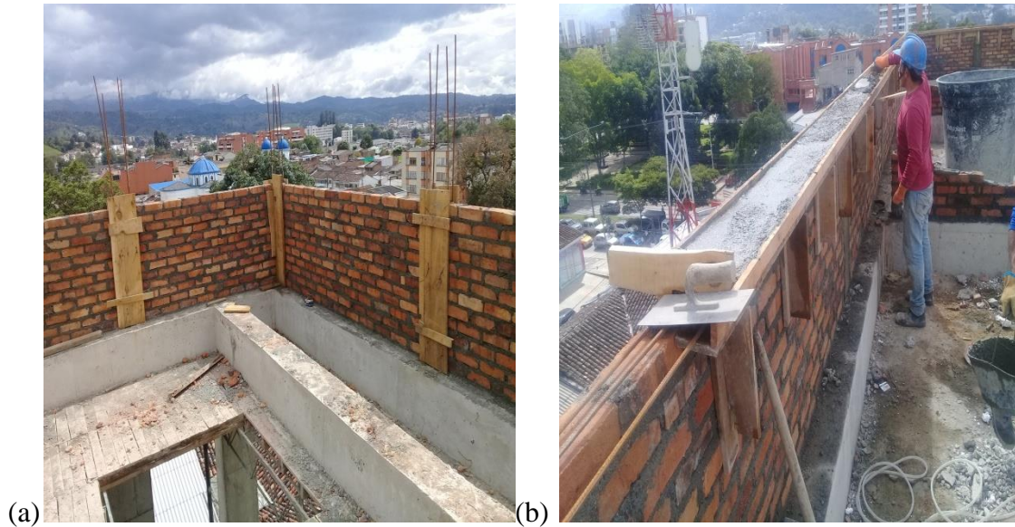
Figura 37: (a) Muros perimetrales y columnetas de confinamiento, (b) Alfajía. (Fuente: Autor).
