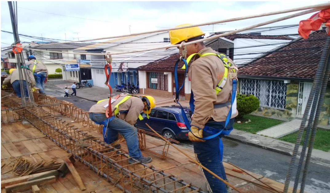
Figura 10: Colocación y amarre de aceros de vigas. (Fuente: Autor).
