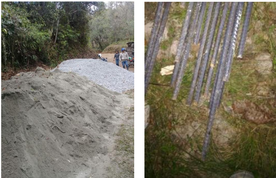
Ilustración 24. Suministro de material granular y aceros. Vereda Altamira.
