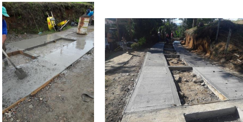
Ilustración 28. Fundición de placas huellas. Vereda Alto Cajete.
