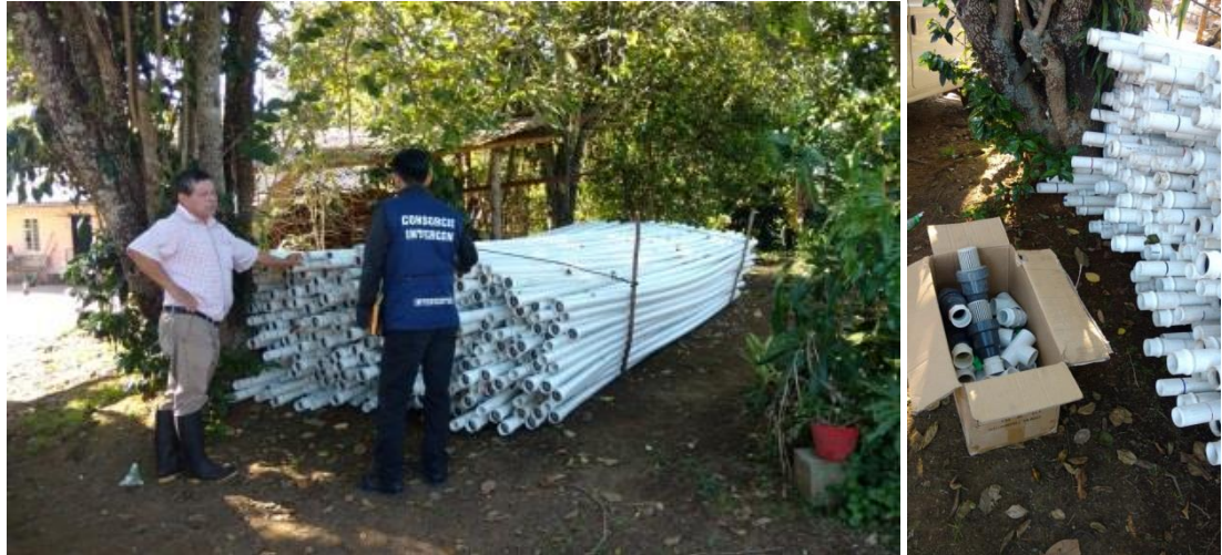
Ilustración 37. Tubos y aditamentos acueducto veredal. Vereda Los Llanos.
