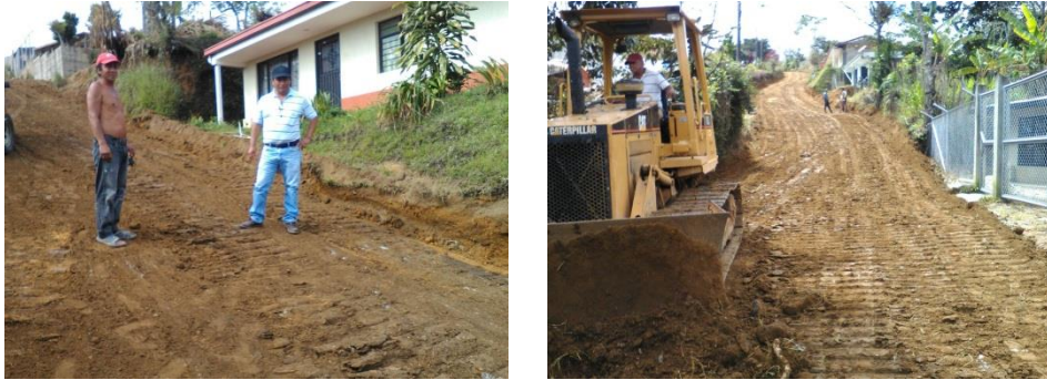
Ilustración 30. Retiro de la capa vegetal. Vereda Alto Puelenje.
