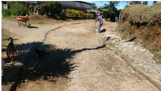
Ilustración 26. Localización y replanteo. Vereda Alto Cajete.
