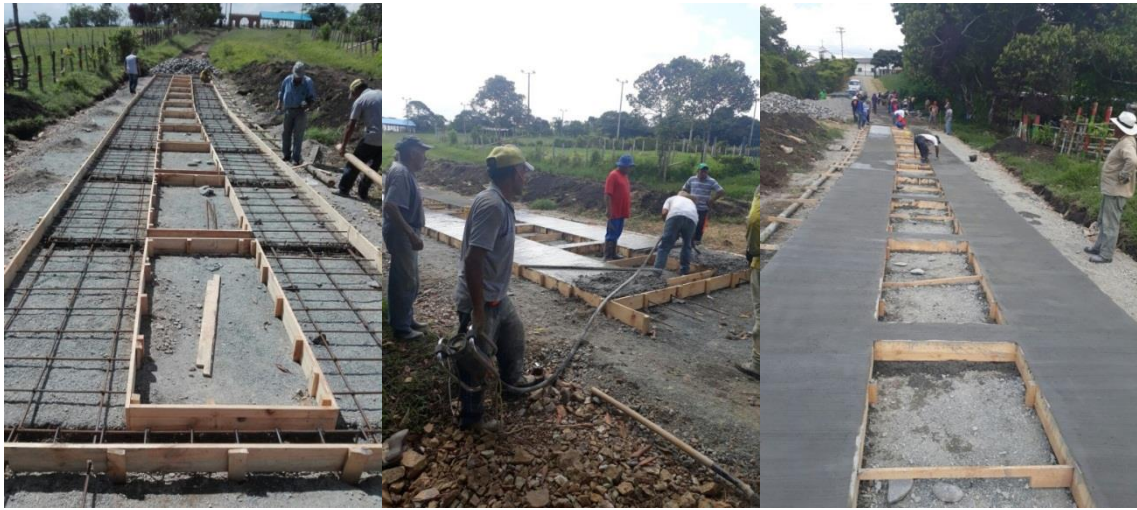
Ilustración 35. Fundición de la losa de Placa Huella in situ . Vereda Julumito.
