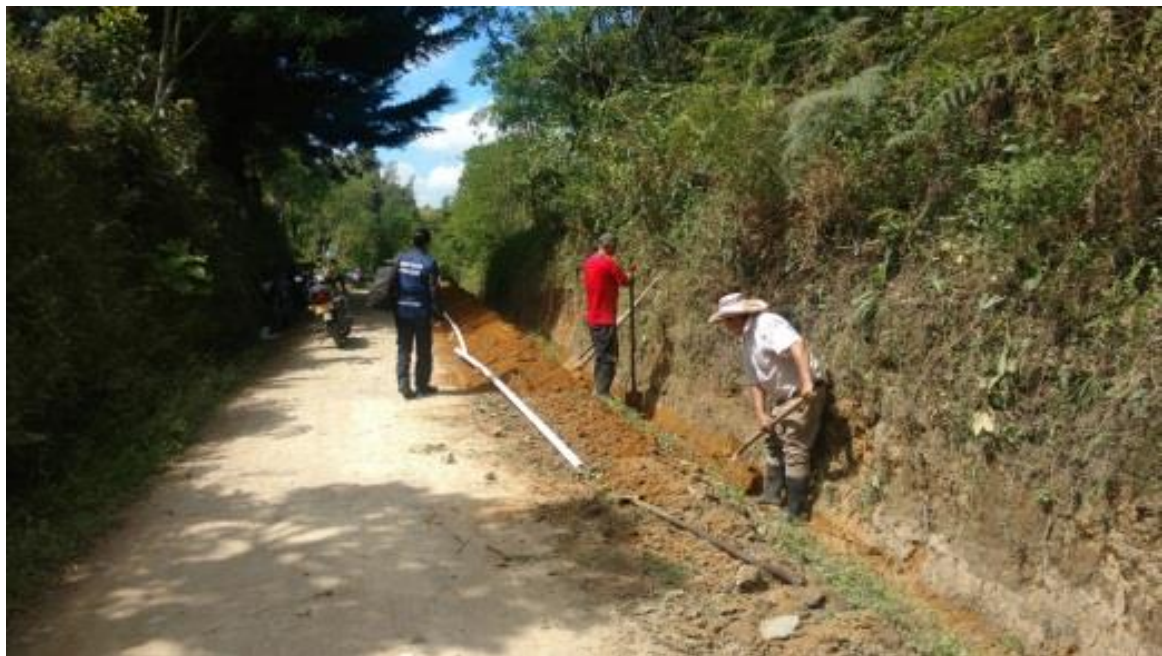
Ilustración 38. Mantenimiento del acueducto veredal. Vereda Los Llanos.
