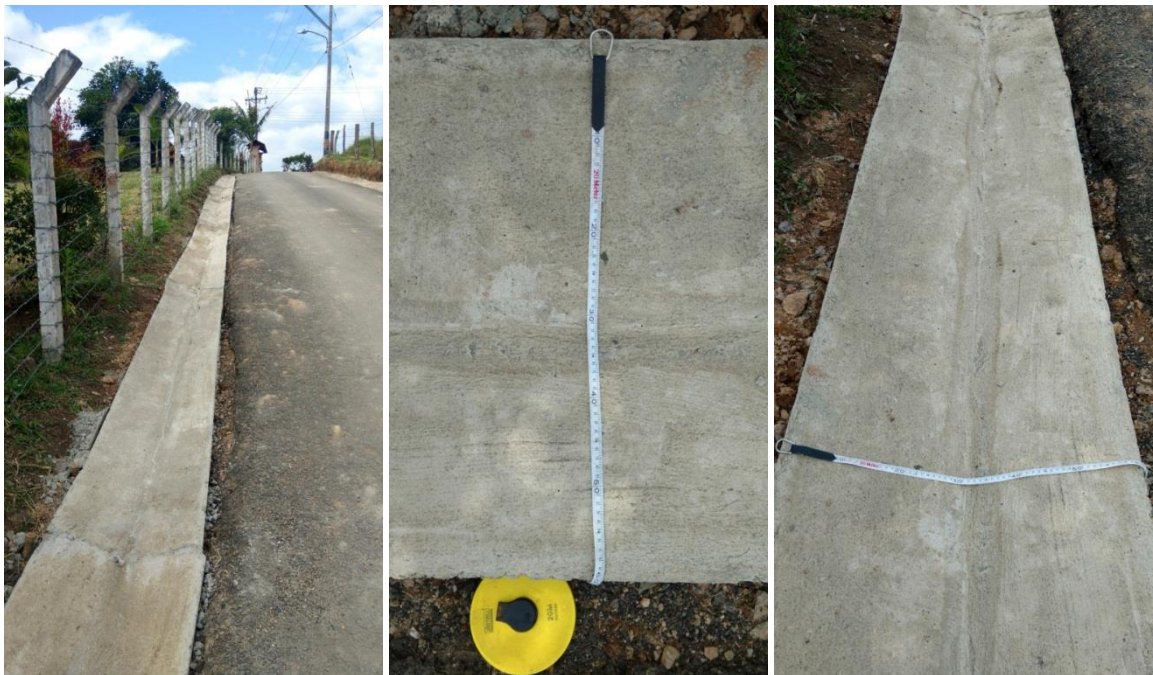
Ilustración 36. Cuneta. Vereda Las Vegas.
