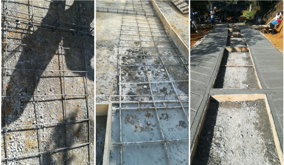
Ilustración 32. Aceros de refuerzo y colocación de concreto. Vereda Bajo Cauca.
