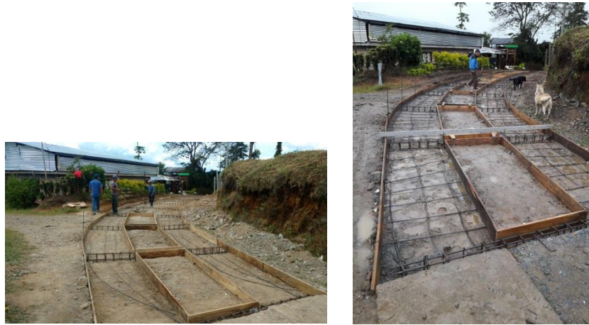
Ilustración 27. Colocación del acero de refuerzo. Vereda Alto Cajete.
