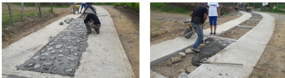
Ilustración 29. Colocación del concreto ciclópeo in situ . Vereda Alto Cajete.
