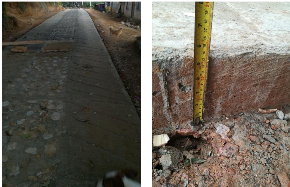
Ilustración 34. Espesor de Placa Huella. Vereda Clarete.
