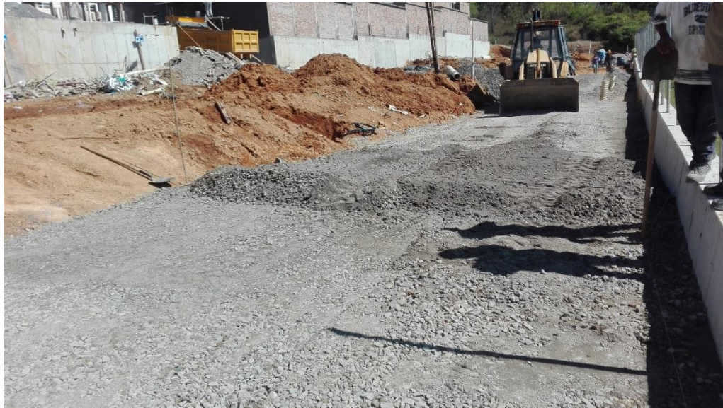
Fotografía 19: Extendido del material de subbase. Fuente: Tomada por Jhon Edison Ordoñez
