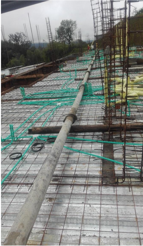
Fotografía 10: Refuerzo de la losa de entepiso. Fuente: Tomada por Jhon Edison Ordoñez
