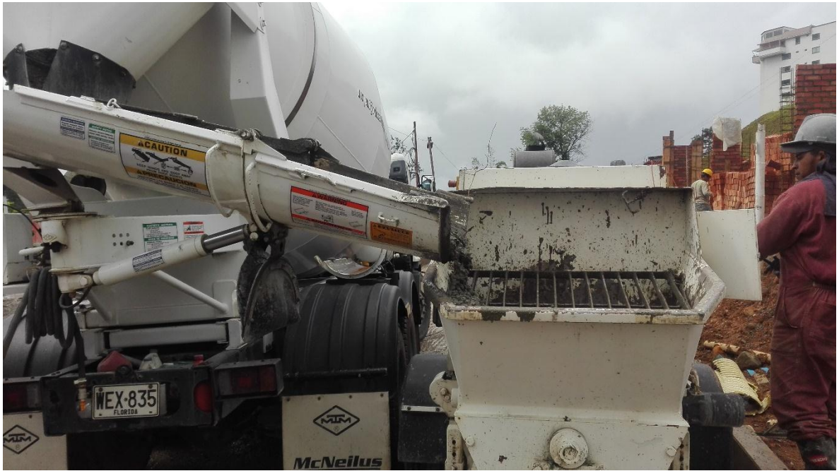
Fotografía 11: Descargue de concreto en la motobomba. Fuente: Tomada por Jhon Edison Ordoñez
