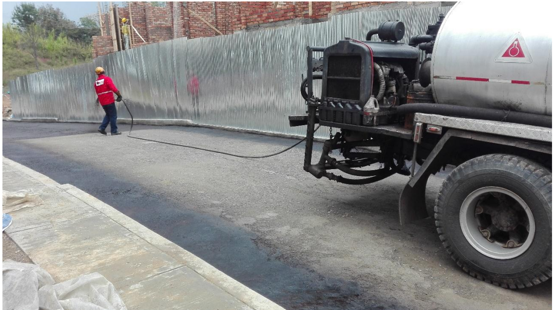
Fotografía 23: Proceso de imprimación. Fuente: Tomada por Jhon Edison Ordoñez
