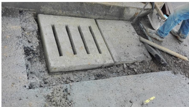
Fotografía 29: Terminación del sumidero. Fuente: Tomada por Jhon Edison Ordoñez
