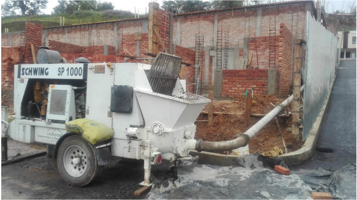
Fotografía 8: Montaje de la motobomba. Fuente: Tomada por Jhon Edison Ordoñez
