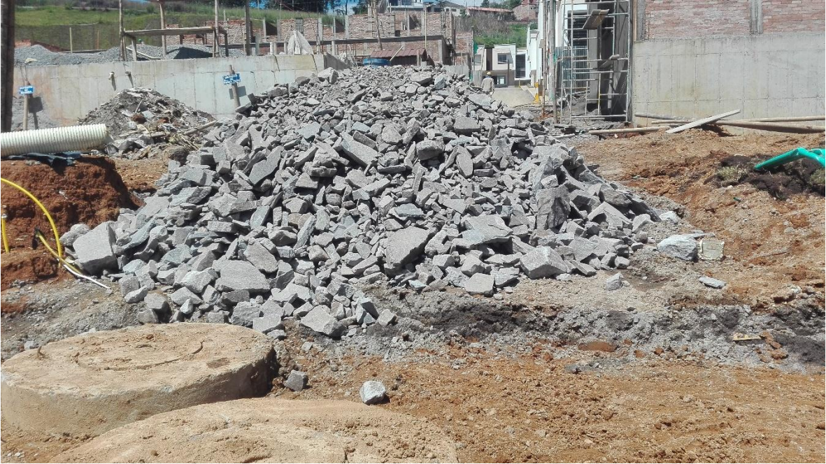
Fotografía 18: Material de mejoramiento. Fuente: Tomada por Jhon Edison Ordoñez
