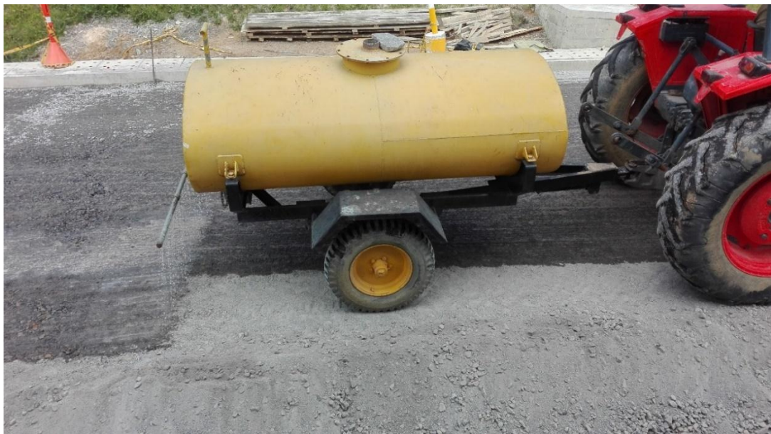
Fotografía 22: Proceso de humectación para compactar. Fuente: Tomada por Jhon Edison Ordoñez
