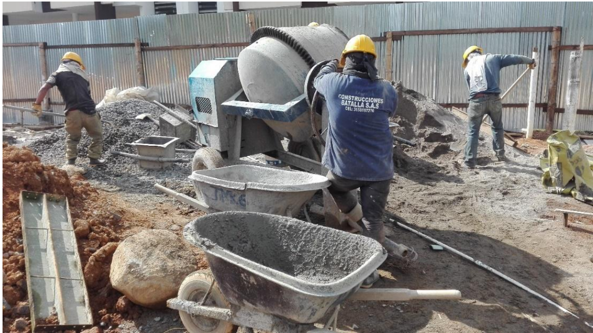
Fotografía 5: Preparación de concreto para fundir columnas. Fuente: Tomada por Jhon Edison Ordoñez
