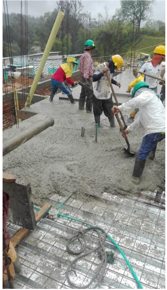
Fotografía 9: Fundición losa de entepiso. Fuente: Tomada por Jhon Edison Ordoñez
