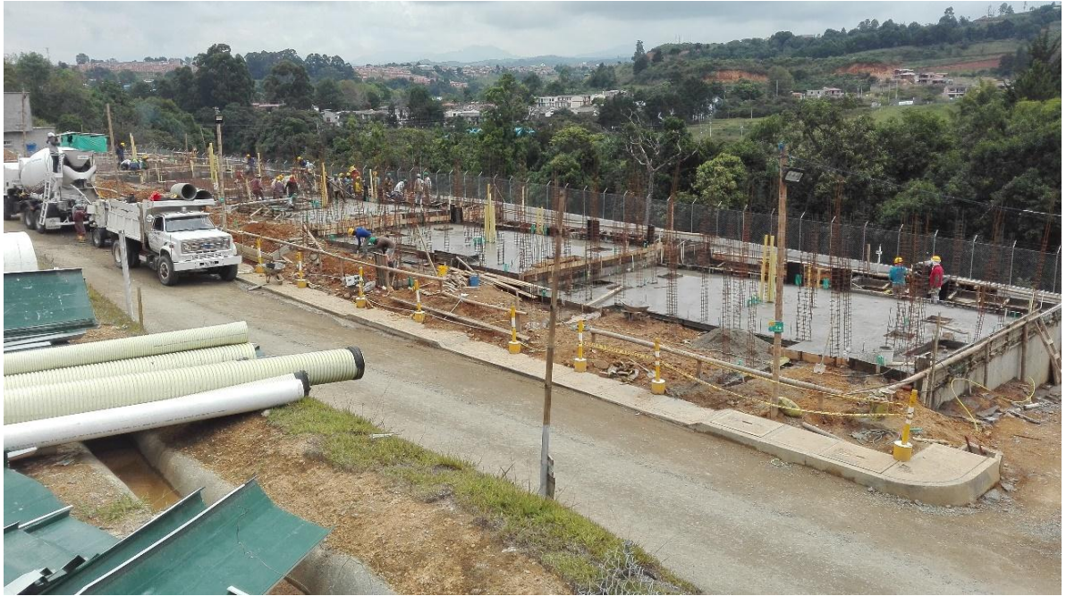
Fotografía 3: Fundición de la losa de cimentación. Fuente: Tomada por Jhon Edison Ordoñez
