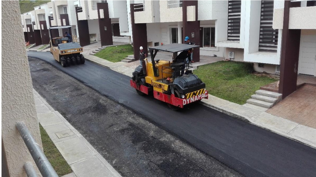
Fotografía 25: Compactación de la capa asfáltica. Fuente: Tomada por Jhon Edison Ordoñez
