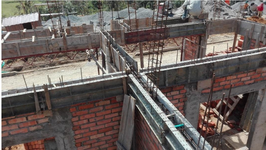
Fotografía 6: Refuerzo losa de entresuelo. Fuente: Tomada por Jhon Edison Ordoñez
