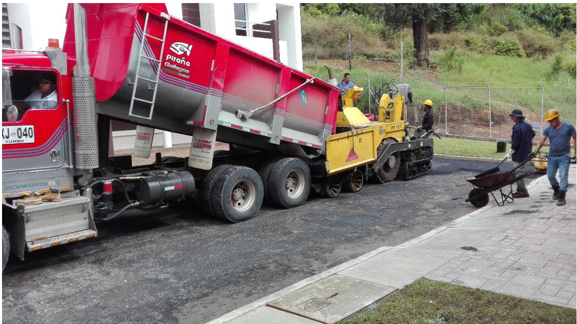
Fotografía 24: Deposito del cemento asfáltico en la Finisher. Fuente: Tomada por Jhon Edison Ordoñez
