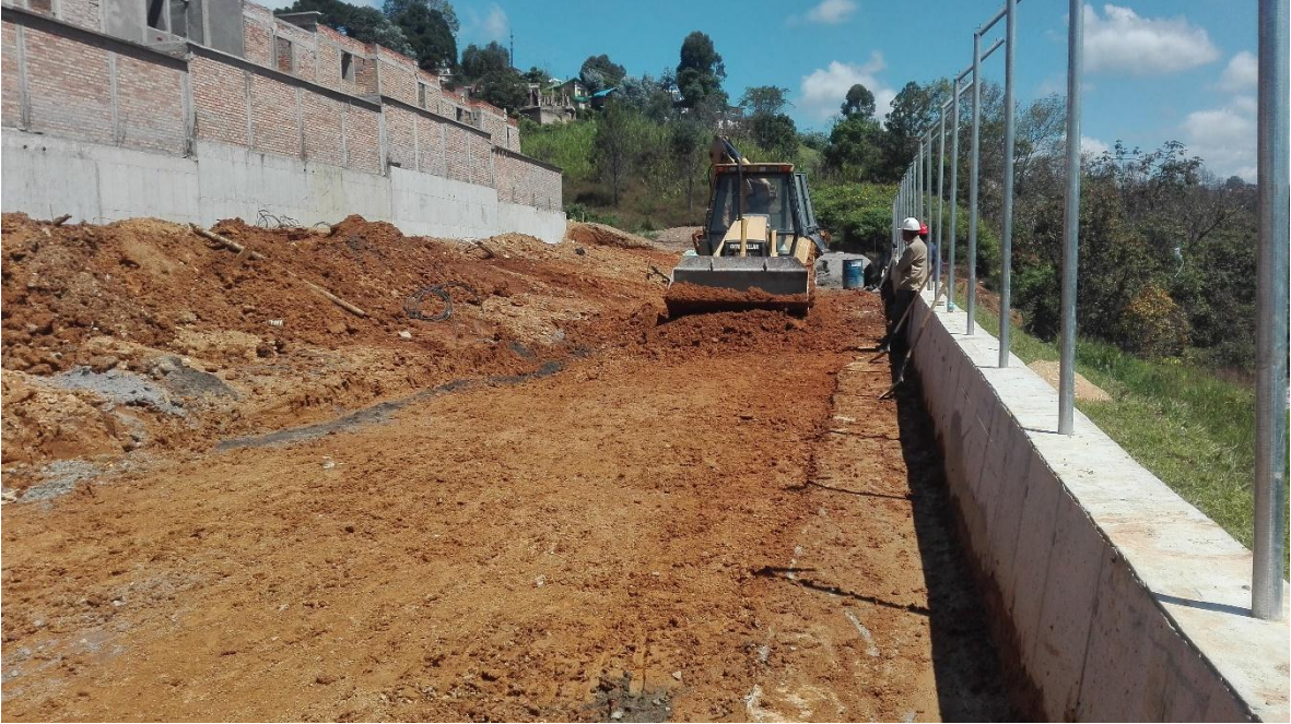
Fotografía 17: Nivelación de la subrasante. Fuente: Tomada por Jhon Edison Ordoñez
