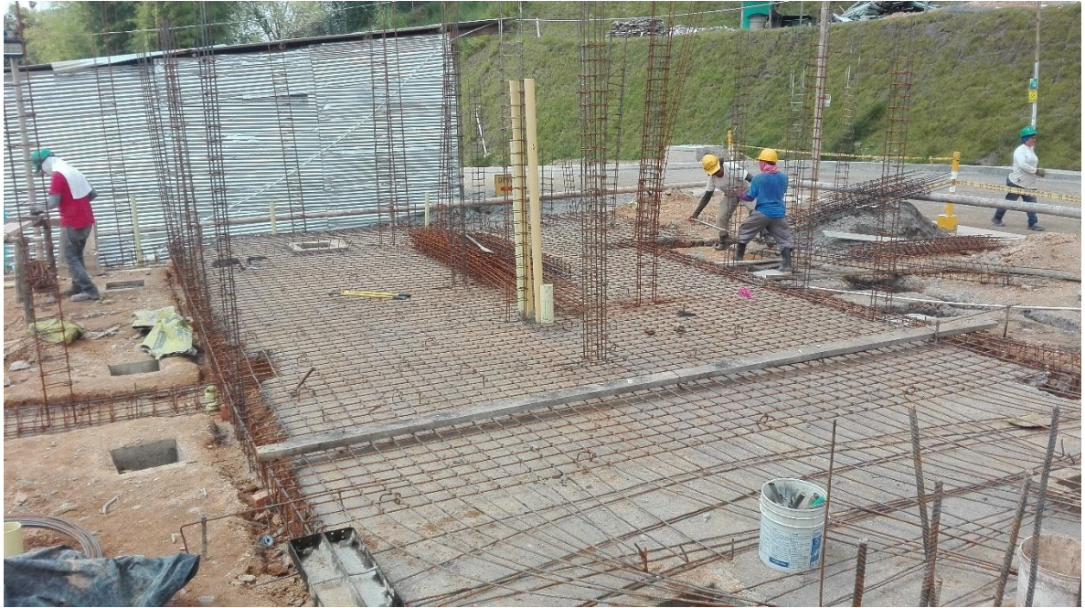
Fotografía 2: Armado del refuerzo losa de cimentación. Fuente: Tomada por Jhon Edison Ordoñez
