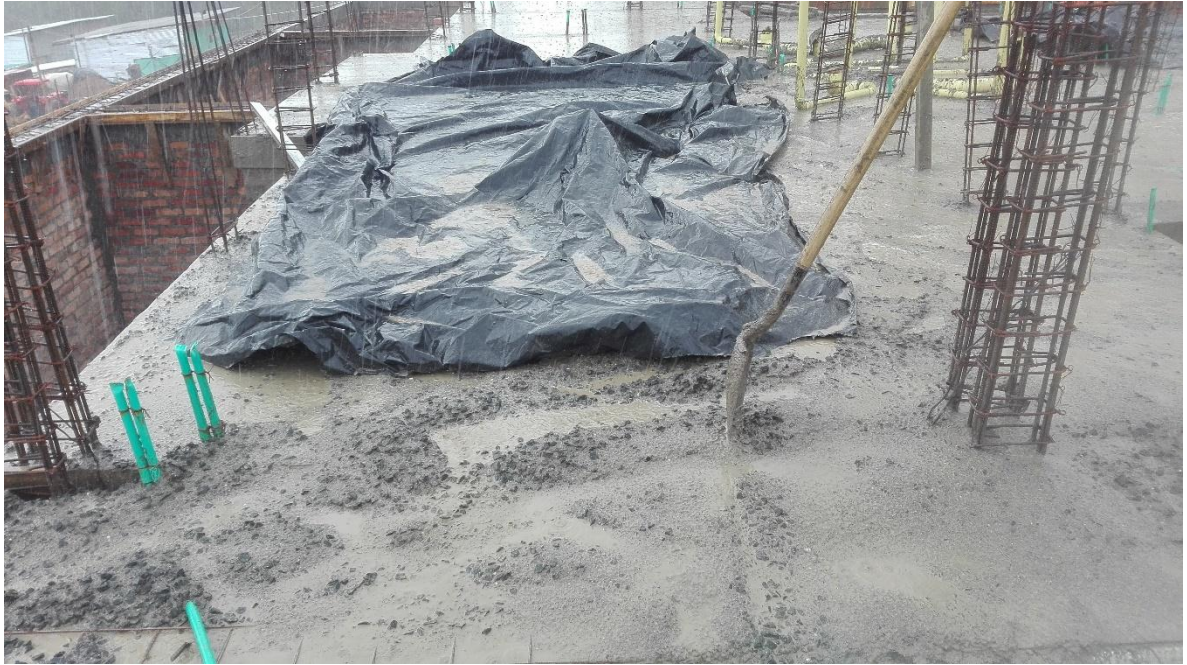
Fotografía 31: Precipitación en fundición de losa de entrepiso. Fuente: Tomada por Jhon Edison Ordoñez
