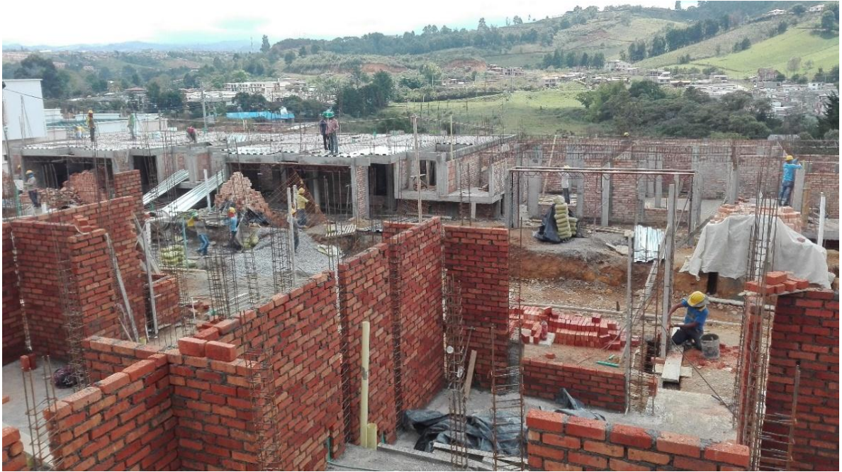
Fotografía 4: Mampostería primer piso. Fuente: Tomada por Jhon Edison Ordoñez
