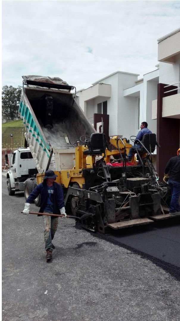
Fotografía 27: Extendido del cemento asfáltico. Fuente: Tomada por Jhon Edison Ordoñez
