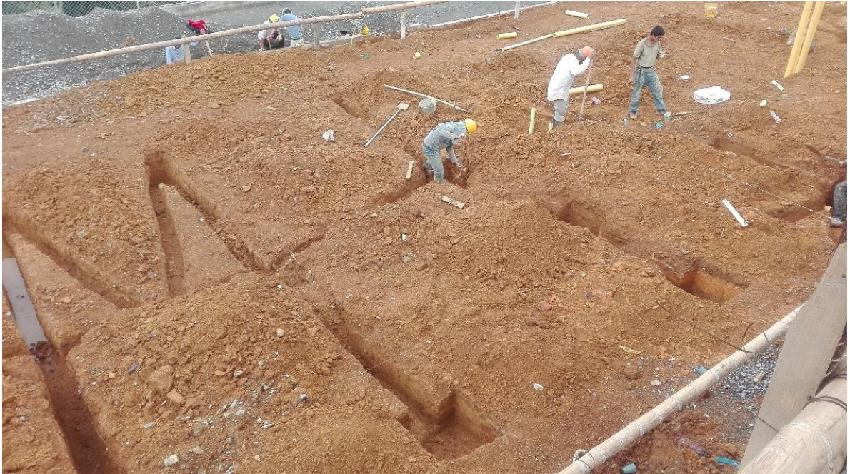
Fotografía 1: Instalación de tuberías sanitarias. Fuente: Tomada por Jhon Edison Ordoñez
