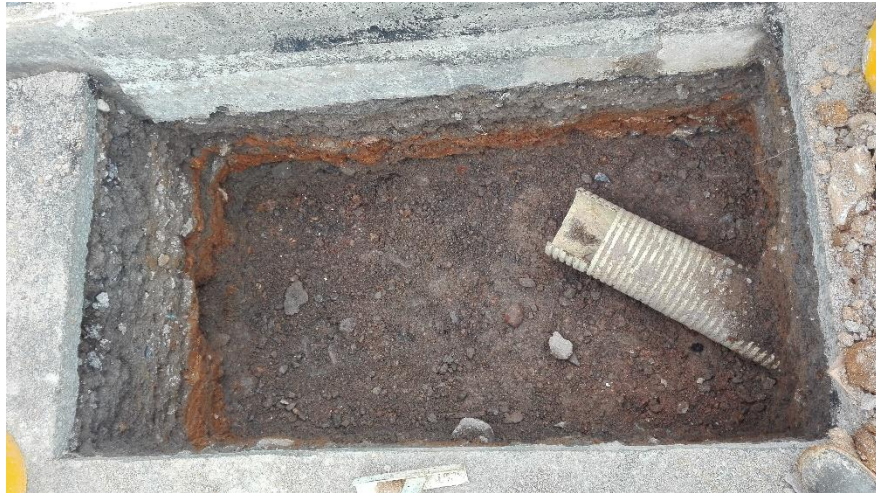
Fotografía 28: Excavación para el sumidero. Fuente: Tomada por Jhon Edison Ordoñez
