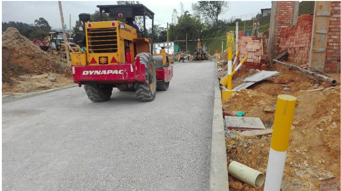
Fotografía 21: Extendido y compactación del material de base. Fuente: Tomada por Jhon Edison Ordoñez
