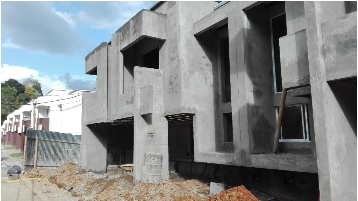
Fotografía 12: Repello fachada. Fuente: Tomada por Jhon Edison Ordoñez
