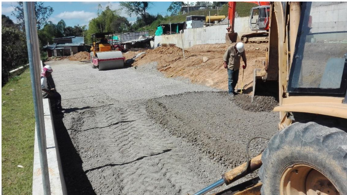
Fotografía 20: Nivelación y compactación del material de subbase. Fuente: Tomada por Jhon Edison Ordoñez
