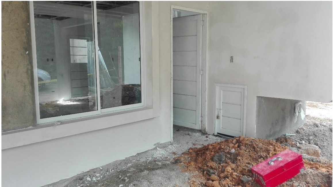
Fotografía 15: Estuco fachada. Fuente: Tomada por Jhon Edison Ordoñez
