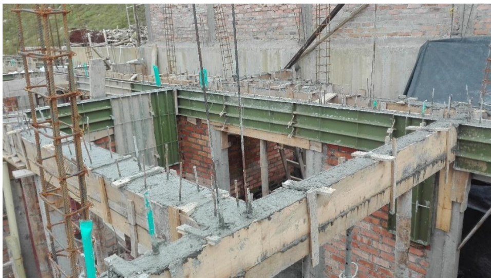
Fotografía 7: Fundición de las vigas de entresuelo. Fuente: tomada por Jhon Edison Ordoñez
