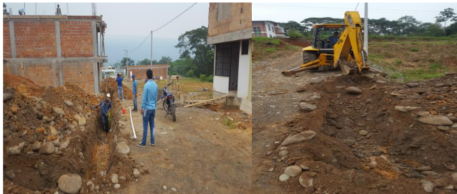
Figura 46. Instalación de red de acueducto y acometidas.
