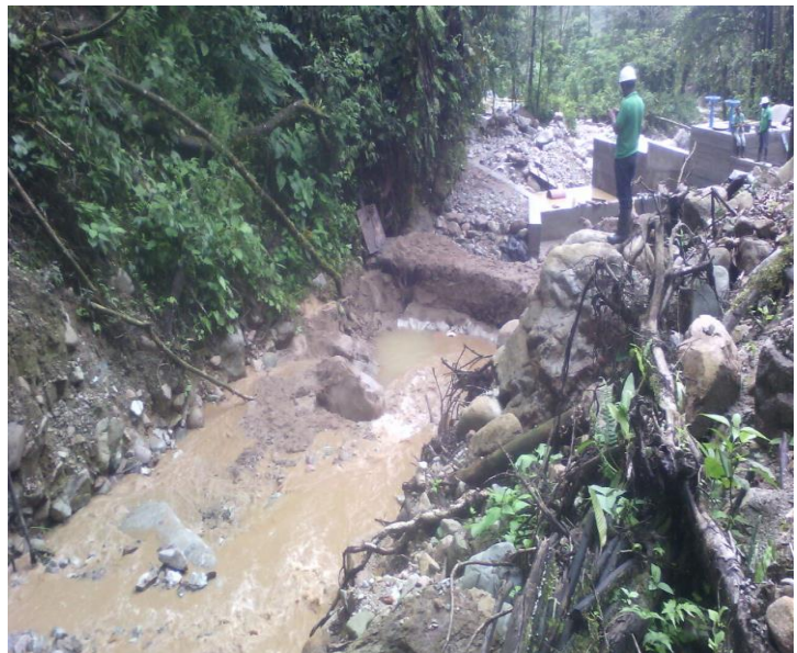
Figura 36. Crecida de la fuente, taponamiento de bocatoma provisional.
