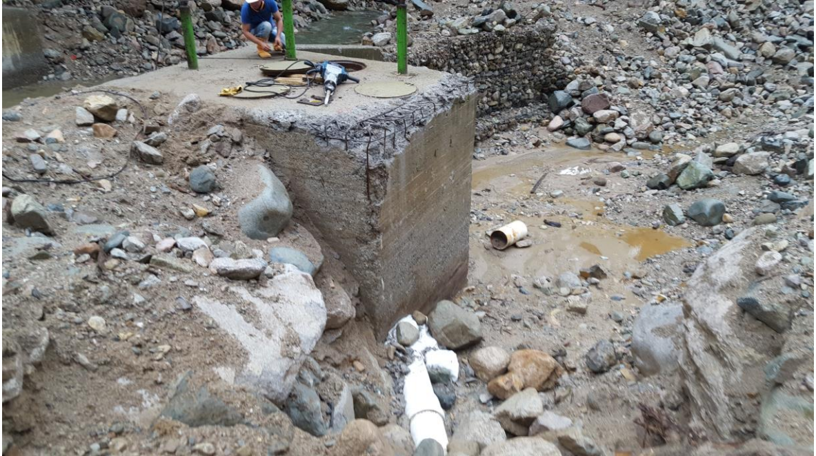
Figura 28. Ampliación del tanque de captación.
