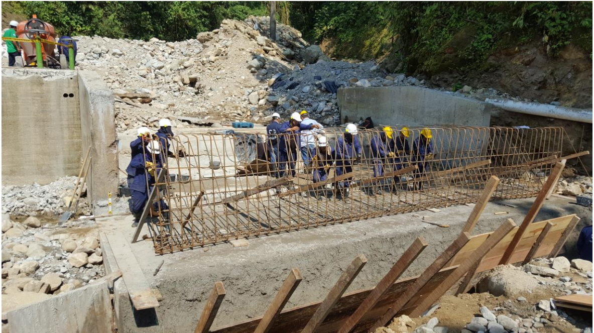
Figura 29. Armadura de dentellón para bocatoma.
