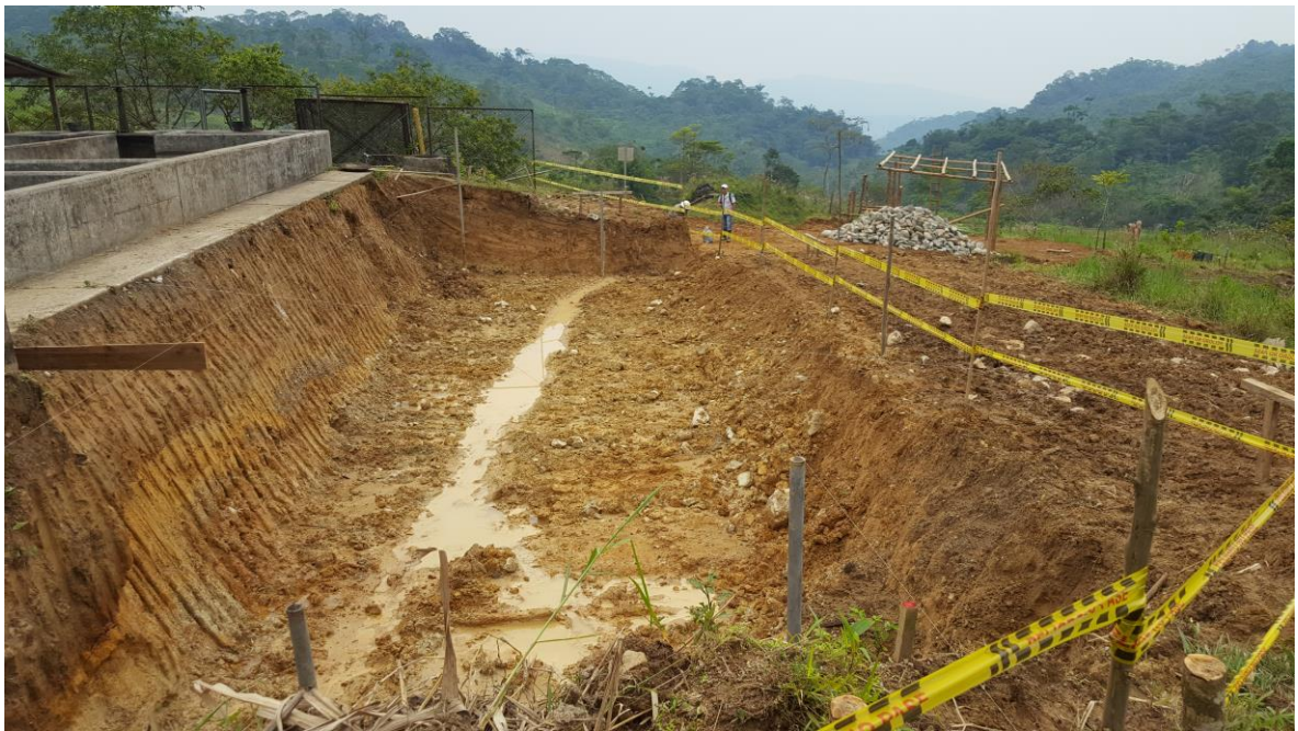
Figura 23. Excavación desarenador.
