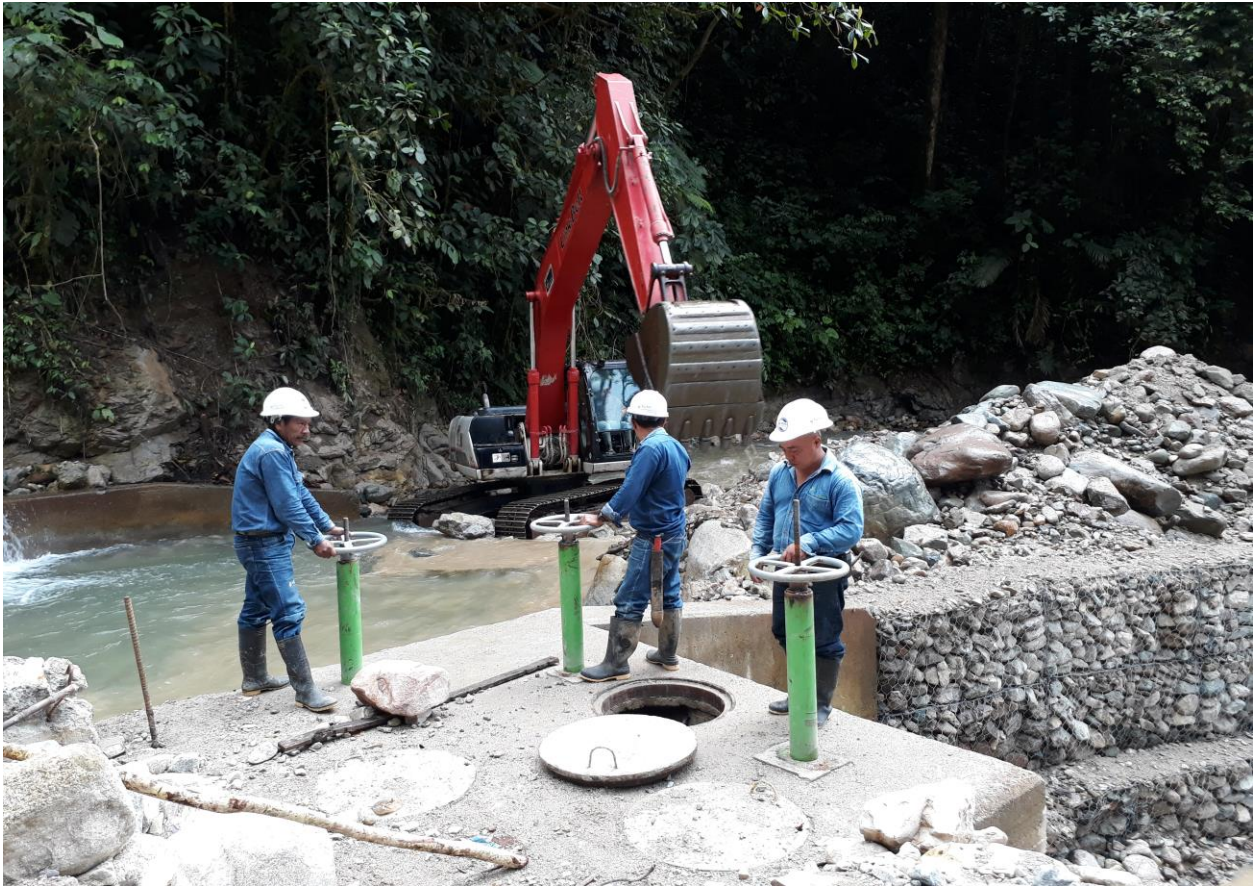
Figura 2. Mantenimiento de bocatoma antes de la avalancha.
