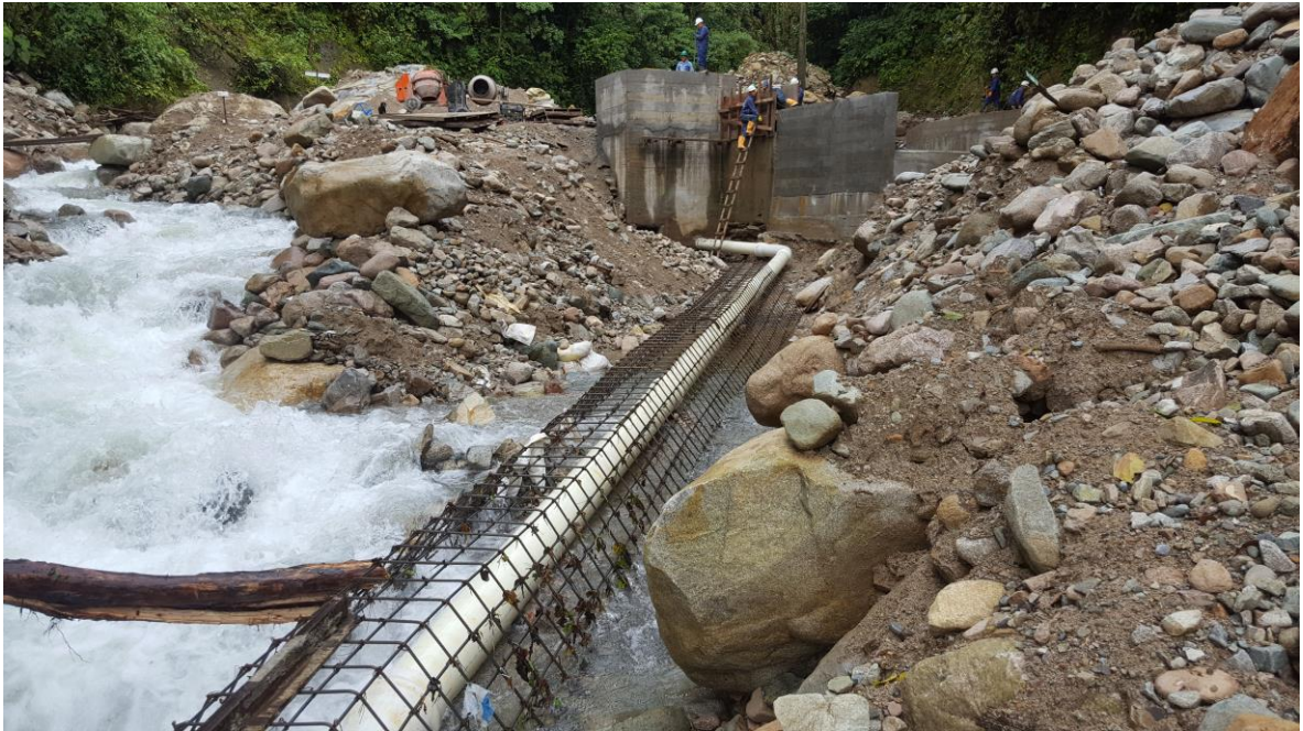
Figura 34. Estructura de protección a la línea de aducción.
