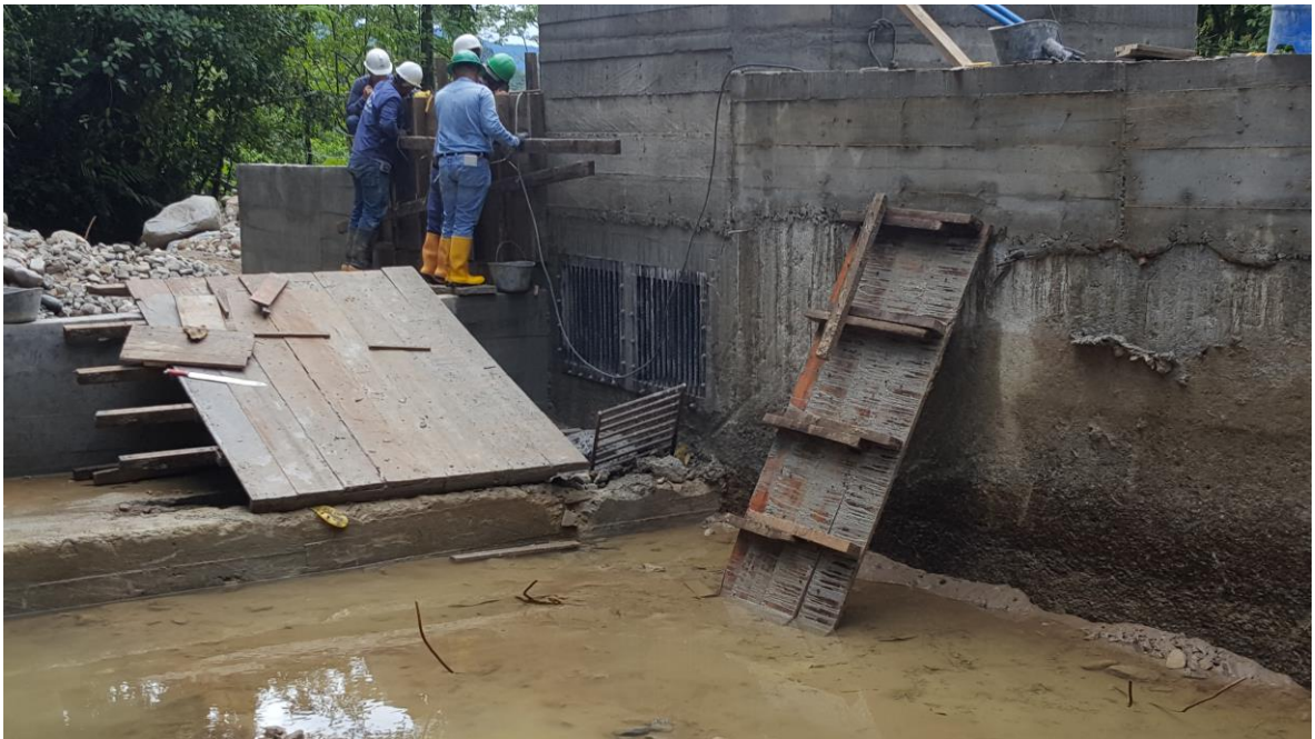
Figura 33. Instalación de rejillas de captación y ampliación de tanque
