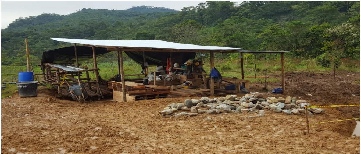
Figura 21. Campamento provisional frente de obra desarenador.
