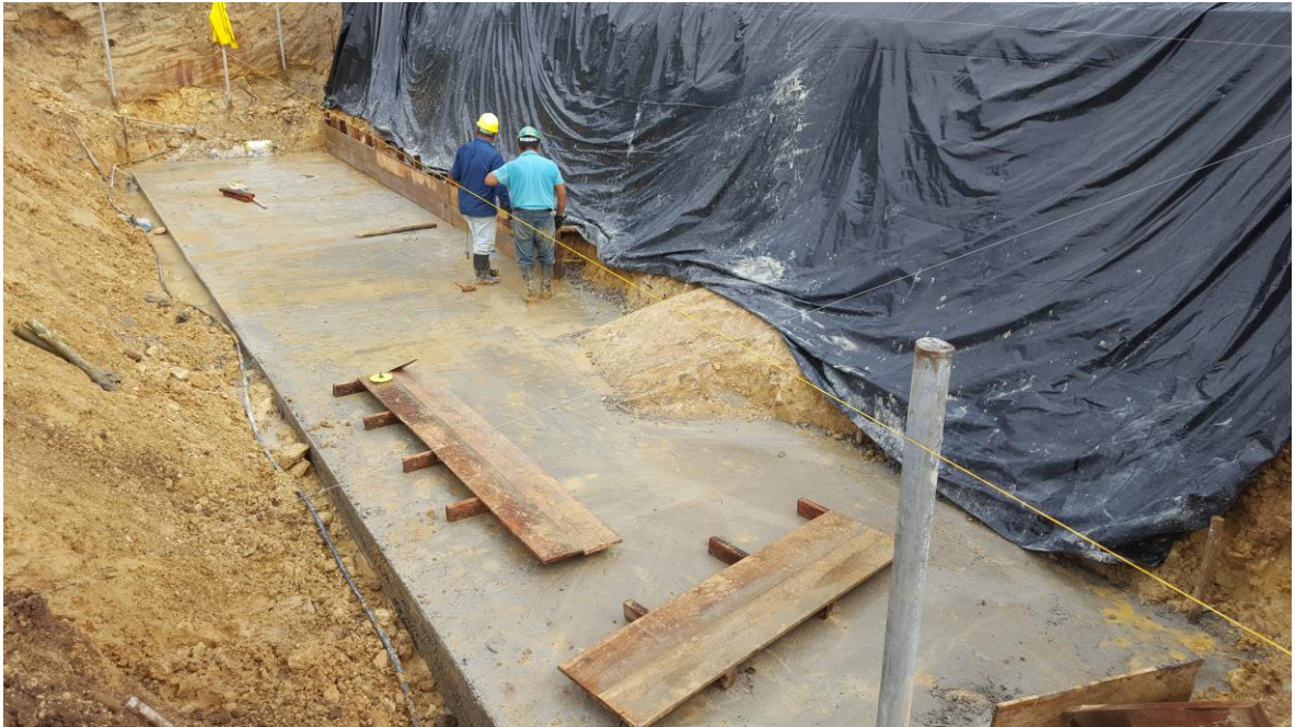
Figura 24. Fundición de mejoramiento de suelo para desarenador.
