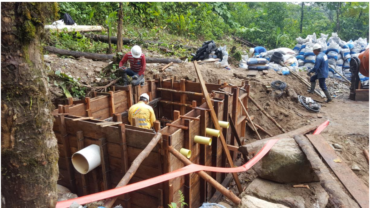
Figura 14. Formaleta del tanque de derivación provisional.
