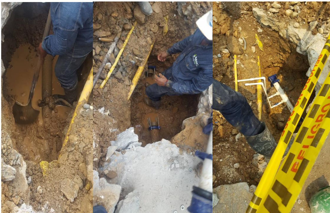
Figura 44. Collage reparación de fuga de agua potable.
