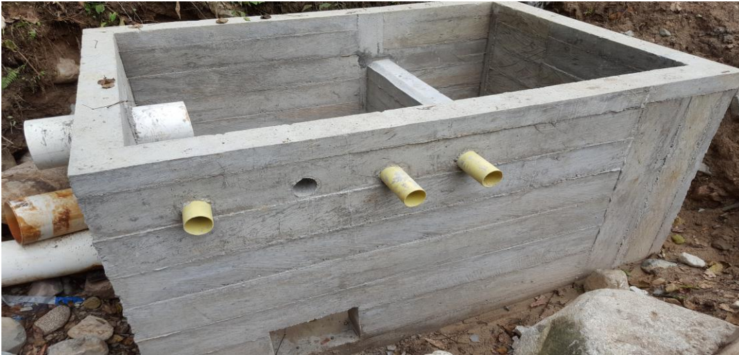
Figura 16. Tanque de derivación provisional desencofrado.
