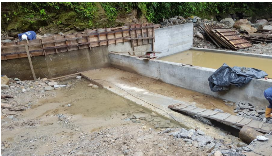
Figura 31. Estructura de bocatoma, desencofrado de elementos.
