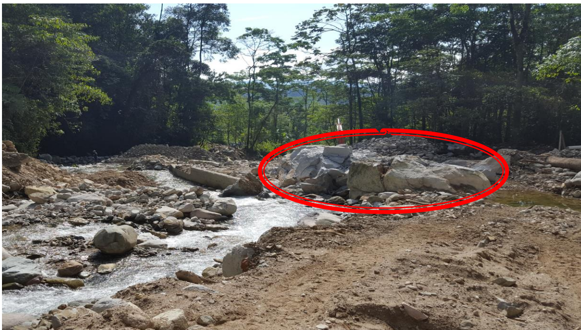
Figura 27. Panorámica de bocatoma, terreno limpio.
