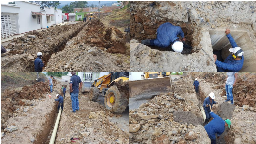
Figura 47. Proceso de instalación de red de alcantarillado.
