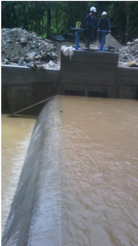
Figura 36. Crecida de la fuente, taponamiento de bocatoma provisional.
