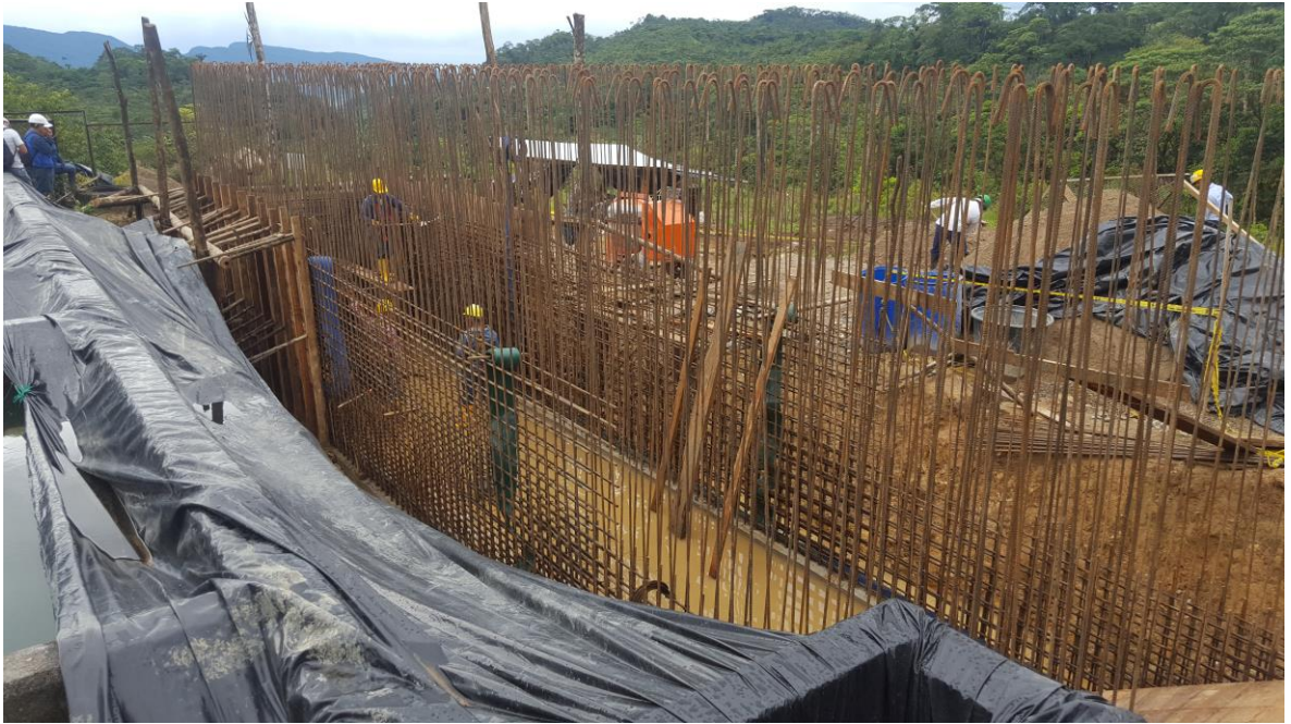
Figura 26. Desarenador listo para fundir muros laterales.
