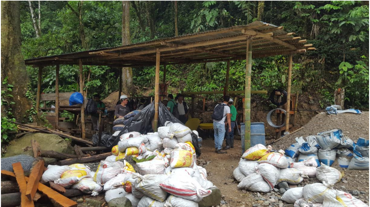
Figura 20. Campamento provisional frente de obra bocatoma.
