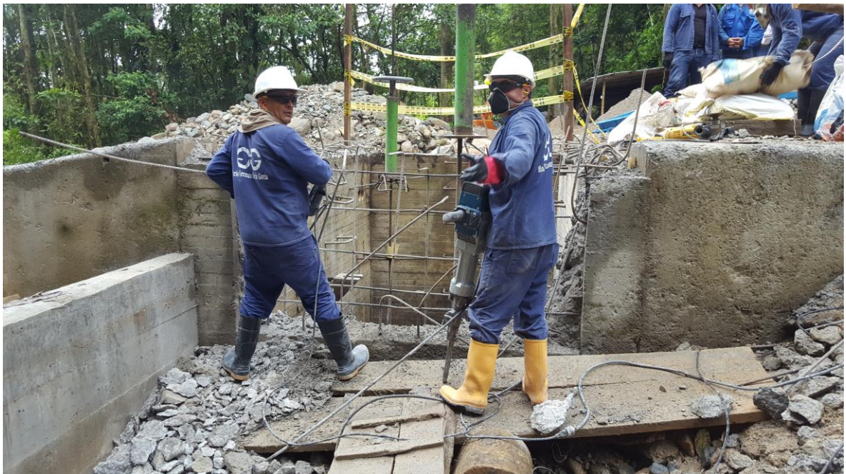
Figura 32. Adecuación del tanque de captación para instalar rejillas de aducción.
