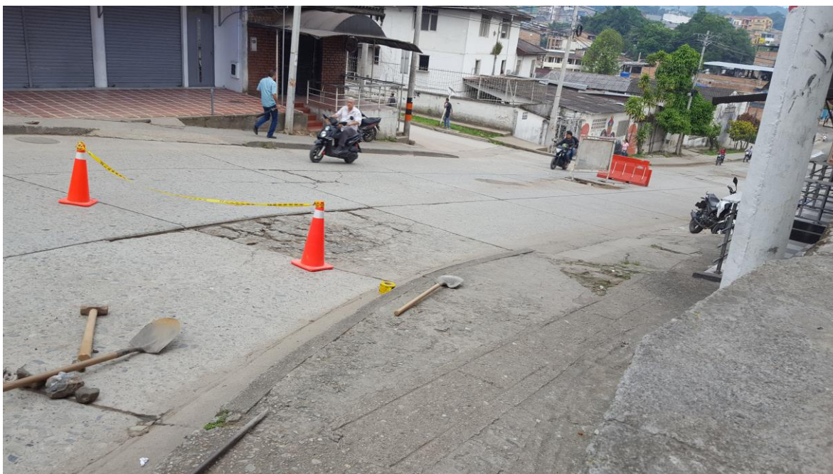
Figura 41. Vía la licorera localización de fuga.
