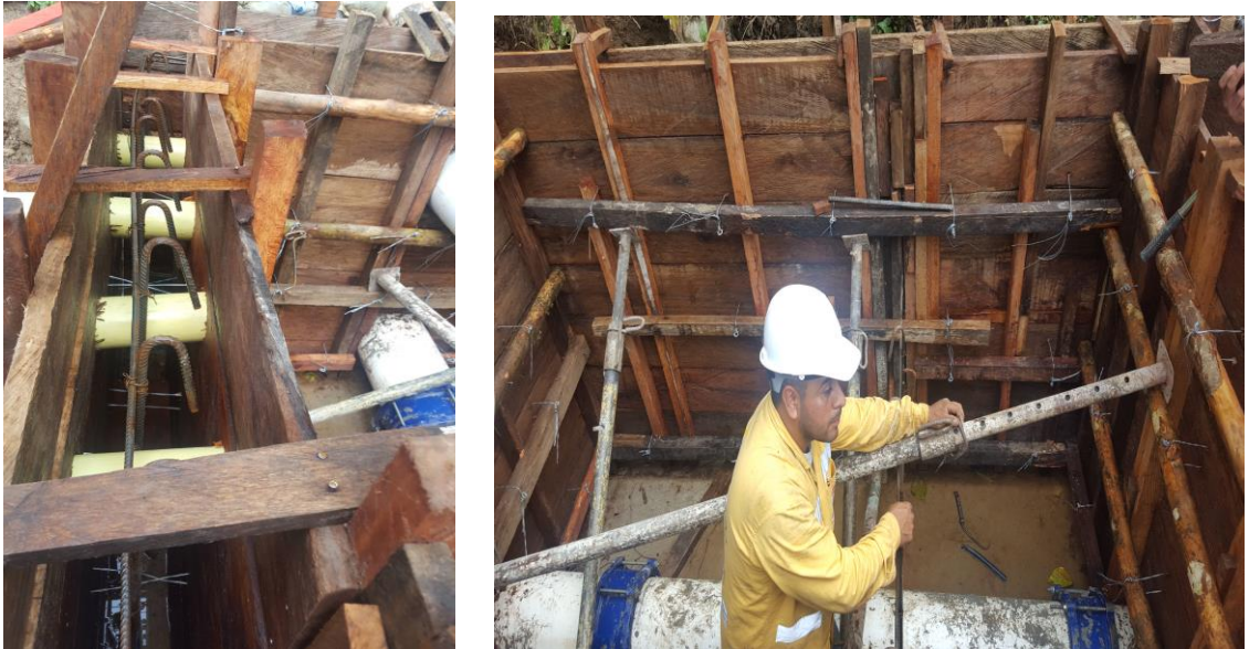
Figura 15. Elementos estructurales del tanque de derivación provisional.
