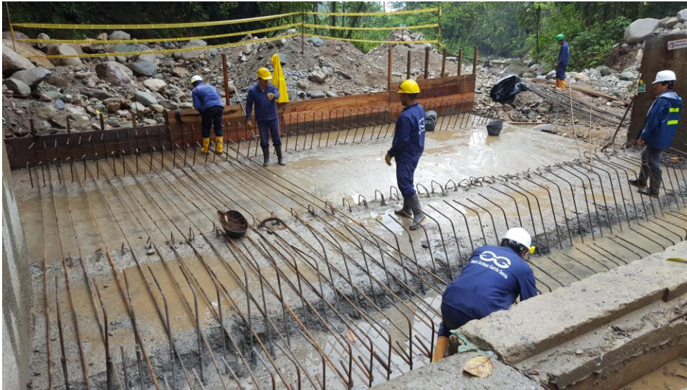
Figura 30. Dentellones fundidos y armadura de loza.
