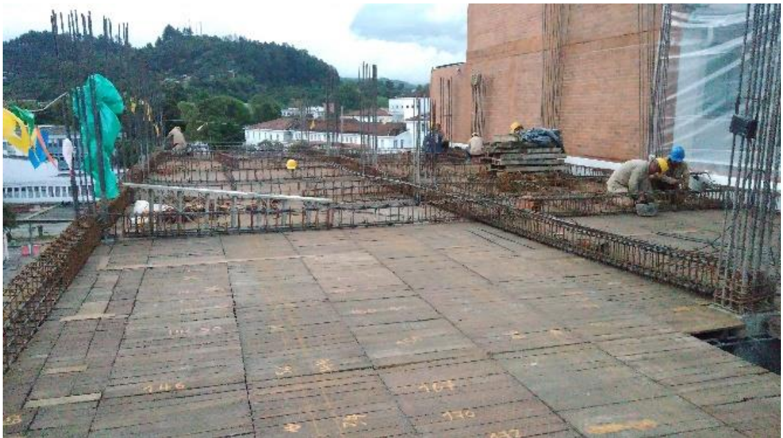
Figura 5. Placa N°4. Amarre de vigas
