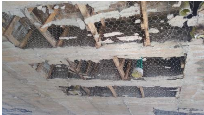
Figura 27. Casetones sin relleno.
