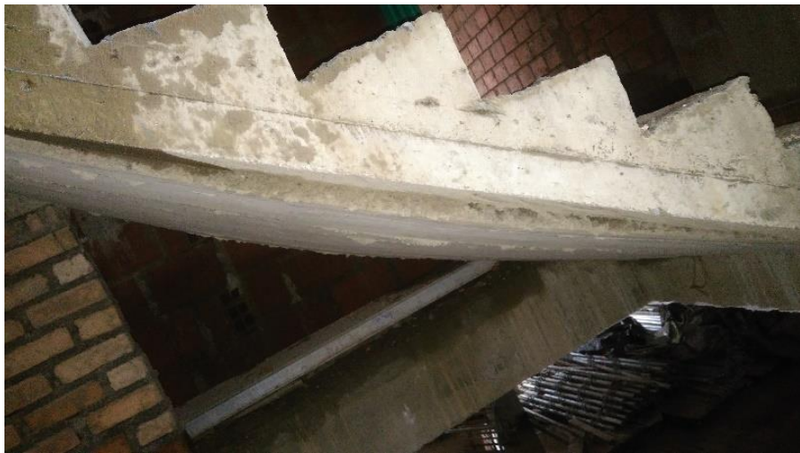
Figura 44. Gradas ubicadas en el sótano
