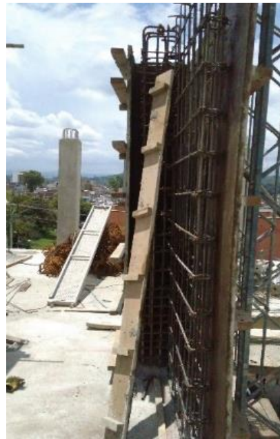
Figura 34. Fundición de columna
