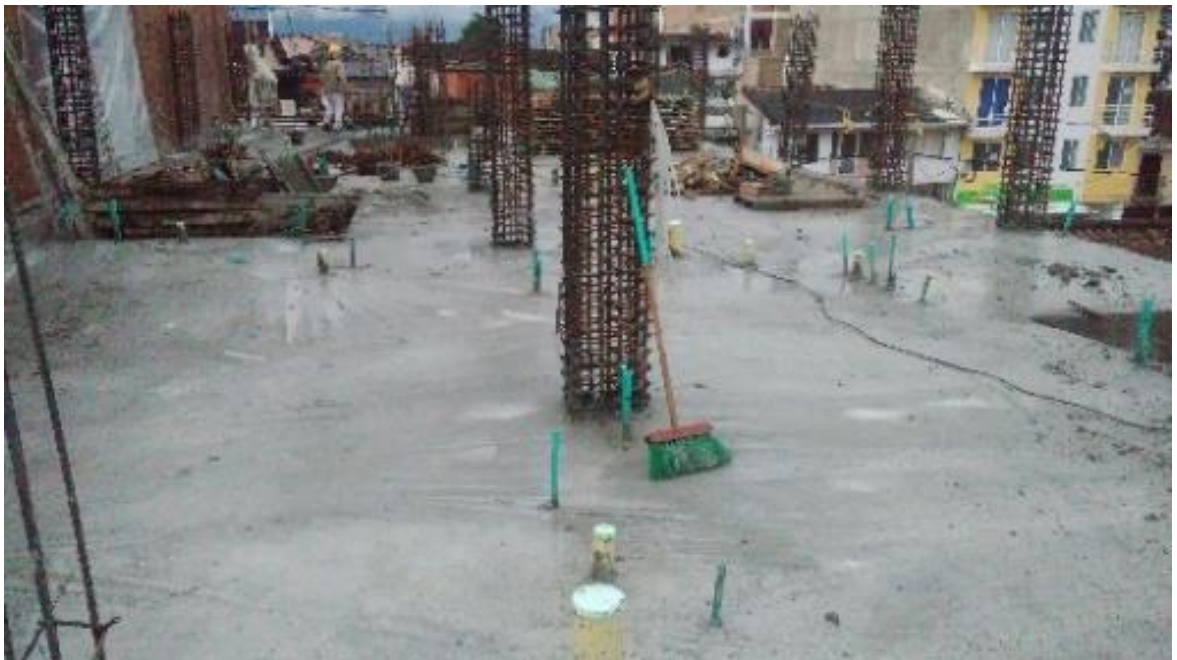
Figura 16. Columnas cuarto piso.
