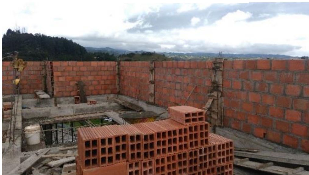
Figura 55. Muros de cubierta.
