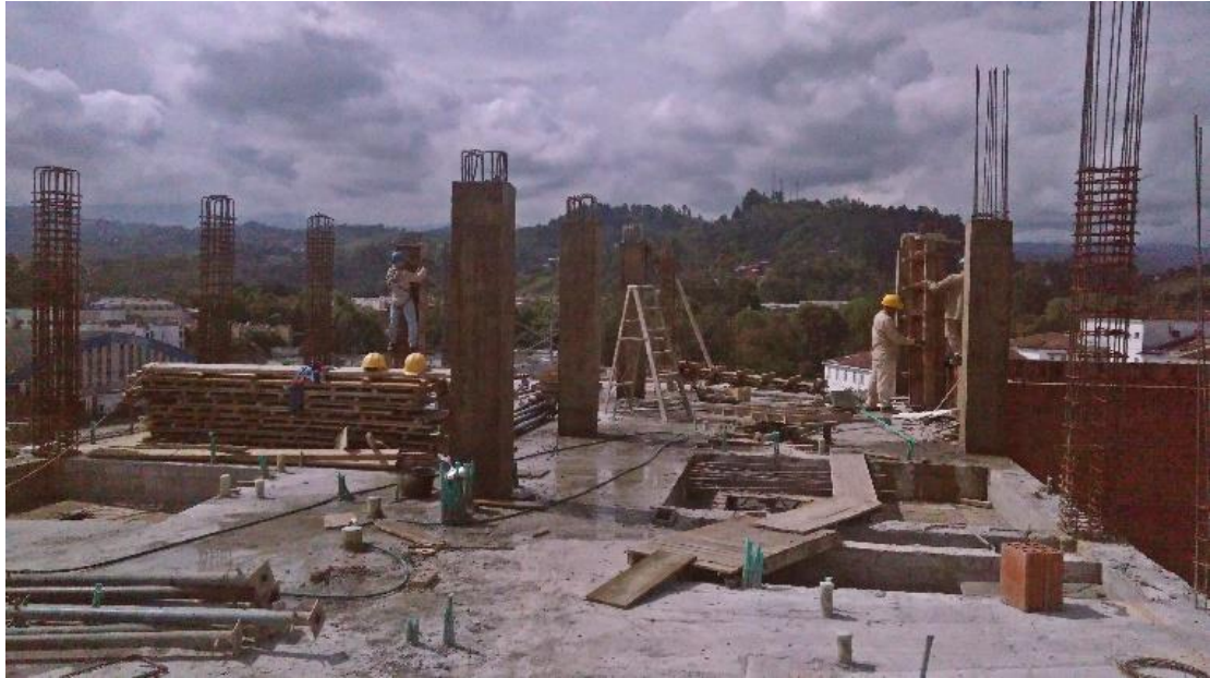
Figura 35. Columnas del último nivel
