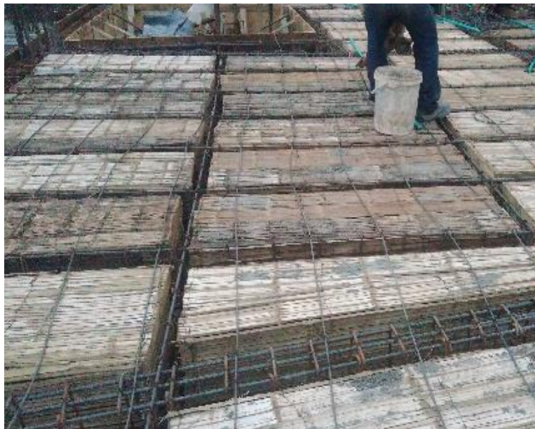
Figura 10. Refuerzo de retracción y temperatura.
