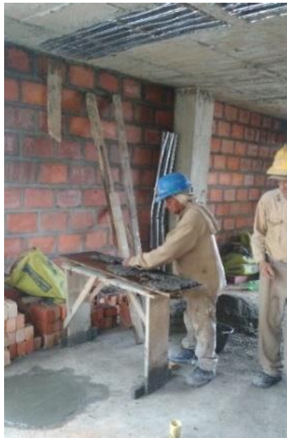
Figura 39. Reparación de casetones no rellenos
