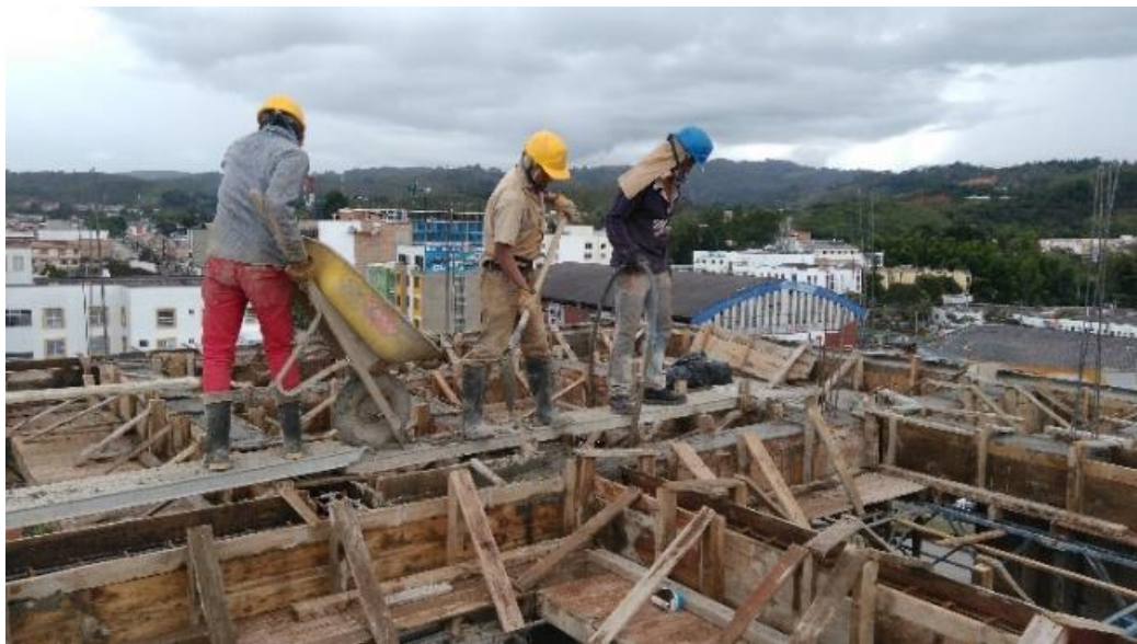
Figura 53. Fundición de vigas de cubierta.
