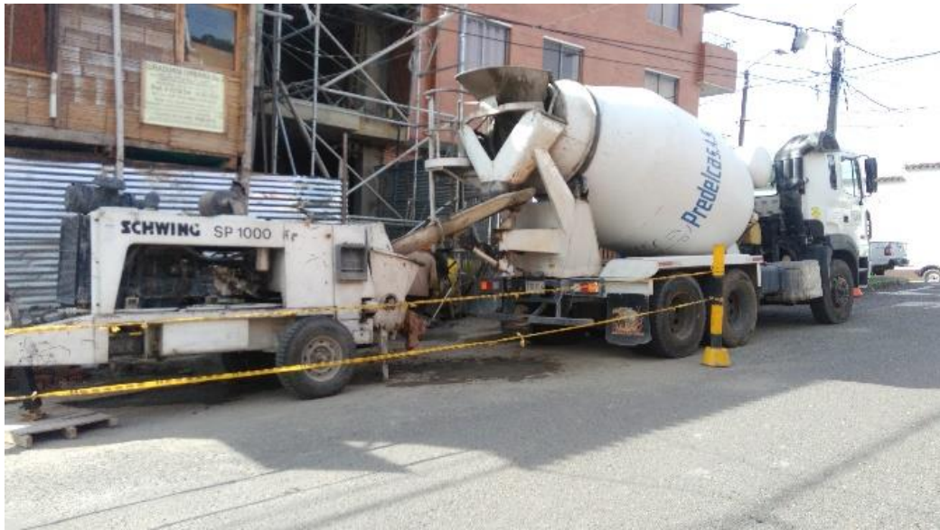
Figura 11. Mixer y bomba para concreto
