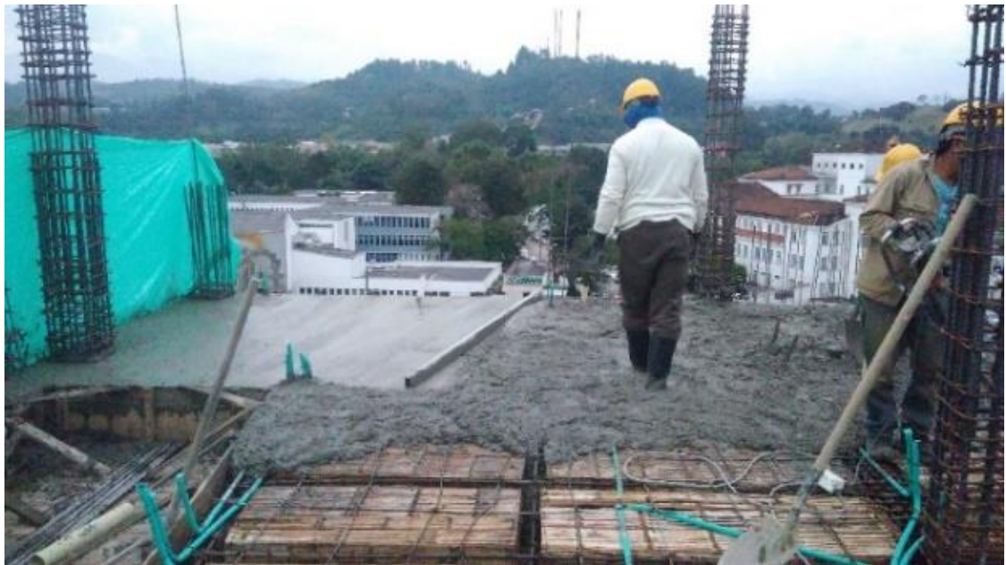
Figura 31. Inicio de fundición
