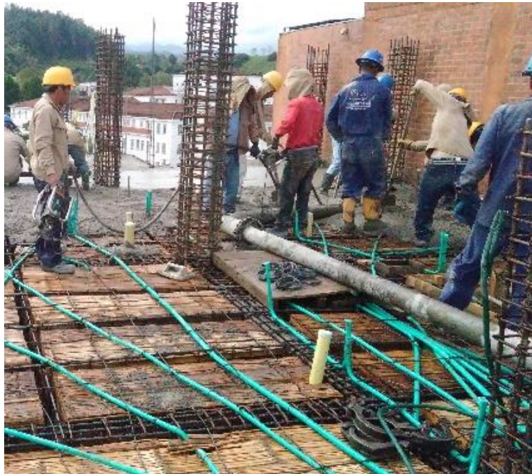
Figura 12. Fundición de la placa N°4.
