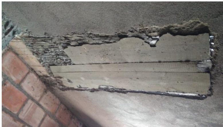
Figura 40. Reparación de casetones no rellenos
