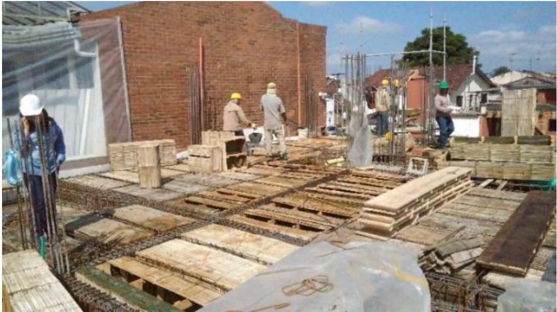
Figura 6. Ubicación de casetones en placa N°4.
