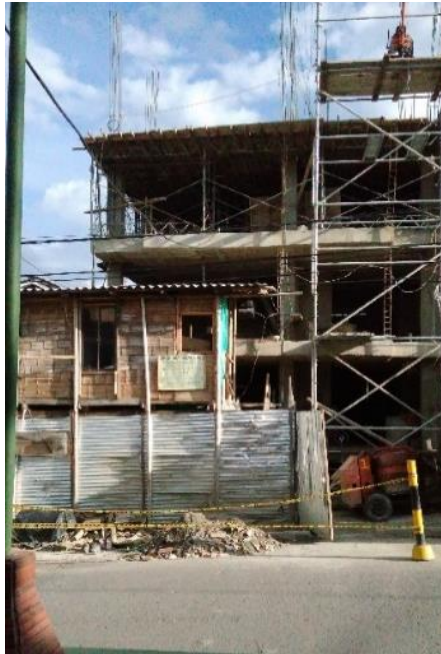
Figura 3. Edificio Sendero de Praga. Confección de placa N°4
