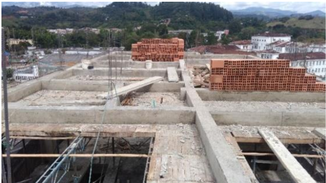
Figura 54. Desencofrado de vigas de cubierta.
