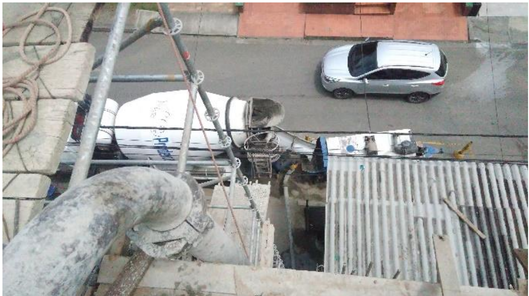
Figura 30. Inicio de fundición
