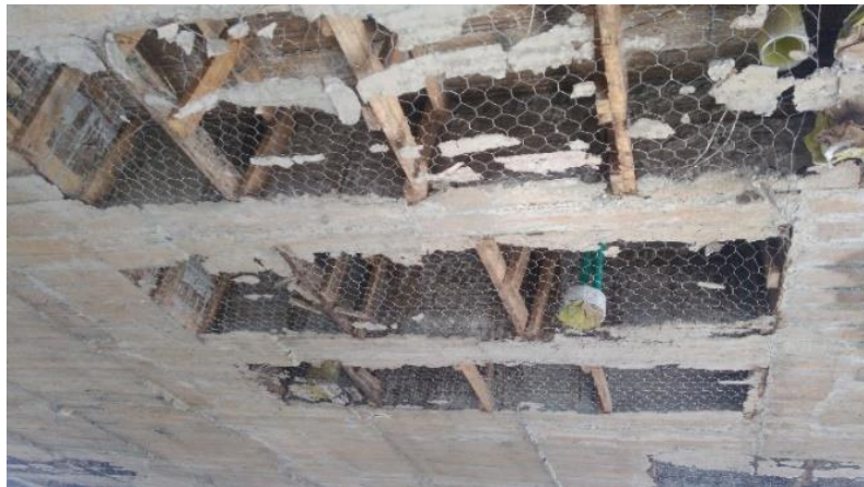
Figura 38. Casetones no rellenos con mortero
