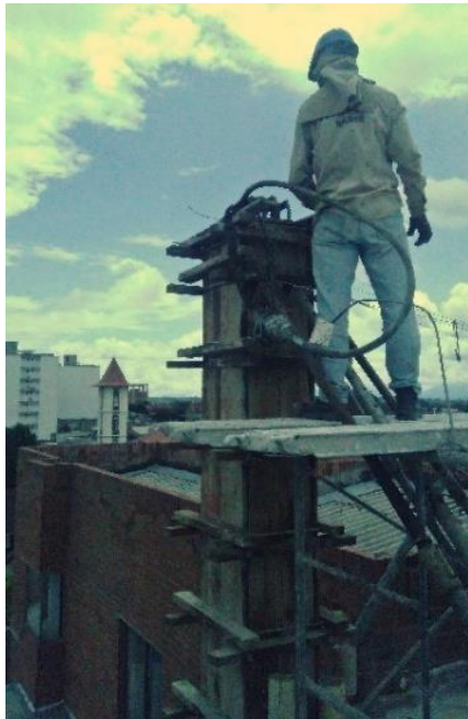
Figura 33. Fundición de columna
