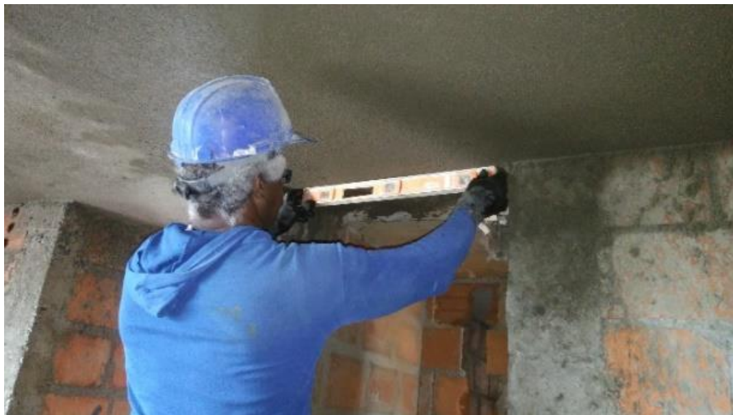
Figura 70. Verificación de nivel
