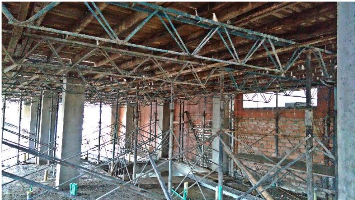
Figura 4. Encofrado de placa N°4.
