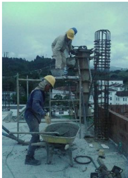
Figura 36. Fundición de columna C2
