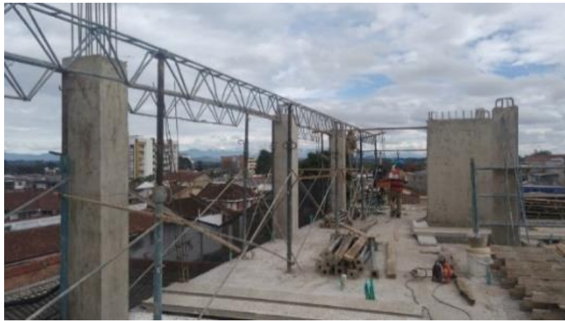
Figura 50. Encofrado de vigas de cubierta
