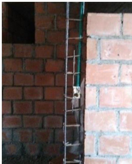
Figura 67. Refuerzo de columneta
