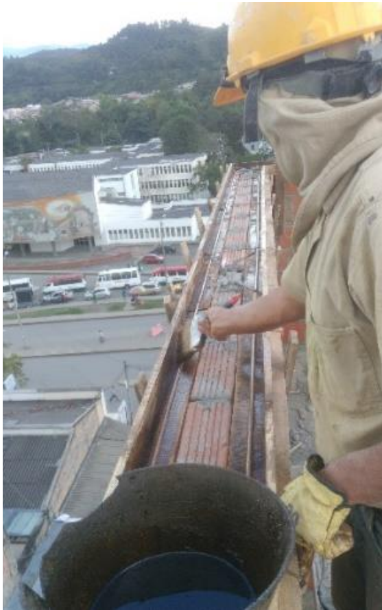
Figura 56. Recubrimiento alfajía.
