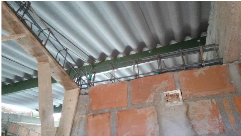
Figura 68. Vigas de amarre muros
