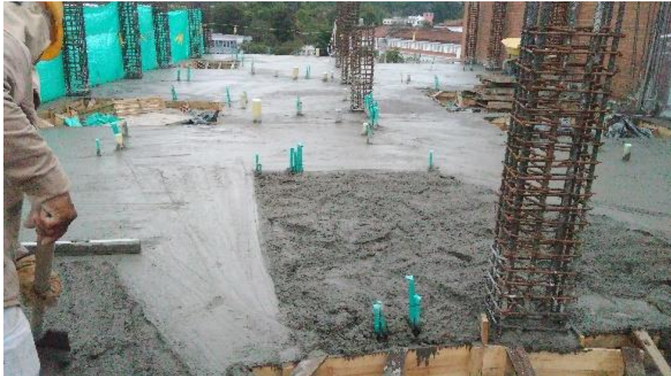
Figura 14. Vaciado de concreto hasta el eje 5.
