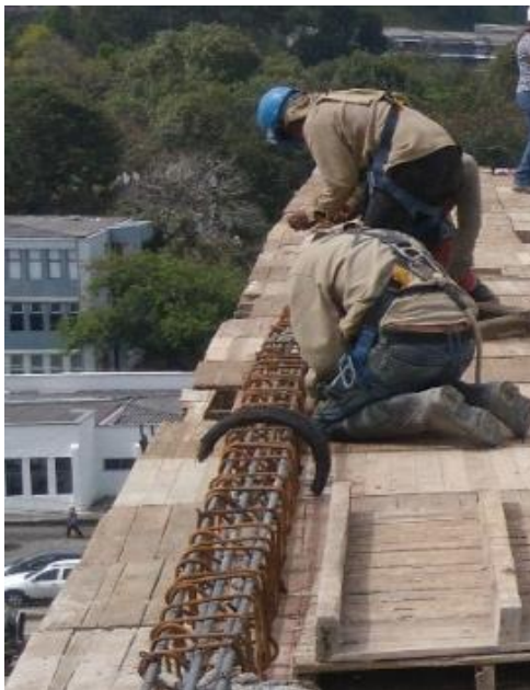
Figura 51. Amarre de vigas de cubierta
