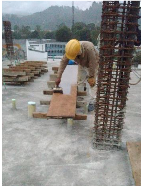
Figura 17. Revestimiento de encofrado.
