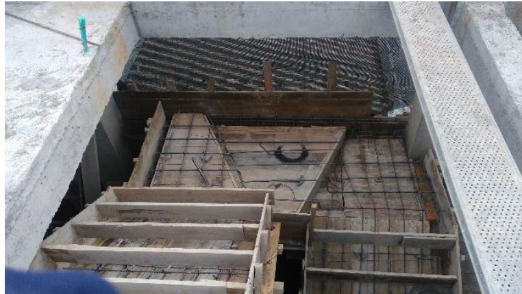
Figura 42. Elaboración de gradas del último nivel
