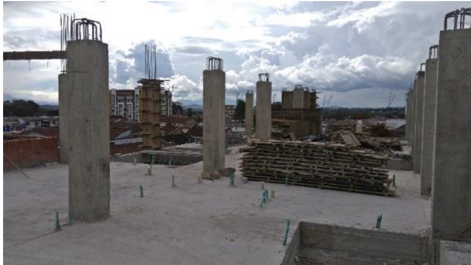
Figura 37. Columnas de la placa N°5
