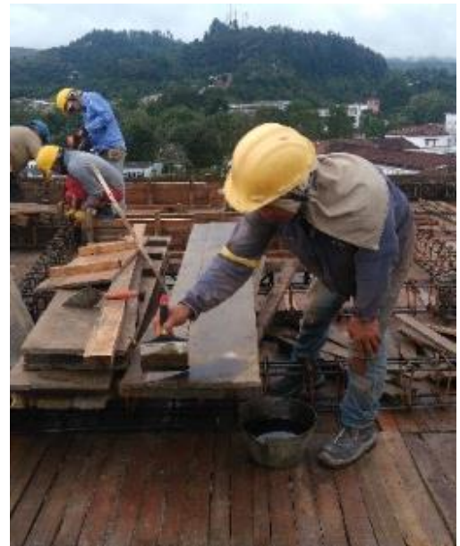
Figura 52. Recubrimiento de encofrado
