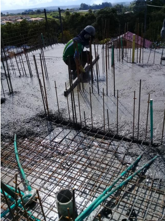
Fotografía 10: fundición. Fuente: autor.
