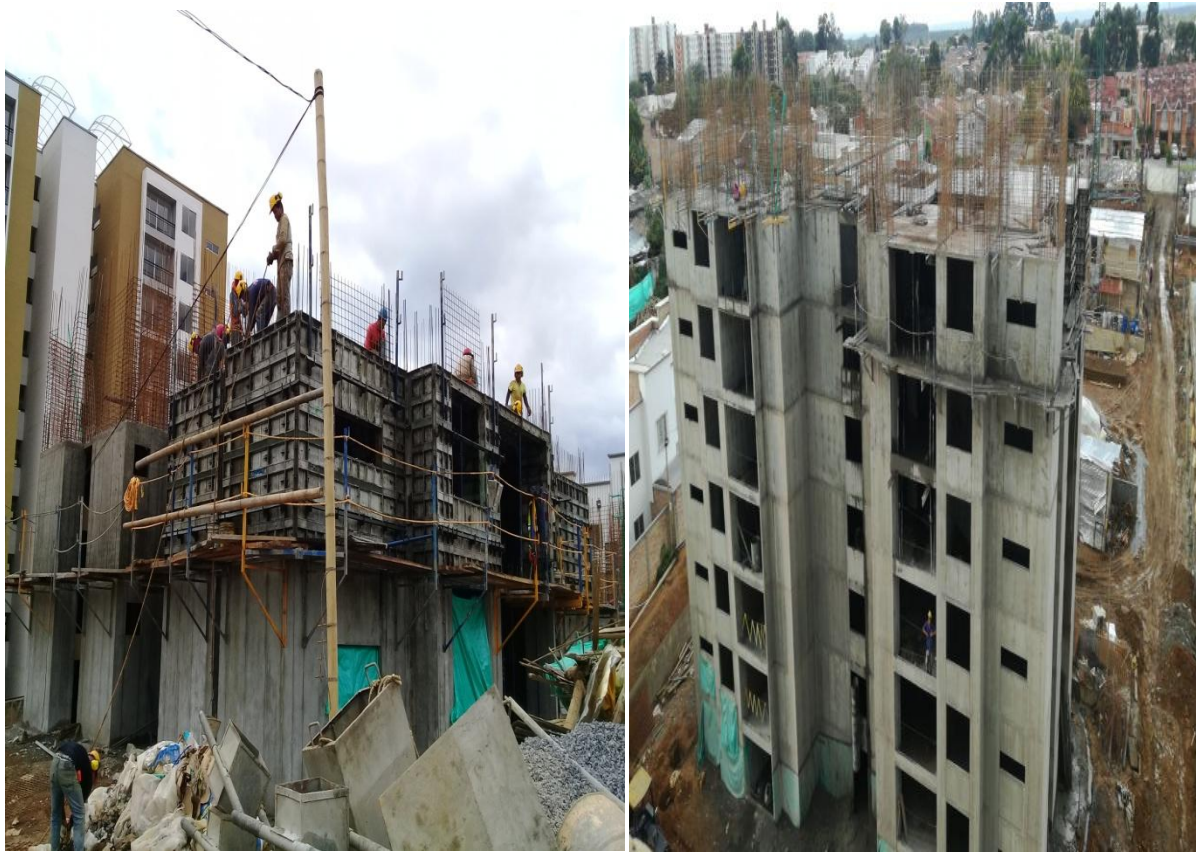
Fotografía 19: Torre D en construcción. Fuente: autor.
