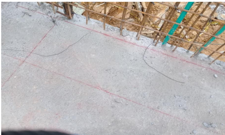
Fotografía 6: Cimbrado. Fuente: autor.
