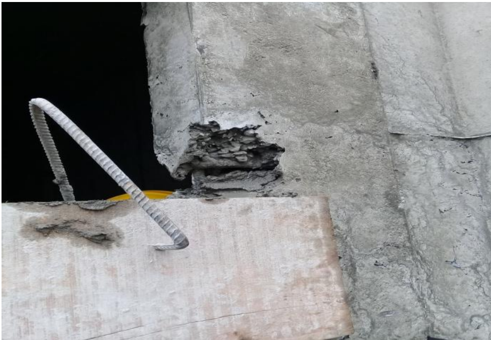
Fotografía 12: Ventana de muro social. Fuente: autor.
