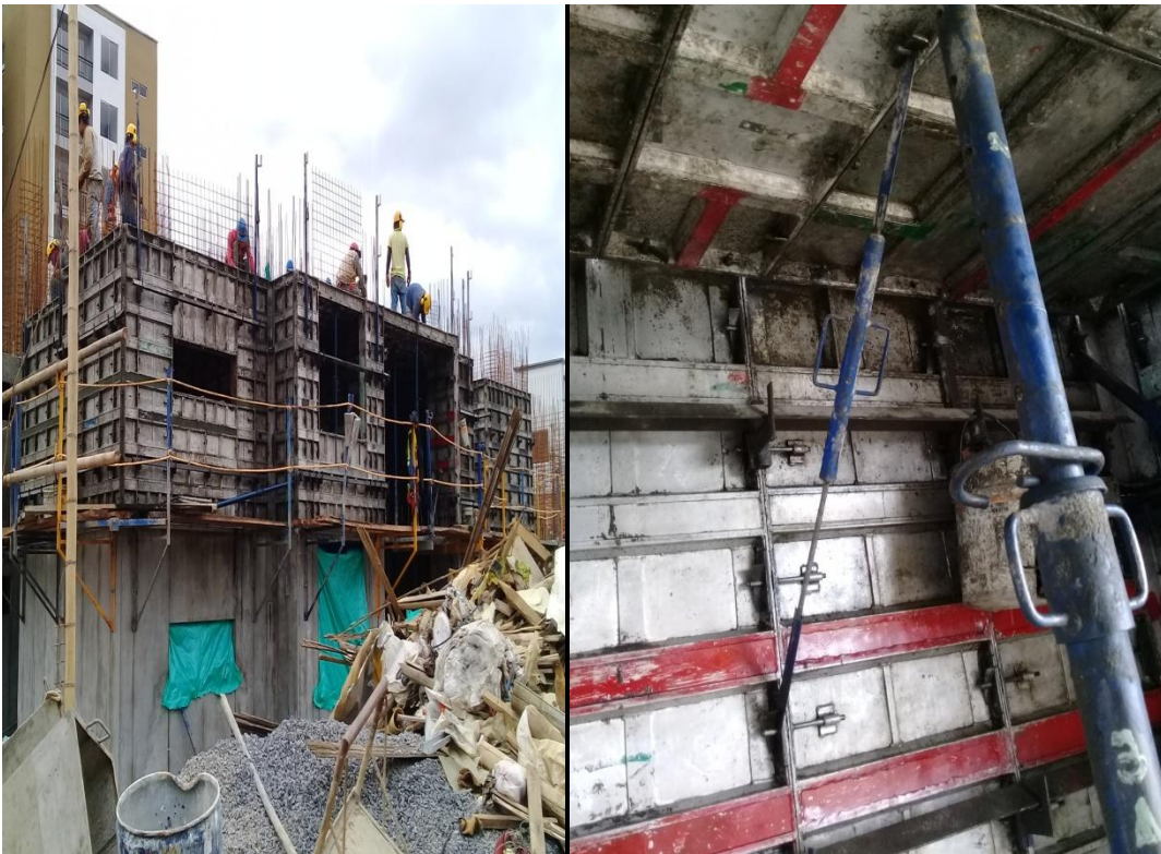
Fotografía 7: formaleta. Fuente: autor.
