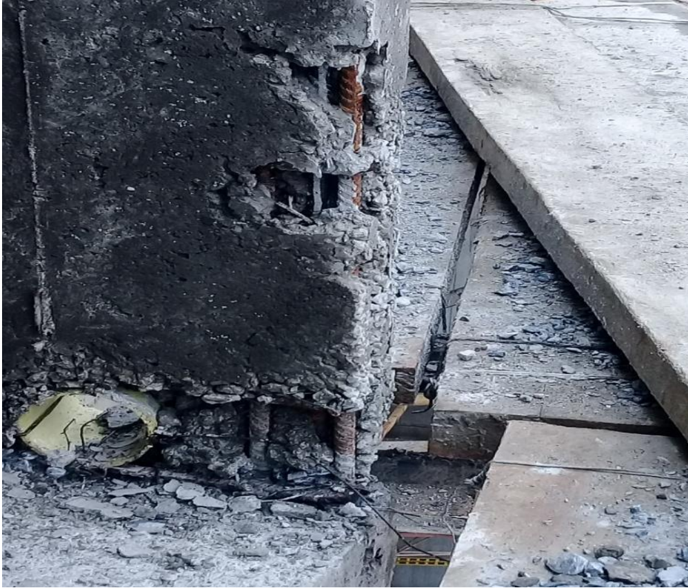
Fotografía 13: Muro 5-balcon. Fuente: autor.
