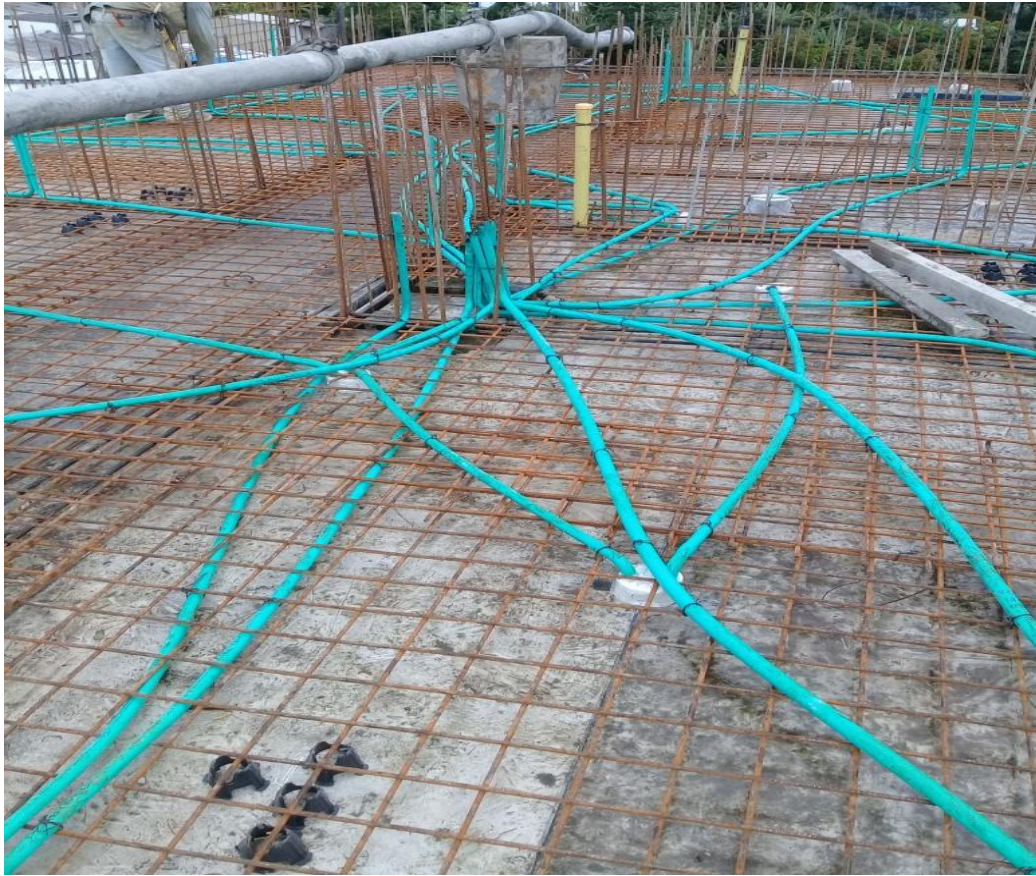
Fotografía 9: instalación de tubería y acero en la losa. Fuente: autor.
