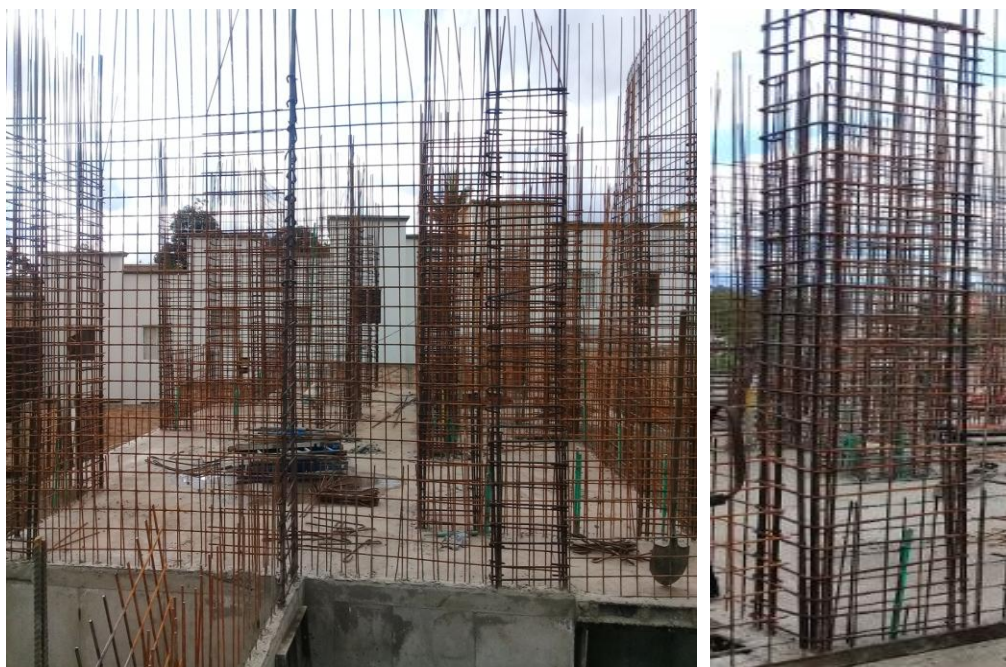
Fotografía 2: Instalación del acero. Fuente: autor.
