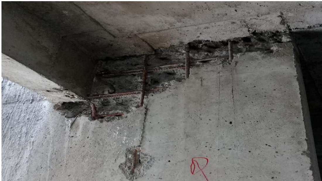
Fotografía 16: Muro 30- losa de entrepiso. Fuente: autor.
