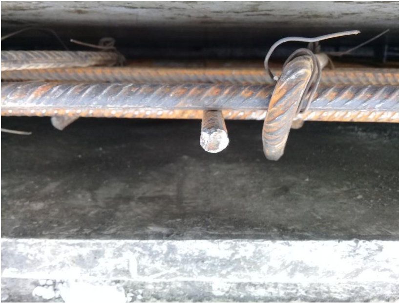
Fotografía 8: Espacio entre el acero y formaleta. Fuente: autor.
