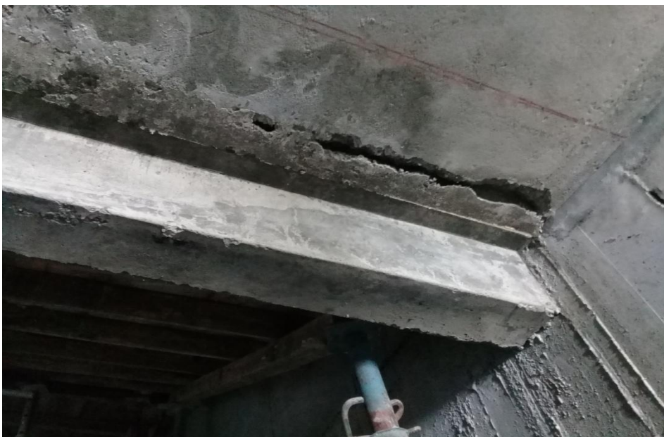
Fotografía 15: Unión vigas-losa de entrepiso. Fuente: autor.
