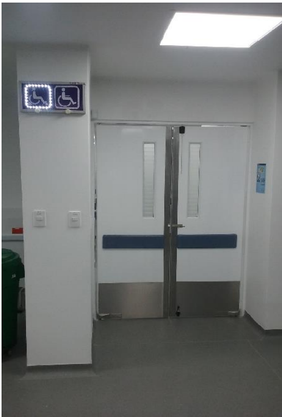
Figura 6.12 Alarma activada mediante el botón de pánico del baño de discapacitados
