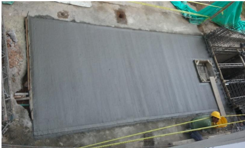
Figura 6.26 Losa superior de tanque de agua; escobiado y acolillado
