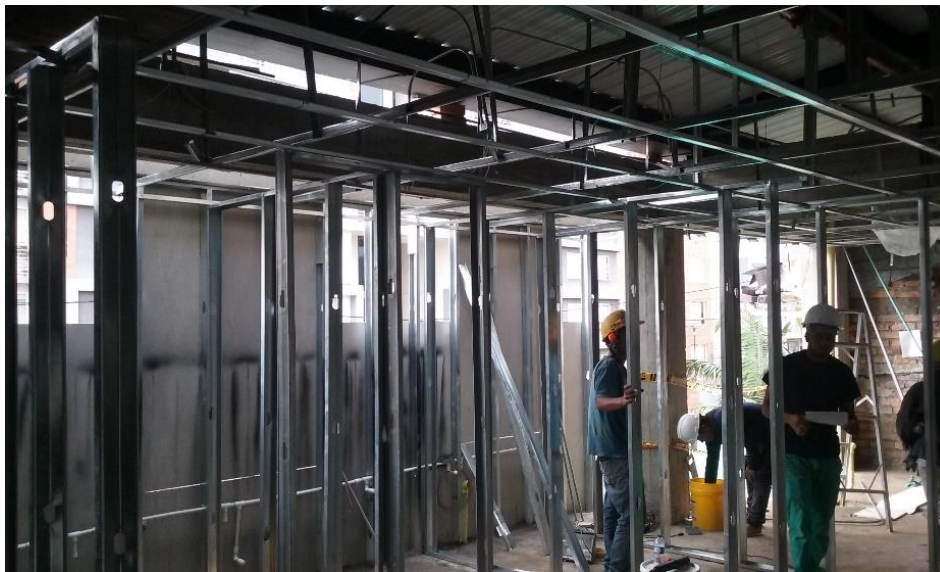
Figura 6.41 Parales; canales, viguetas y omegas de lámina de acero galvanizado para sistema Drywall
