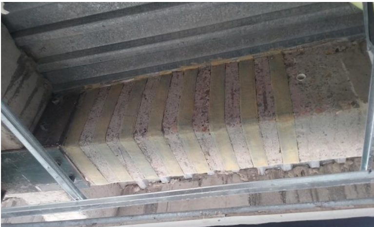
Figura 6.40 Refuerzo transversal de viga de entrepiso con fibras de carbono
