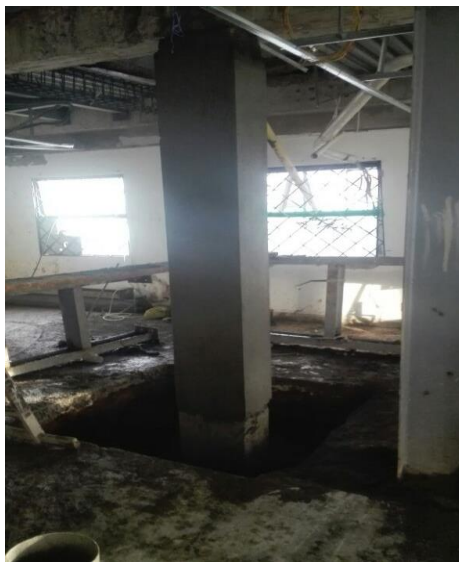
Figura 6.37 Concreto para columnas
