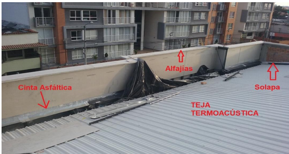
Figura 6.21 Instalación teja termoacústica, solapas y cinta asfáltica
