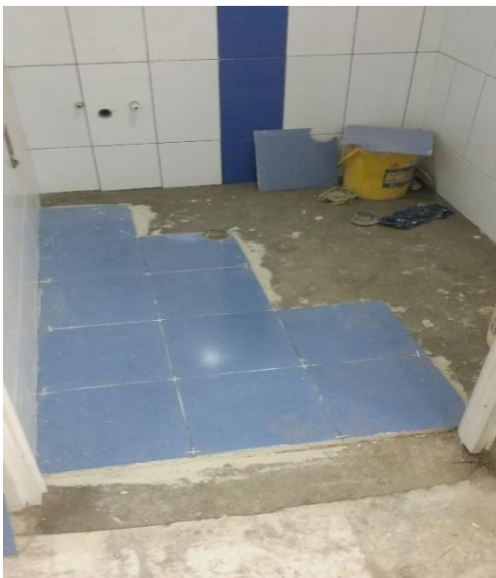
Figura 6.17 Enchape para baño de piso y pared
