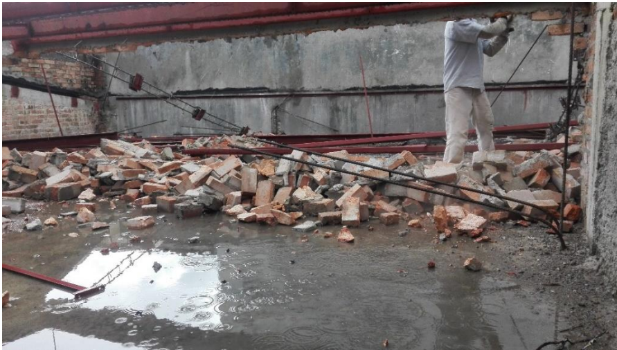
Figura 6.4 Demolición de culatas en ladrillo común
