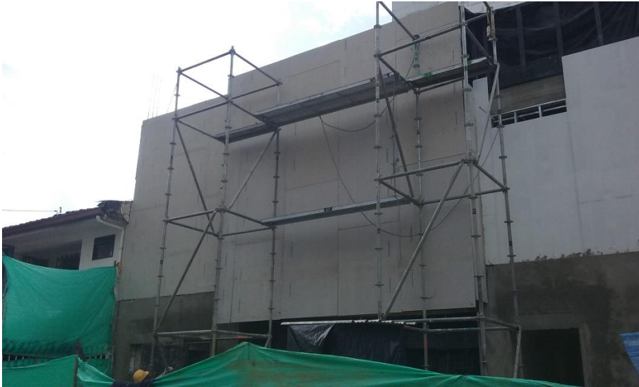
Figura 6.51 Andamios Certificados para trabajo en alturas
