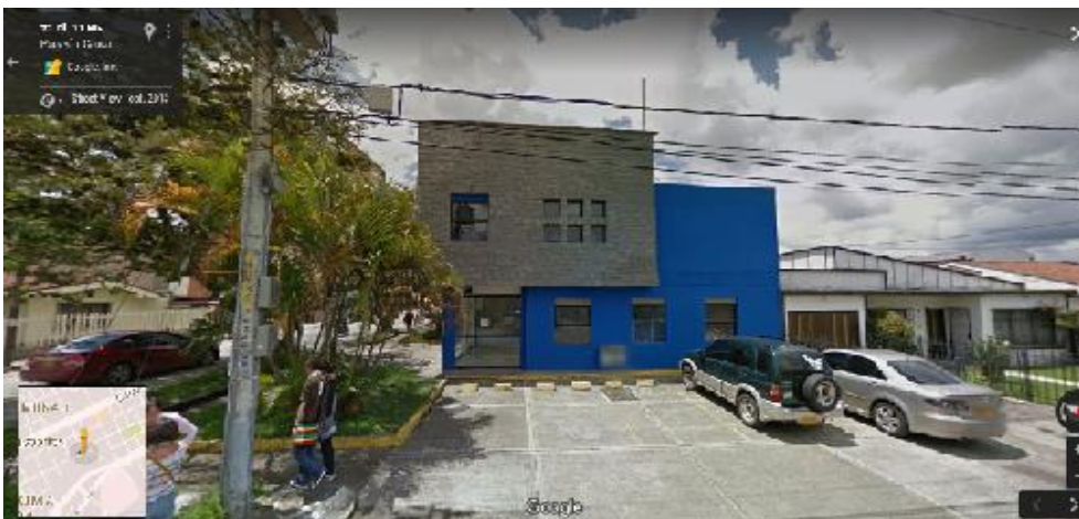
Figura 5.3 Fachada existente sobre la carrera 11
