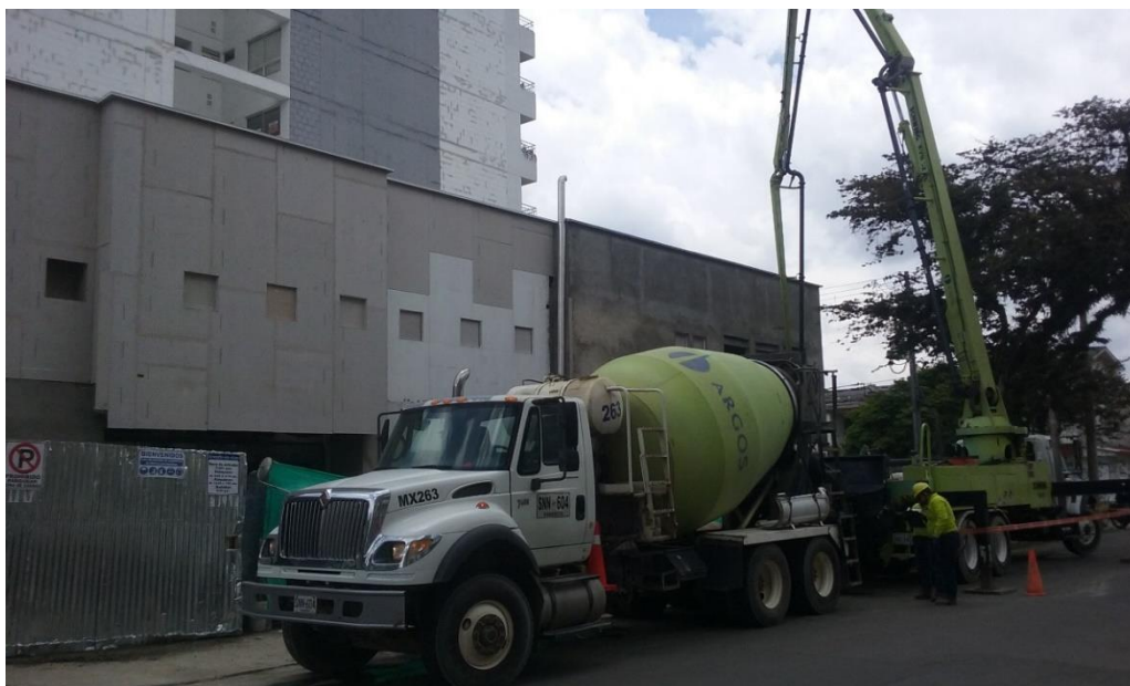
Figura 6.45 Concreto premezclado Argos para muros del tanque de almacenamiento de agua
