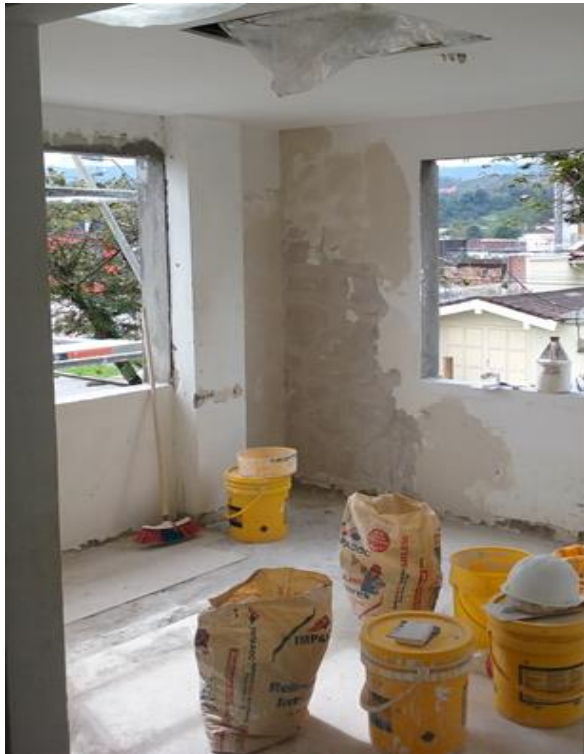
Figura 6.42 Resanes y Rellenos con estuco sobre muros interiores
