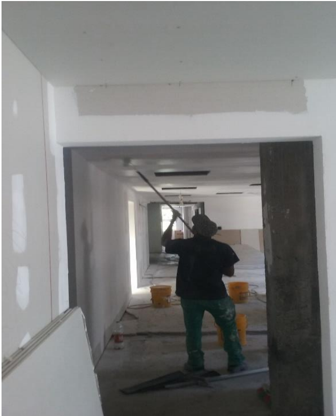
Figura 6.18 Aplicación de pintura acrílica de alta asepsia sobre panel yeso
