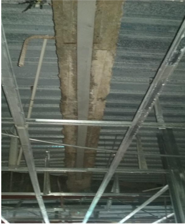
Figura 6.39 Refuerzo longitudinal de viga de entrepiso con fibras de carbono
