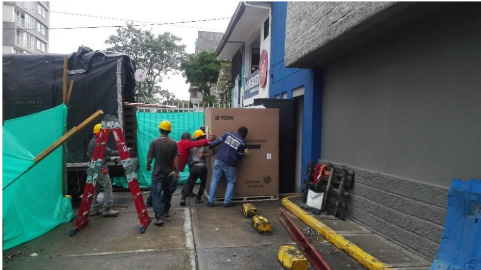
Figura 6.50 Descargue y recepción de unidades exteriores del sistema de aire acondicionado
