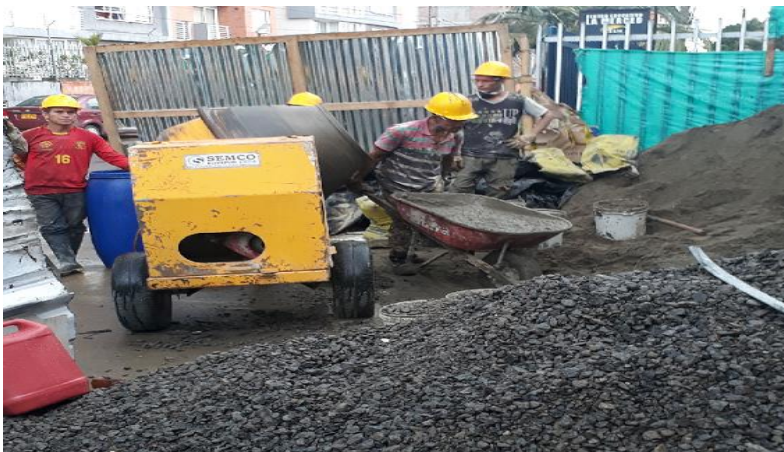
Figura 6.10 Mezcladora mecánica para la elaboración de concretos
