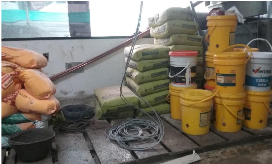
Figura 6.47 Almacenamiento de cemento argos sobre estibas de madera
