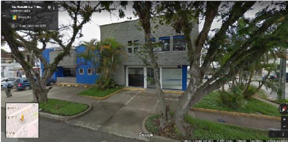
Figura 5.2 Fachada existente sobre la carrera 7ª
