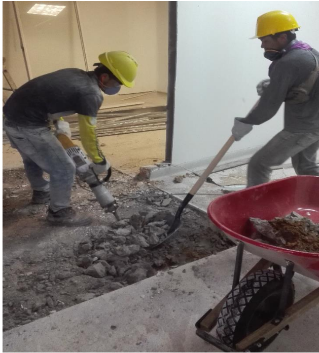
Figura 6.8 Uso de herramienta y equipo para demolición de pisos
