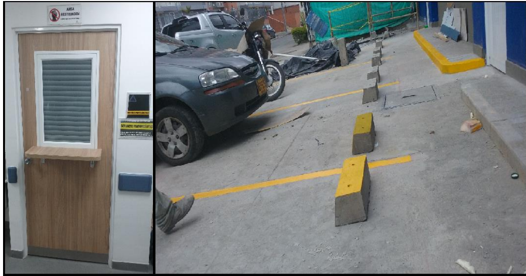
Figura 6.31 Señalización de áreas de trabajo y señalización parqueaderos
