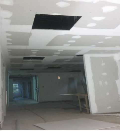
Figura 6.16 Sellamiento de juntas entre placas de muros y cielo falsos
