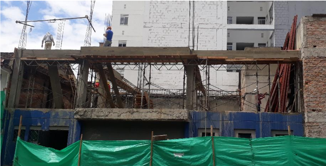
Figura 6.13 Vigas de coronación y columnas de concreto 3000 psi
