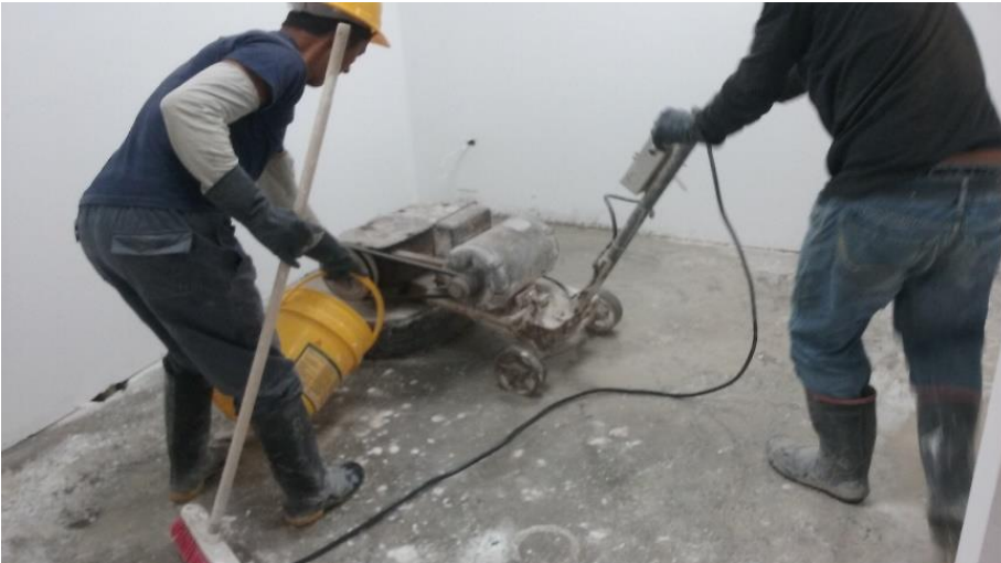
Figura 6.19 Destronque de piso a máquina para emparejar pisos
