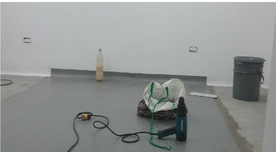
Figura 6.20 Instalación de pisos en vinilo PVC
