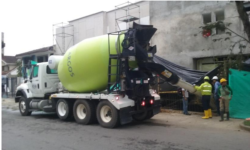
Figura 6.25 Concreto premezclado impermeabilizado ARGOS 3000 psi
