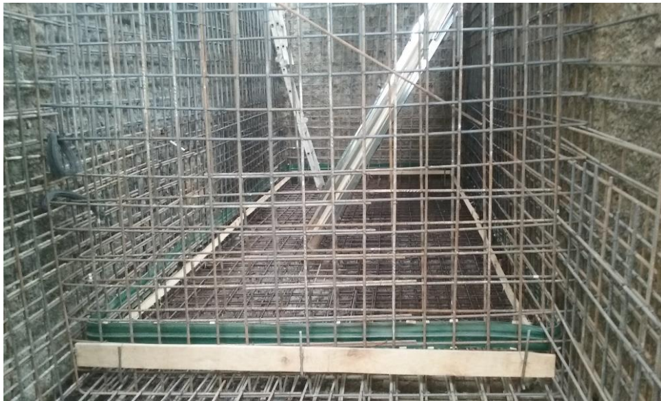
Figura 6.24 Cinta PVC para impermeabilizar juntas y Acero de refuerzo de muros y losa de fondo del tanque de almacenamiento de agua
