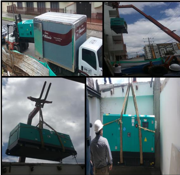
Figura 6.22 Proceso de instalación de la planta eléctrica en el segundo piso
