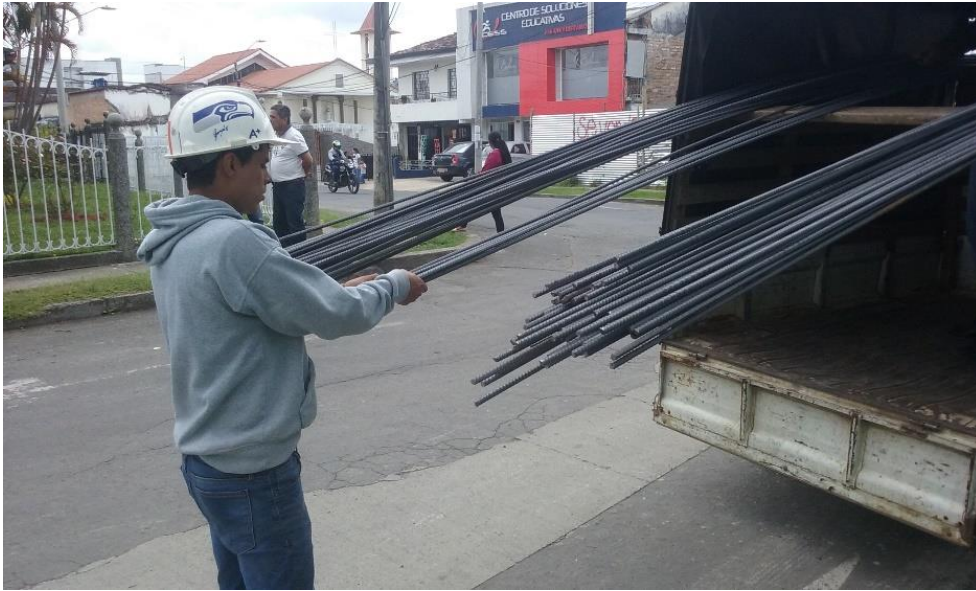
Figura 6.48 Recepción y conteo de varillas corrugadas de acero
