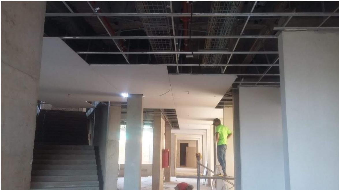
*Imagen 19. Instalación de cielo raso, Bloque 1 piso 2.
