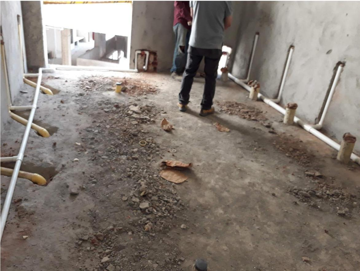
*Imagen 21. Red sanitaria e hidráulica interna. Bloque 1 piso 3.
