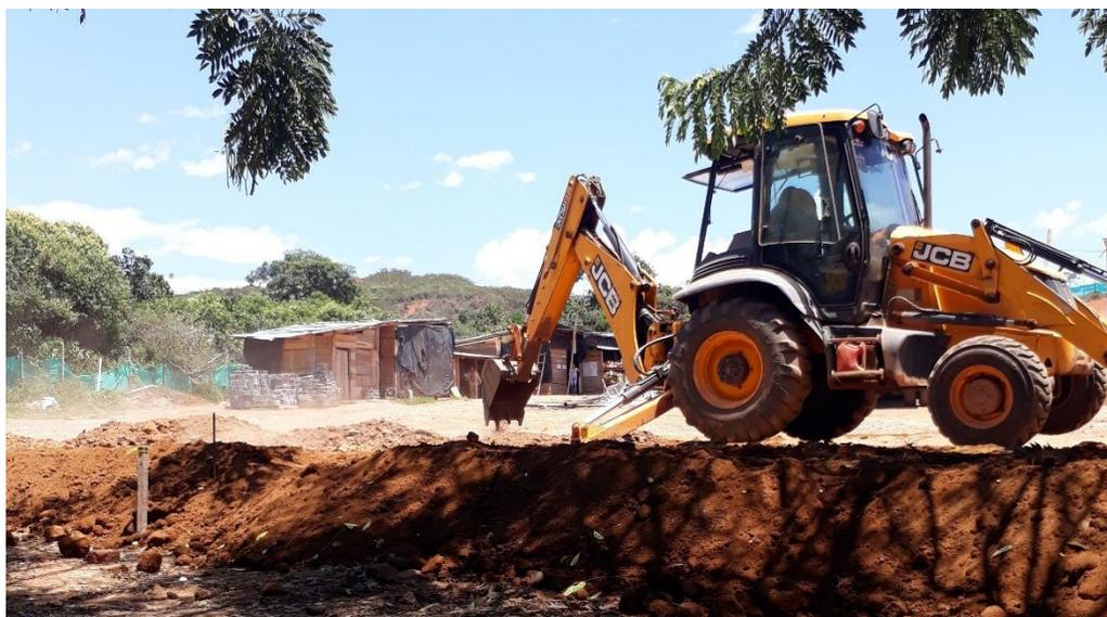
*Imagen 38. Corte con retroexcavadora.
