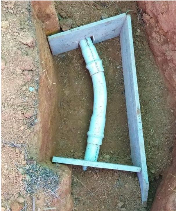
*Imagen 24. Codo gran radio, Red hidráulica externa.
