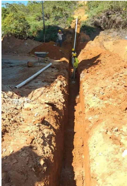
*Imagen 25. Instalación de red hidráulica externa.
