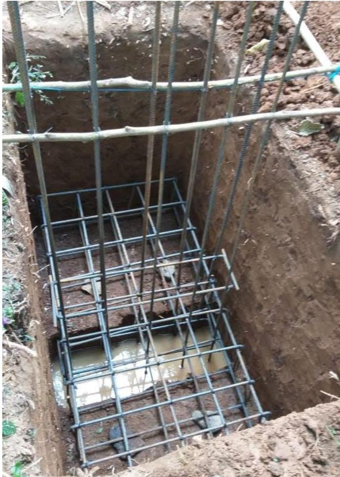
*Imagen 36. Armada de acero de zapata 1 Corpopaló.
