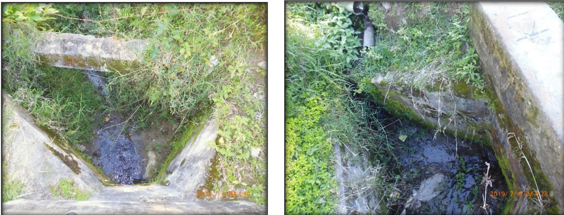
Figura 46: : Estructura de entrada y salida alcantarilla 5
