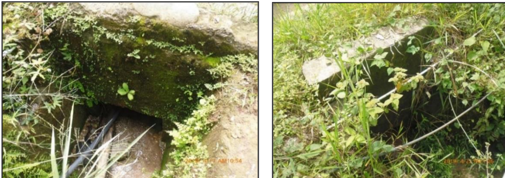
Figura 53: Estructura de entrada y salida alcantarilla 16, presencia de tubería de acueducto
