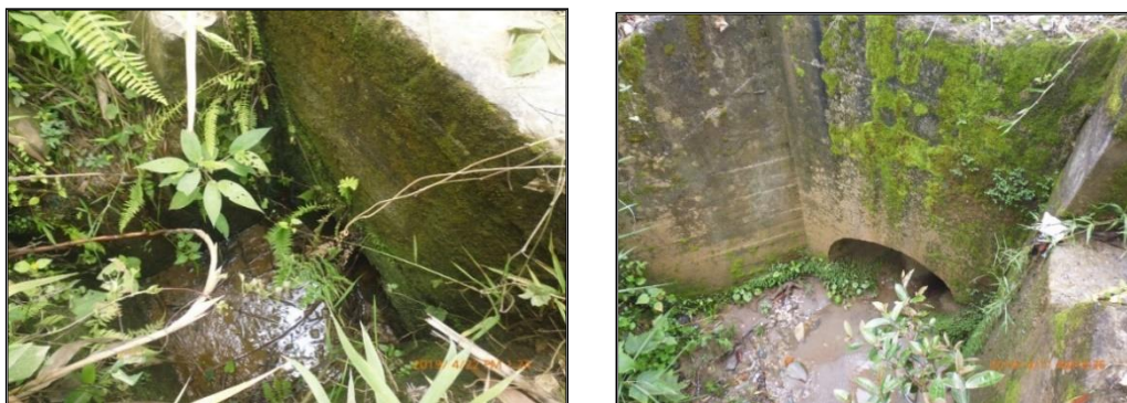
Figura 54: : Estructura de entrada y salida alcantarilla 22
