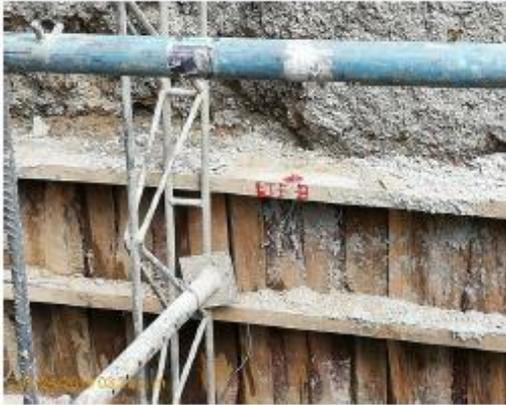
5. Luego de excavación mecánica en el corazón, se localiza donde ira la cimentación y se comienza con excavación manual de los pozos. Fotografía 16.
