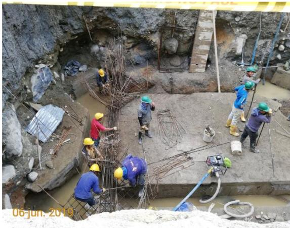
4. Se rellena con material granular la parte de la cimentación excavada en el corazón (vigas y dados de cimentación). Fotografía 28.
