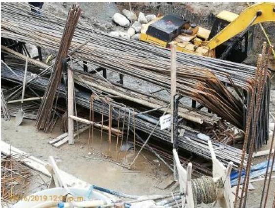
4. Termina el amarre de acero en el pozo 1 hasta el nivel de sótano 1. El acero amarrado comprende vigas, dado de cimentación y arranque de columna con sus respectivos estribos. Fotografía 10.
