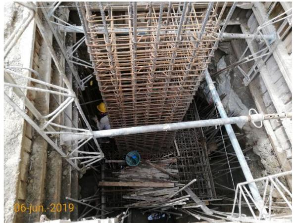
3. Se suelta todo el acero amarrado en el corazón y se deja en los puntos destinados para el acopio, debido a inconsistencias en los diseños y a la posibilidad de ingreso de maquinaria para excavación total de los dos sótanos. Fotografía 27.
