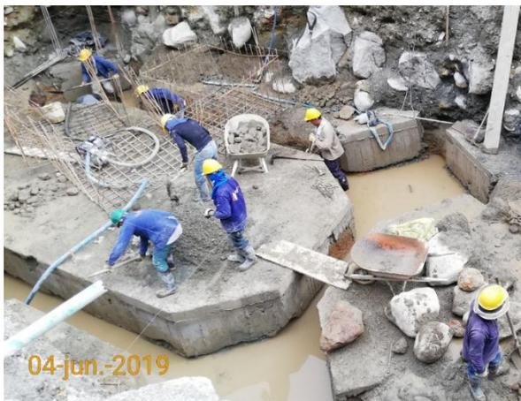
2. Se realiza revisión por parte de interventoría en el pozo 8, 9 y 11, se diligencia el formato de liberación y en él se escriben las observaciones acerca del amarre de acero, se observó que en el pozo 3 los arranques de la columna estaban desplazados unos centímetros, lo que se arregló más adelante, también se observaron unas separaciones de estribos mayores a las permitidas y diseñadas en los planos, estas se hicieron corregir. Fotografía 25 y 26 de los pozos 3 y 11.
