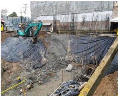
2. Avanza el champeo en taludes del pozo central para evitar la erosión, el talud junto al edificio oporto ya se encuentra cubierto por concreto. Lo anterior se puede evidenciar en las Fotografías 19 y 20.
