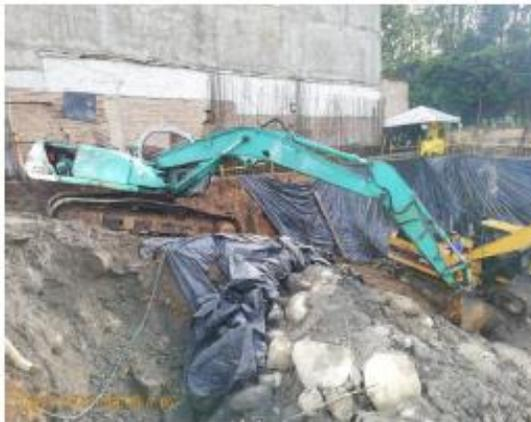
2. Debido a problemas generados por el agua se decide champear una parte del talud en la ubicación de ejes A10 y fundir en la parte superior del pozo 8 para prevenir desprendimiento de materiales. Fotografía 13.
