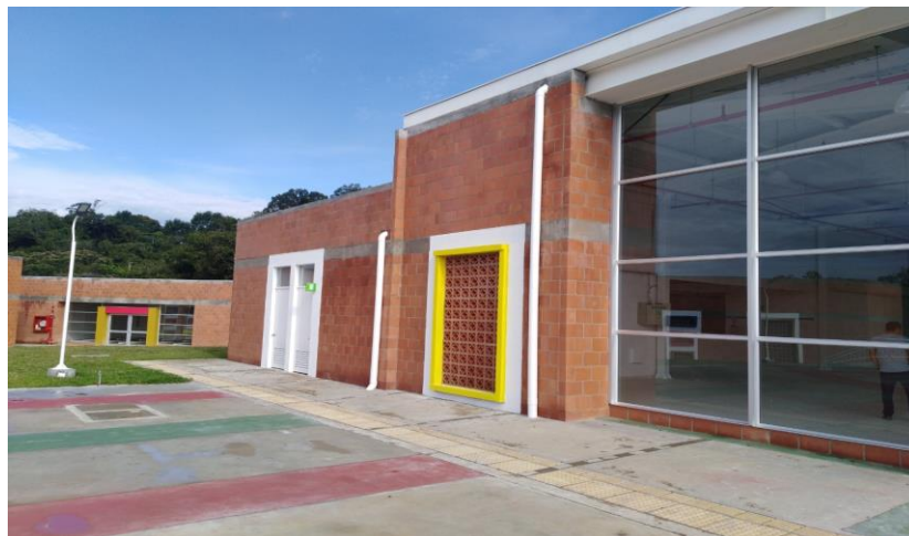
Imagen 2. Fachadas y terminaciones en obras colegio El Ortigal. Fuente: Diego Fajardo
