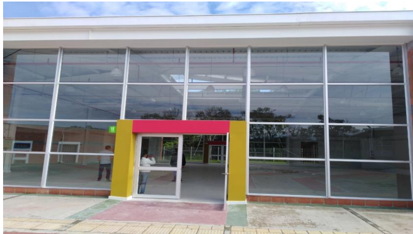
Imagen 1. Fachadas y terminaciones en obras colegio El Ortigal. Fuente: Diego Fajardo
