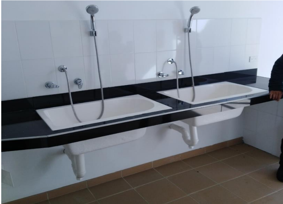
Imagen 5. Acabados con enchape cerámico – Baños Mega colegio El Ortigal. Fuente: Diego Fajardo
