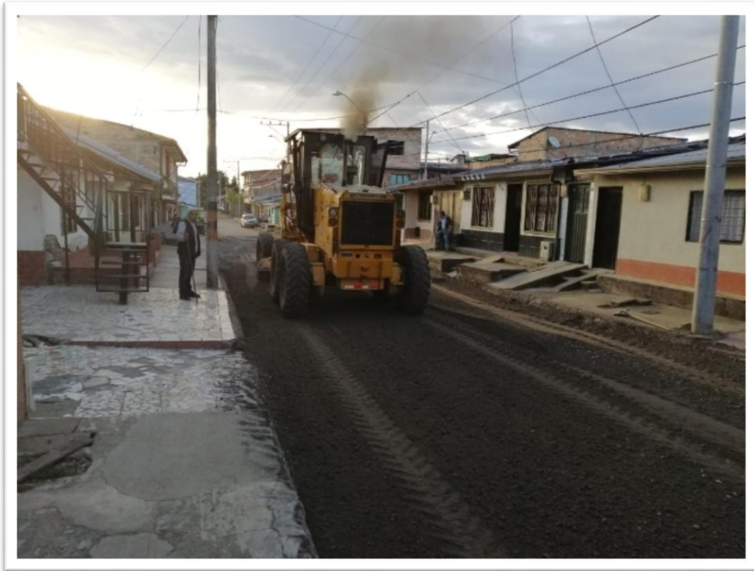
Ilustración 39. Motoniveladora nivelando material de base en el Barrio Junín
