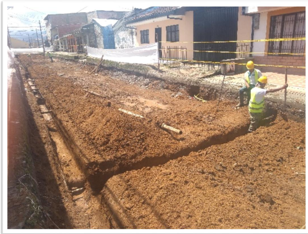
Ilustración 20. Trabajos de excavación para profundizar la tubería de agua potable, Barrio Junín Fuente. Elaboración propia
