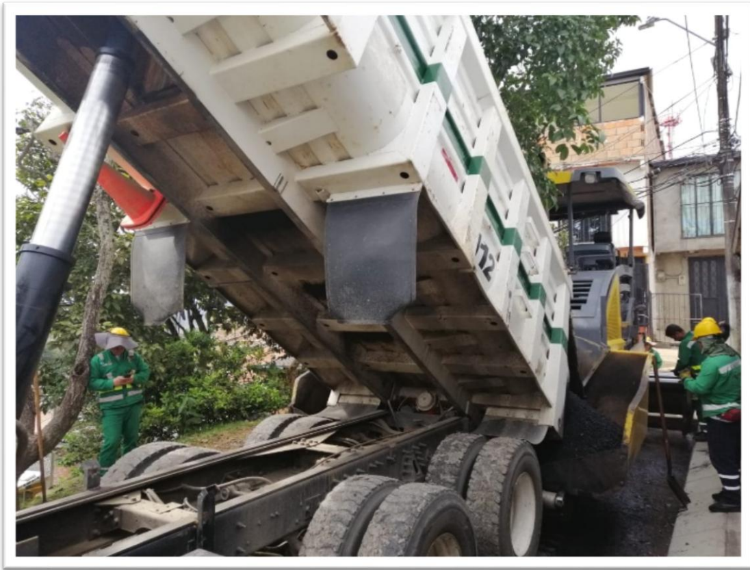
Ilustración 45. Volqueta pasando mezcla asfáltica a tolva de pavimentadora en el Barrio Santa Fe Fuente: Elaboración propia
