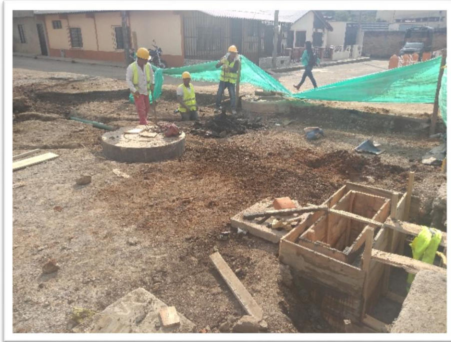
Ilustración 34. Construcción de recamara y sumideros en Deán
