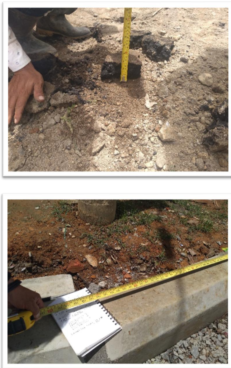
Ilustración 37. Medición de espesor de carpeta asfáltica demolida en el Barrio Junín y medición de sardinel prefabricado instalado en el Barrio Santa Fe
