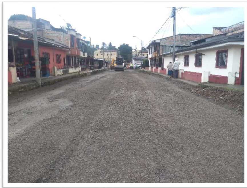
Ilustración 31. Colocación de la capa de subbase en el tramo Santa Fe y compactación en el tramo Deán
