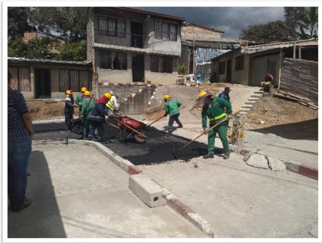
Ilustración 50. Pavimentación manual de calle adyacente en el Barrio Los comuneros
