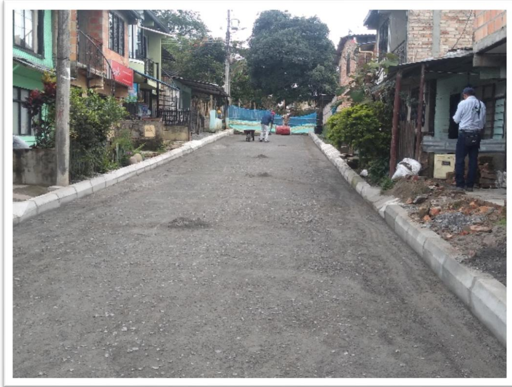
Ilustración 41. Barrido en el tramo Germania para posterior imprimación
