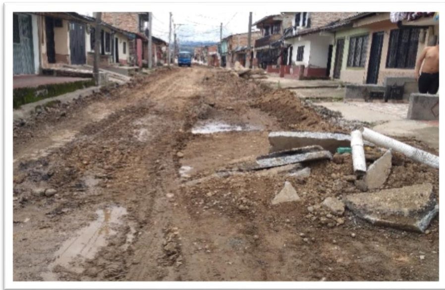
Ilustración 17. Demolición de reductor de velocidad Barrio Junín
