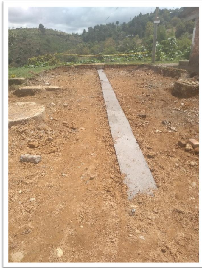
Ilustración 19. Recubrimiento en concreto en tubería de alcantarillado, Barrio Las veraneras
