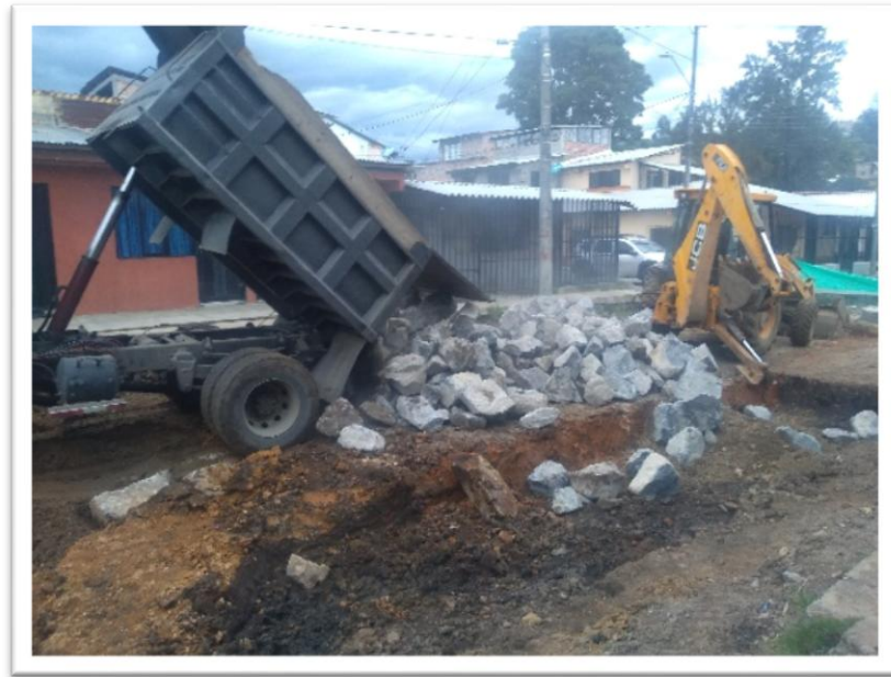
Ilustración 26. Estabilización de suelo de subrasante con pedraplen, geotextil y “Roca Muerta” en Nuevo Japón – Los comuneros y Deán
