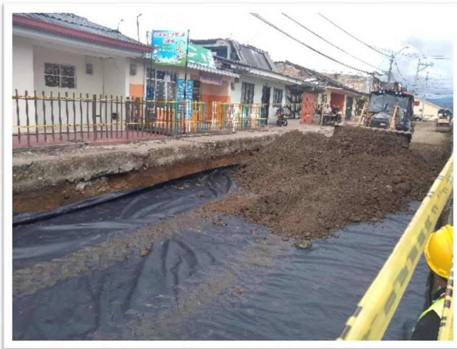
Ilustración 30. Colocación de geotextil con su respectivo traslapo y “Roca Muerta” en el tramo del Barrio Junín
