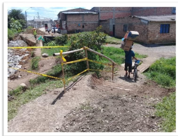
Ilustración 13. Puente peatonal construido en el tramo Nuevo Japón – Los Comuneros
