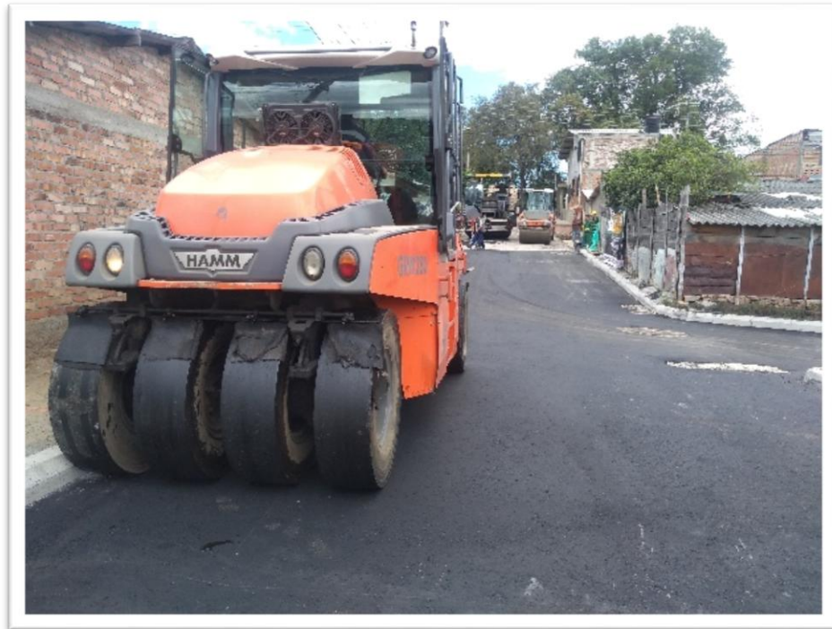
Ilustración 47. Compactador de rodillo liso y compactador de rodillos neumáticos en acción, en los tramos Los Comuneros y Las veraneras respectivamente
