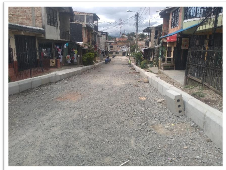
Ilustración 35. Colocación de los prefabricados tipo rampa en Santa Fe y Barrio Germania con los prefabricados colocados completamente
