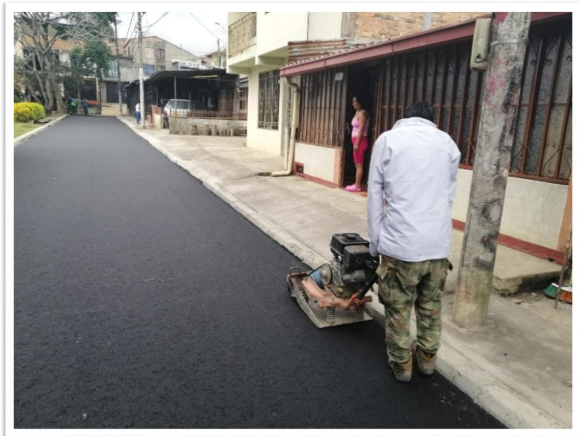
Ilustración 48. Operario compactando bordes con placa vibratoria en el tramo Santa Fe
