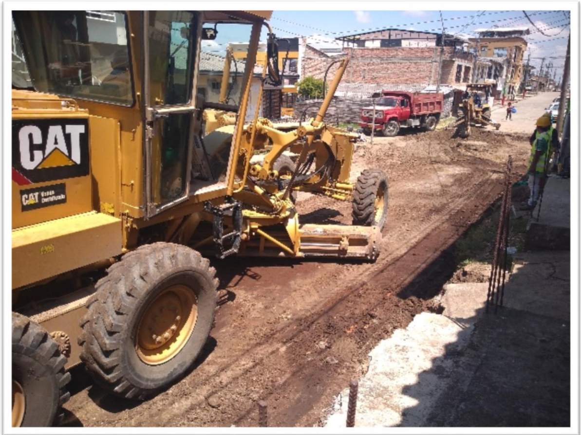
Ilustración 22. Trabajos de conformación de la subrasante en el Barrio Los Comuneros
