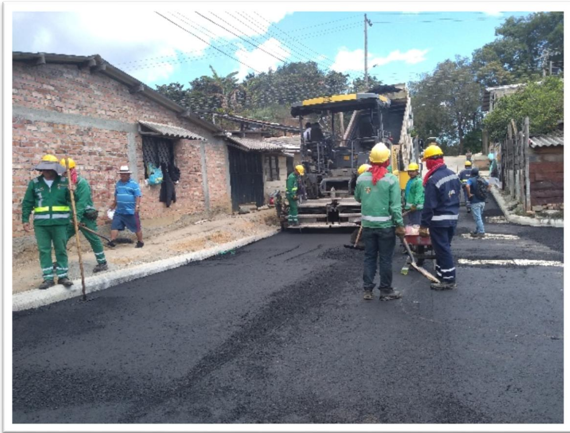
Ilustración 46. Obreros enrasando la mezcla asfáltica en el Barrio Las Veraneras Fuente: Elaboración propia
