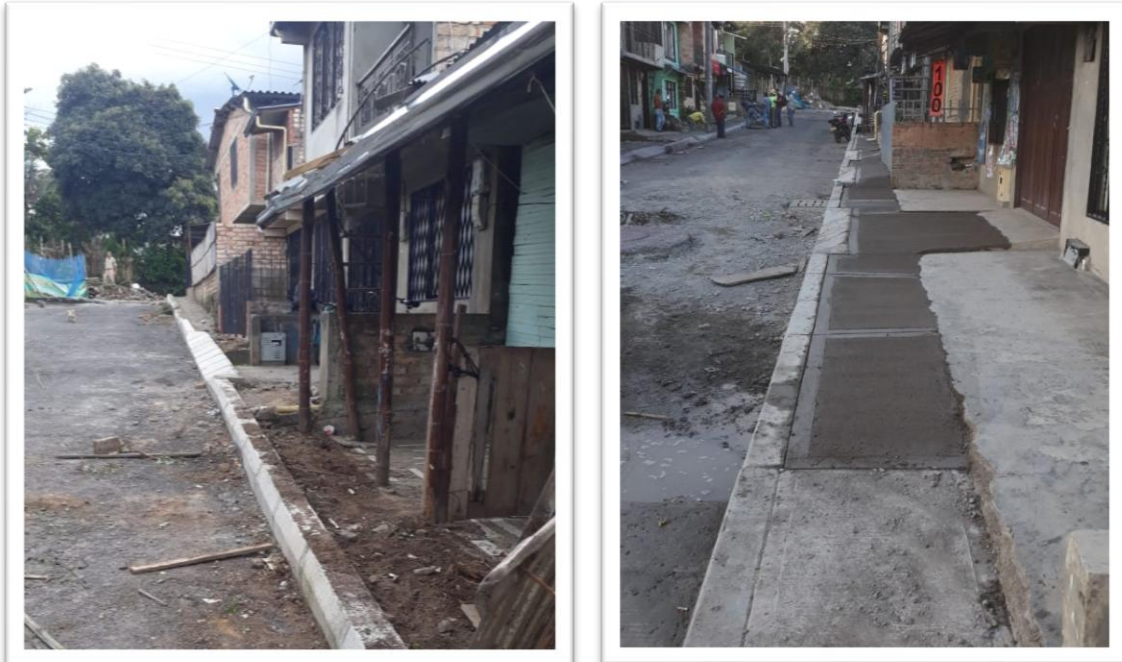
Ilustración 36. Construcción de andenes en el Barrio Germania
