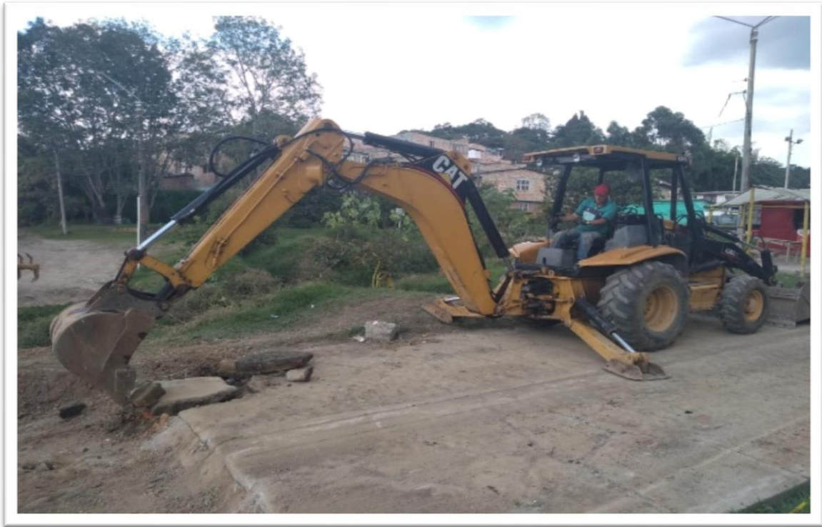
Ilustración 18. Demolición losas fisuradas en el tramo Nuevo Japón – Los Comuneros
