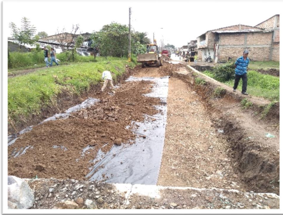
Ilustración 29. Colocación de geotextil y “Roca Muerta” en Nuevo Japón – Los Comuneros
