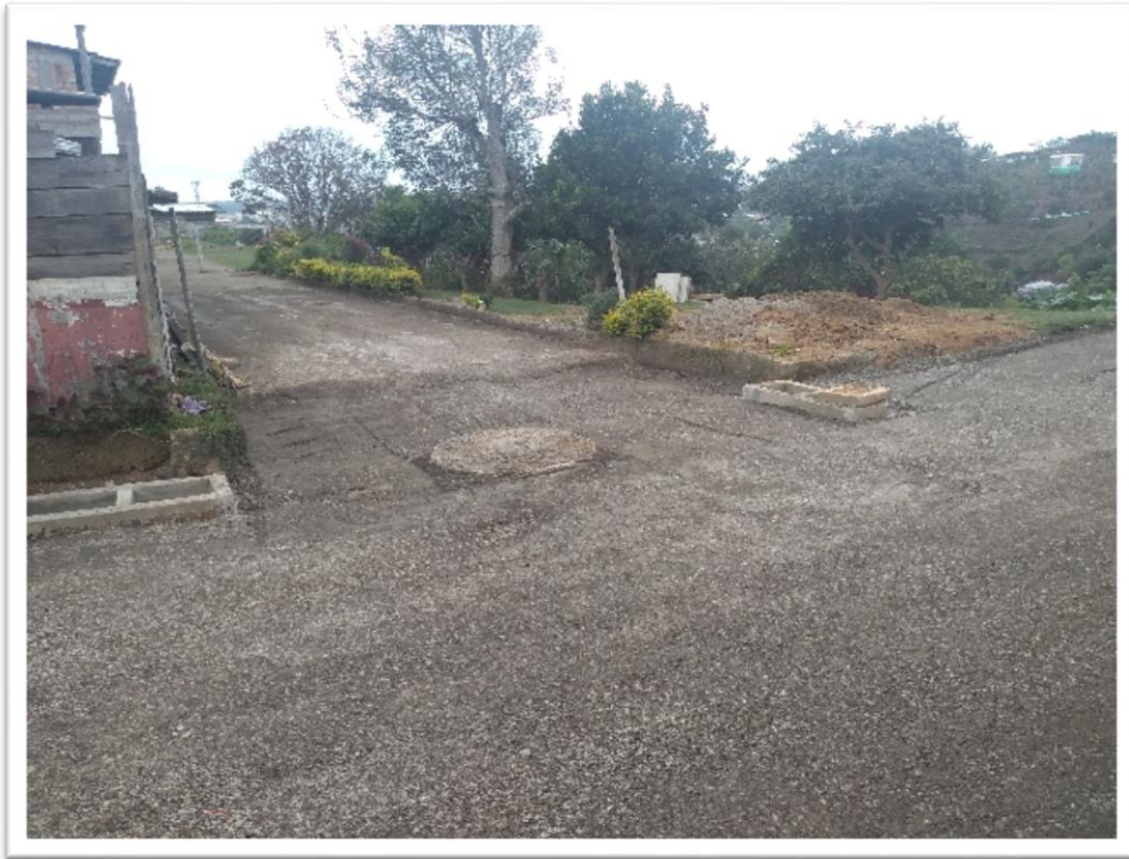
Ilustración 32. Tramo del Barrio Las Veraneras con subbase. La cámara y el sumidero no permiten trabajar con maquinaria
