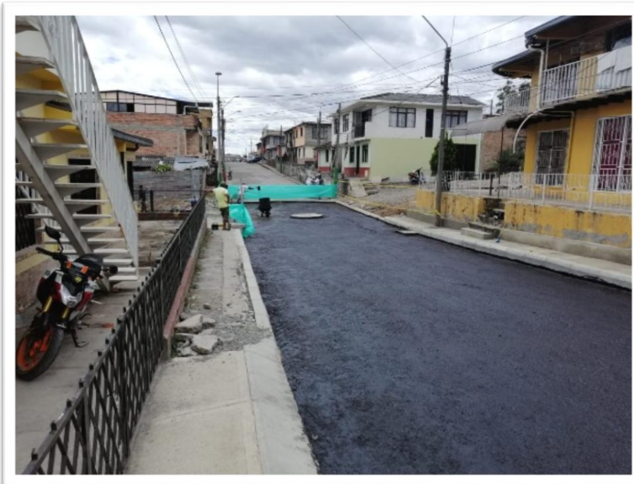
Ilustración 42. Inicio de imprimación manual en el Barrio Germania e imprimación manual finalizada en el Barrio Los Comuneros
