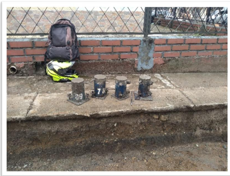
Ilustración 33. Construcción de Recamara y toma de muestras de concreto en el Barrio Los Comuneros
