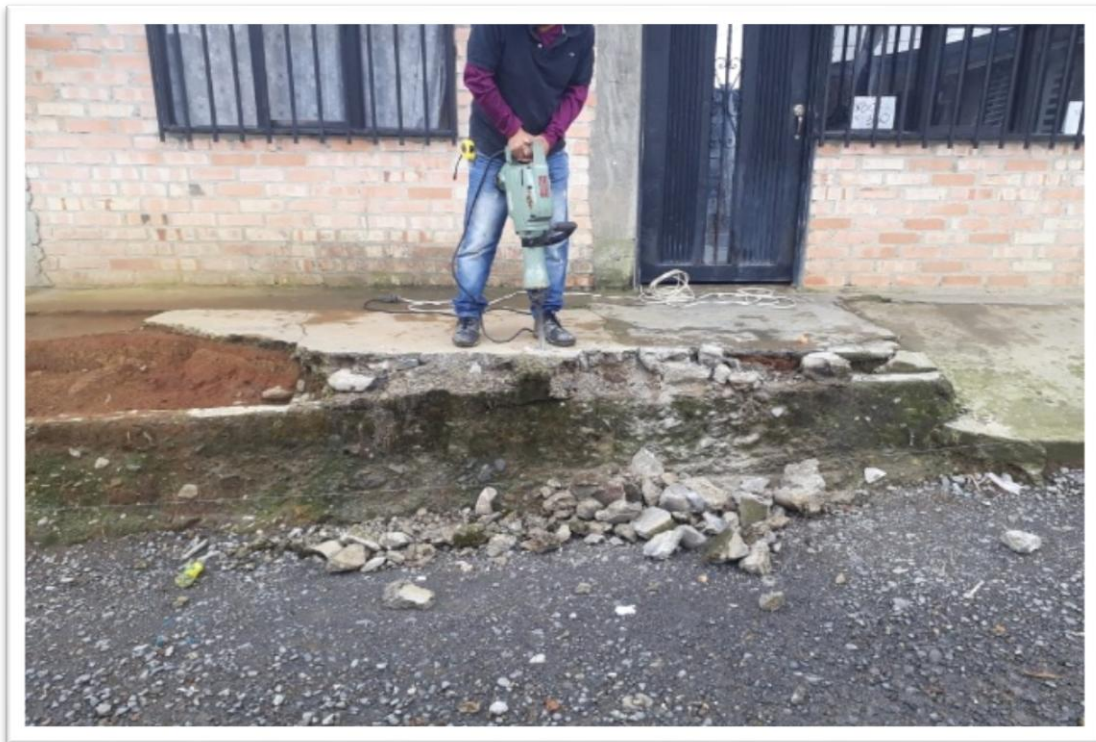
Ilustración 16. Demolición de andenes y sardineles en mal estado, Barrio Las Veraneras
