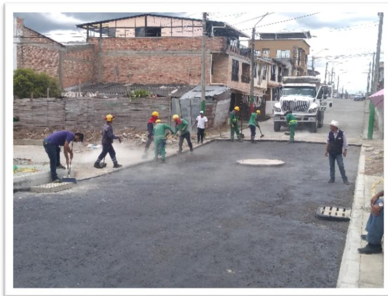
Ilustración 43. Limpieza anterior a pavimentación en los Barrios Santa Fe y Los Comuneros
