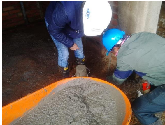
Ilustración 24 Realización de slump para torta de losa - foto del autor
