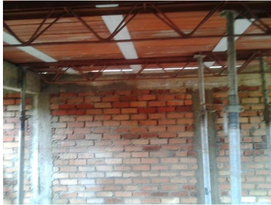
Ilustración 17 Apuntalamiento de los perfiles- foto de Michael Hurtado
