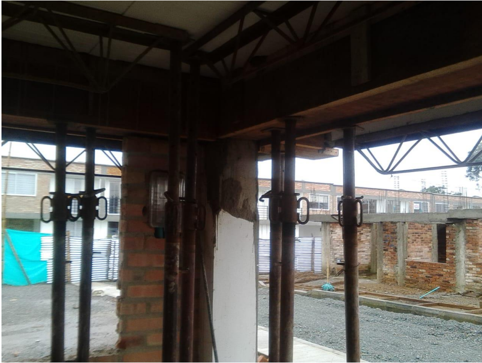
Ilustración 67 Formateado de vigas - foto del autor
