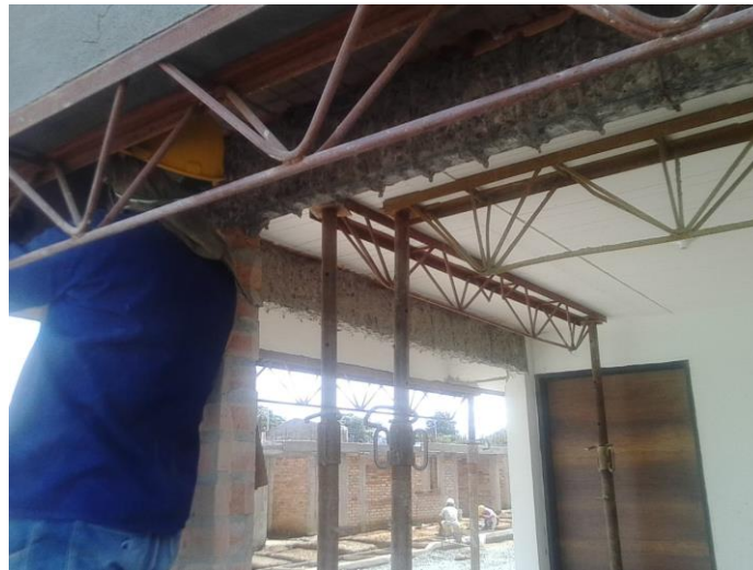
Ilustración 63 Escarificación de vigas - foto del autor
