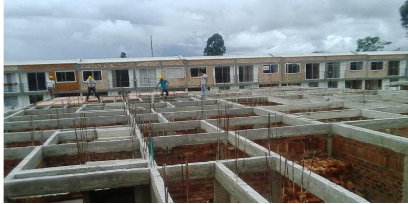
Ilustración 26 Vigas de entrepiso proyecto de caminos-autor Michael hurtado
