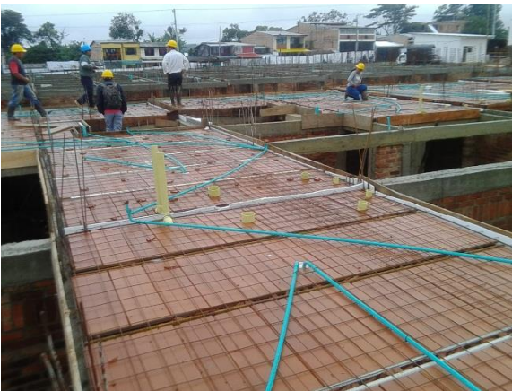
Ilustración 22 Colocación tubería electrica -foto del autor
