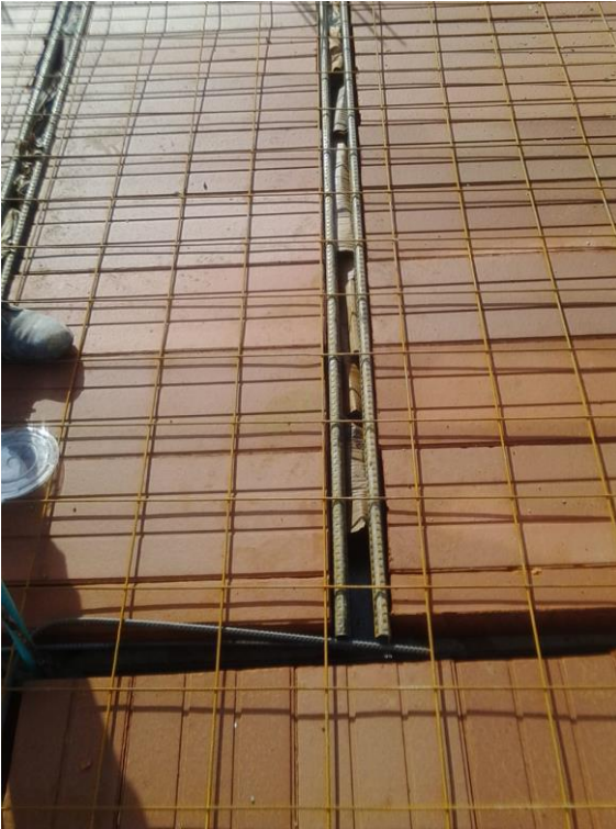
Ilustración 20 Colocación de enmallado -foto del autor
