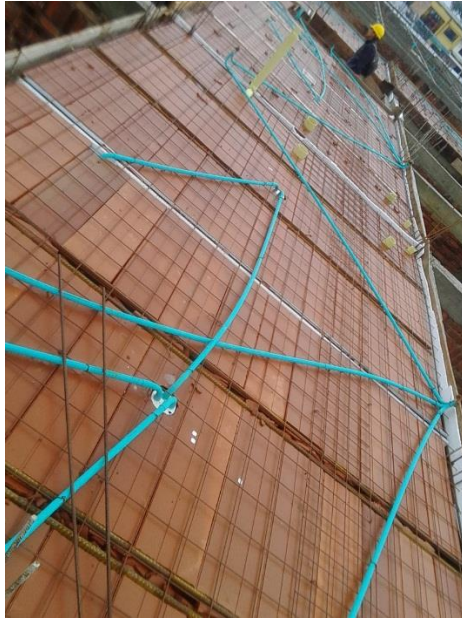
Ilustración 23B Colocación tubería eléctrica y sanitaria - foto del autor
