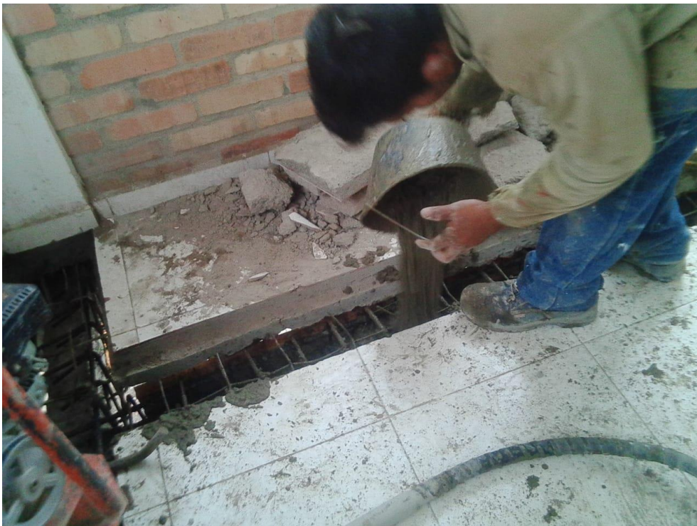
Ilustración 68 Fundición de vigas - foto del autor
