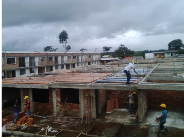
Ilustración 31 Colocación de perfiles- foto del autor
