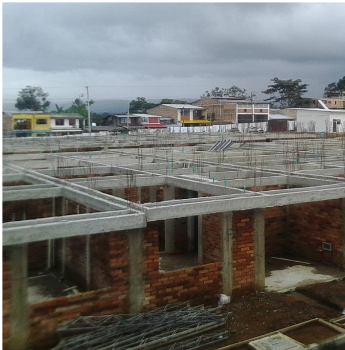
Ilustración 27 Vigas de entrepiso proyecto de caminos-autor Michael hurtado
