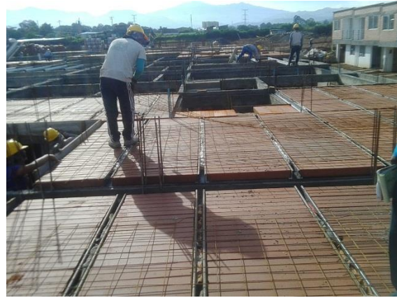
Ilustración 21 Colocación de enmallado- foto del autor
