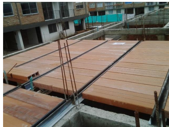
Ilustración 19 Colocación de bloquelón- foto del autor
