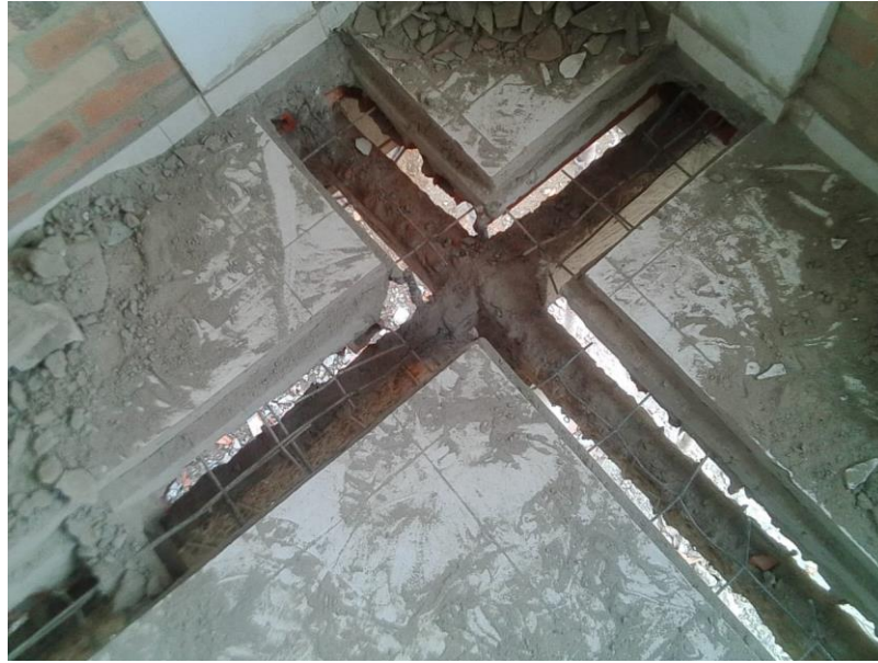
Ilustración 64 Demolición de placa fácil - foto del autor
