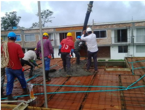
Ilustración 27 Fundición de losa -foto del autor
