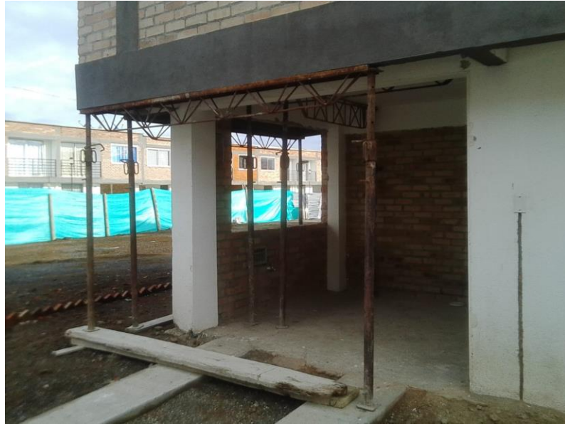
Ilustración 62 Alizaprimada de casa E12 - foto del autor
