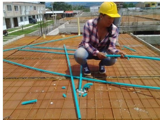
Ilustración 23A Colocación tubería electrica - foto del autor
