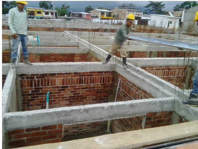
Ilustración 32 Colocación de perfiles- foto del autor
