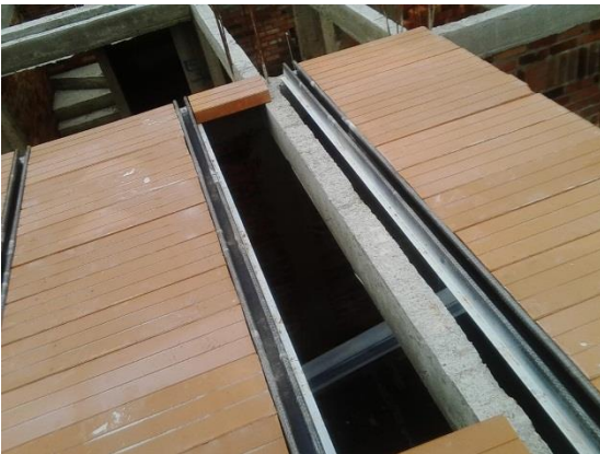
Ilustración 18 Colocación de bloquelón-foto del autor
