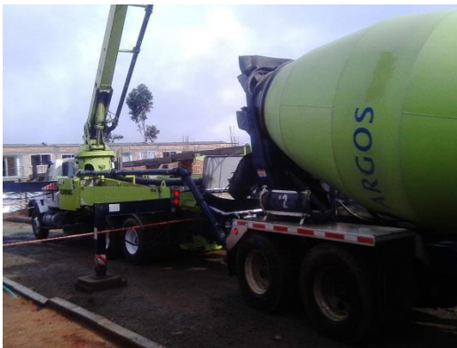
Ilustración 25 Fundición de losa -foto del autor
