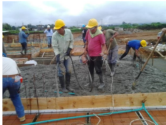
Ilustración 28 Fundición de losa - foto del autor
