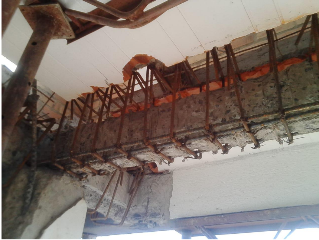
Ilustración 66 Instalación de estribos según diseño - foto del autor
