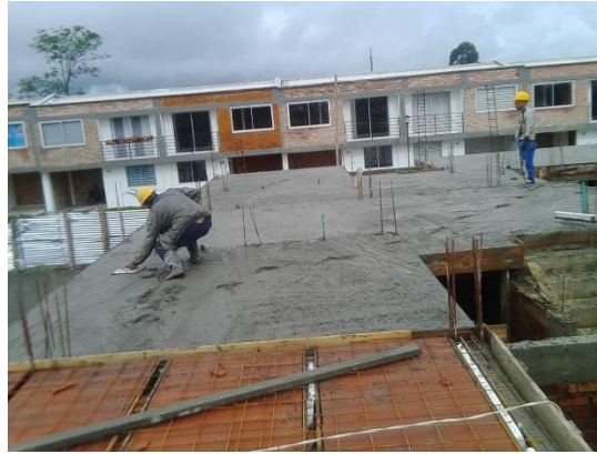
Ilustración 29 fundición de losa -foto del autor
