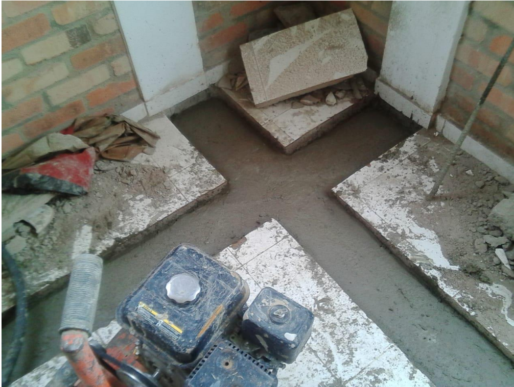
Ilustración 69 Terminado de la fundición de vigas - foto del autor
