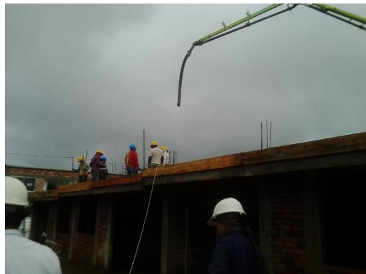
Ilustración 26 Fundición de losa - foto del autor
