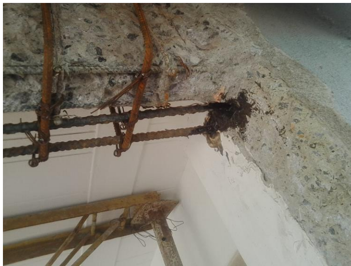
Ilustración 65 Instalación de acero y anclaje - foto del autor
