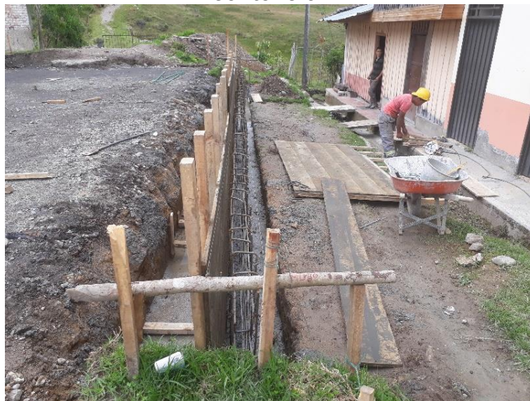
Figura 17. Detalle ítem no previsto: Acero de refuerzo para muro de contención
