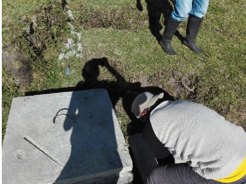
Figura 50. Inspección de la construcción de tanques de almacenamiento
