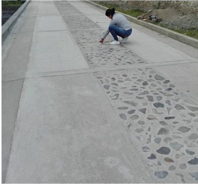
Figura 35. Detalle de inspección de obra
