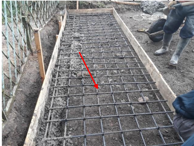
Figura 26. Acero de refuerzo para placas ( f_y=420 Mpa)
