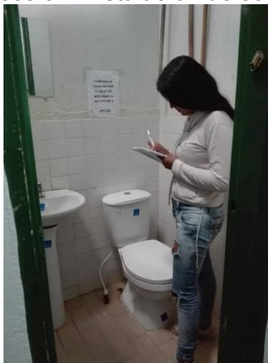
Figura 45. Inspección- instalación de combos sanitarios
