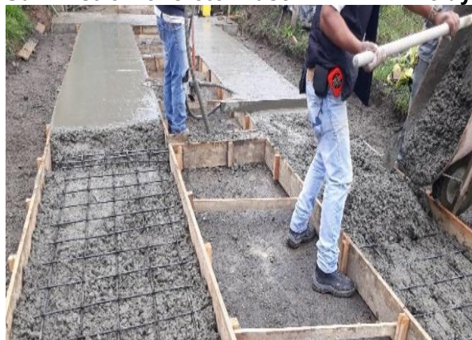
Figura 27. Suministro Concreto Clase D 21 MPA incluye formaleta
