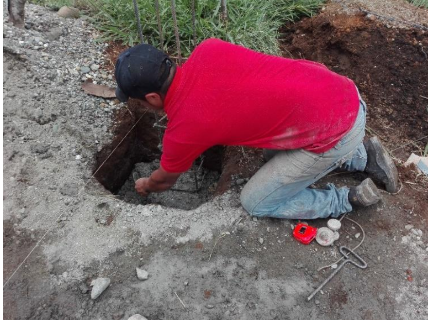
Figura 56 Inspección de obra - Zapatas
