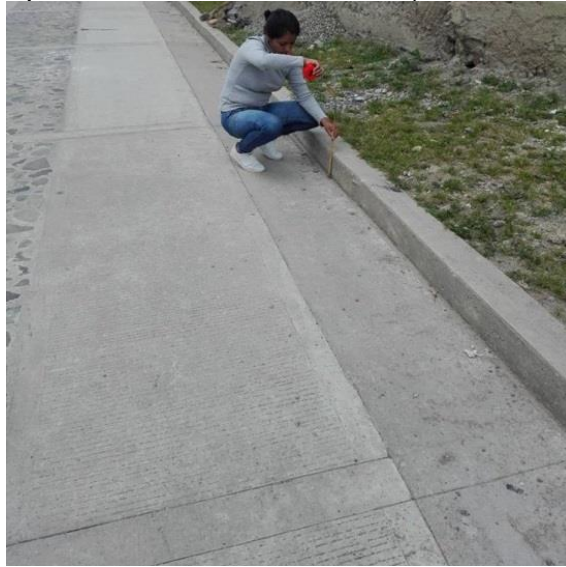
Figura 29. Detalle inspección Concreto Clase D (Sardinel 0.35 m x 0.15 m)
