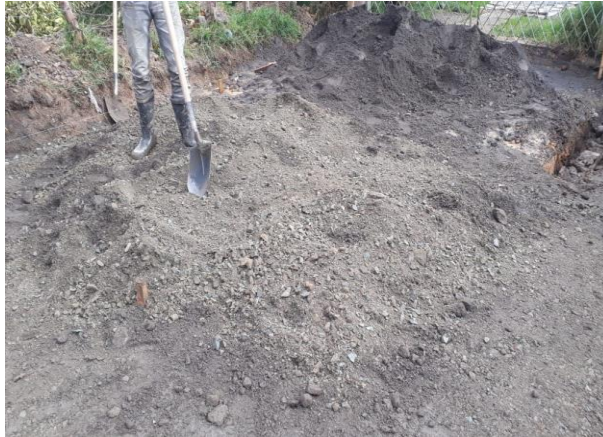
Figura 24. Mejoramiento de la subrasante con adición de material granular
