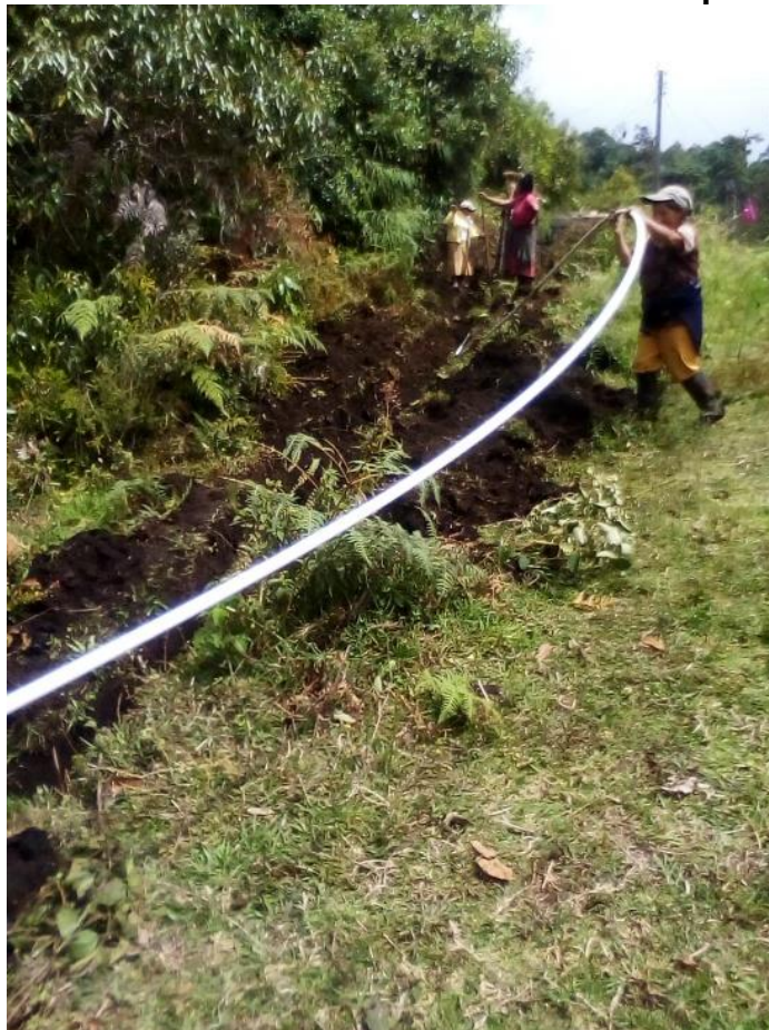
Figura 51. Evidencia de la instalación de tubería PVC a presión 1" RDE 21.
