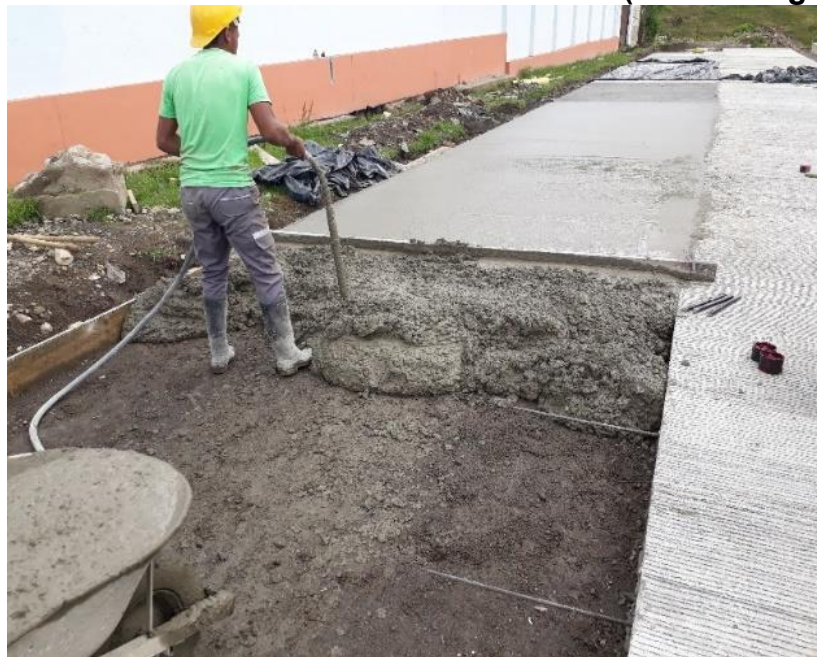
Figura 9. Pavimento de Concreto Hidráulico (MR = 40 Kg/cm 2 )
