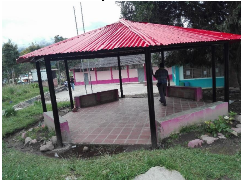
Figura 43. Detalle del mejoramiento de cubierta de Kiosco
