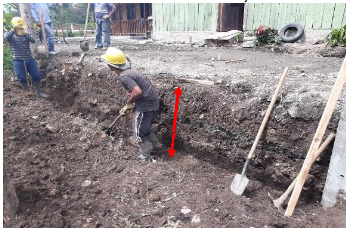
Figura 23. Excavación en material común, medido en sitio.
