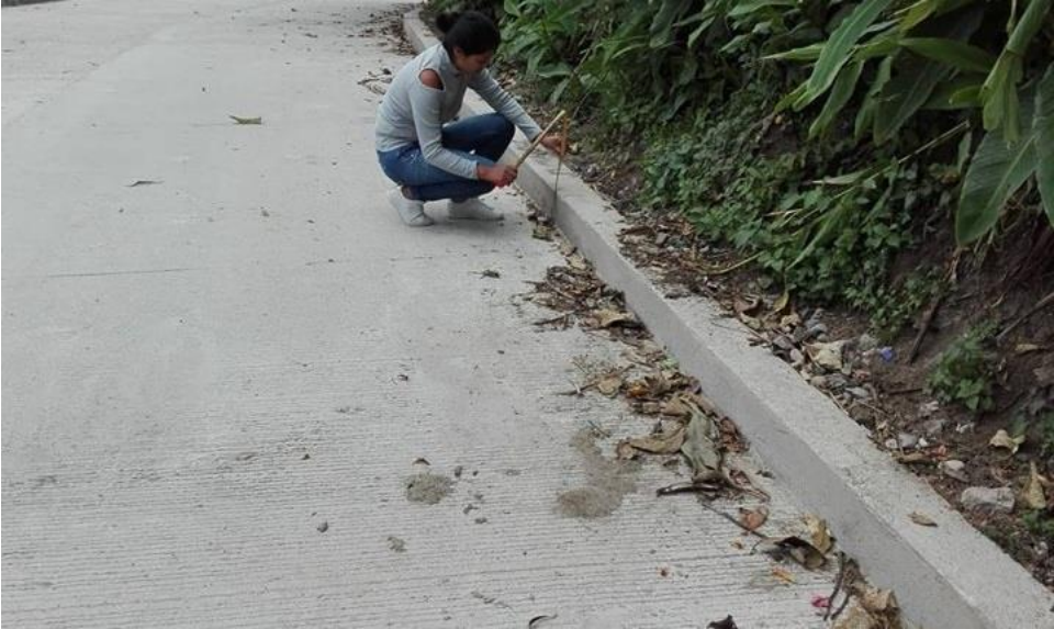
Figura 19. Detalle pavimento rígido en la Cra 3 entre CII 2 y CII 3
