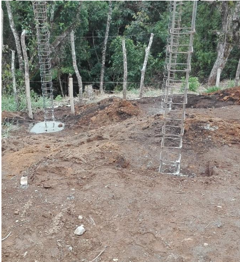
Figura 57. Inspección refuerzo de columnas y zapatas
