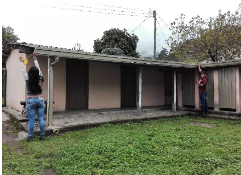
Figura 48. Inspección de canales
