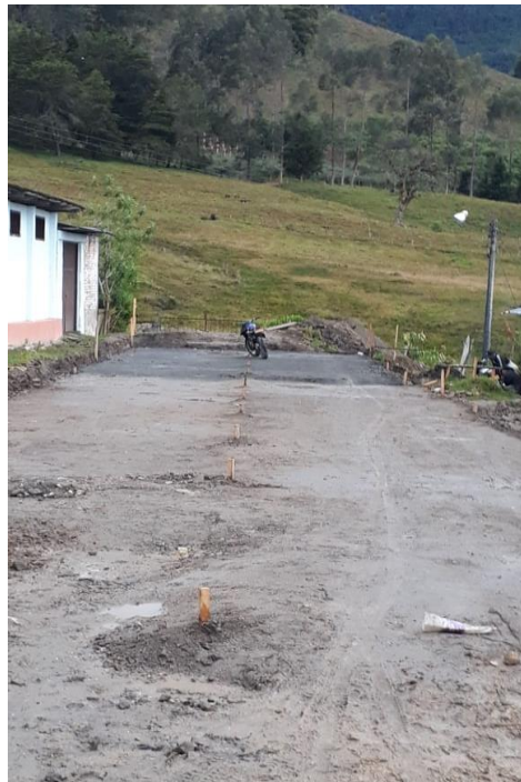
Figura 7. Mejoramiento de la subrasante con adición de material granular
