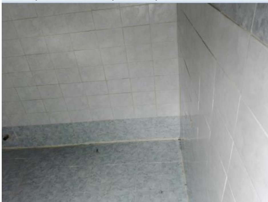
Figura 53. Inspección de enchape de tanque de almacenamiento
