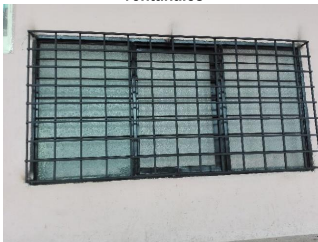
Figura 49. Inspección de instalación de reja de protección de los ventanales
