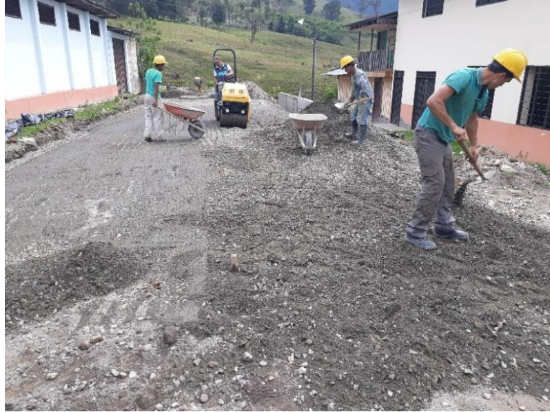
Figura 8. Suministro, riego y compactación de Base Granular
