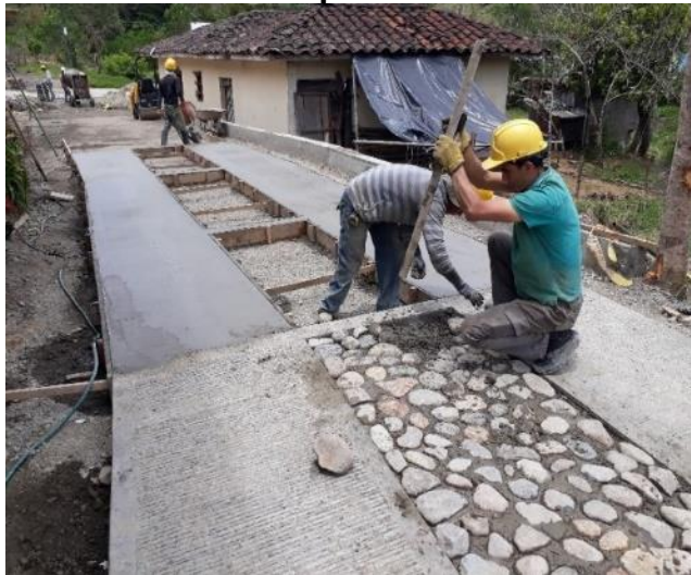
Figura 28. Concreto Ciclópeo 14 MPa Relación 60C/40P
