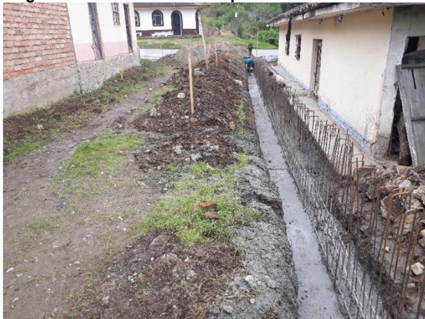
Figura 34. Acero de refuerzo para muro de contención
