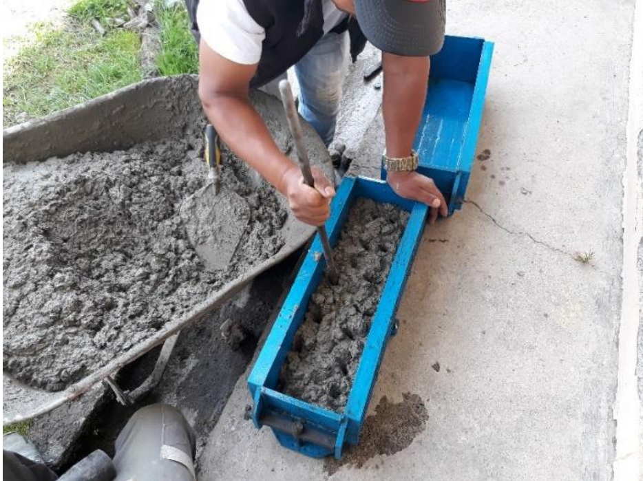
Figura 10. Detalle de la preparación de vigas para el ensayo a flexión
