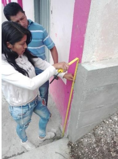
Figura 44. Inspección de muro de protección
