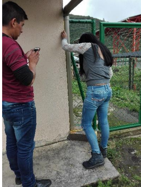
Figura 47. Inspección de obra – Medición de bajantes
