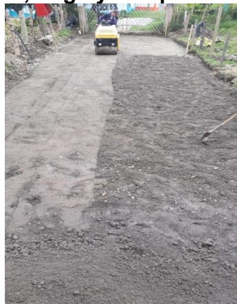
Figura 25. Suministro, riego y compactación de Base Granular
