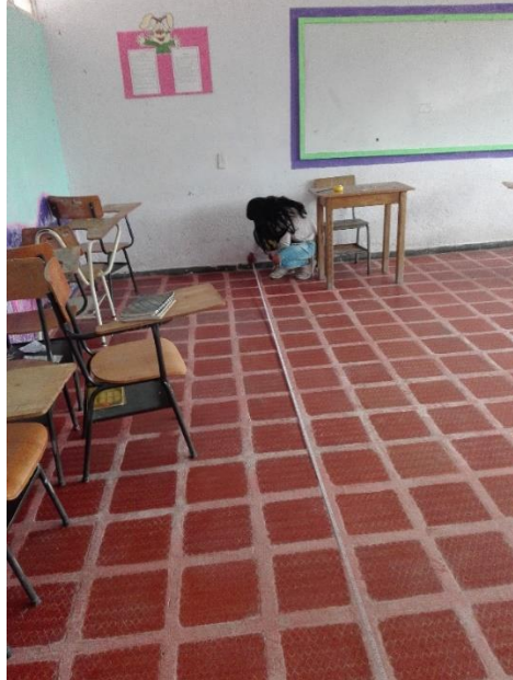
Figura 42. Reparación de juntas y enchape de piso
