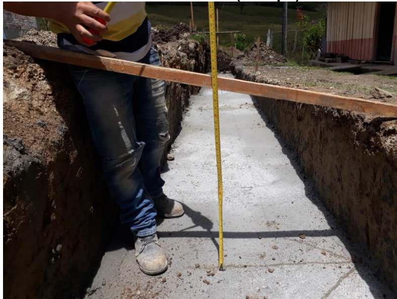
Figura 16. Detalle ítem no previsto: Solado de concreto espesor 5 cm en concreto clase F (14 Mpa)
