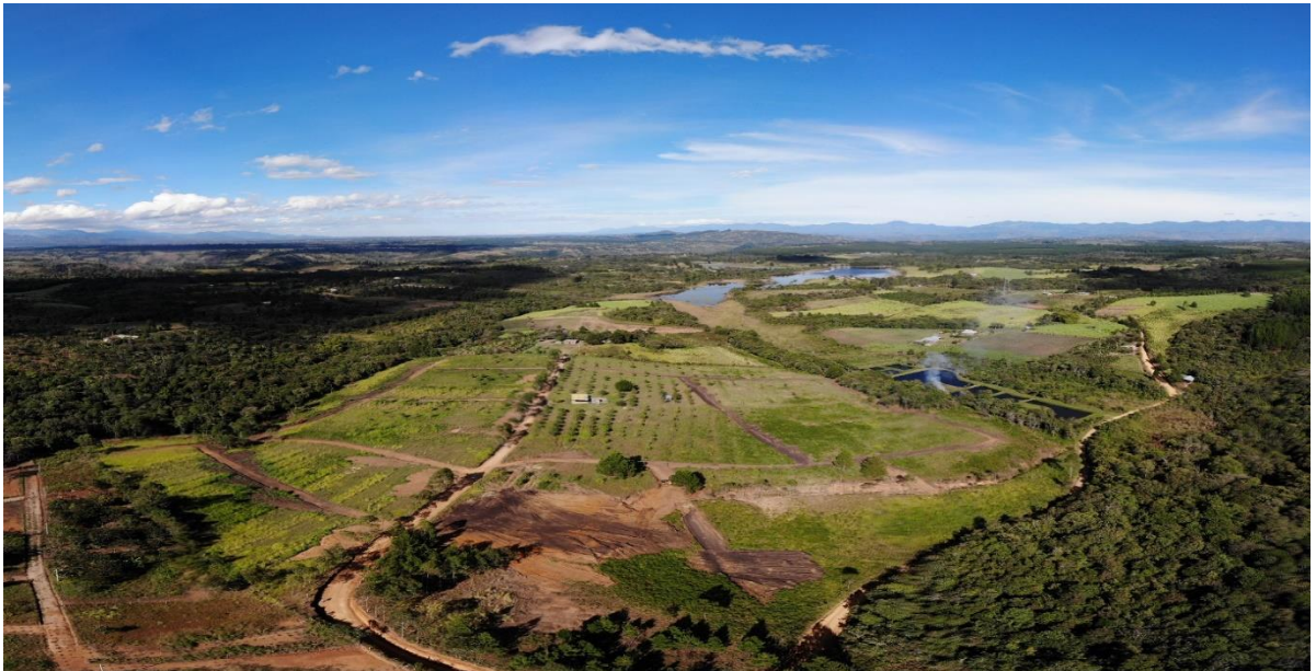
Imagen 12: Primera etapa de vías internas.
