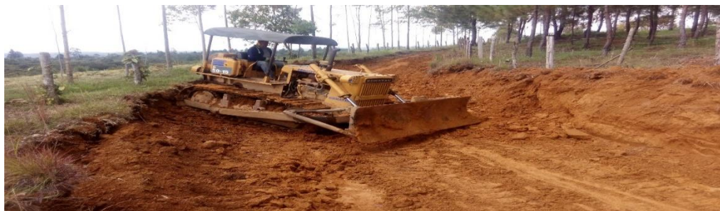
Imagen 11: Apertura de vías internas.
