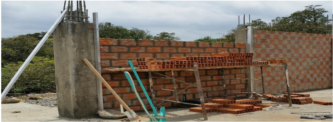
Imagen 29: Muro en mampostería.
