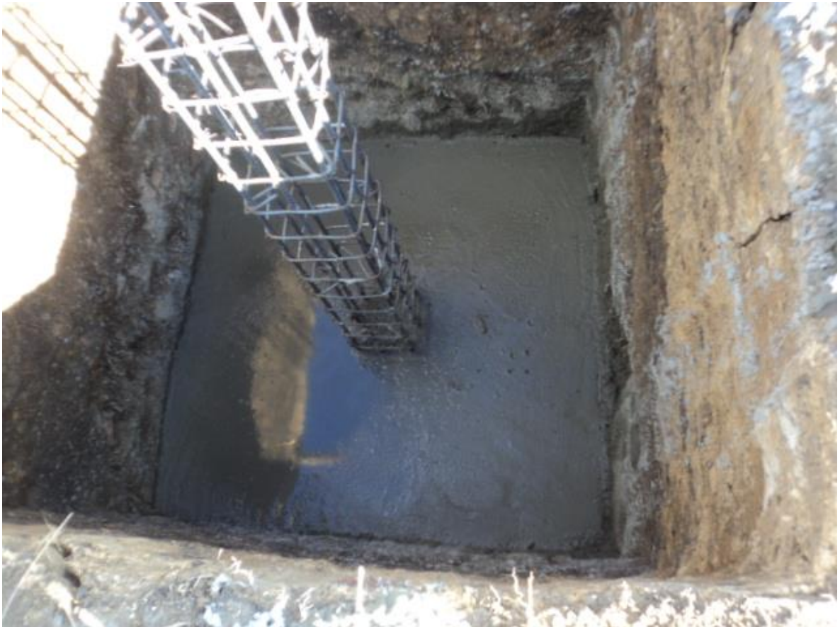
Imagen 22: Fundición de zapatas.
