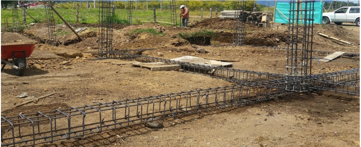
Imagen 24: Colocación de acero vigas de cimentación.
