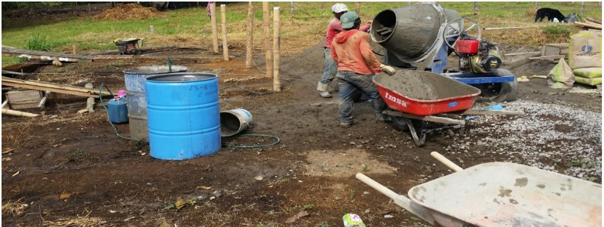
Imagen 34: Preparación del concreto.
