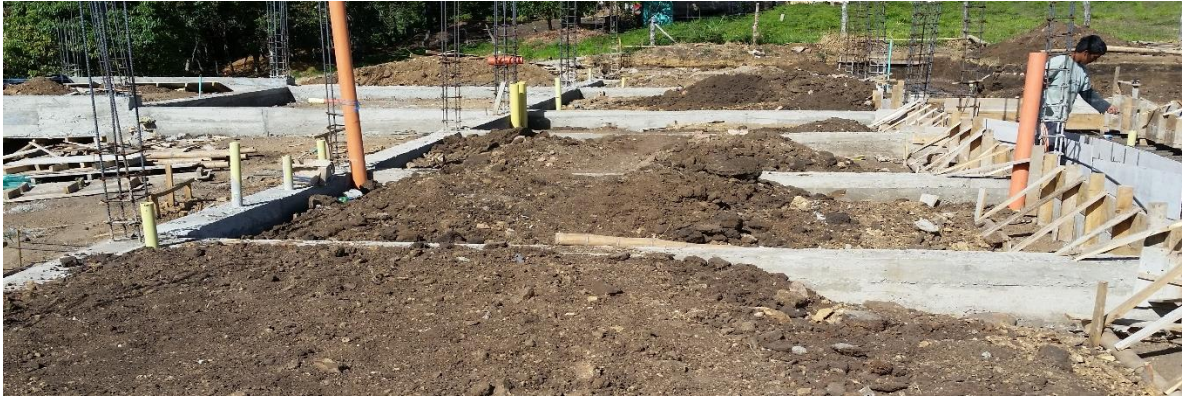
Imagen 26: Desencofrado y relleno.
