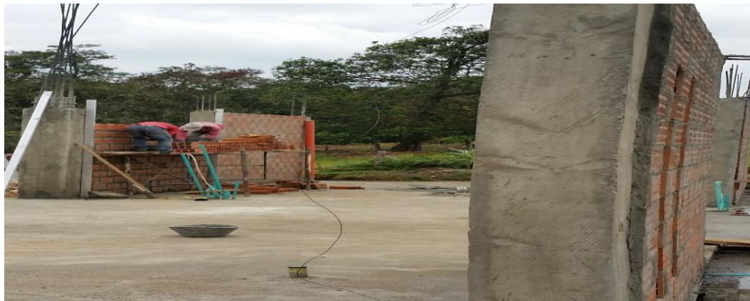
Imagen 30: Alzado de muros.
