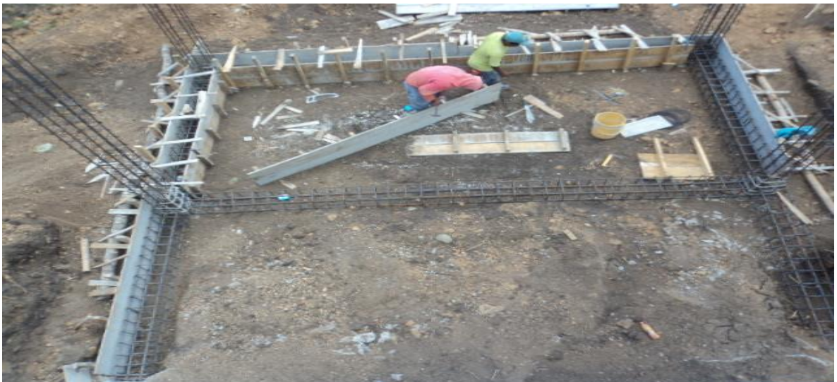
Imagen 25: Formaleta vigas de cimentación.
