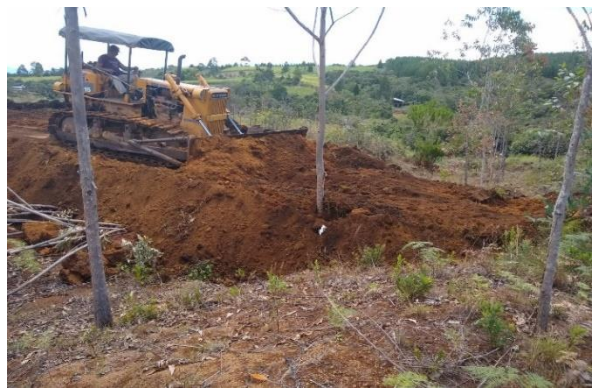
Imagen 10: Acarreo a zona de depósito
