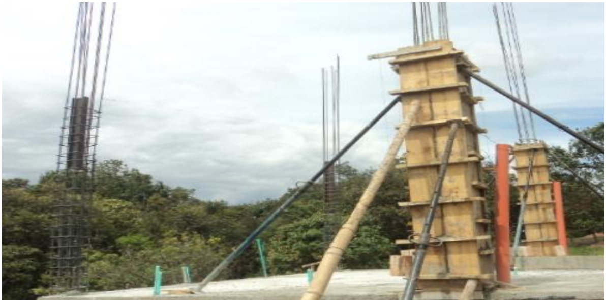
Imagen 28: Formaletas de columnas.
