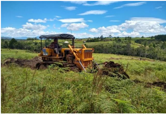
Imagen 9: Eliminación capa vegetal
