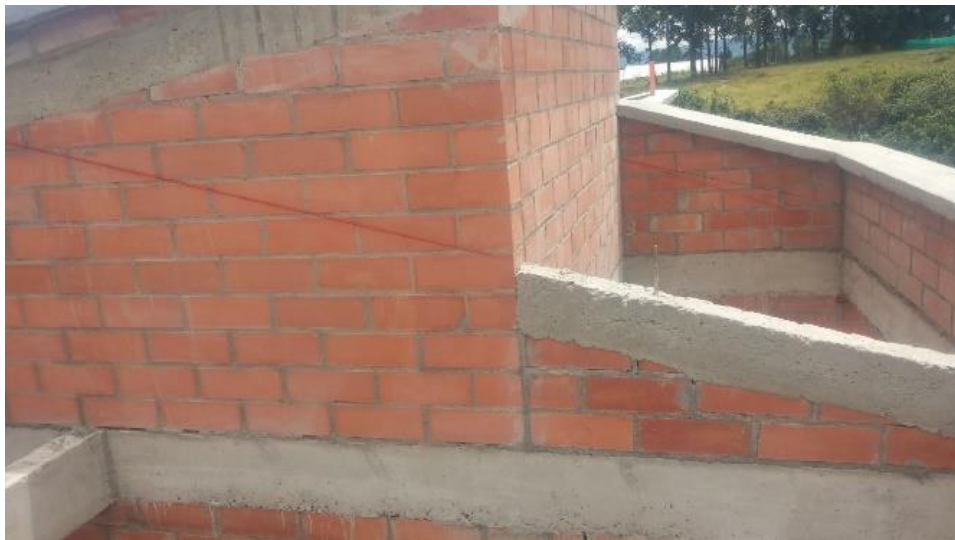
Figura No. 37. Cimbra para cubierta
