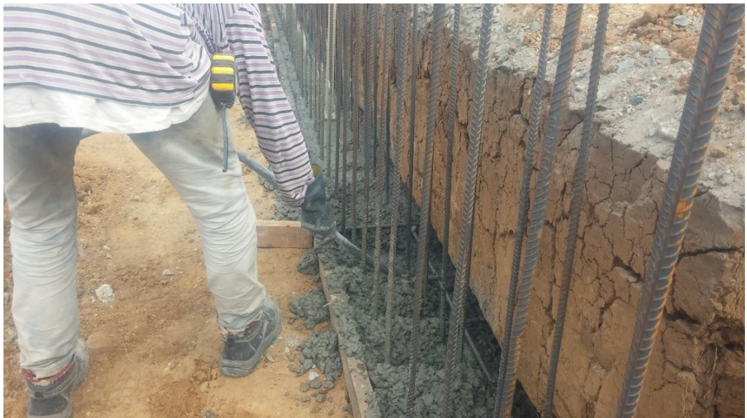
Figura No. 8. Fundición zapata corrida de muro de contención
