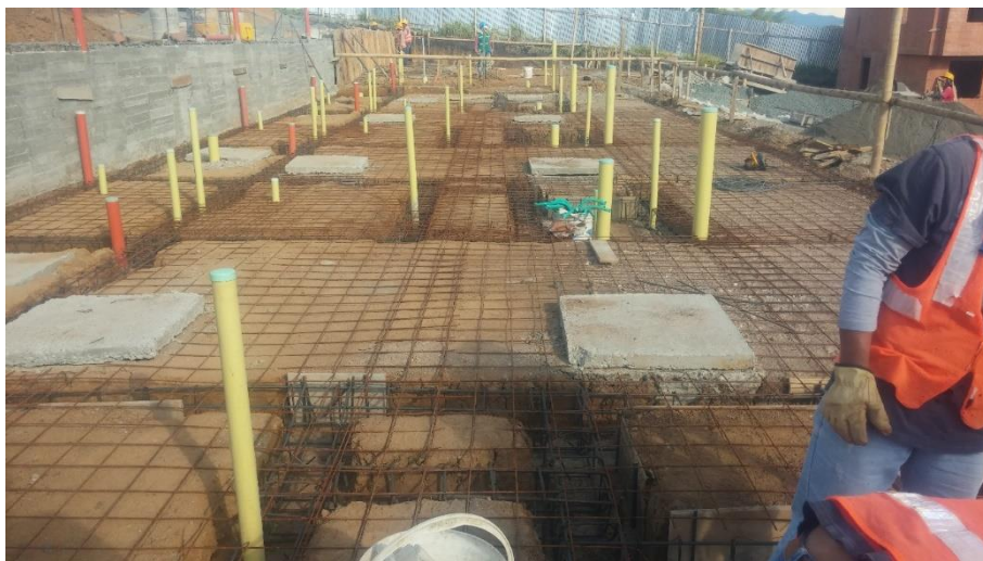
Figura No. 17. Losa de cimentación lista para fundición
