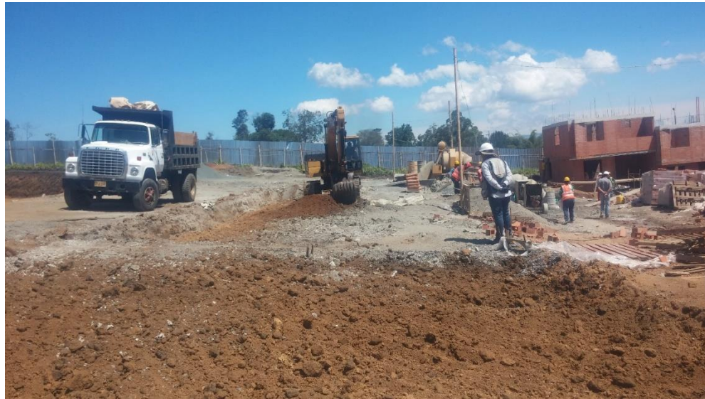
Figura No. 5. Nivelación de terreno para casas
