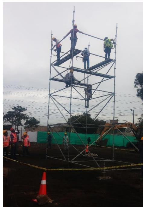
Figura No. 58. Montaje andamio certificado
