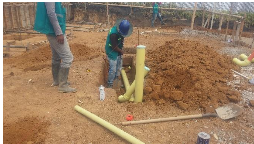
Figura No. 13. Instalación tubería sanitaria
