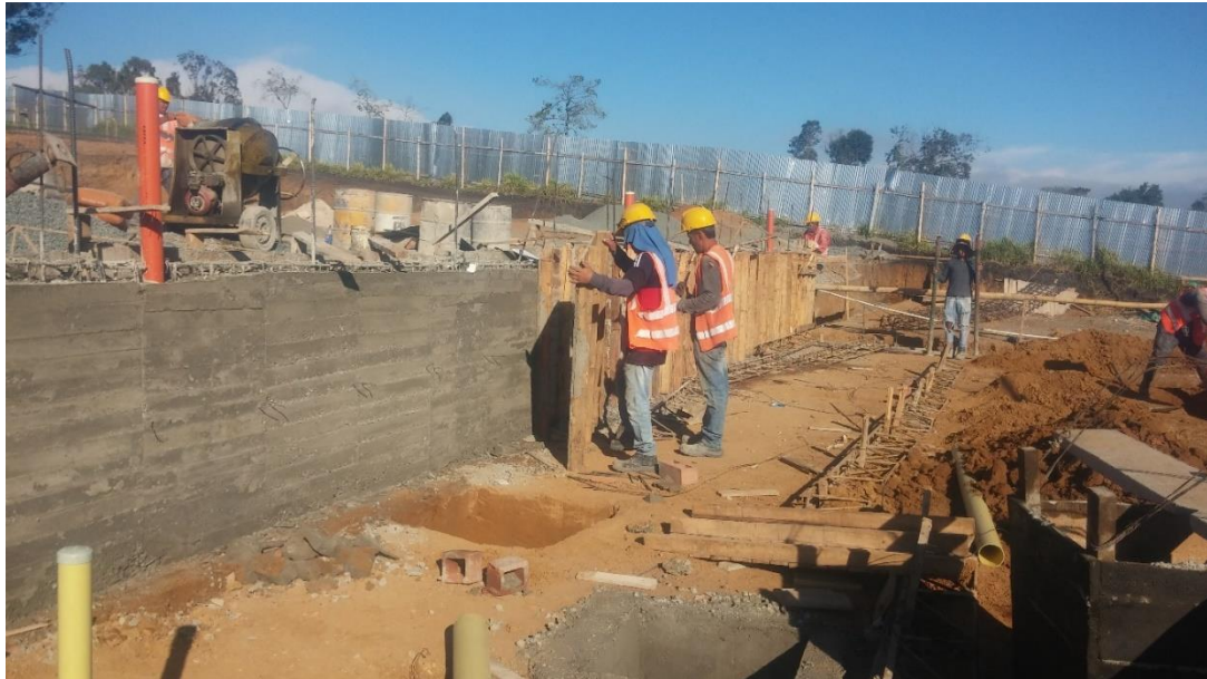
Figura No. 10. Desmontaje de formaleta muro de contención
