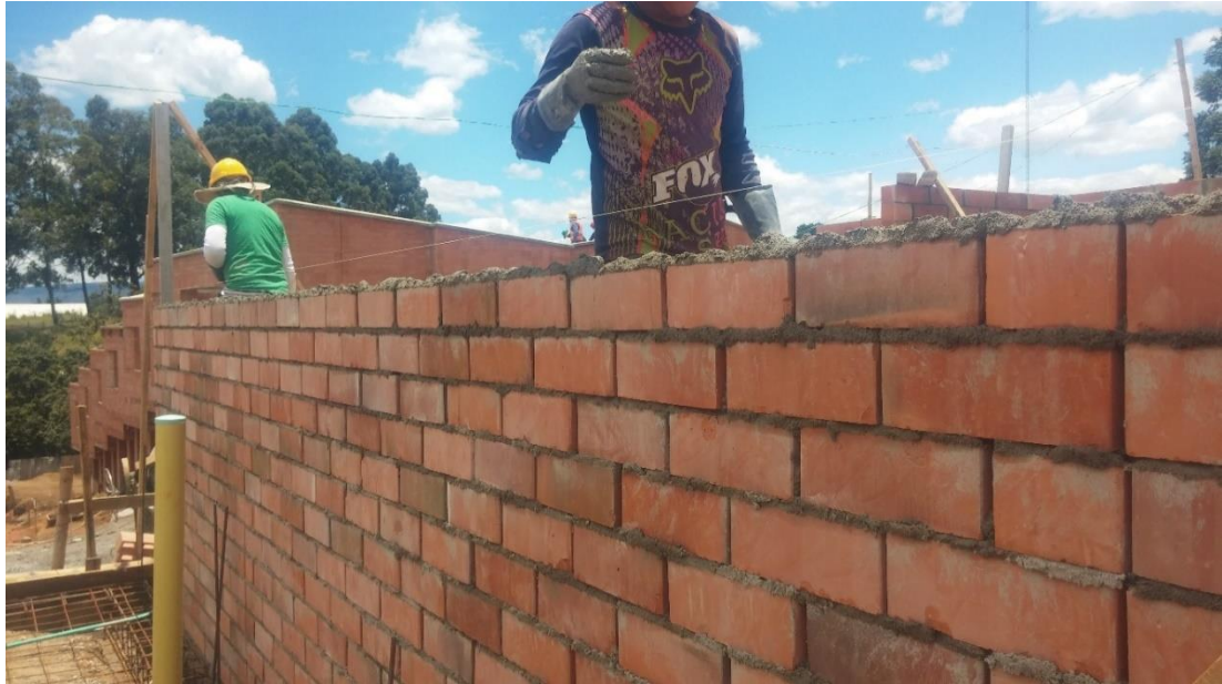
Figura No. 23. Levantamiento muro de mampostería estructural
