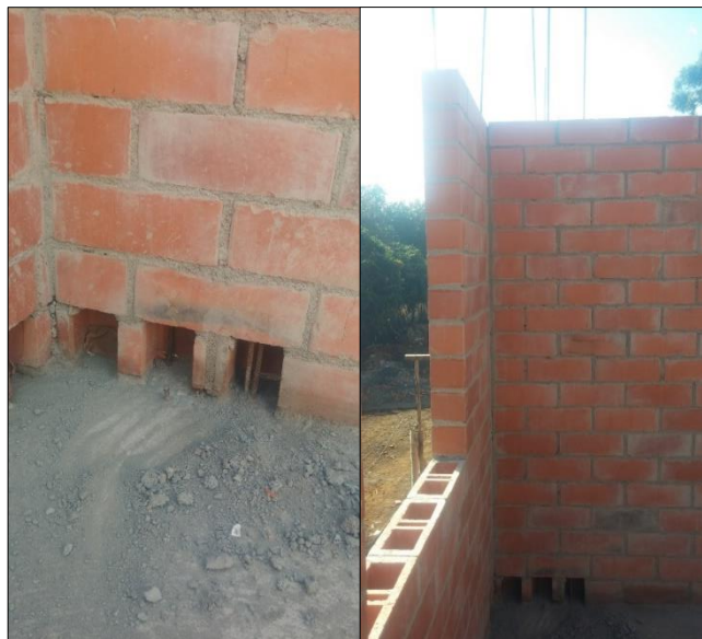
Figura No. 25. Revisión de limpieza y acero de devalas
