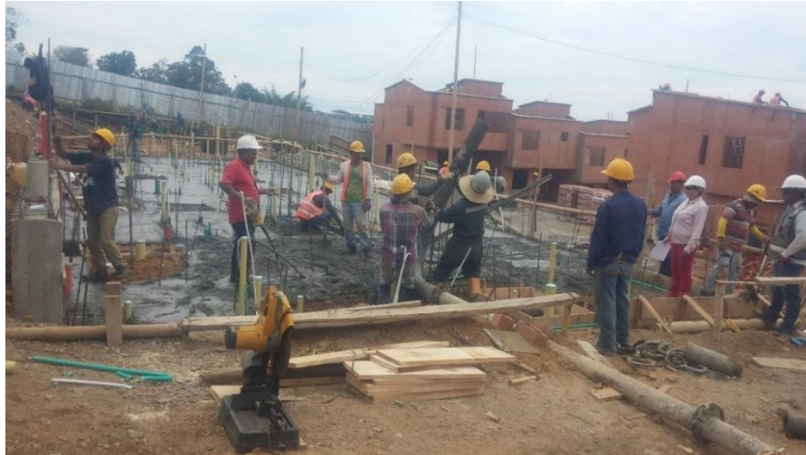
Figura No. 18. Fundición losa de cimentación
