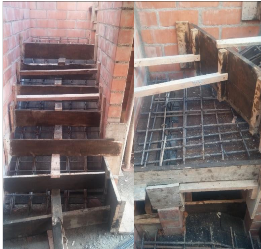
Figura No. 27. Revisión de escaleras
