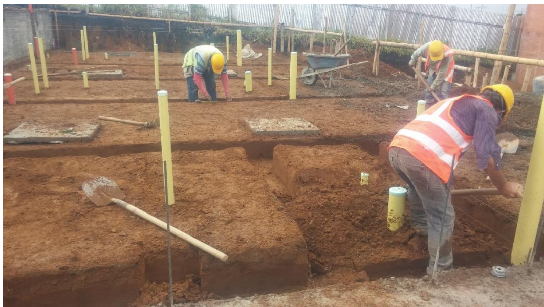
Figura No. 15. Excavación para vigas de cimentación
