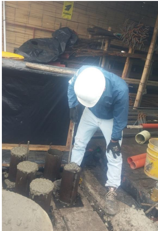
Figura No. 47 Elaboración de cilindros de concreto
