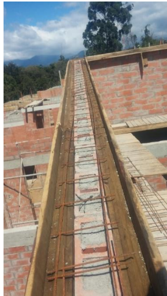
Figura No. 32. Revisión de alfajías
