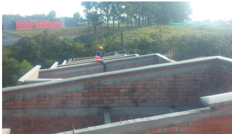
Figura No. 33. Alfajías terminadas
