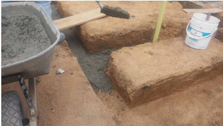
Figura No. 16. Solado para limpieza de vigas de cimentación
