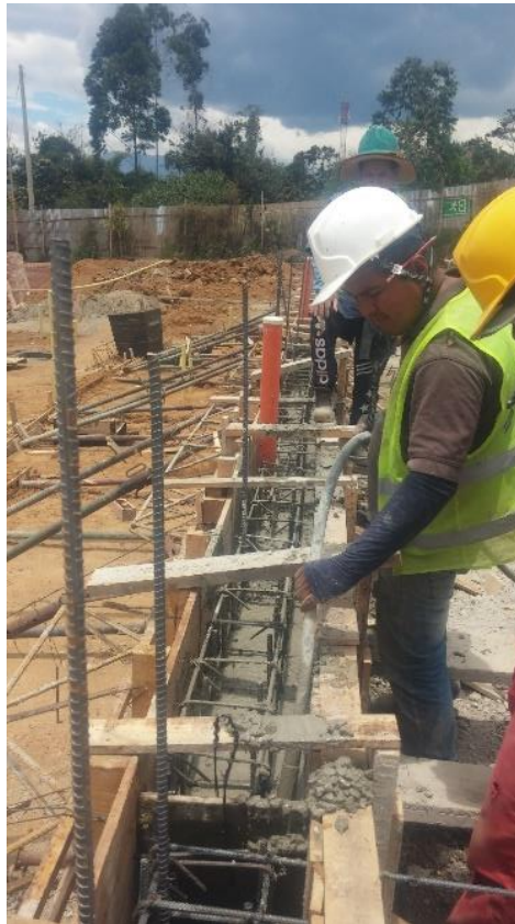
Figura No. 9. Proceso de fundición y vibrado muro de contención
