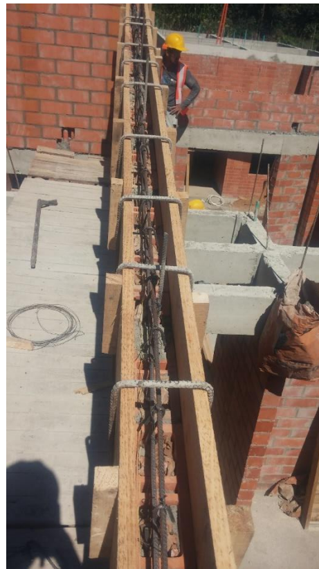
Figura No. 31. Revisión cinta de remate
