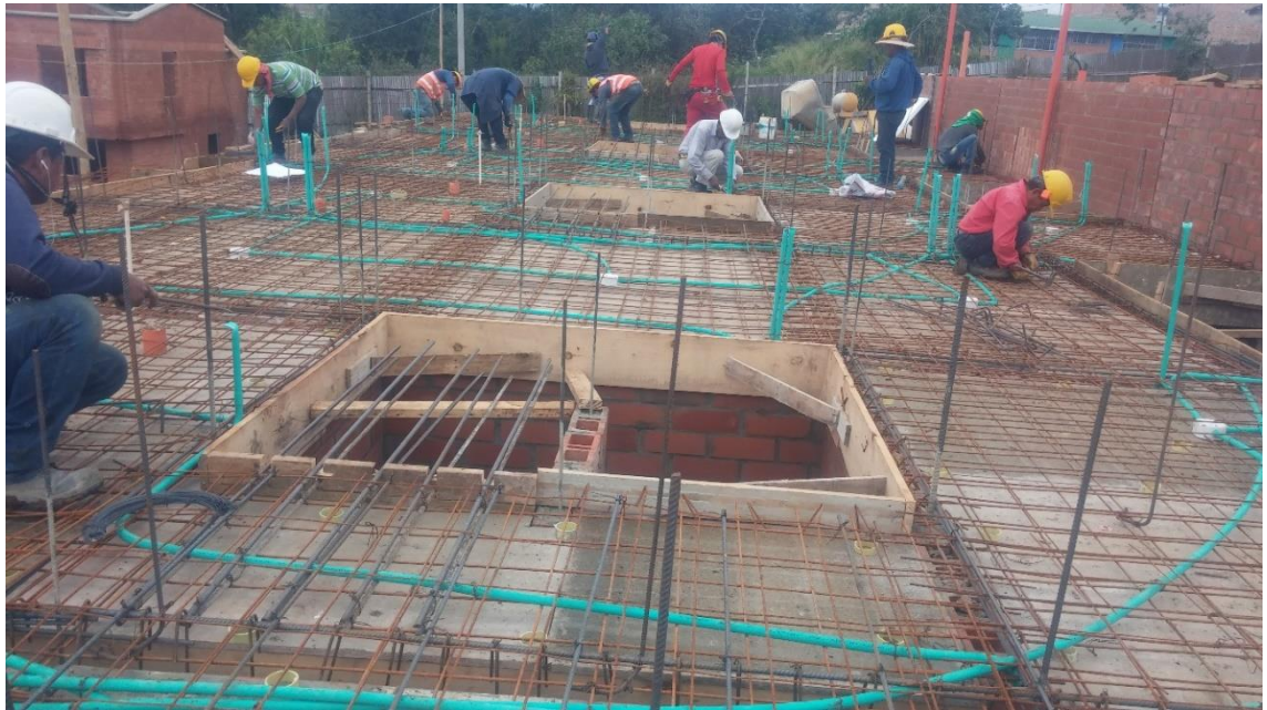
Figura No. 29. Preparación losa de entrepiso para fundición
