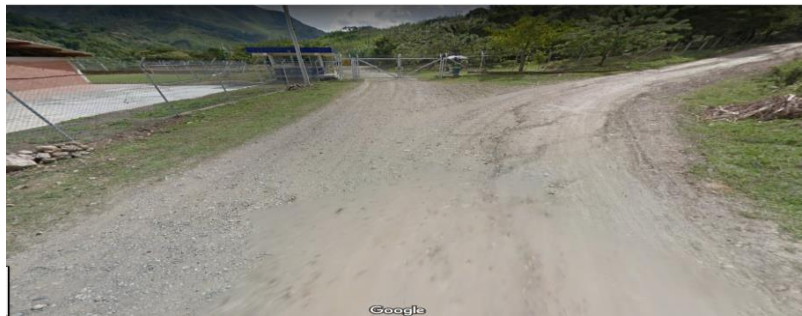
Ilustración 1 Inicio obras de pavimentación
