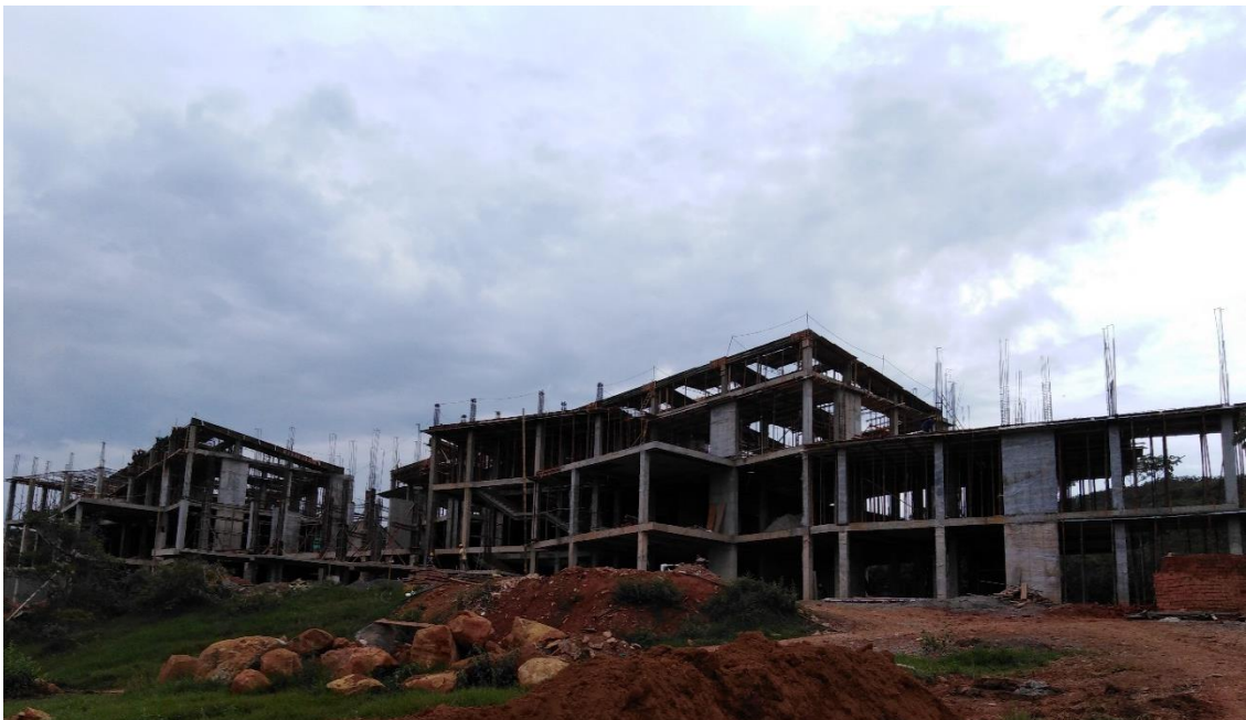
Ilustración 31. Vista bloque 2 y batería sanitaria 2 Fuente propia
