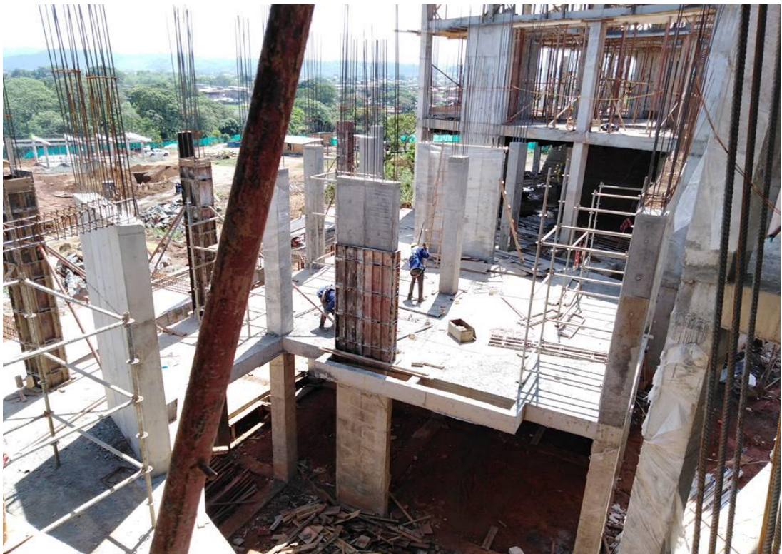
Ilustración 33. Avance batería sanitaria 1 Fuente propia
