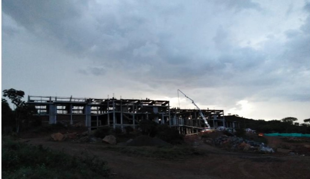
Ilustración 6. Fundición vigas de cubierta Fuente propia
