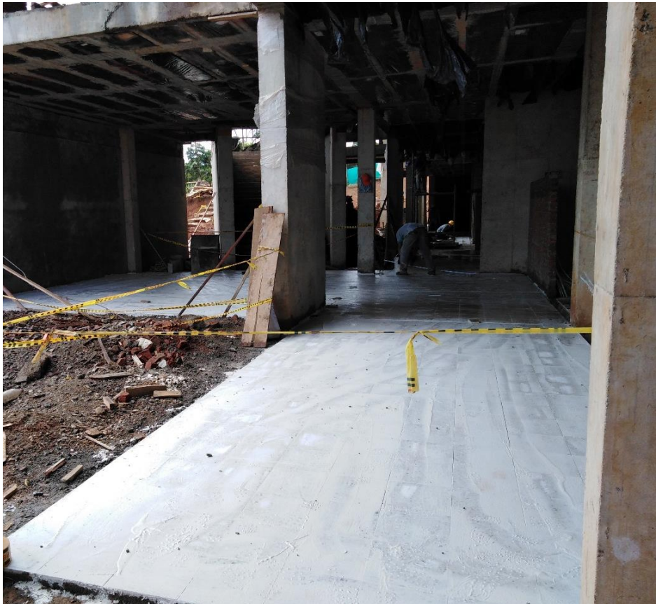
Ilustración 24. Pega de baldosa en el bloque 1 Fuente propia
