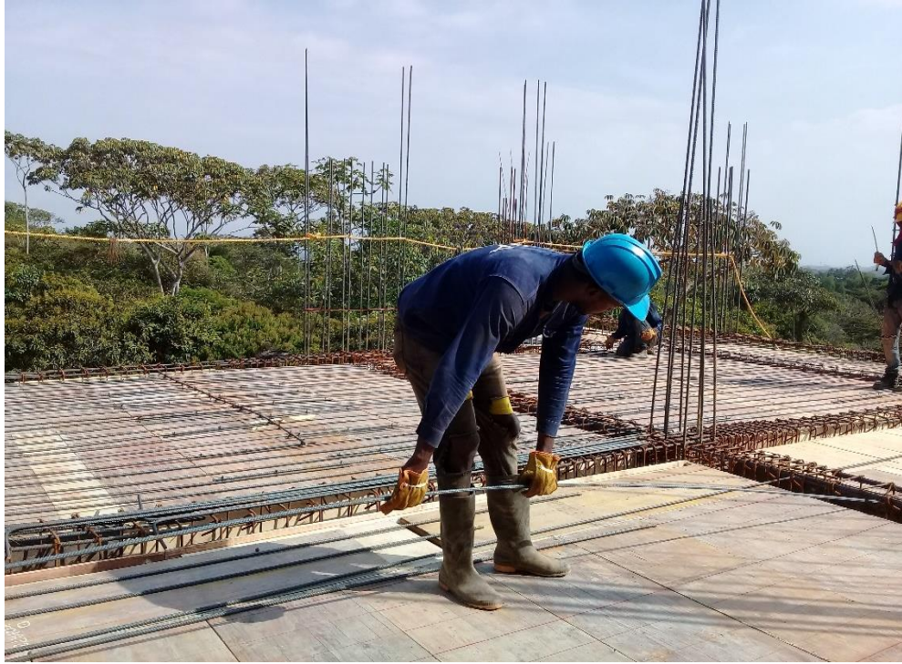
Ilustración 19. Losa de entpiso batería sanitaria 2 – nivel 1 Fuente propia
