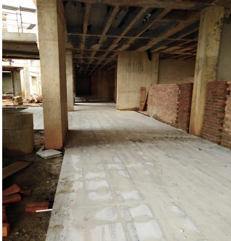
Ilustración 25. Baldosa pasillo en el bloque 2 Fuente propia
