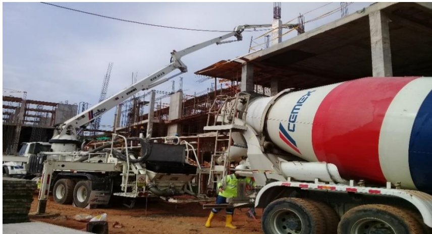
Ilustración 5. Fundición elementos estructurales 3 piso – bomba-mixer
