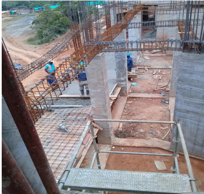
Ilustración 22. Fundición rampa tramo 1 batería 1 Fuente propia – concreto 21 MPA
