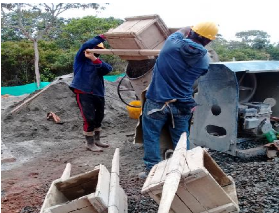
Ilustración 7. Concreto mezclado en obra Fuente propia
