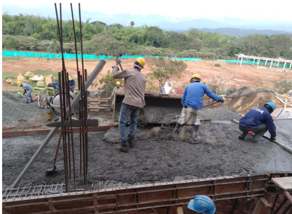
Ilustración 8. Fundición rampa para discapacitados Fuente propia
