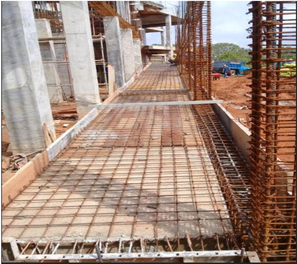
Ilustración 20. Armado de Rampa batería 1 para discapacitados Fuente propia
