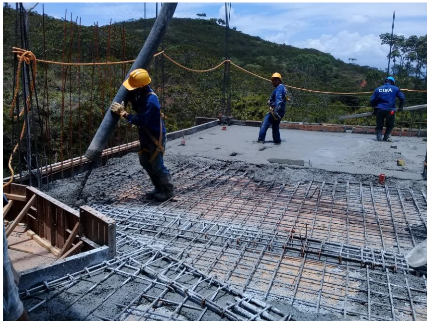
Ilustración 23. Fundición losa maciza batería sanitaria 2 – nivel 1 Fuente propia – concreto 21 MPA
