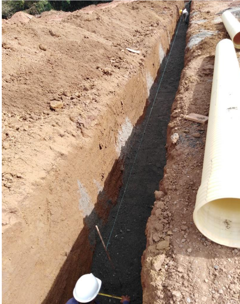
Ilustración 29. Colocación tubería - alcantarillado Fuente propia
