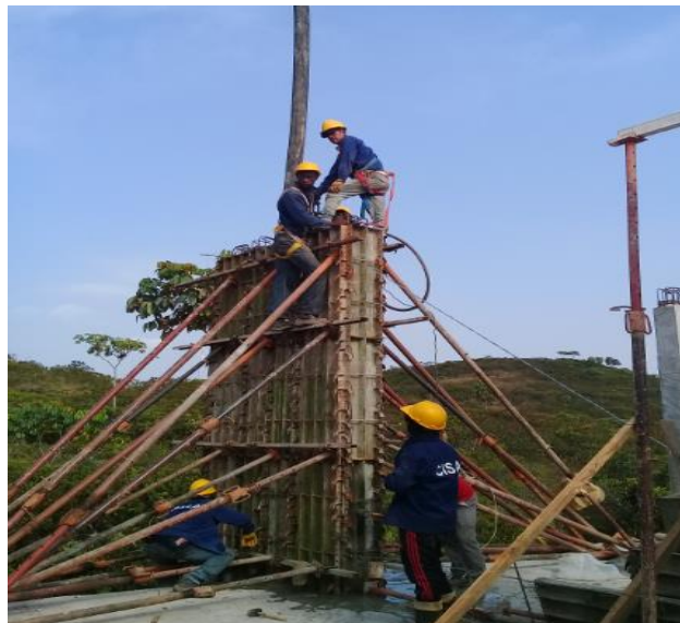
Ilustración 21. Fundición pantalla A5 piso 3 - bloque 2
