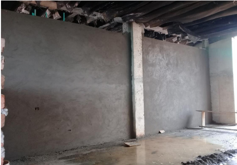
Ilustración 18. Repello de muros Fuente propia
