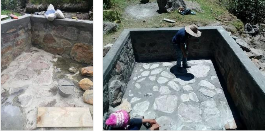
Figura 5-10, Impermeabilización y sellado de pantallas protectoras. Fuente Propia
