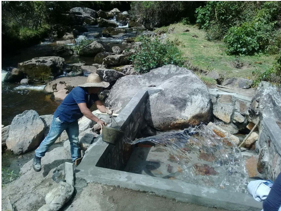
Figura 5-8, Construcción encausamiento y pantalla protectora de crecidas. Fuente Propia
