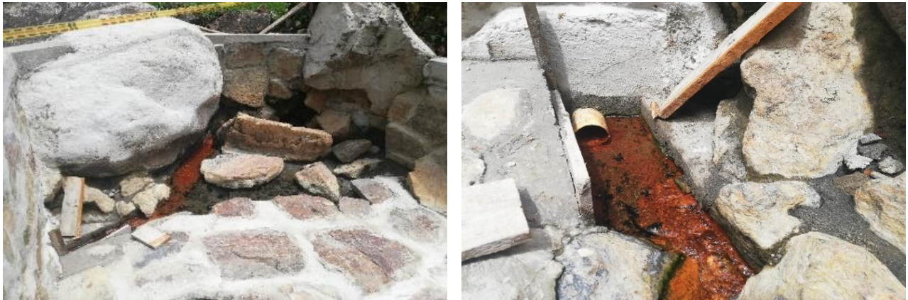
Figura 5-12, Encauzamiento sin afectar el nacimiento. Fuente propia
