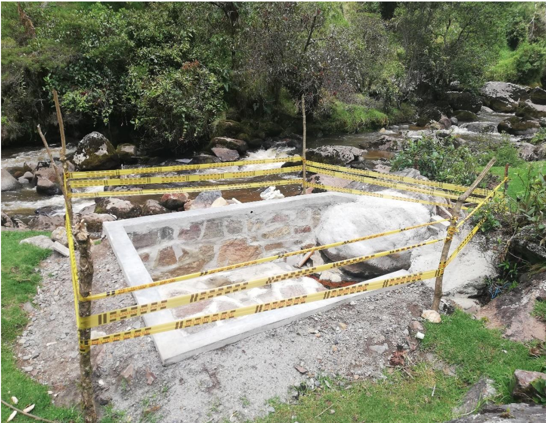
Figura 5-11. Fraguado del Concreto y secado del mortero. Fuente Propia.
