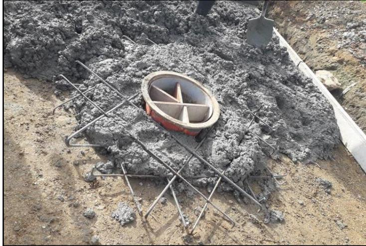
Figura 66. Acero de refuerzo en cámaras de inspección de alcantarillado
