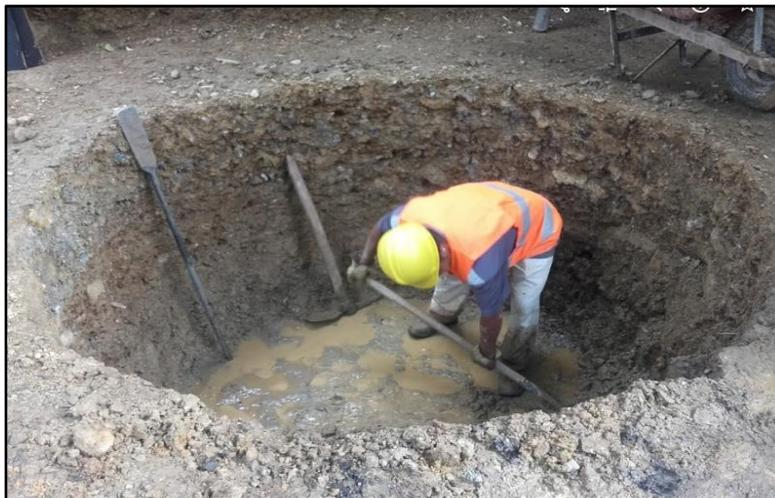
Figura 22. Excavación manual de caissons.
