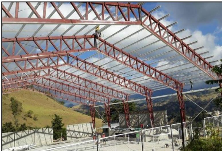
Figura 77. Colocado de templetos y tensores en la cubierta
