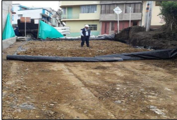
Figura 56. Colocación de geotextil
