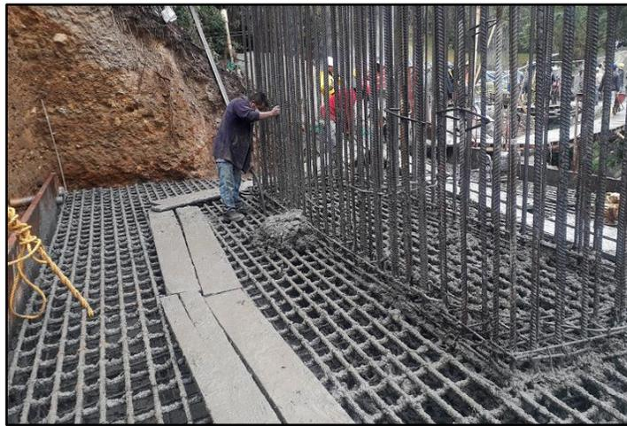
Figura 37. Fundición y vibrado del concreto pila 2.
