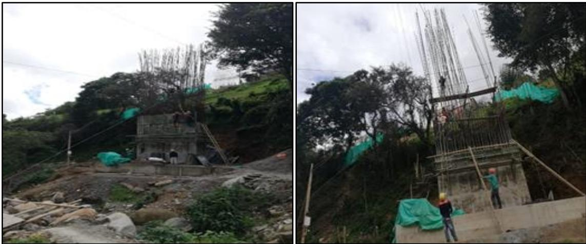
Figura 43. Construcción de pilar 2 (colocado y amarrado de acero, después de la fundición del primer tramo).
