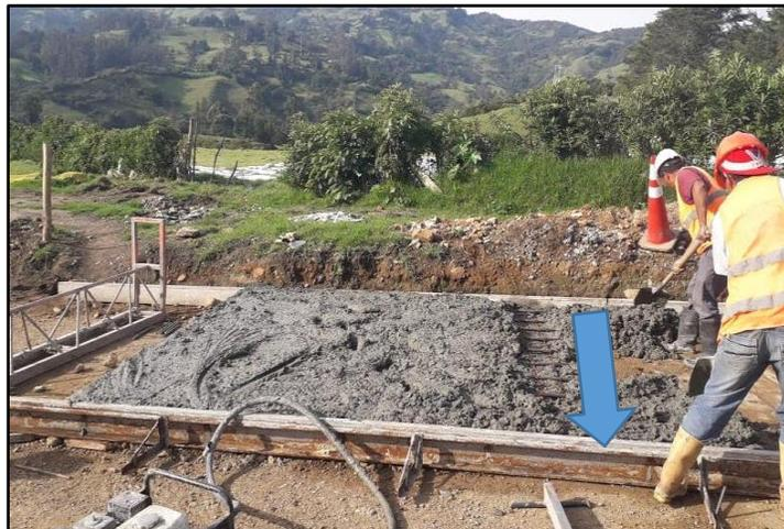
Figura 64. Colocación de Dovelas
