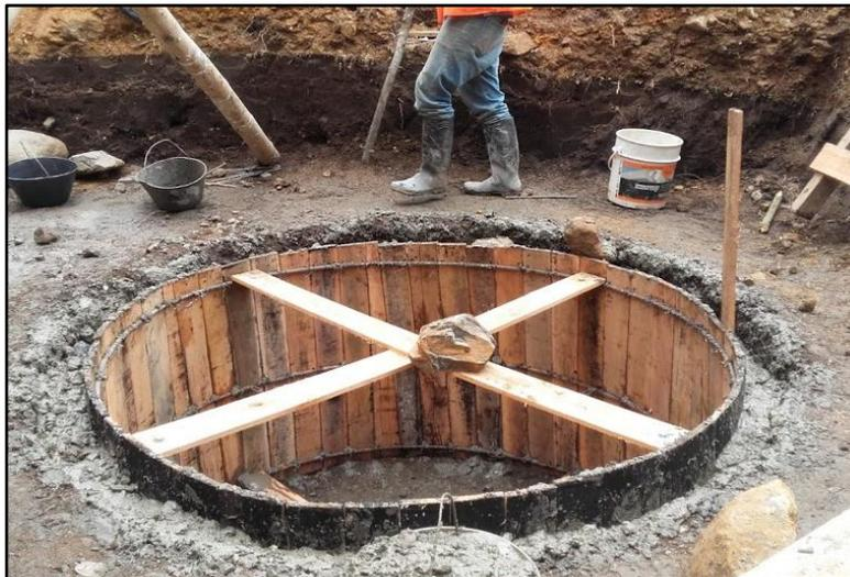
Figura 24. Fundición del primer anillo del caisson
