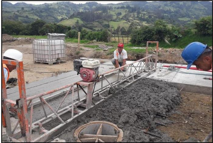
Figura 62. Fundición de las losas de concreto y vibrado con regla, en la Figura Además pueden observarse las dovelas de 1" de diámetro
