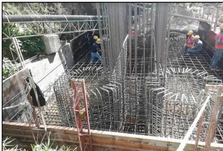
Figura 34. Colocado de formaleta, recubrimiento de 5 cm.
