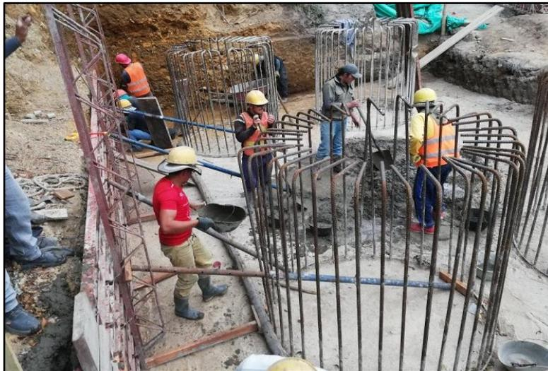
Figura 29. Preparación de concreto para solado de la zarpa del pilar
