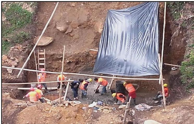
Figura 20. Excavación en para pila 1.
