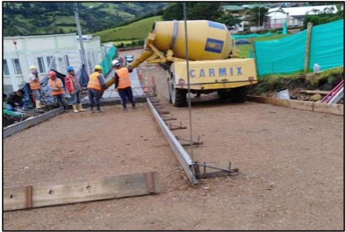
Figura 61. Fundición con carro mezclador CARMIX, y detalle de formaleta
