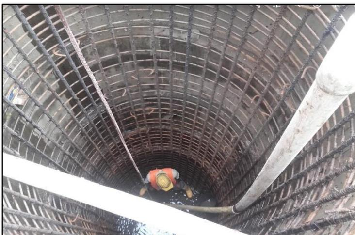
Figura 27. Vista de acero longitudinal y transversal, además de tubería de motobomba para evacuar el agua al interior del caisson
