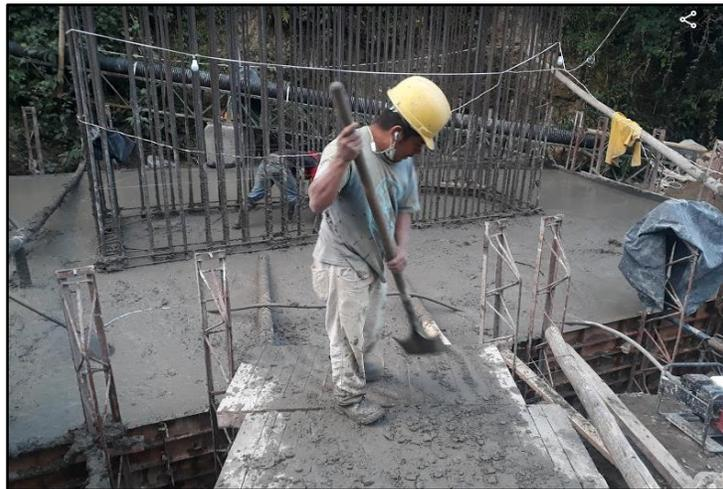
Figura 38. Fundición de pila 1
