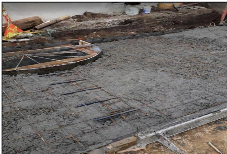
Figura 65. Malla electrosoldada y dovelas
