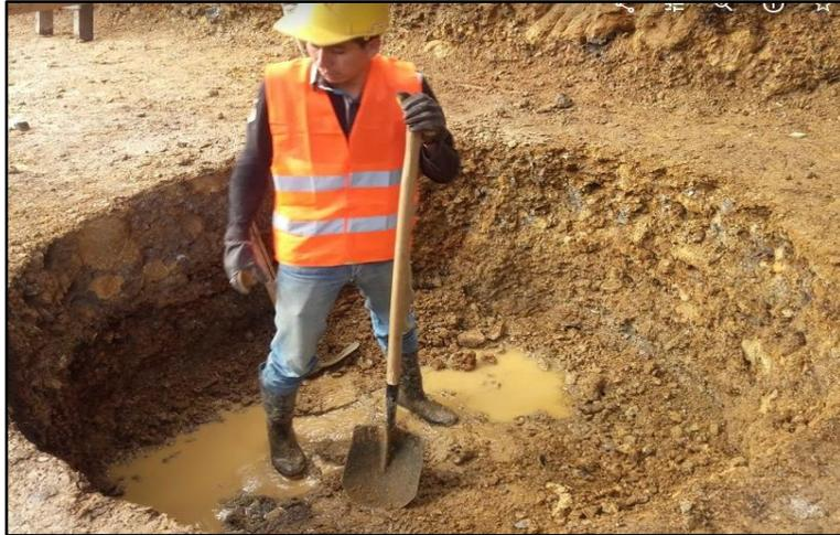
Figura 21. Inicio de las excavaciones para la fundación de los pilares principales.
