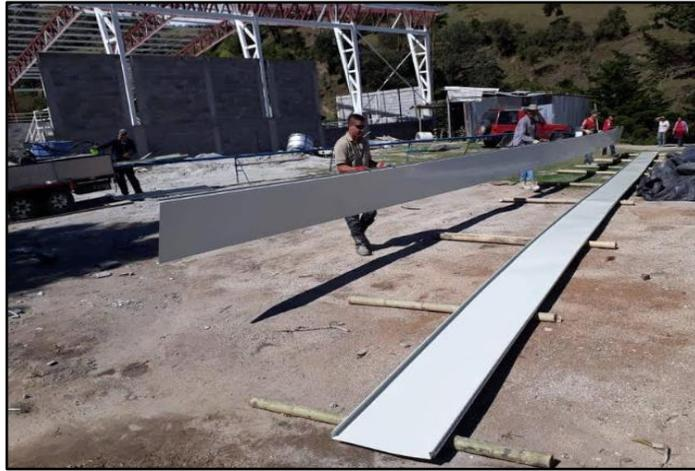
Figura 78. Doblado de tejas para cubierta
