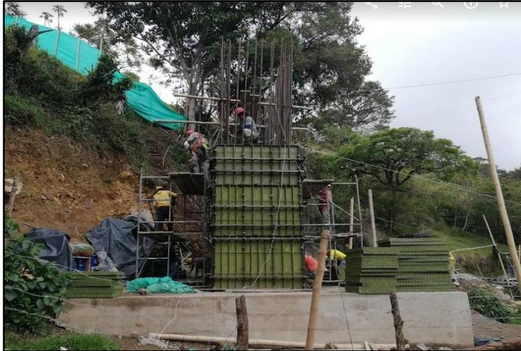
Figura 45. Proceso de colocado de formaleta pila 2 tramo 2
