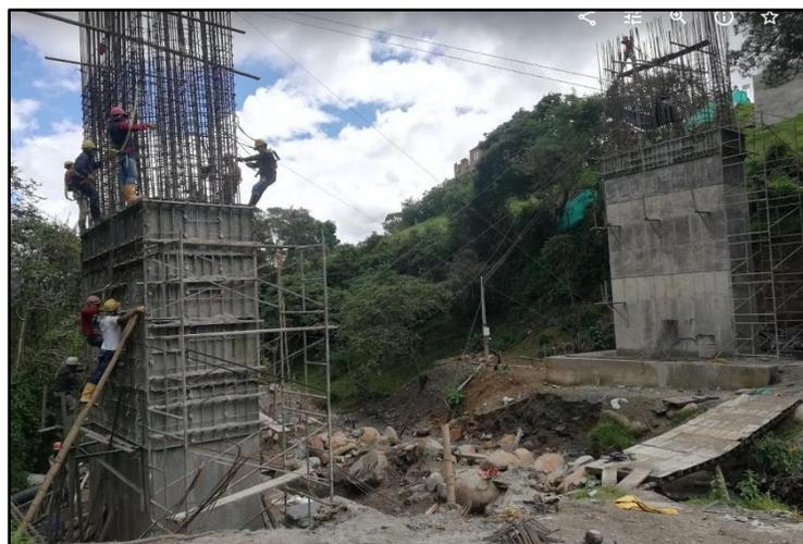
Figura 44. Construcción pila 1 (colocado y armado de acero después de fundición del segundo tramo)
