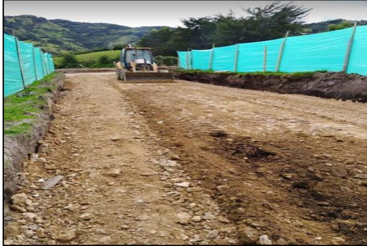
Figura 54. Colocación del material para mejoramiento del terreno
