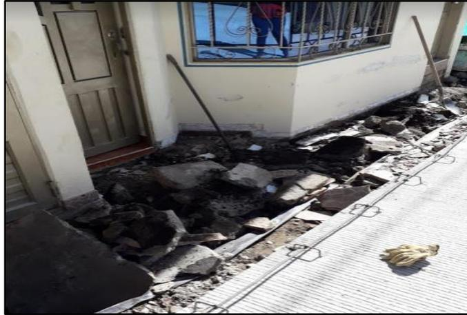
Figura 74. Demolición de andenes existentes
