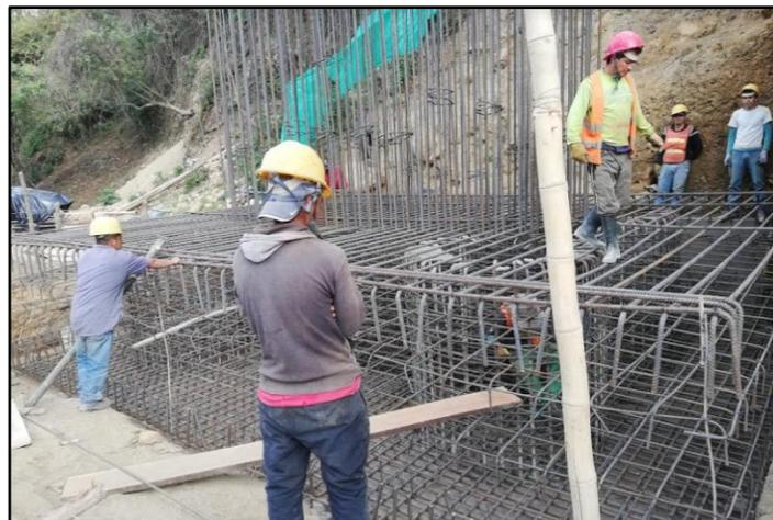
Figura 33. Armado de las parrillas de acero de la zarpa
