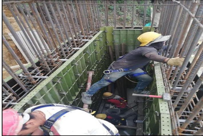
Figura 89. Utilización de elementos de seguridad obra denominada “puente de acceso vía Belén con la proyección a la zona industrial” (fuente: residente de obra)
