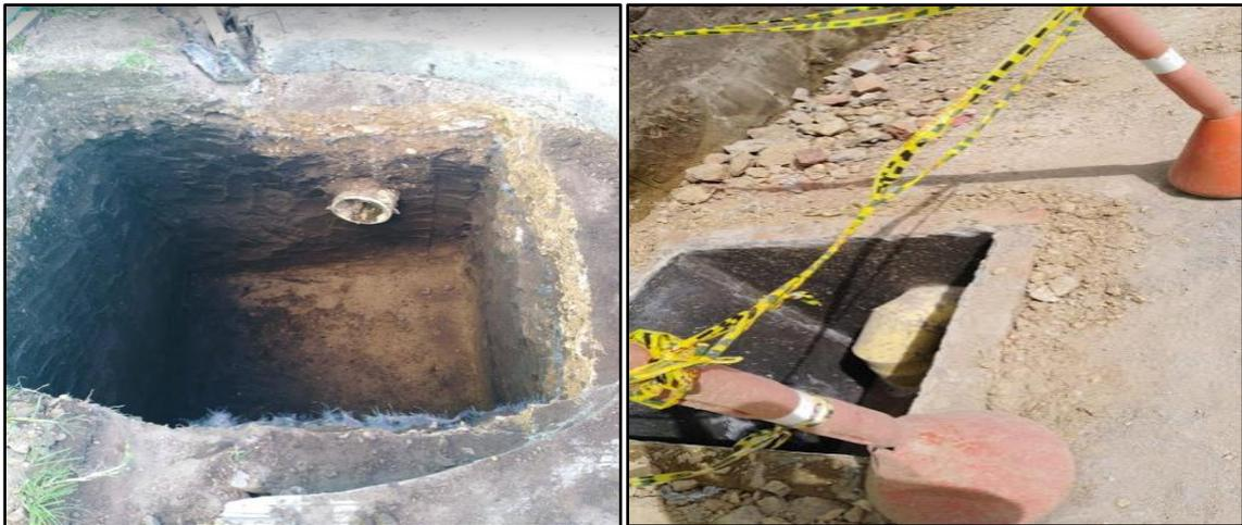
Figura 71. Excavación y construcción de revestimiento para sumidero
