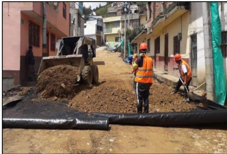
Figura 57. Colocación de geotextil
