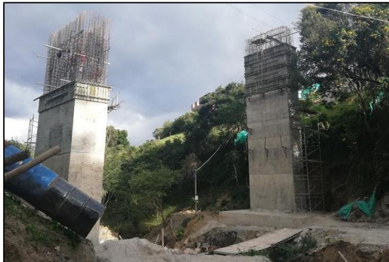
Figura 46. Avance de los pilares centrales
