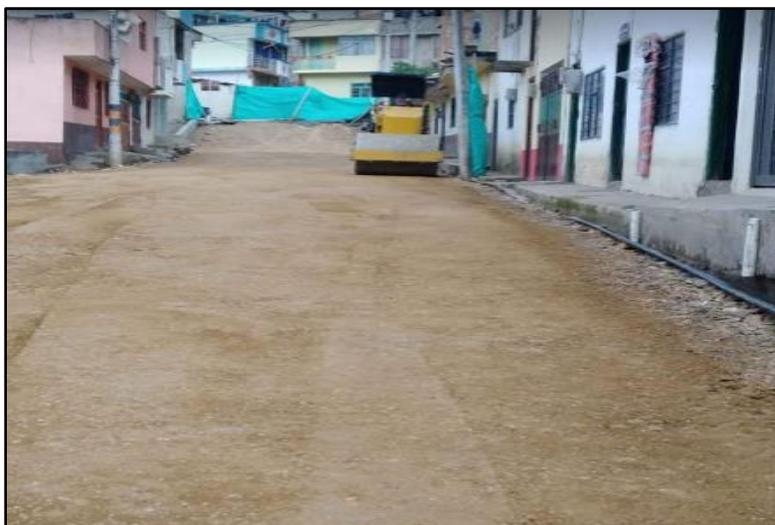
Figura 58. Conformación de la calzada
