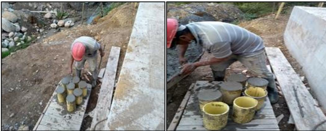
Figura 40. Toma de cilindros fundición cimentación pila 1.
