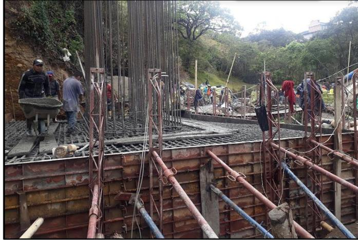
Figura 36. Fundición de zarpas para pilares principales pila 2.
