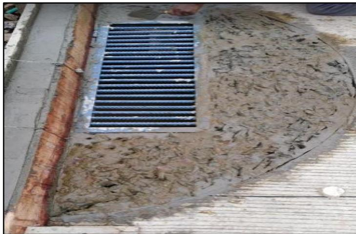
Figura 72. Fundición de tapa de sumidero y colocación de marco y rejilla
