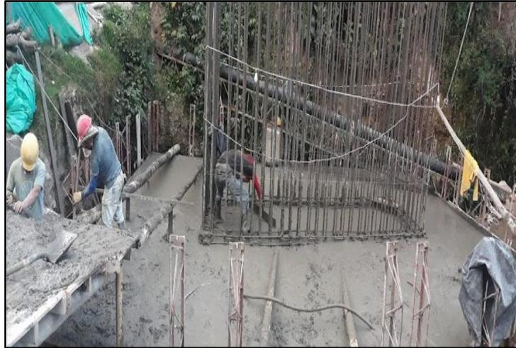
Figura 39. Fundición concreto clase c cimentación pila 7
