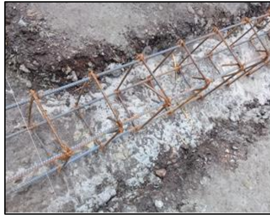
Fotografía 17: Disposición de ganchos
