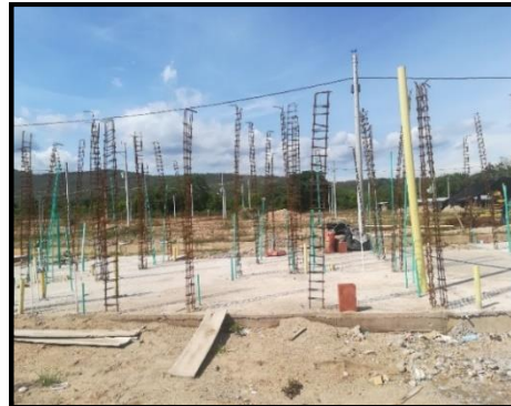
Fotografía 3: Acero de columnetas levantado
