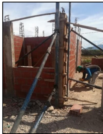
Fotografía 5: Formaleta de columnas
