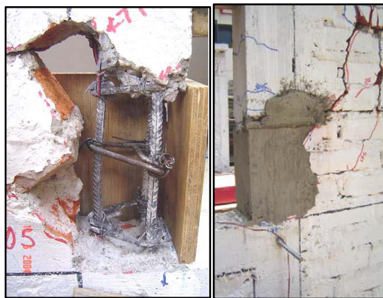
Figura 15. Reparación de Columnas
