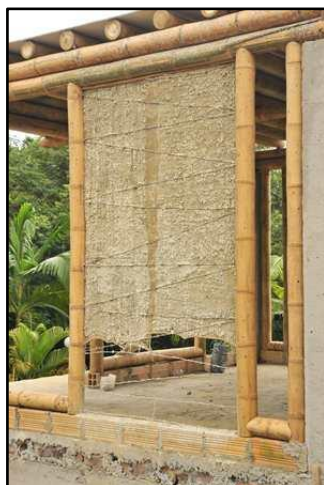
Figura 13. Sistema tendinoso en Bambú
