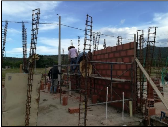
Fotografía 6: Pega de ladrillo para construcción de muros
