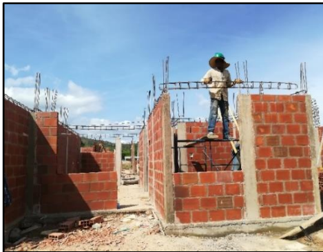
Fotografía 2: Colocación acero de vigas de amarre
