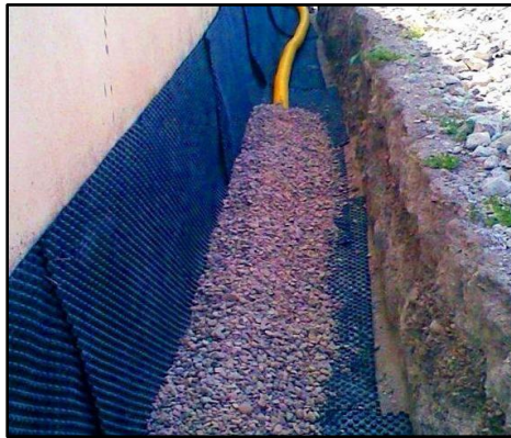
Figura 18. Drenaje para humedad por capilaridad
