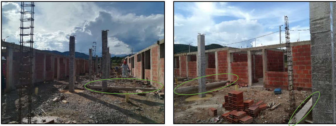
Fotografía 12: chequeo de dimensiones en la Viga para muro divisorio
