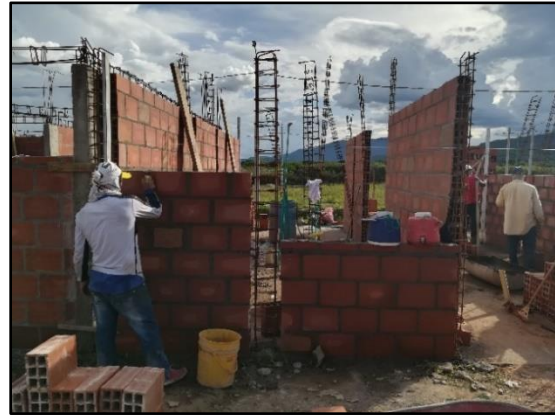
Fotografía 6: Pega de ladrillo para construcción de muros
