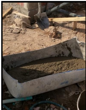
Fotografía 4: Concreto para columna
