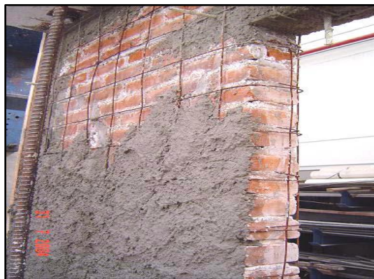
Figura 17. Aplicación de mortero
