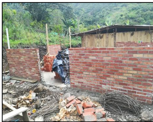
Fotografía 19: Avance de una vivienda
