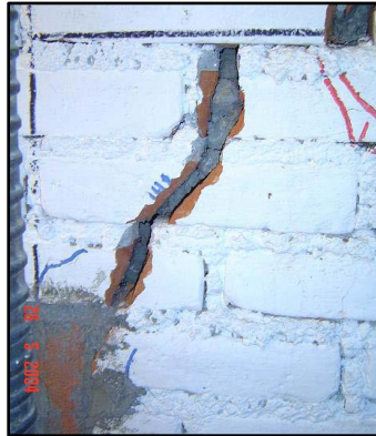
Figura 16. Relleno de grietas
