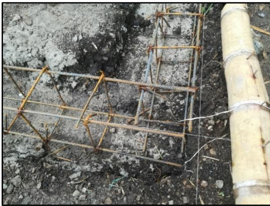
Fotografía 16: Verificación de la colocación de ganchos
