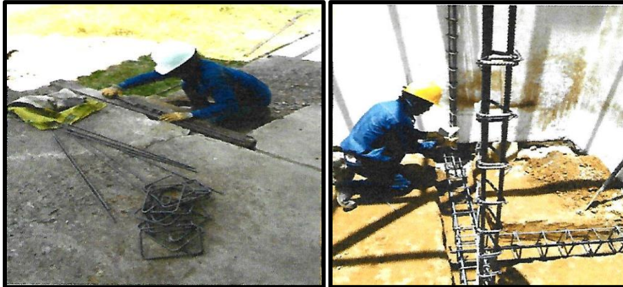
Figura 25. Figurado para vigas y columnas
