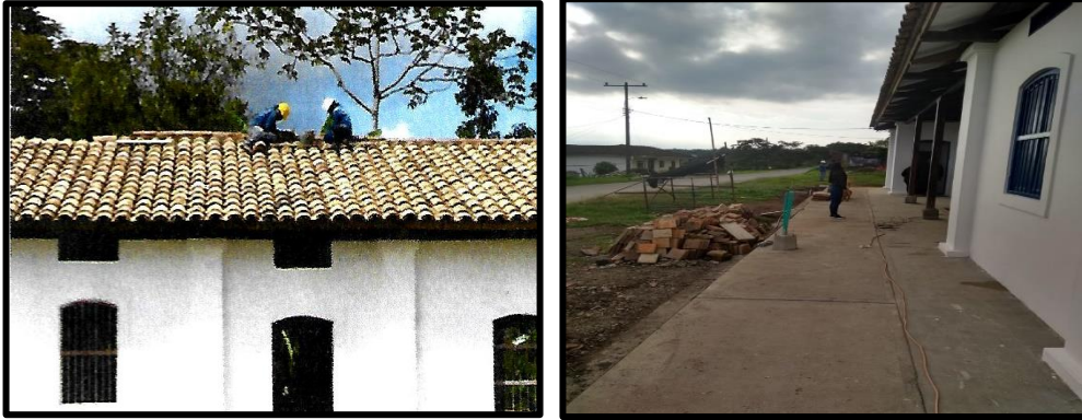
Figura 28. Instalación de caballete en teja de barro
