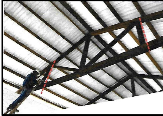
Figura 31. Refuerzos verticales en madera (péndola) en cercha rey
