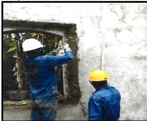
Figura 23. Reparación vanos ventanearía, filos, alfajías
