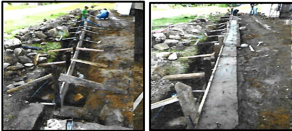
Figura 32. Encofrado y fundición bordillo andén
