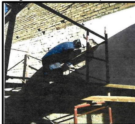
Figura 21. Retiro de pañete
