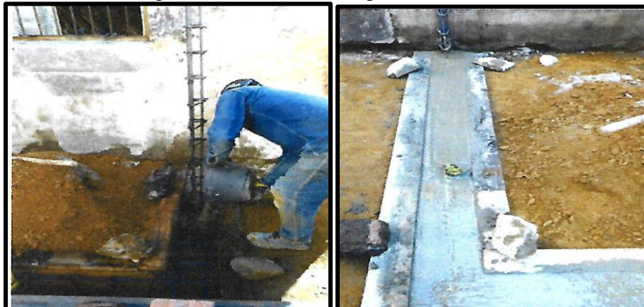
Figura 26. Fundición vigas en concreto
