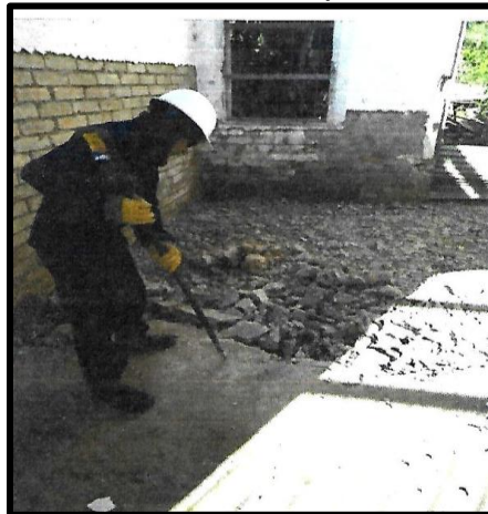
Figura 20. Demolición de piso en concreto
