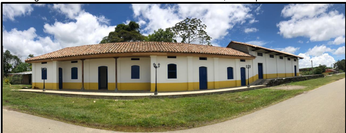
Figura 36. Estado final Estación Férrea Morales, Municipio de Morales
