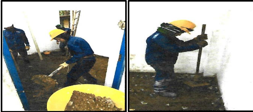
Figura 22. Estabilización y compactación terreno
