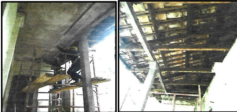
Figura 17. Desmonte de cielo raso y piezas sueltas
