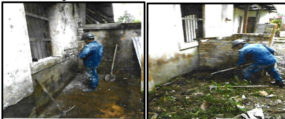
Figura 24. Excavación Manual de 0 a 1.2 m
