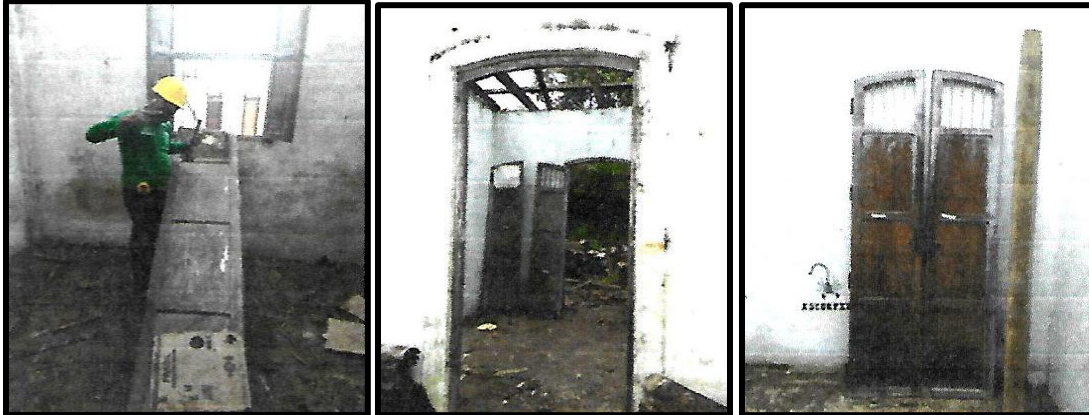
Figura 19. Desmonte de puertas y ventanas existentes
