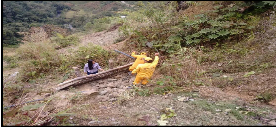
Figura 42. Sitio crítico PR79+0700, construcción de bocatoma
