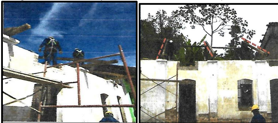
Figura 18. Desmonte y nivelación de cerchas en la parte frontal
