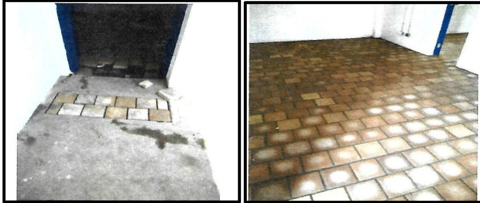
Figura 34. Suministro e instalación de tablón cerámico
