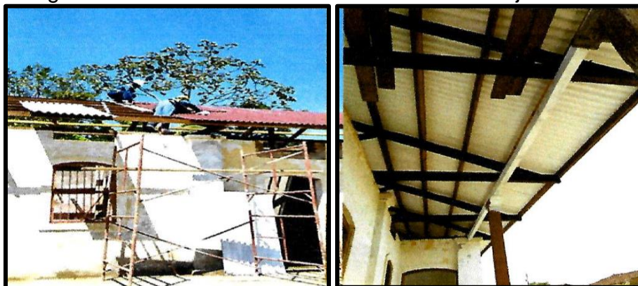
Figura 27. Suministro e instalación de cubierta teja onduline
