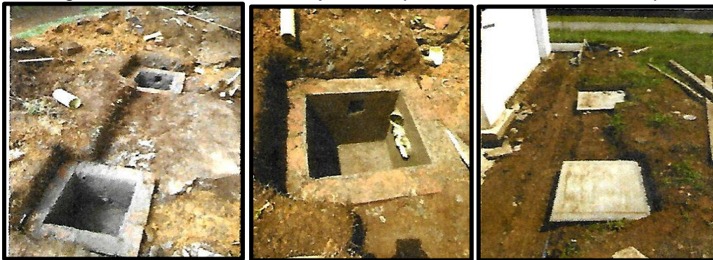
Figura 29. Suministro de caja de inspección 0.8x0.8 m con tapa
