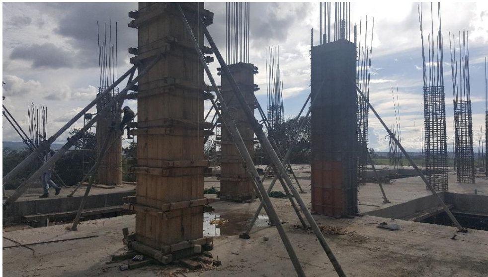
Figura 27. Formateado de columnas en construcción edificio INDETEC. 20 de noviembre de 2018
