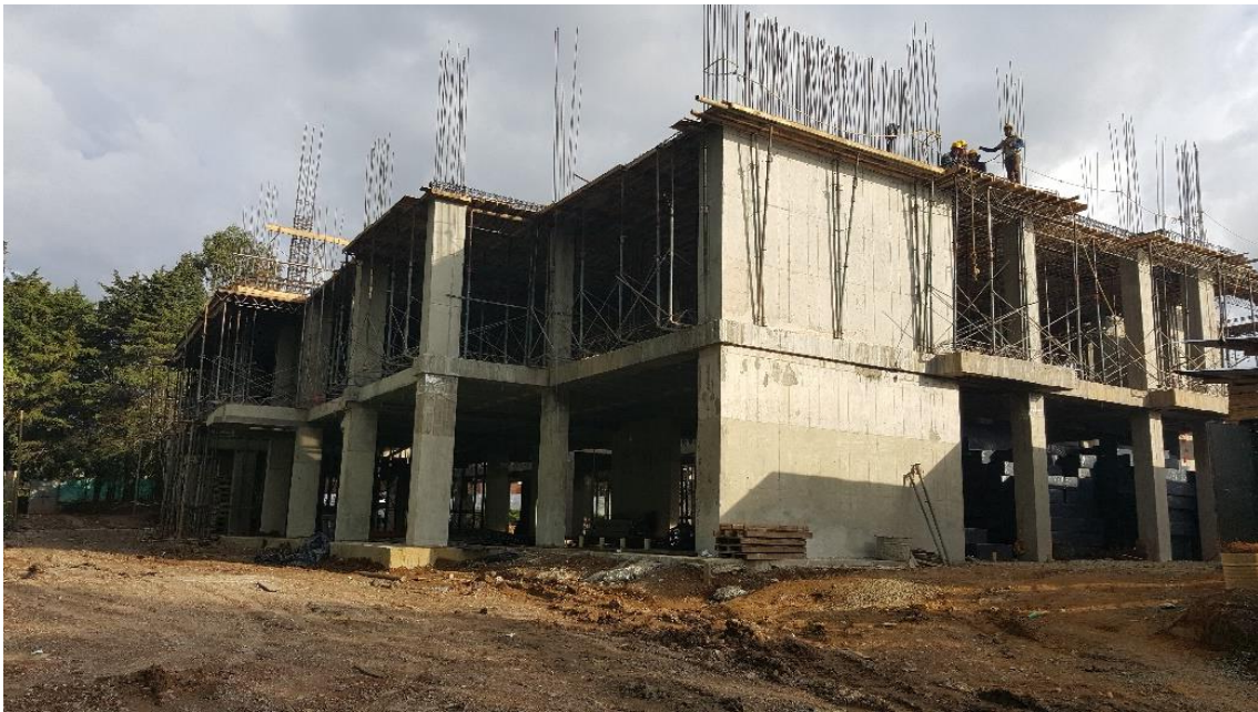
Figura 30. Toma panorámica del trabajo hasta la fecha en construcción edificio INDETEC. 7 de diciembre de 2018
