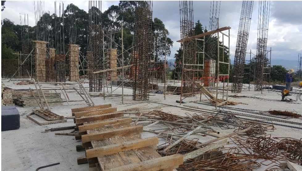
Figura 28. Formateado de columnas en construcción edificio INDETEC. 21 de noviembre de 2018
