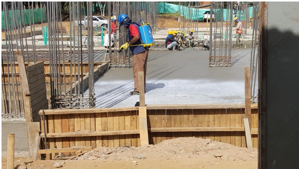
Figura 7. Rociar Antisol en construcción edificio INDETEC. 5 de octubre de 2018
