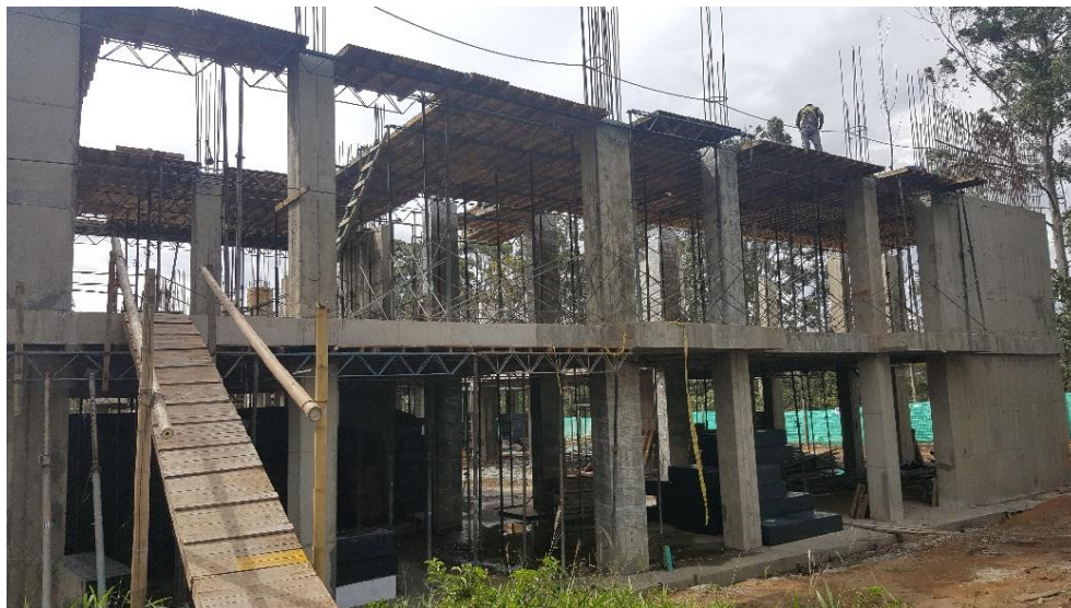
Figura 20. Entablero de tercer piso en construcción edificio INDETEC. 8 de noviembre de 2018
