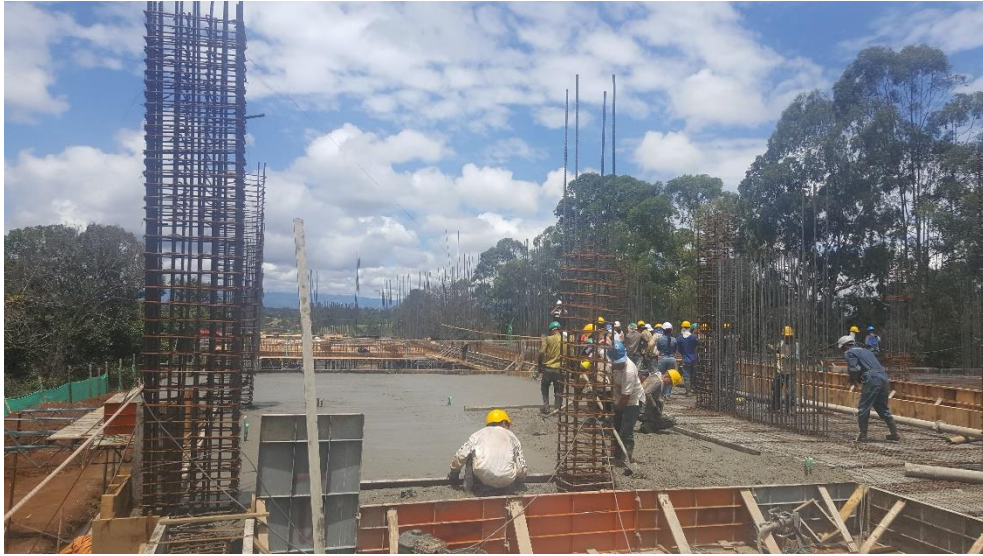
Figura 6. Fundición losa y vigas de segundo piso en construcción edificio INDETEC. 5 de octubre de 2018
