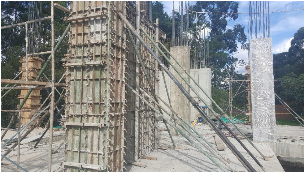
Figura 15. Formateado de pantallas en construcción edificio INDETEC. 23 de octubre de 2018
