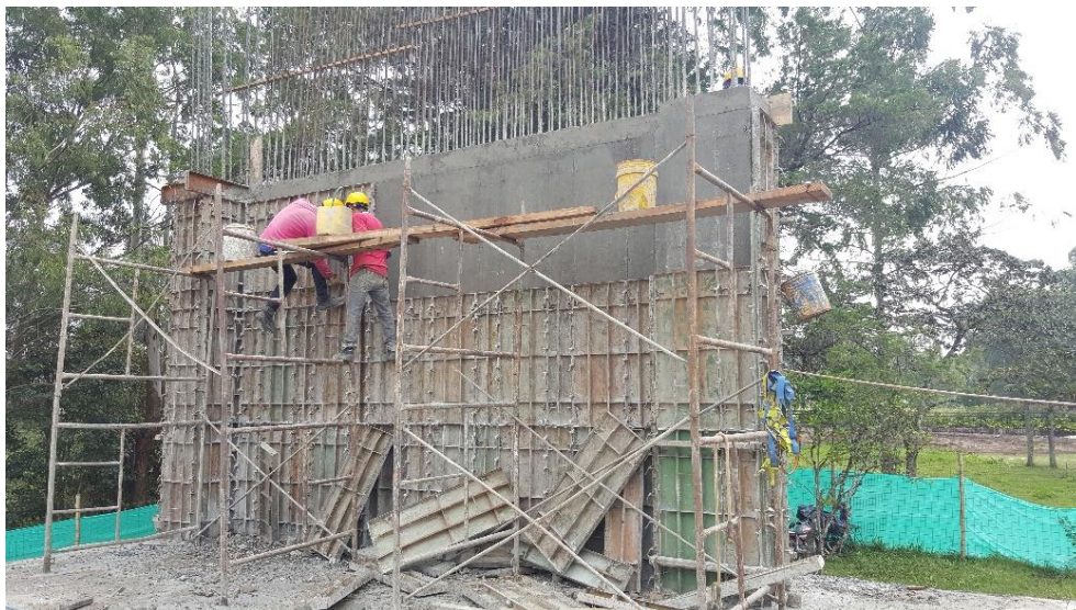
Figura 19. Proceso de des-formateado de pantallas en construcción edificio INDETEC. 8 de noviembre de 2018
