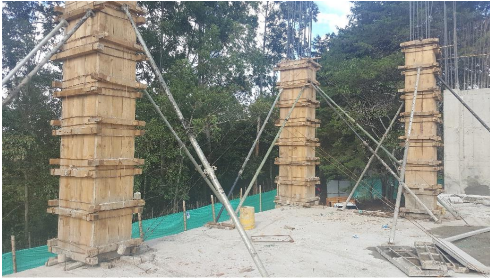
Figura 14. Formateado de columnas en construcción edificio INDETEC. 23 de octubre de 2018
