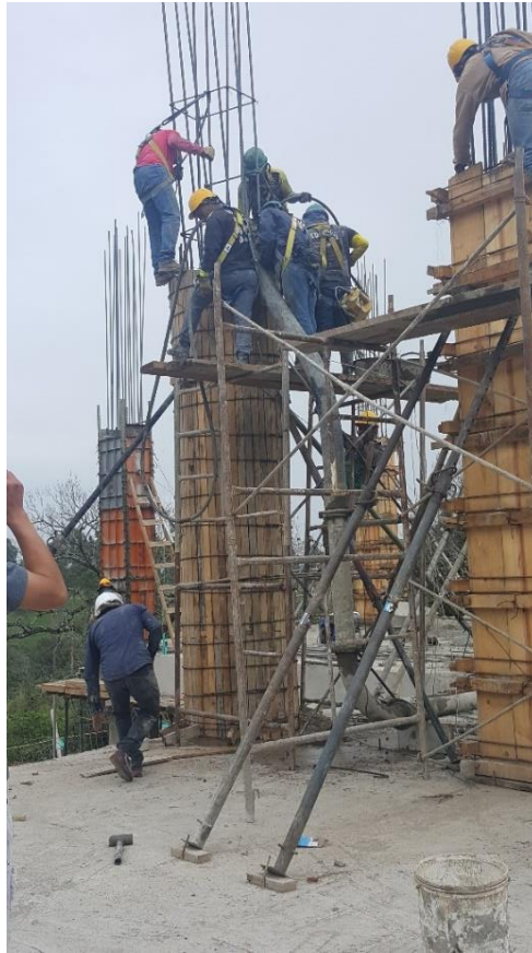
Figura 16. Fundición de columnas de segundo piso en construcción edificio INDETEC. 29 de octubre de 2018
