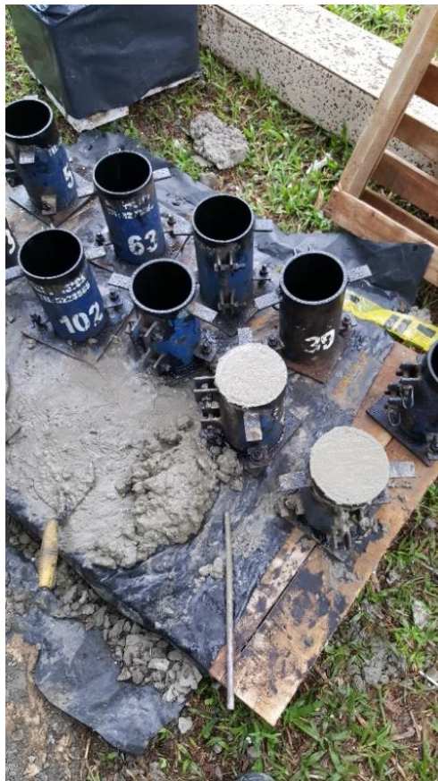
Figura 29. Toma de las muestras representativas de concreto en construcción edificio INDETEC. 21 de noviembre de 2018
