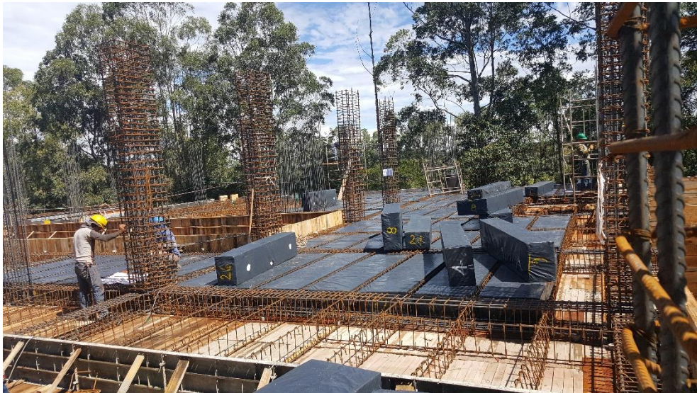
Figura 5. Instalación de casetones en construcción edificio INDETEC. 3 de octubre de 2018
