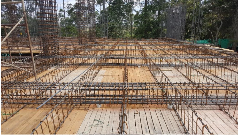
Figura 4. Instalación de aceros segundo piso en construcción edificio INDETEC. 28 de septiembre de 2018
