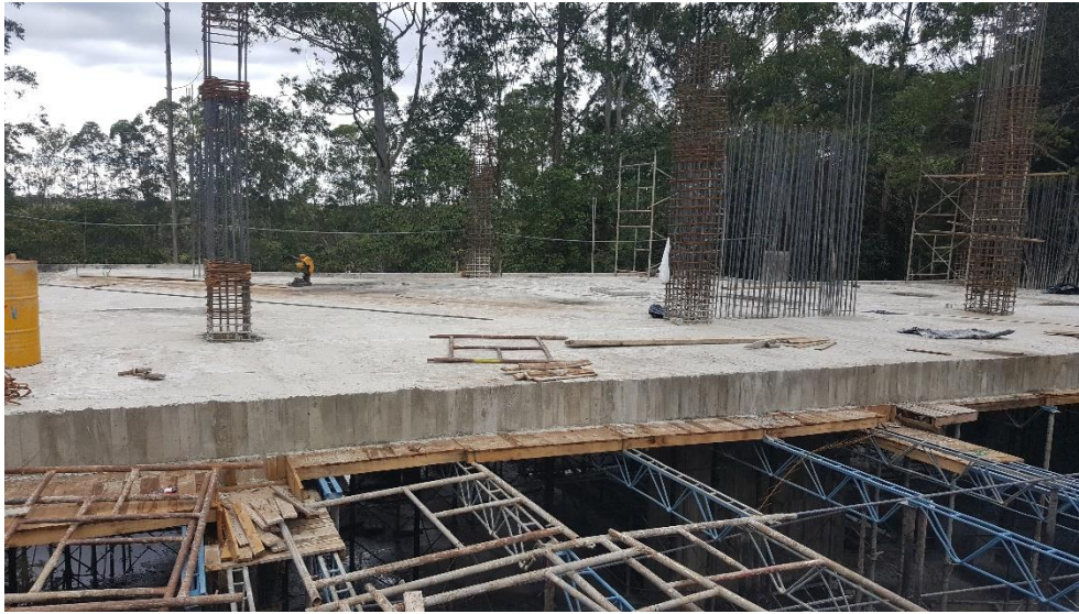
Figura 8. Proceso de des-formateado en construcción edificio INDETEC. 9 de octubre de 2018
