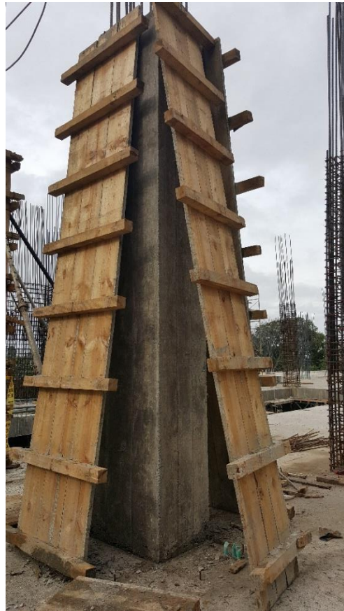
Figura 18. Proceso de des-formateado de columnas en construcción edificio INDETEC. 31 de octubre de 2018
